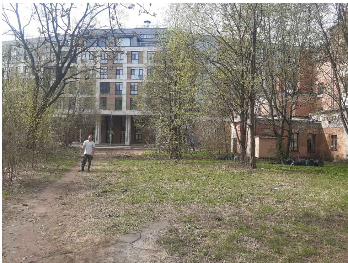
Рис. 22. Санкт-Петербург, Петроградский район, Ремесленная ул. д.8 лит. А. Общий вид участка. Точка съёмки 5. Вид с северо-востока.
