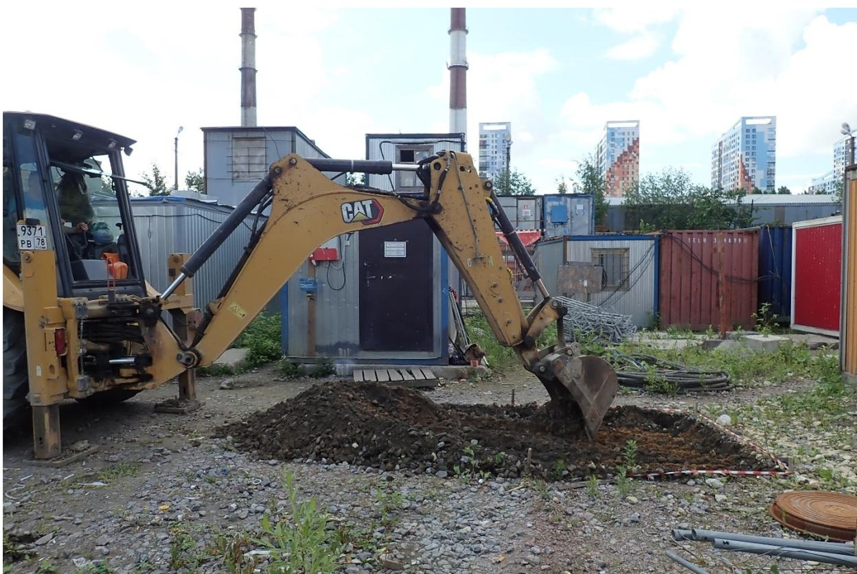
Рис. 11 Земельный участок № 26 по ППТ в пределах кадастрового номера 78:12:0006333:18 по адресу г. Санкт-Петербург, Октябрьская набережная, дом 42, (участок 9). Шурф № 1. Выборка утрамбованной строительной техникой гранитной крошки, песчаной подсыпки и геотекстиля строительной техникой. Вид с севера.
