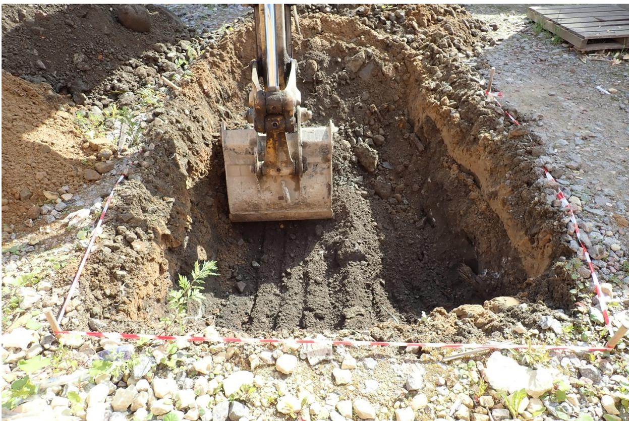
Рис. 12. Земельный участок № 26 по ППТ в пределах кадастрового номера 78:12:0006333:18 по адресу г. Санкт-Петербург, Октябрьская набережная, дом 42, (участок 9). Шурф № 1. Выход подстилающего слоя коричневой супеси с примесью крупногабаритного строительного мусора. Вид с запада
