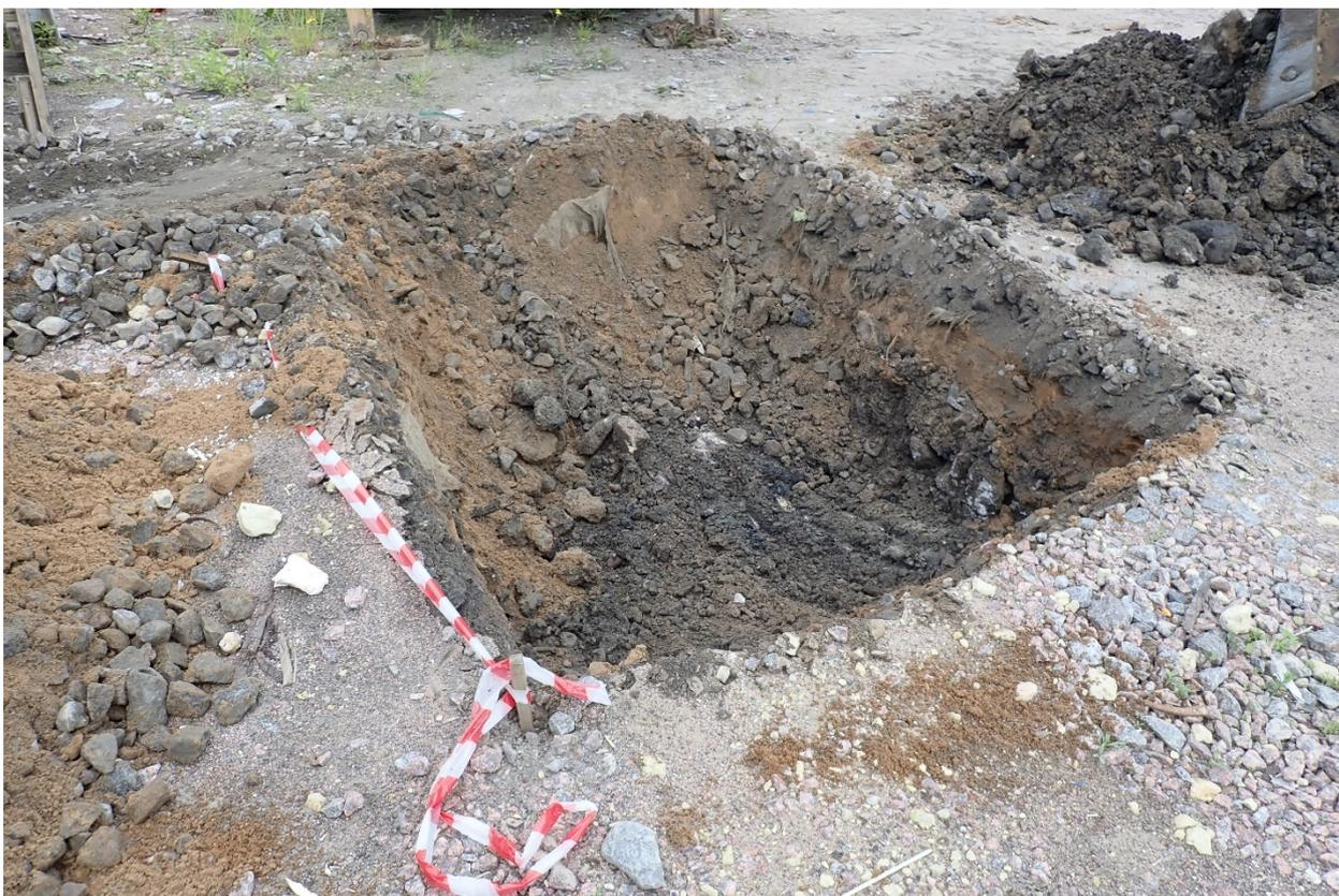
Рис. 14. Земельный участок № 27 по ППТ в пределах кадастрового номера 78:12:0006333:18 по адресу г. Санкт-Петербург, Октябрьская набережная, дом 42, (участок 9). Шурф № 1. Выход подстилающего слоя коричневой супеси с примесью крупногабаритного строительного мусора. Вид с северо-запада
