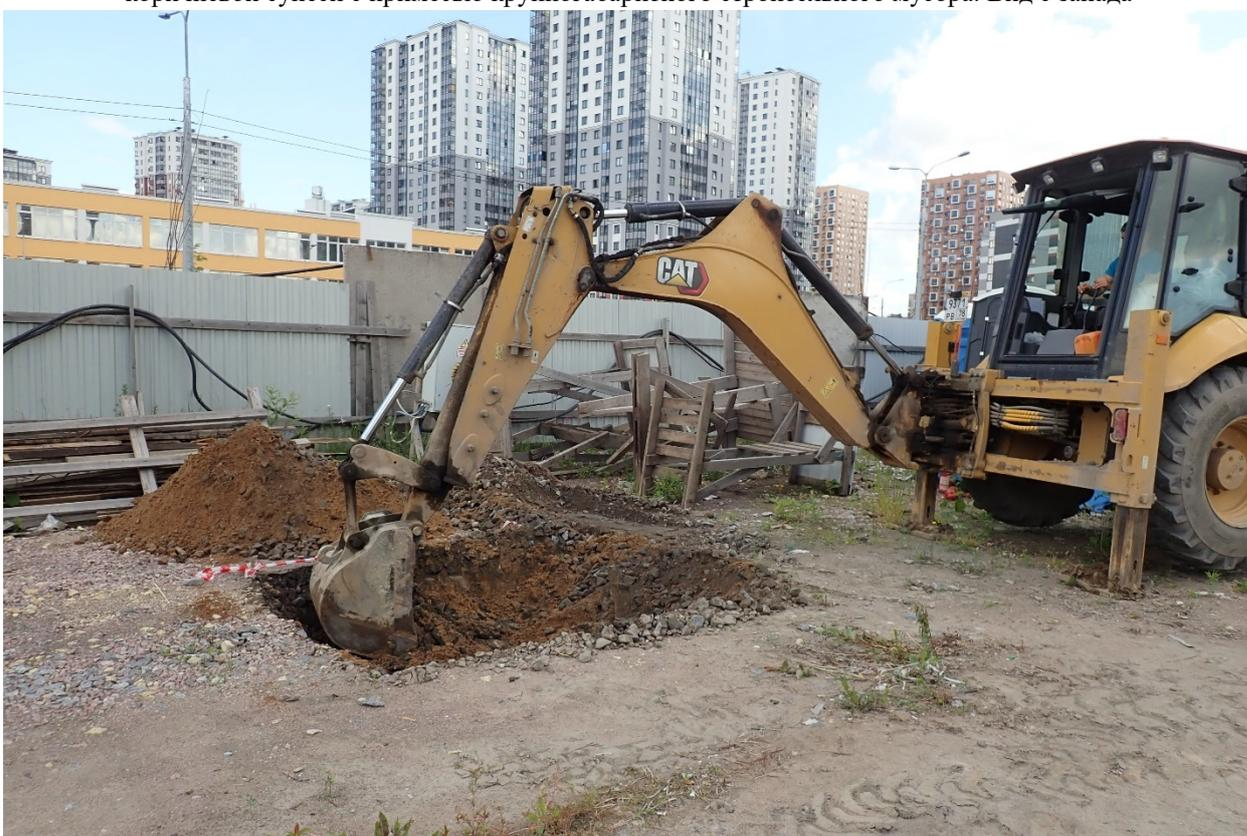
Рис. 13 Земельный участок № 27 по ППТ в пределах кадастрового номера 78:12:0006333:18 по адресу г. Санкт-Петербург, Октябрьская набережная, дом 42, (участок 9). Шурф № 1. Выборка утрамбованной строительной техникой гранитной крошки, песчаной подсыпки и геотекстиля строительной техникой. Вид с юго-запада.
