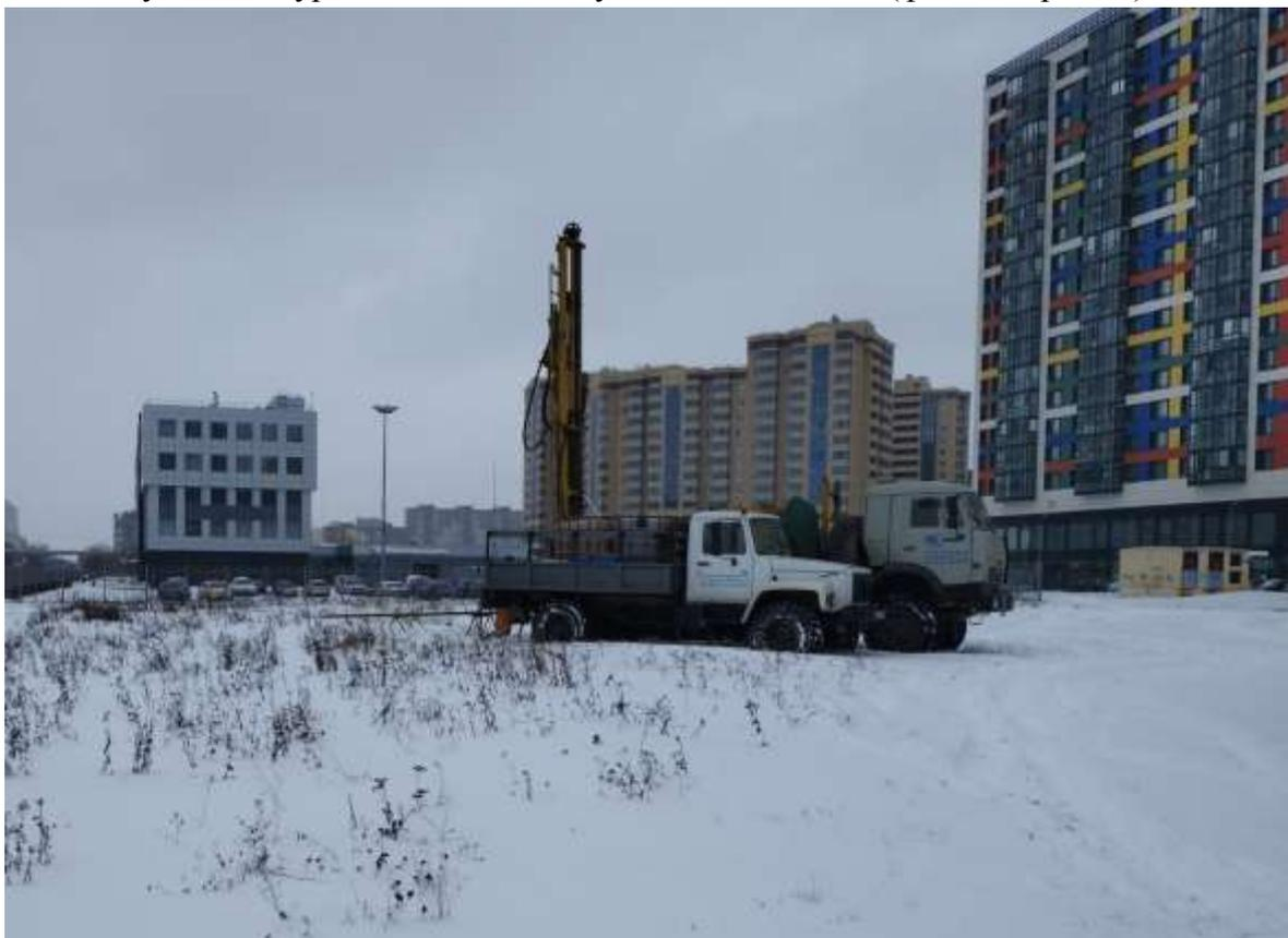
С целью уточнения геологического разреза, физико-механических характеристик грунтов на площадке строительства выполнено статическое зондирование грунтов у скважин и в пунктах 1-3 бригадой оператора Яцевича С.А. до глубин 19,8 – 30,3 м (всего 224,3 м).
