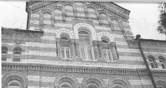
29. Щипец центрального нефа собора. Западный фасад.
