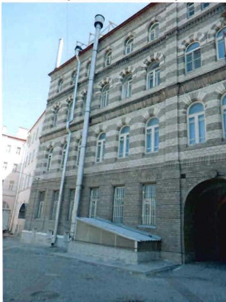
6. Фрагмент западной части фасада
