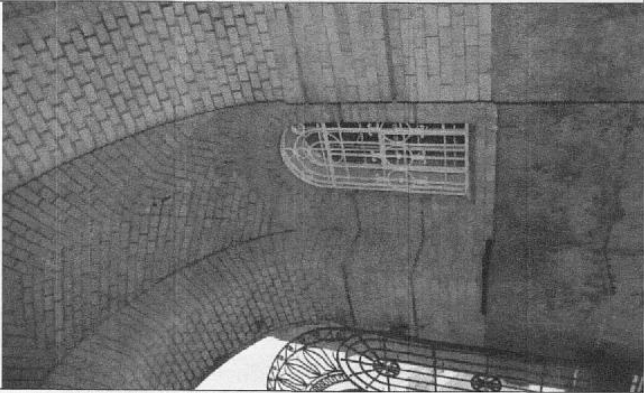
38. Проездная арка западного корпуса. Вид в сторону внутреннего двора. Своды
