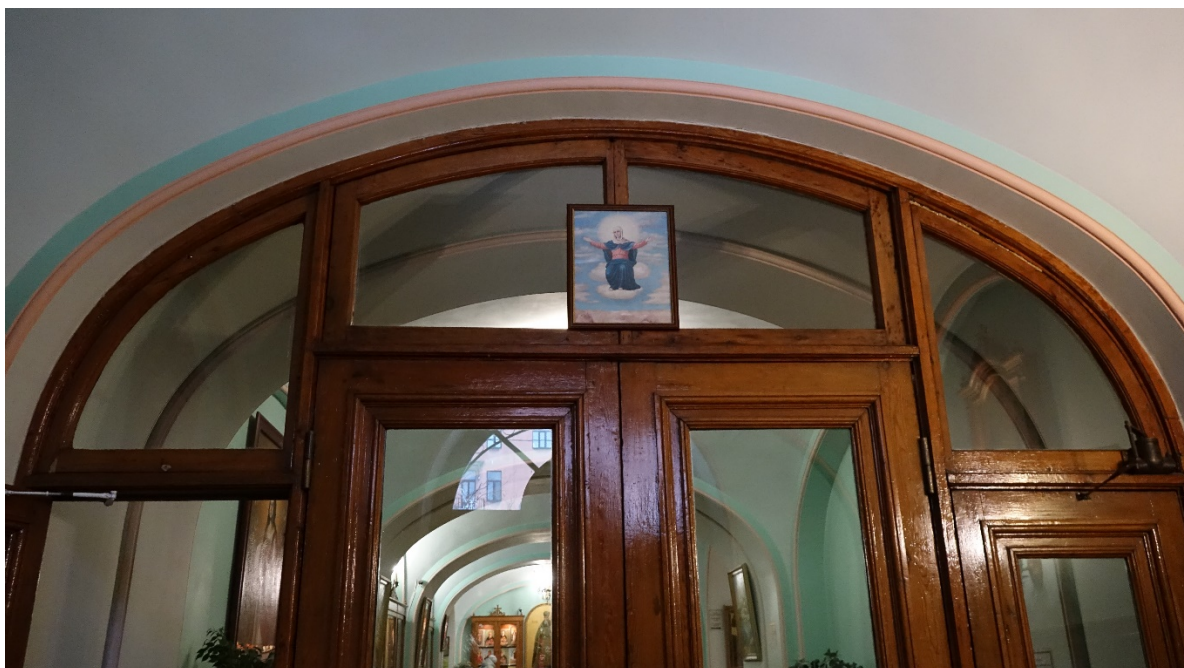
Фото 3. Портал с остеклённой фрамугой коробового очертания. Дата фотофиксации: 11.12.2023
