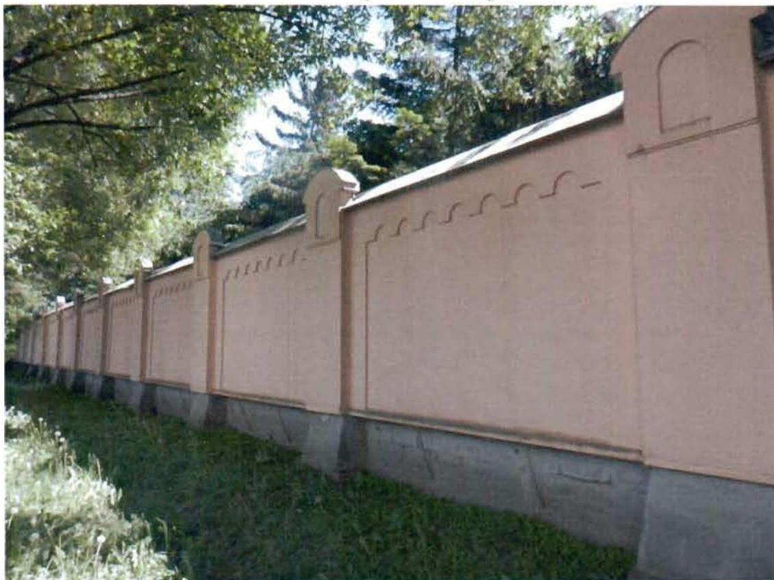
25. Северная часть ограды
