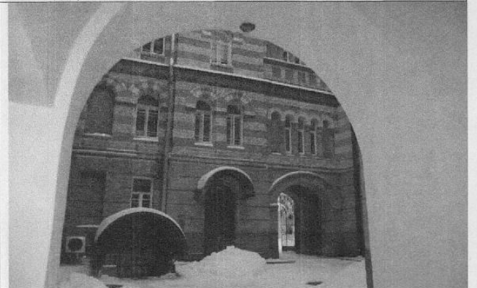
36. Проездная арка западного корпуса. Вид в сторону внутреннего дворика.
