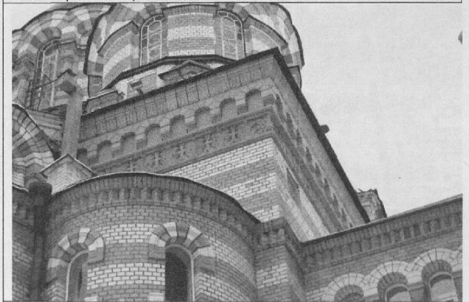
28. «Бегунец» 1-го яруса апсид и карниз основания барабанов.
