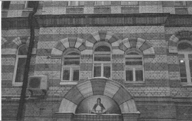
34. Западный корпус. Фасад во внутреннем двореке. Ризалит парадной лестницы. Окно 2-го этажа и портал входа.
