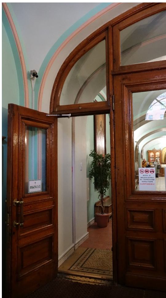
Фото 4. Боковая створка дверного заполнения. Дата фотофиксации: 11.12.2023
