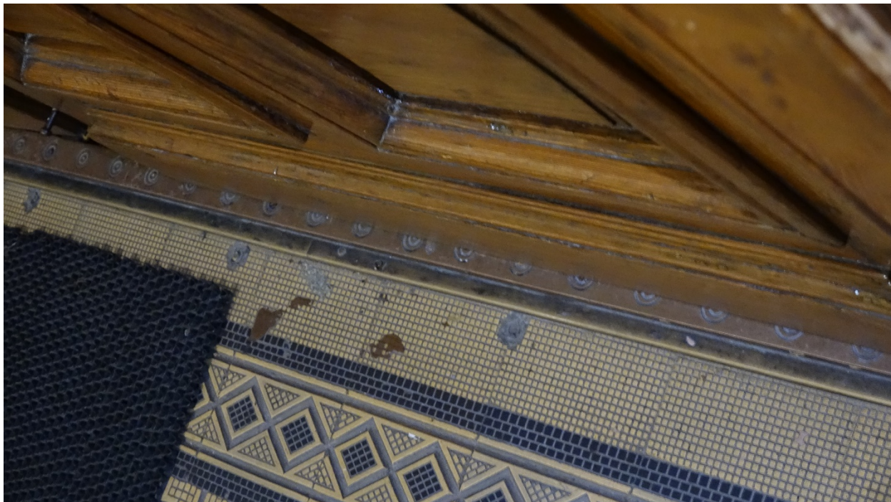
Фото 10. Фрагмент латунного порога в дверном проёме центральных двустворчатых дверей. Дата фотофиксации: 11.12.2023
