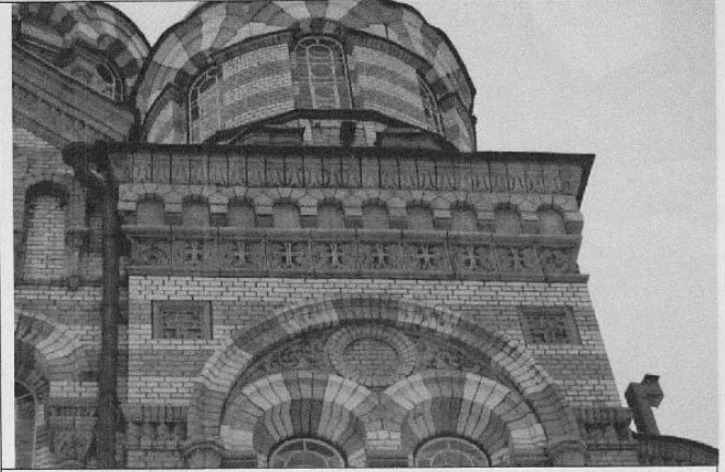
16. Главный корпус. Ризалит правого купола. Венчающий карниз.
