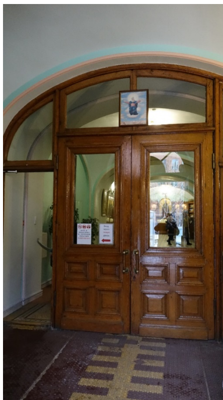
Фото 5. Центральные двустворчатые двери деревянного портала вестибюля Дата фотофиксации: 11.12.2023
