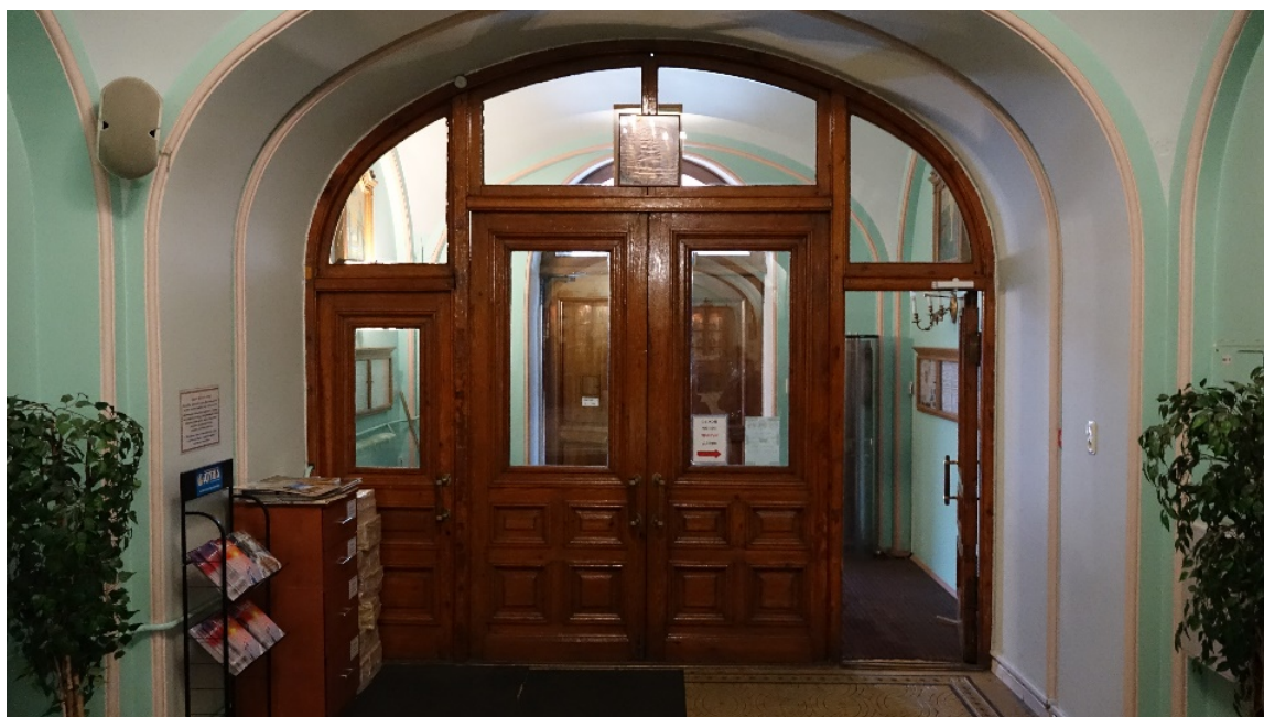
Фото 2. Общий вид деревянного портала со стороны главного вестибюля. Дата фотофиксации: 11.12.2023
