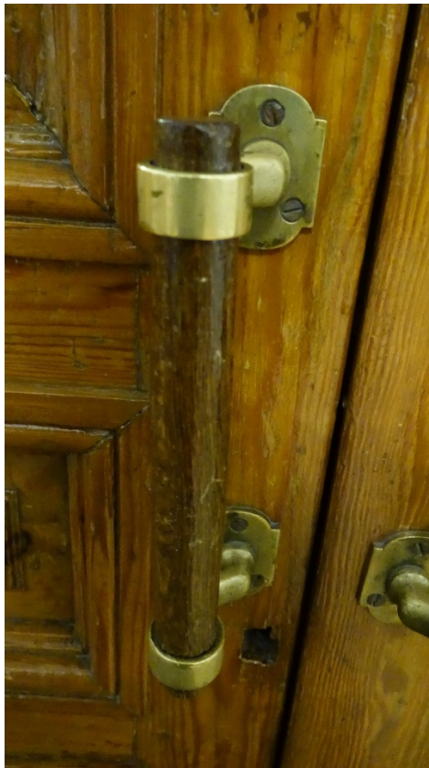
Фото 7. Фурнитура дверей – деревянная ручка-скоба центральных двустворчатых дверей Фрагмент. Дата фотофиксации: 11.12.2023
