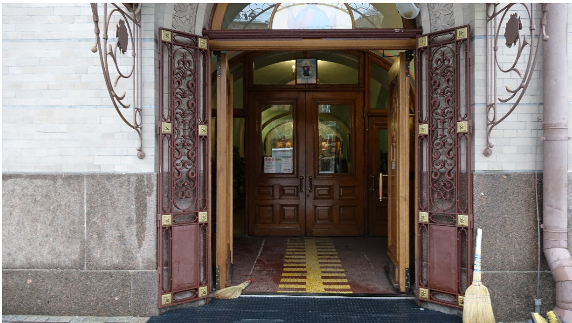
Фото 1. Дверной деревянный портал общий вид со стороны фасада. Дата фотофиксации: 11.12.2023
