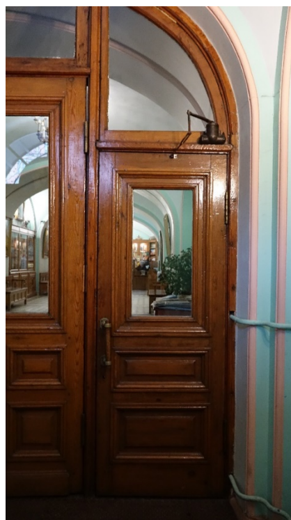
Фото 6. Боковая створка дверного заполнения Дата фотофиксации: 11.12.2023
