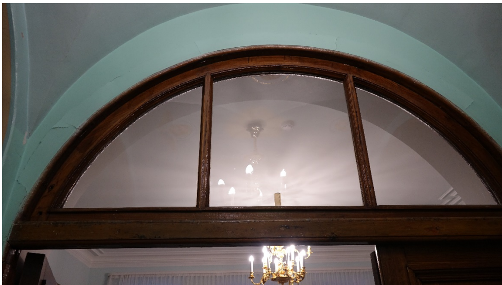
Фото 17. Глухая остеклённая фрамуга портала спальни. Вид со стороны коридора. Дата фотофиксации: 11.12.2023
