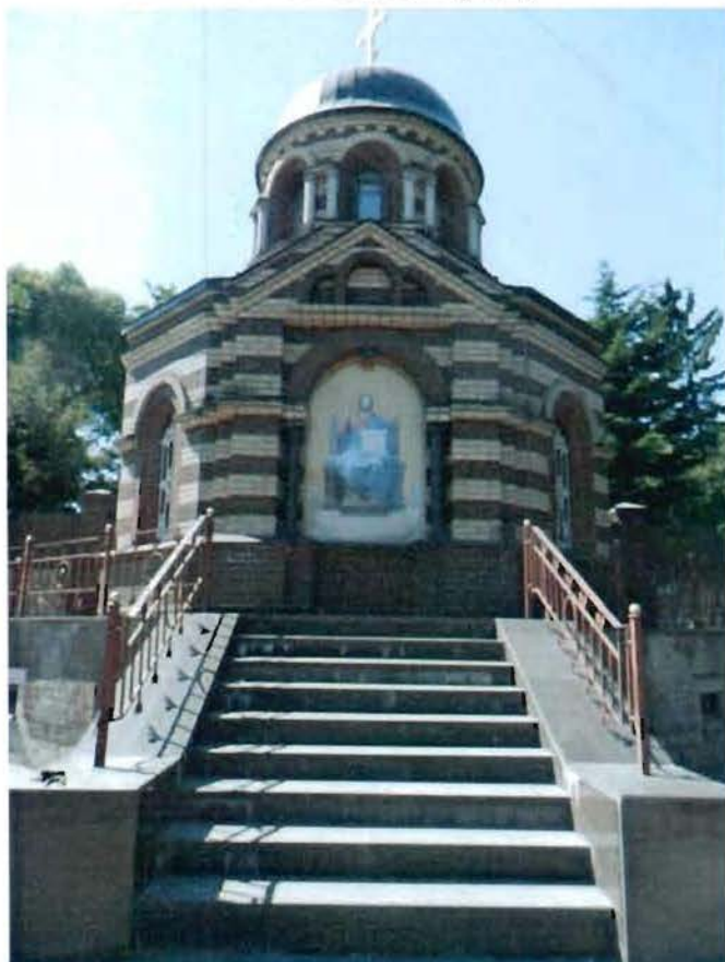
Часовня 20. Лицевой фасад
