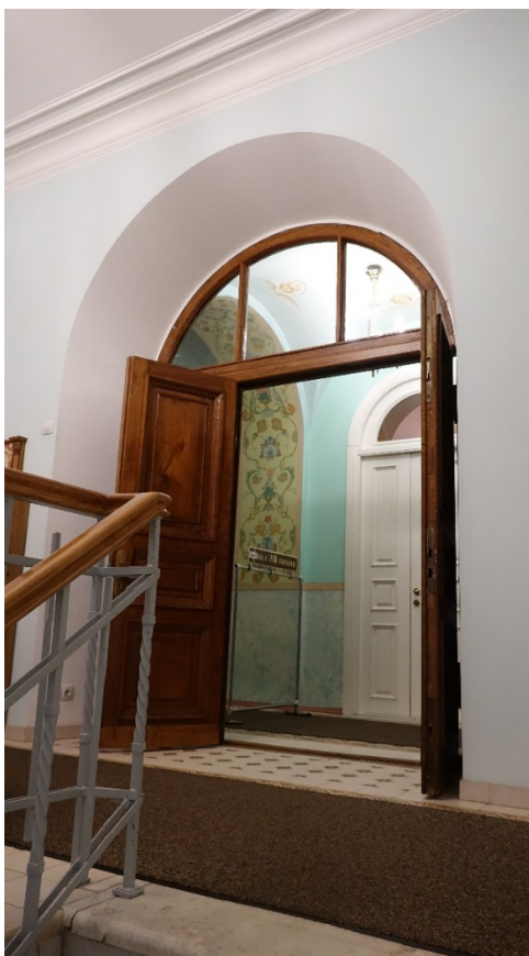
Фото 15. Вид на дверное заполнение со стороны ступеней лестницы в нижний храм. Дата фотофиксации: 11.12.2023
