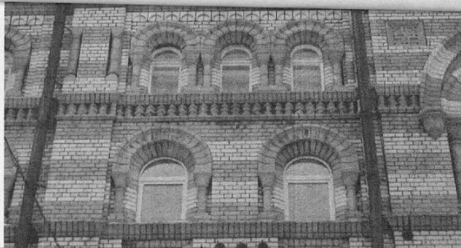
17. Главный корпус. Лицевой фасад. Окна хоров.
