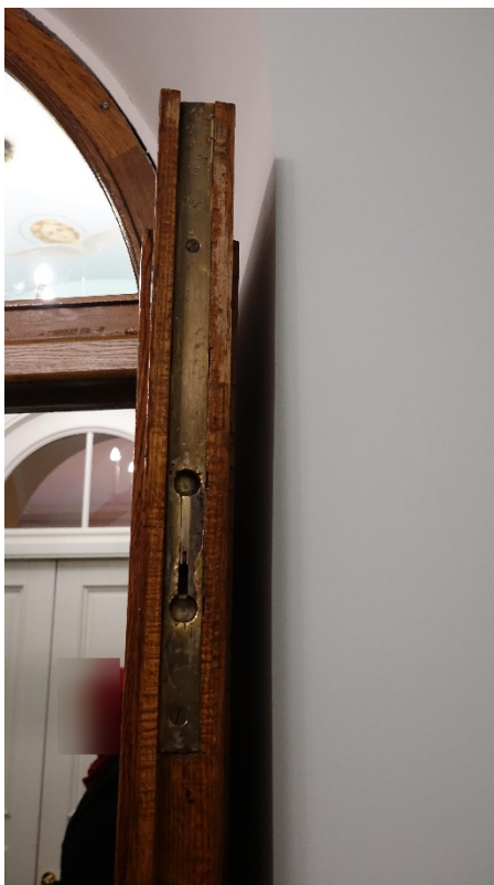
Фото 20. Фурнитура дверей – замковый механизм боковой створки. Дата фотофиксации: 11.12.2023
