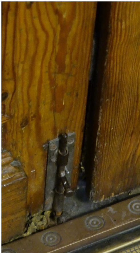
Фото 8. Металлический шпингалет в нижней части центральных двустворчатых дверей и латунный порожек. Дата фотофиксации: 11.12.2023
