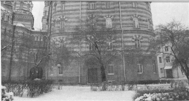
5. Жилой корпус. Вид с востока.
