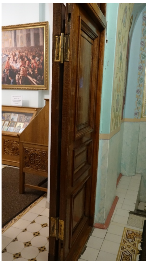
Фото 16. Деревянный портал усыпальницы. Фурнитура дверей – дверные петли боковой створки. Общий вид. Дата фотофиксации: 11.12.2023
