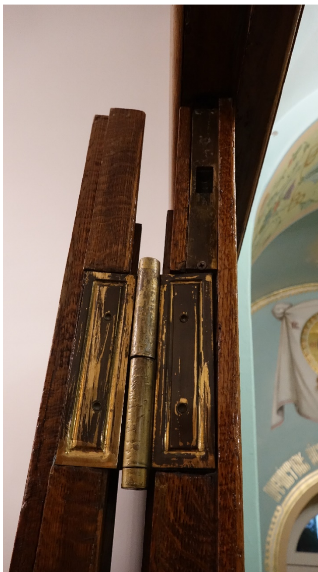
Фото 18. Фурнитура дверей портала спальни – дверная петля боковой створки. Фрагмент. Дата фотофиксации: 11.12.2023
