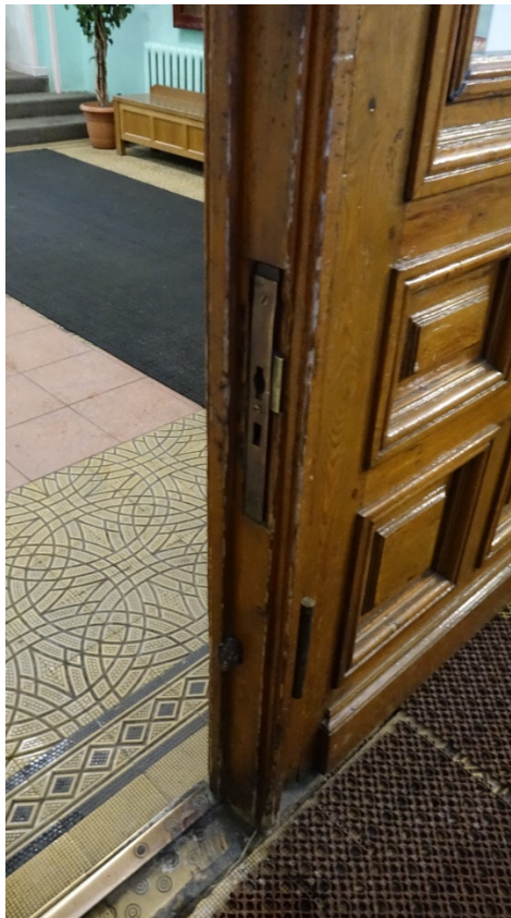
Фото 11. Фурнитура дверей – замковый механизм боковой створки. Дата фотофиксации: 11.12.2023
