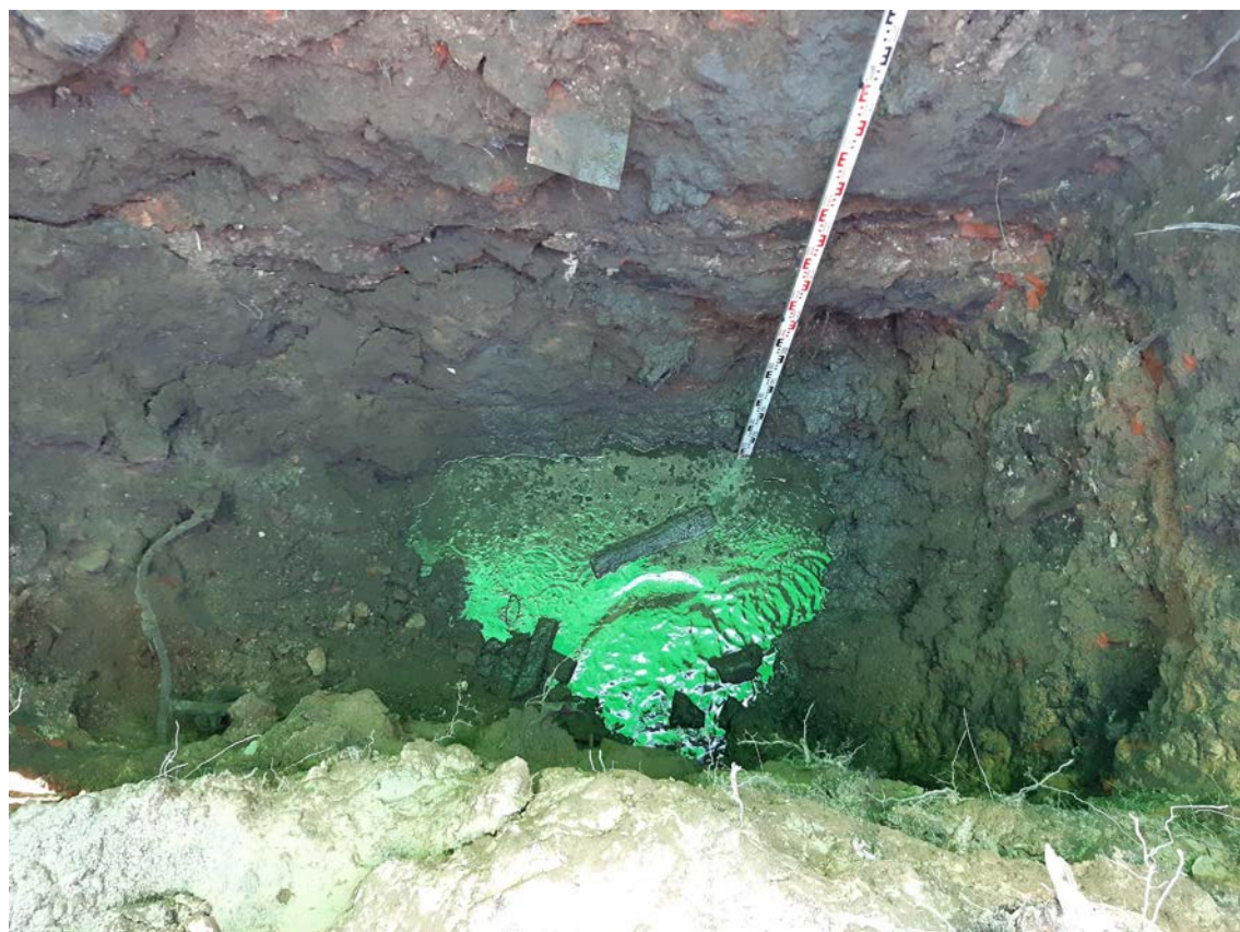
Рис. 46. Санкт-Петербург, Приморский р-н, Приморский пр., участок 114. Шурф 1. Фотофиксация дна шурфа, затопленного грунтовыми водами. Вид на юг.
