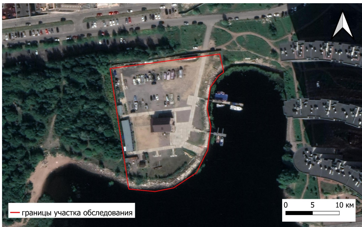
Рис. 4. Санкт-Петербург, Приморский р-н, Приморский пр., участок 114. Расположение участка обследования на спутниковом снимке Google (23.08.2022).
