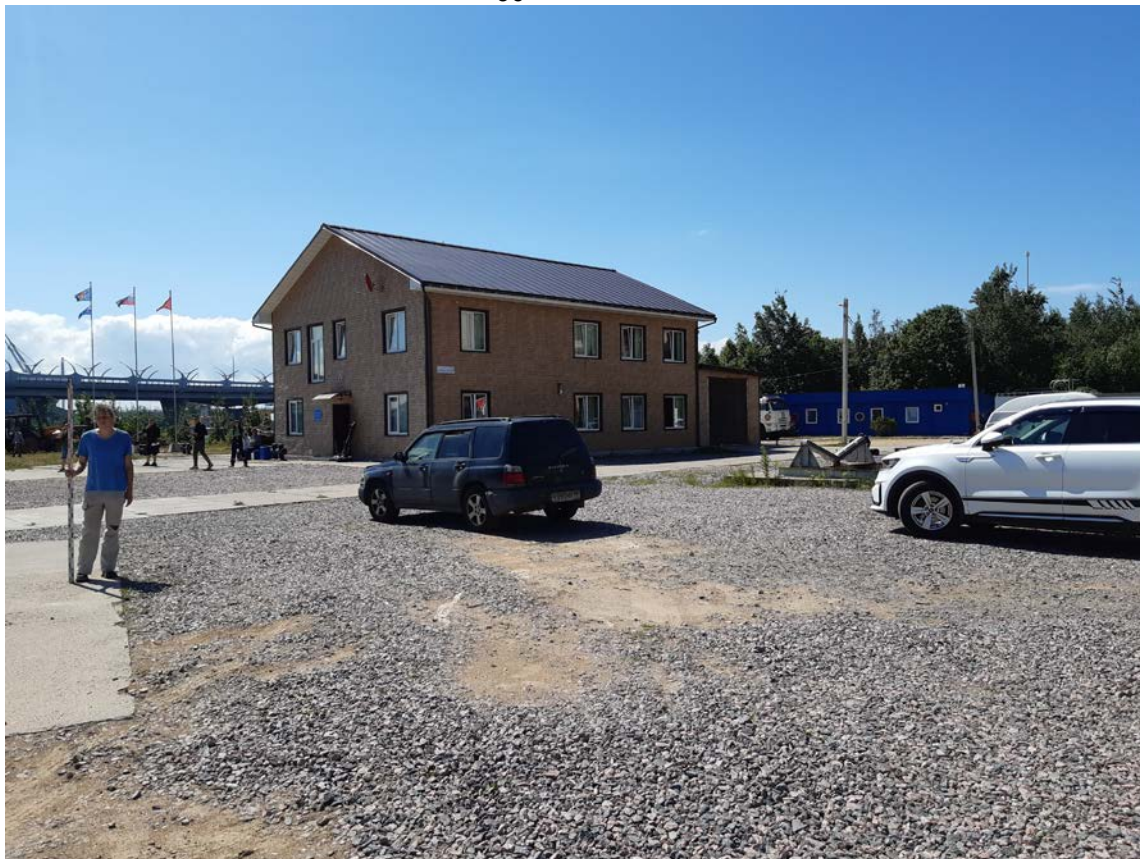
Рис. 33. Санкт-Петербург, Приморский р-н, Приморский пр., участок 114. Общий вид участка. Точка съёмки 6. Вид на юго-запад.
