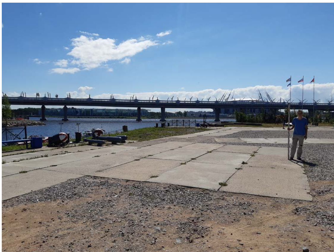
Рис. 32. Санкт-Петербург, Приморский р-н, Приморский пр., участок 114. Общий вид участка. Точка съемки 6. Вид на юг.
