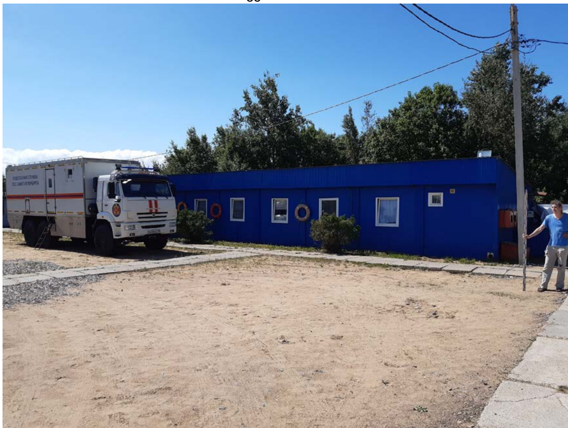
Рис. 23. Санкт-Петербург, Приморский р-н, Приморский пр., участок 114. Общий вид участка. Точка съёмки 4. Вид на юго-запад.
