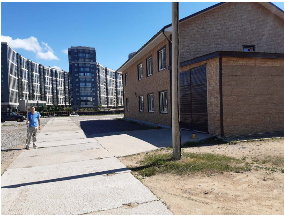
Рис. 22. Санкт-Петербург, Приморский р-н, Приморский пр., участок 114. Общий вид участка. Точка съёмки 4. Вид на восток.
