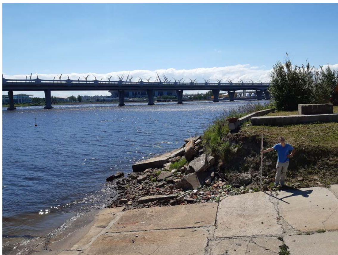
Рис. 42. Санкт-Петербург, Приморский р-н, Приморский пр., участок 114. Общий вид участка. Точка съёмки 13. Вид на юго-запад.
