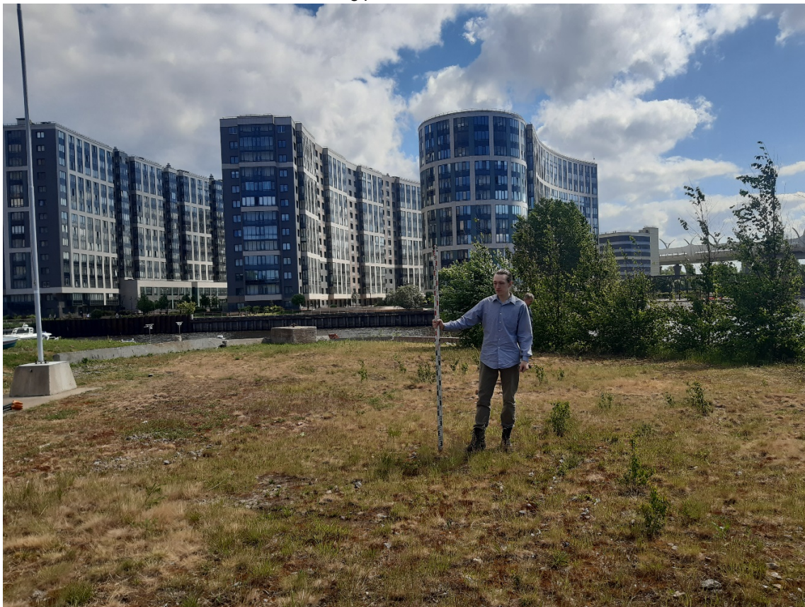
Рис. 15. Санкт-Петербург, Приморский р-н, Приморский пр., участок 114. Общий вид участка. Точка съёмки 1. Вид на восток.
