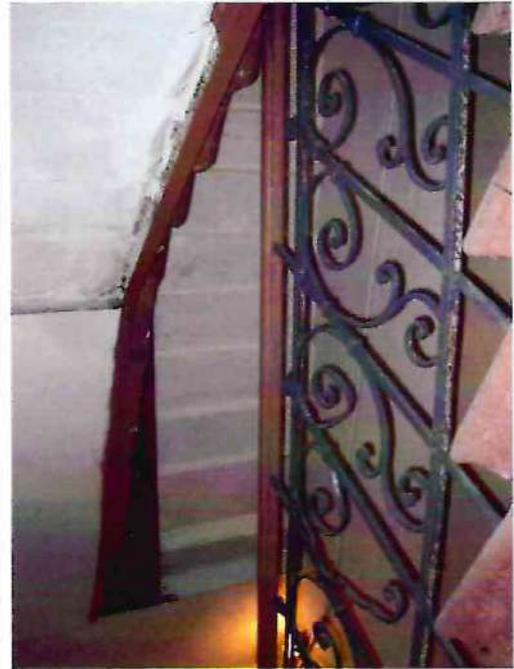
ограждение лестничных маршей кованного черного металла из завитков закрепленных между вертикальными стержнями;
