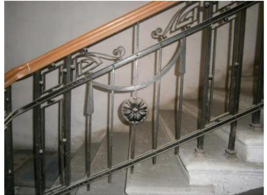
черная лестница – конструкция маршей на косоурах, известняковые ступени, металлическое ограждение, деревянный профилированный поручень.
