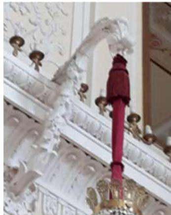
52 бра (свинец, литье) на 3 светоточки. Укреплены по краю антабмента (на продольных стенах по 21 ед., на поперечных по 5 ед.).
