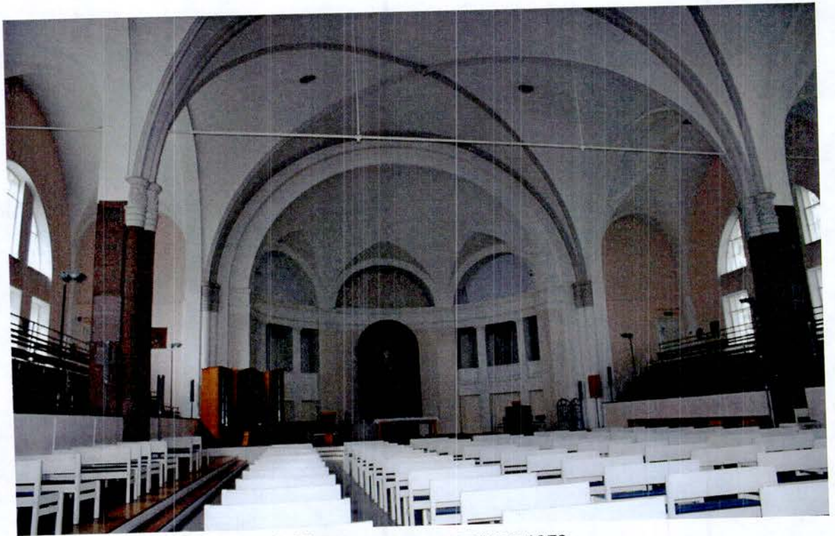
3. Интерьер центрального зала.
