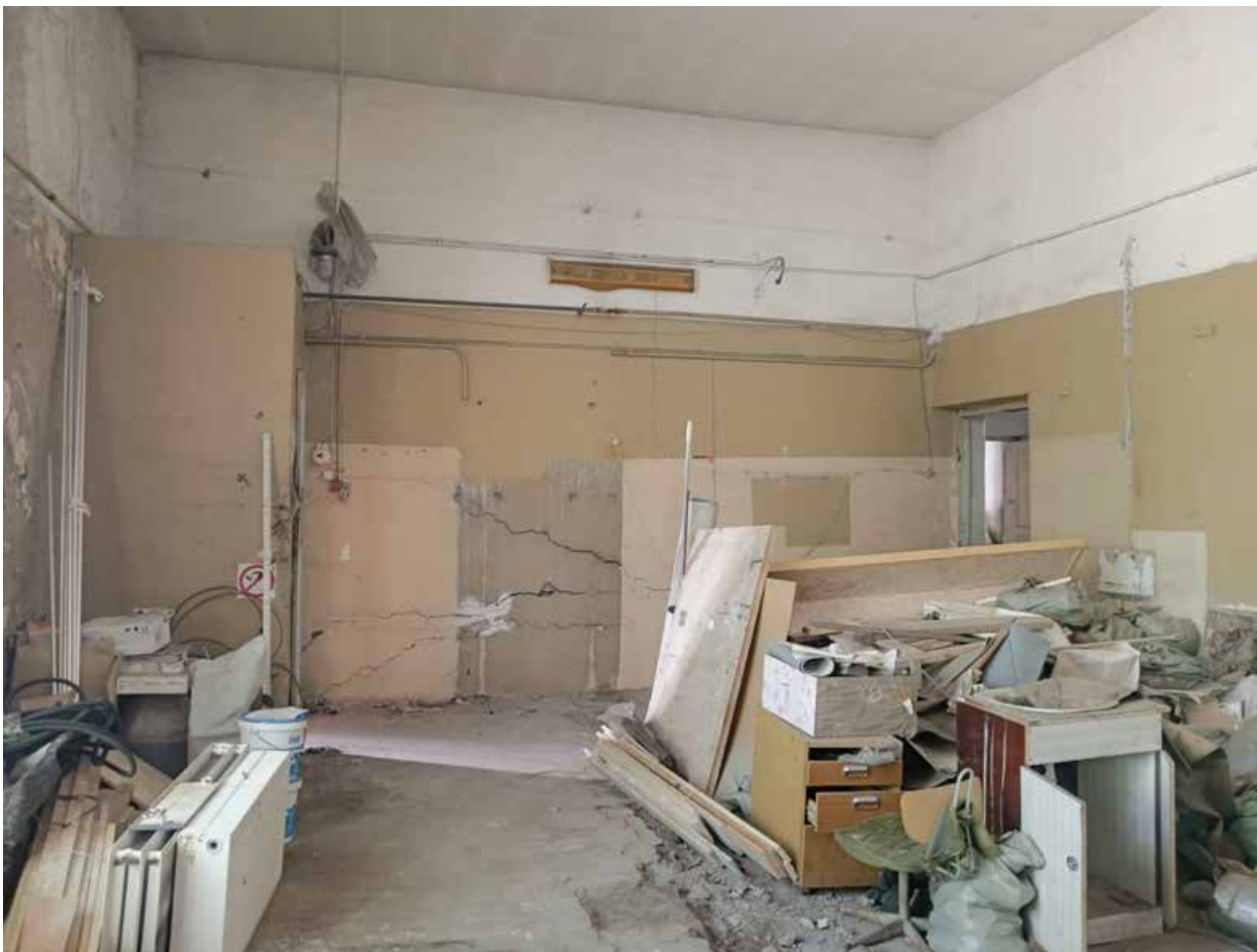
Фото 8. Объект культурного наследия федерального значения «Храм евангелическо-лютеранский Апостола Петра», Санкт-Петербург, Невский проспект, дом 22-24, литеры А, Б, Ж, дом 22а, литера А. Флигель (лит.Ж). Помещение 33-Н (2). Фрагмент.
