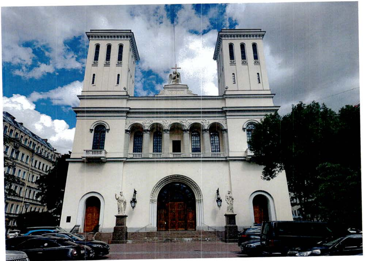
1. Вид на южный фасад.
