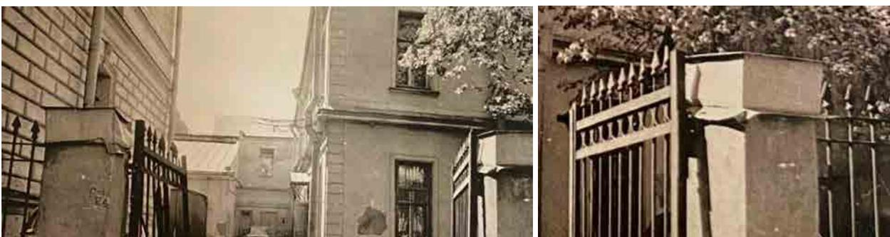
18. Фрагмент фотографии 1991 г. (см. илл. 51, 52 Том 2.1, шифр: 0172200003824000011-ЭА/2024-ИАБИ), навершие воротных столбиков утрачено, выполнено покрытие столбика односкатным металлическим листом, чуть ниже по периметру столба устроена металлическая «юбочка». Ворота уже находятся на разном уровне.
