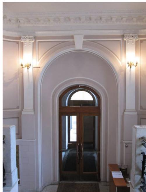
рустованная поверхность стен в нижней трети стены, гладкая штукатурка в верхних 2/3 стены;
