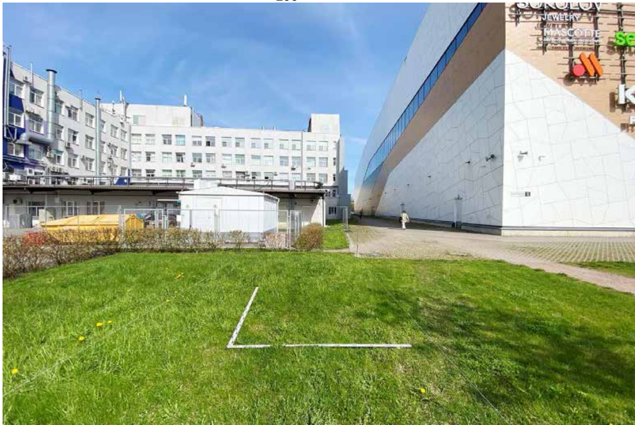
Рис. 45. СПб-2024. Красногвардейский р-н. Земельный участок: 78:11:0006047:2514. Шурф №2. Общий вид до начала работ. Вид с юга.
