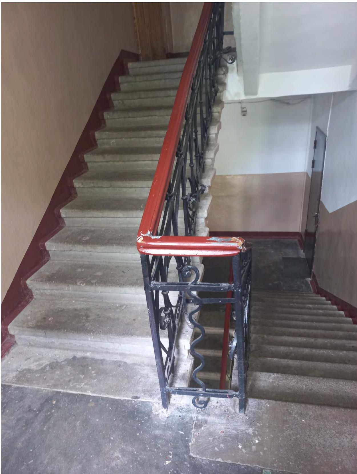
Фото 8. Лестница. Вид с площадки между 2 и 3 этажами. Известняковые ступени, металлические ограждения с профилированными деревянными поручнями.
