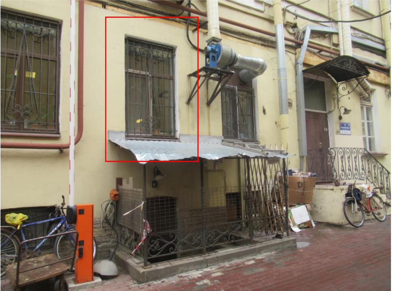
9. Дворовый (южный) фасад лицевого флигеля. Фрагмент. Над приемком выделен оконный проем, предполагаемый к переустройству в дверной проем дополнительного входа.
