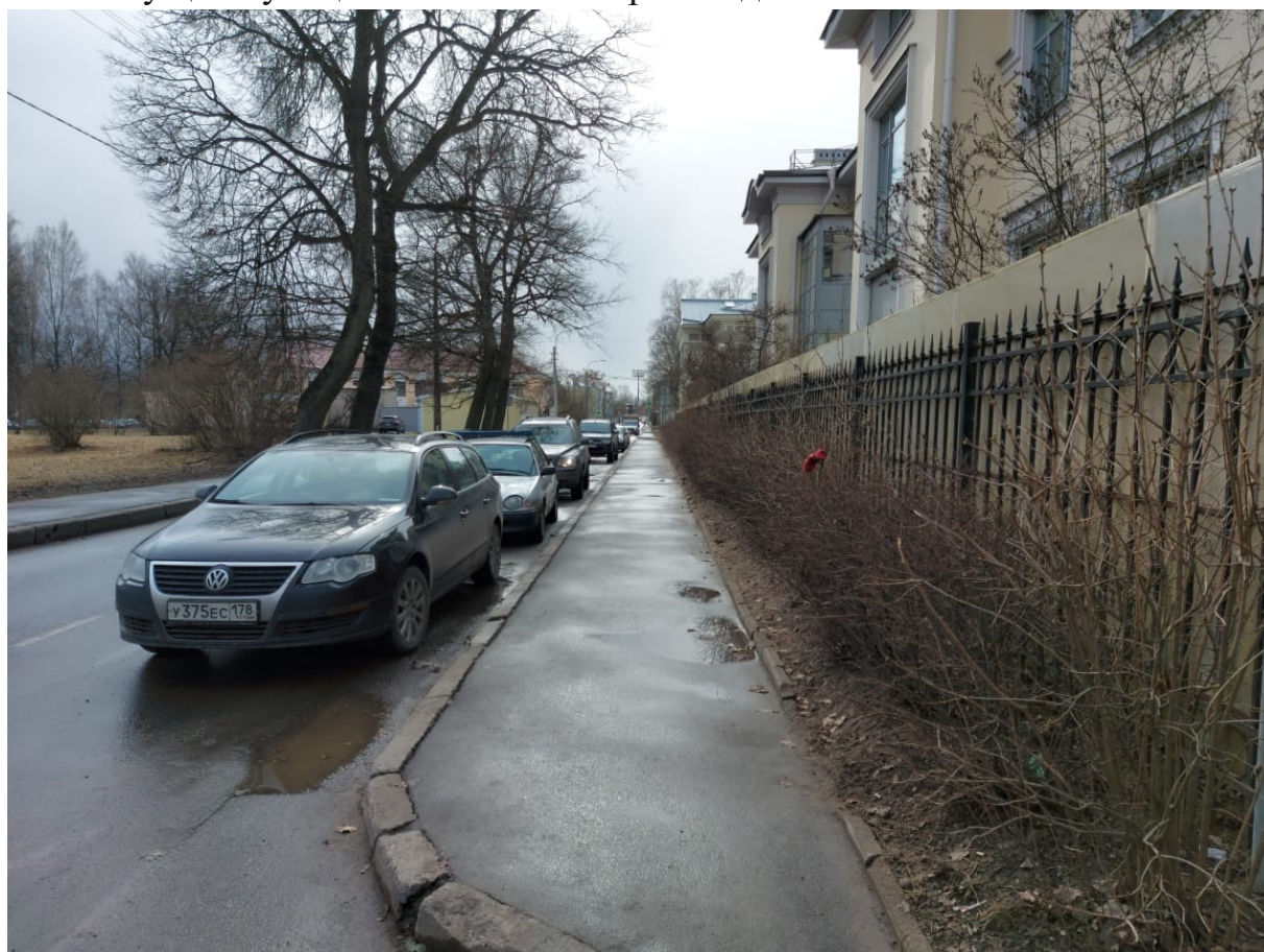
Точка фотофиксации 7. Улица Госпитальная, трасса перекладки электрического кабеля. Вид с СВ.
