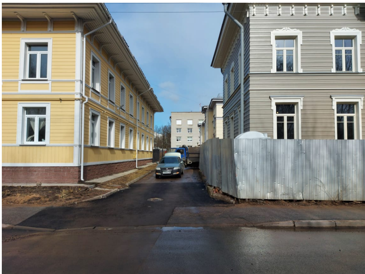
Точка фотофиксации 2. Проезд между домами по ул. 1 Мая, 14 и ул. Госпитальная, д. 9/20, лит. А. Вид с ЮЗ.
