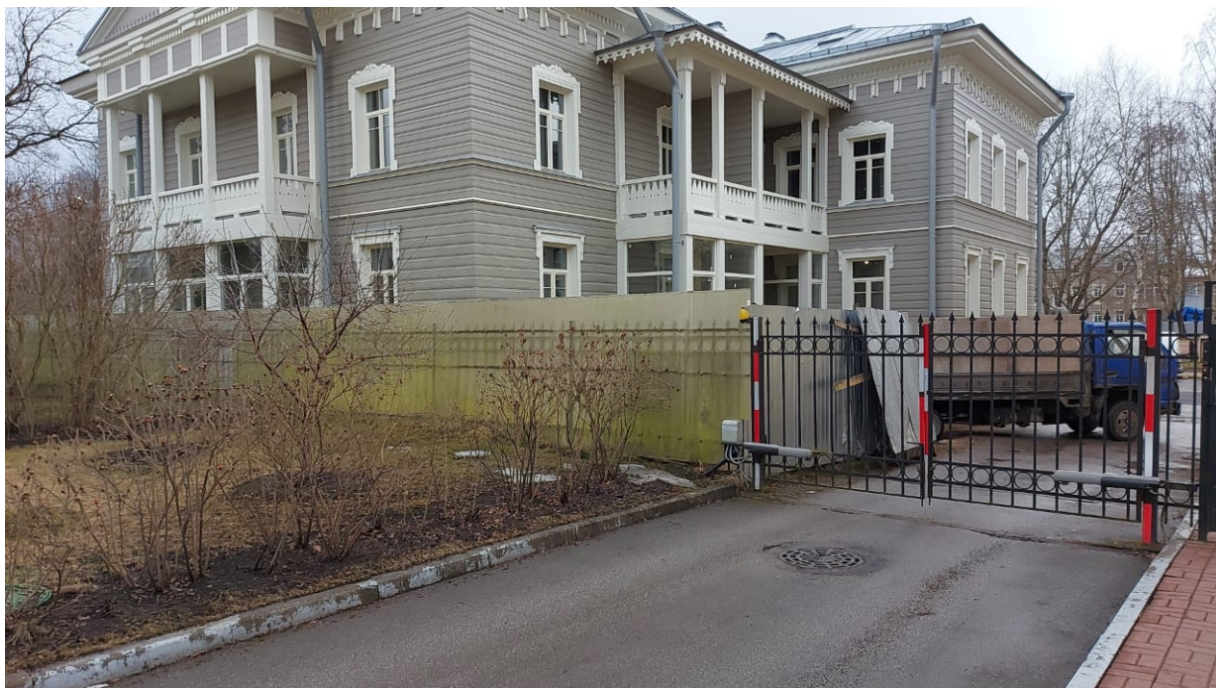
Точка фотофиксации 3. Дом по ул. Госпитальная, д. 9/20, лит. А. Вид с С.
