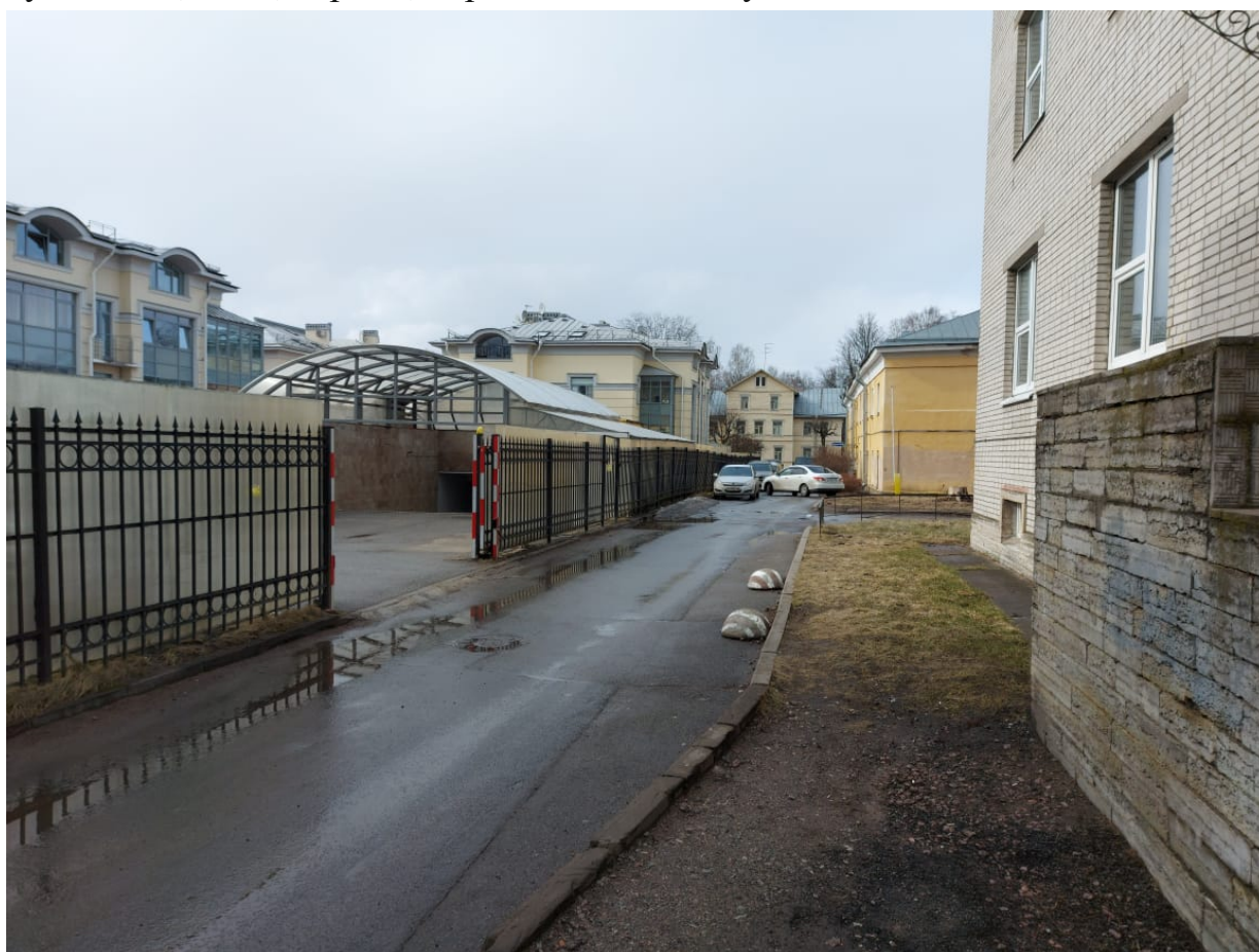
Точка фотофиксации 9. Проезд между домами по ул. Госпитальная, 1 и ул. 1 Мая, д. 10, корп. 6, трасса перекладки электрического кабеля. Вид с ЮВ.
