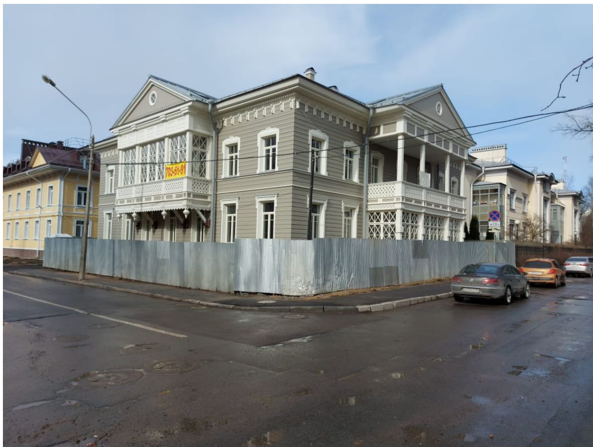
Точка фотофиксации 1. ул. Госпитальная, д. 9/20, лит. А. Общий вид с Ю.
