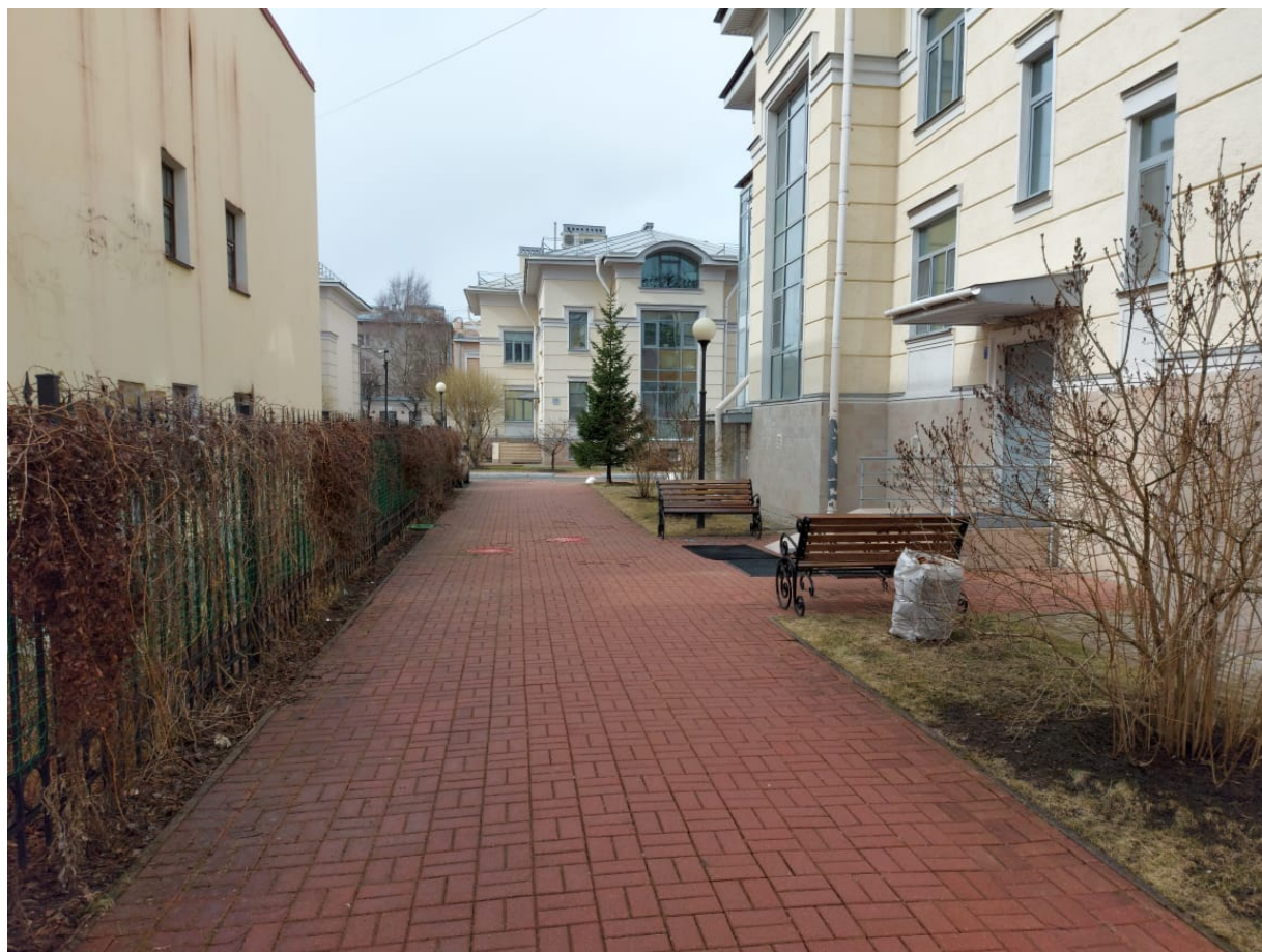
Точка фотофиксации 6. Проход между домами по ул. 1 Мая, 12 и 10. Люки существующей тепловой камеры. Вид с ЮВ.
