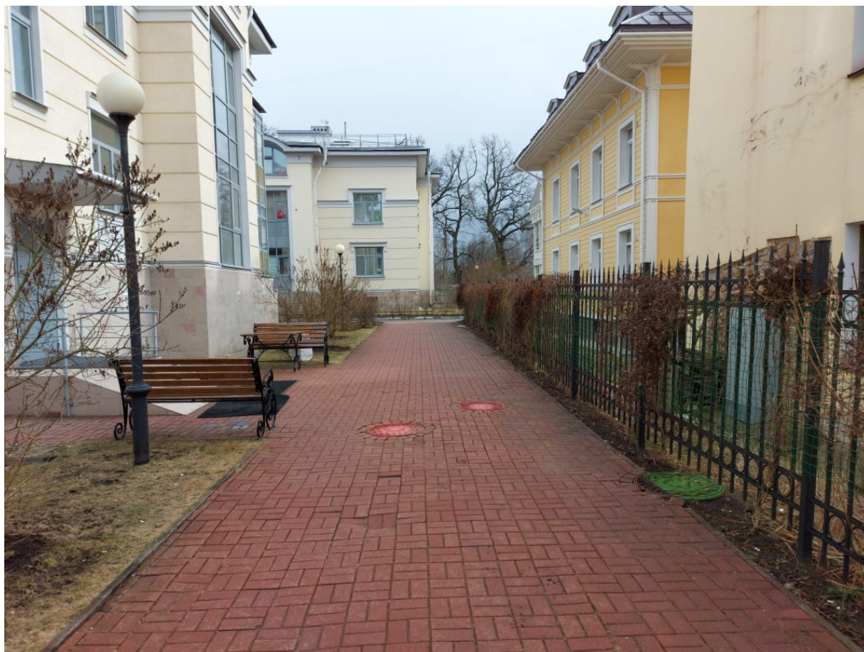
Точка фотофиксации 5. Проход между домами по ул. 1 Мая, 12 и 10. Люки существующей тепловой камеры. Вид с СЗ.
