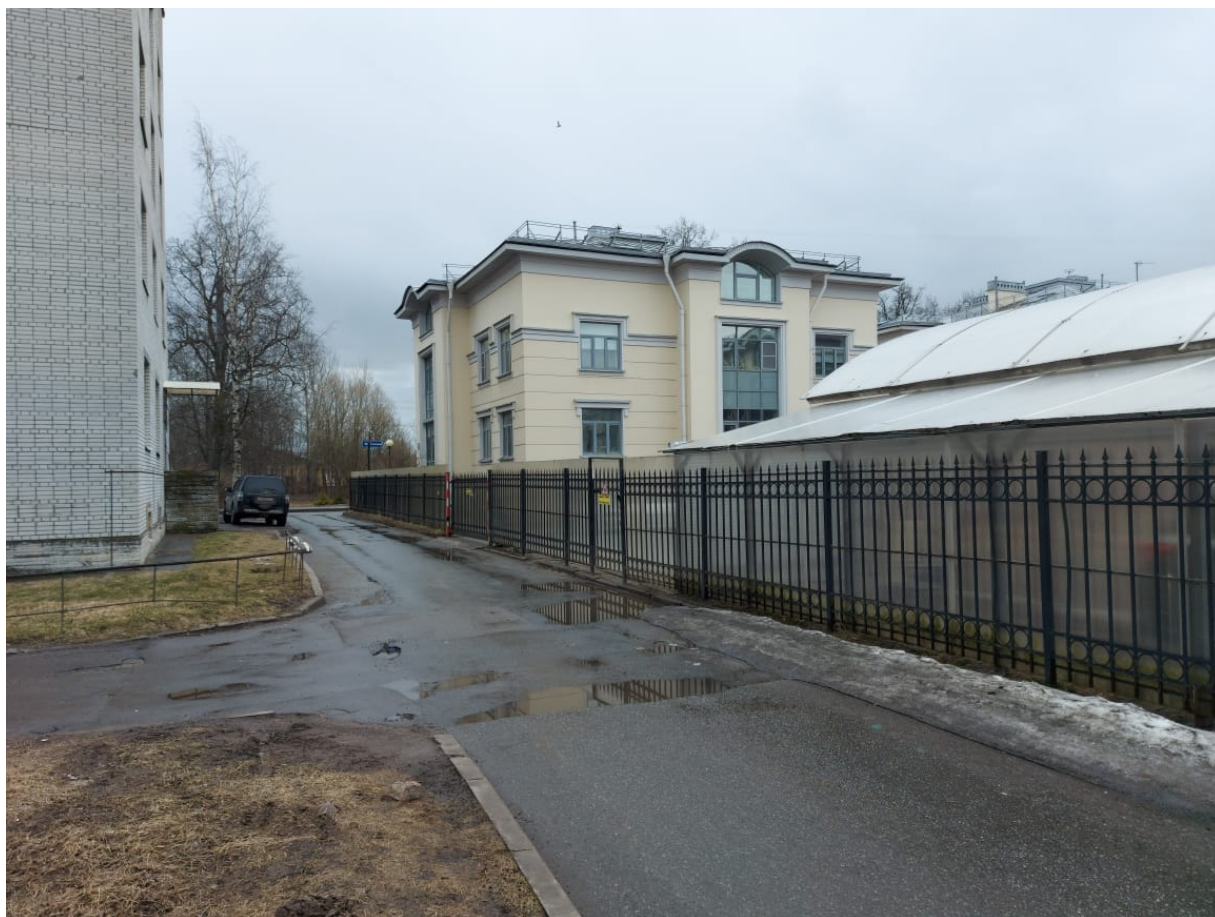
Точка фотофиксации 10. Проезд между домами по ул. Госпитальная, 1 и ул. 1 Мая, д. 10, корп. 6, трасса перекладки электрического кабеля. Вид с СЗ.
