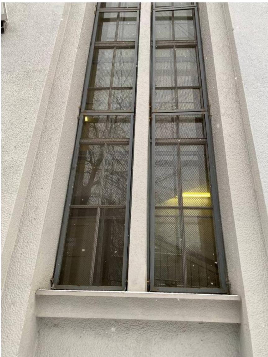
**13. Здание вторичной понижающей подстанции. Фрагмент северного фасада. Центральное окно лестничной клетки с железобетонным оконным переплётом.**
