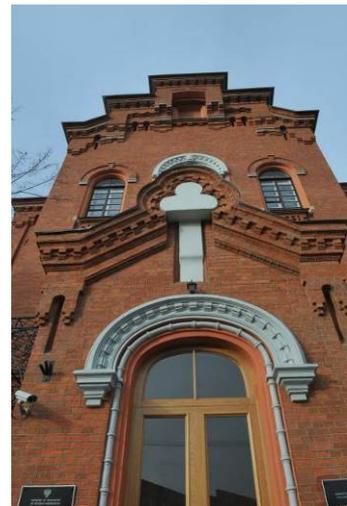
исторические дверные проемы - местоположение, габариты, конфигурация, в т.ч. арочные проемы главного входа и входов со стороны сада; материал (дуб) и рисунок дверных заполнений;
