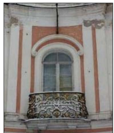
заполнение балконного дверного проема – материал (дерево), исторический рисунок расстекловки (двойные рамы, шестичастная система расстекловки с полуциркульной фрамугой);
