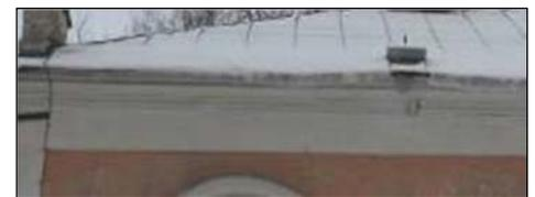
оформление лучкового аттика над центральным выступом – сдвоенные гладкие лопатки, раскрепованный профилированный карниз;
