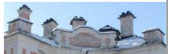
оформление кирпичных дымовых и вентиляционных труб – профилем по верхнему краю и гладкий фриз в завершении
