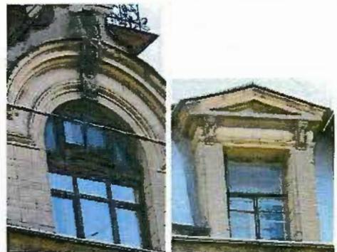
полуколонны и пилястры с капителями римско-дорического ордера, фриз с горизонтальными профилированными филёнками, выносной профилированный карниз на штукатурных кронштейнах, рустованные угловые лопатки;
