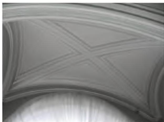
стены эркера разбиты штукатурными профилированными тягами на филенки;
