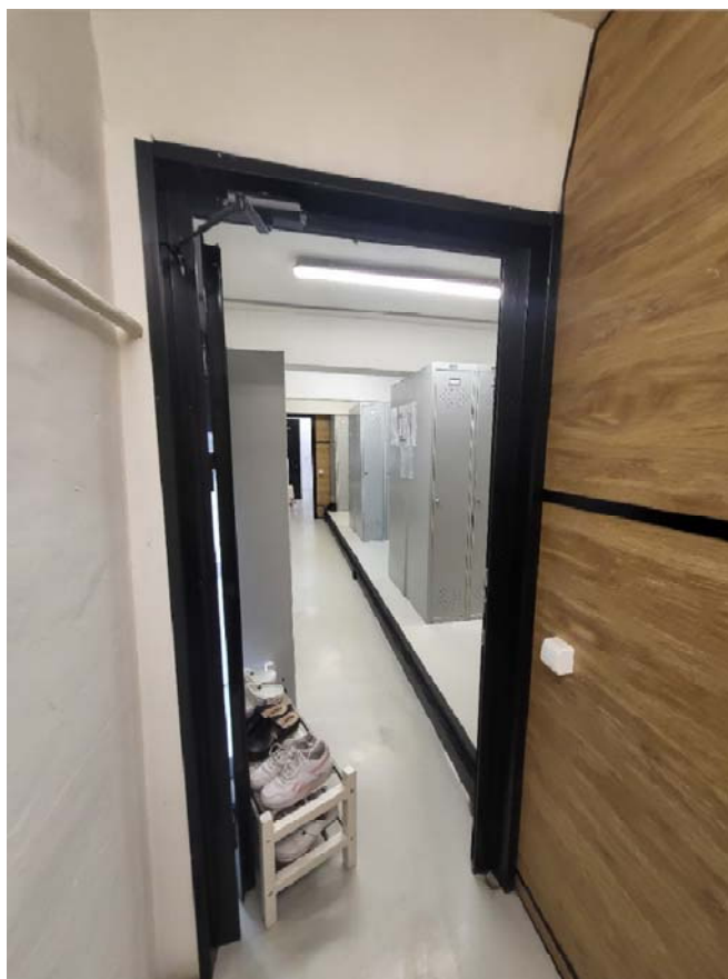
Фото №32. Вид на помещения 2-й антресоли. Помещение №28 согласно экспликации.
