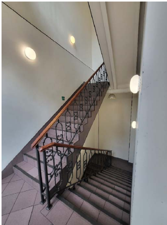
Фото №46. Вид на лестничную клетку второго этажа. Помещение №72 согласно экспликации.
