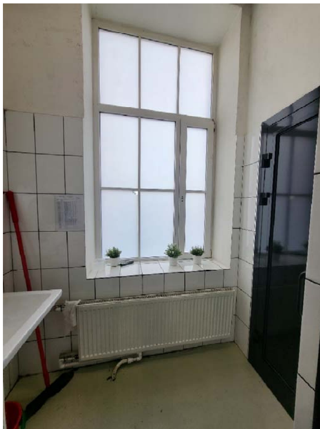
Фото №79. Вид на тамбур санузла.
