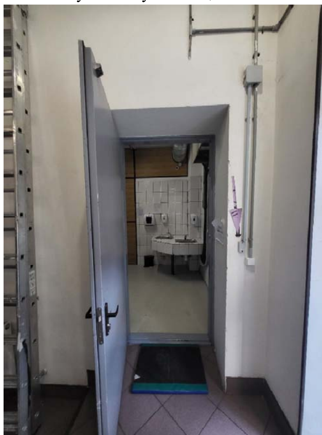
Фото №7. Вид на вход с лестничной клетки в помещения первого этажа.
