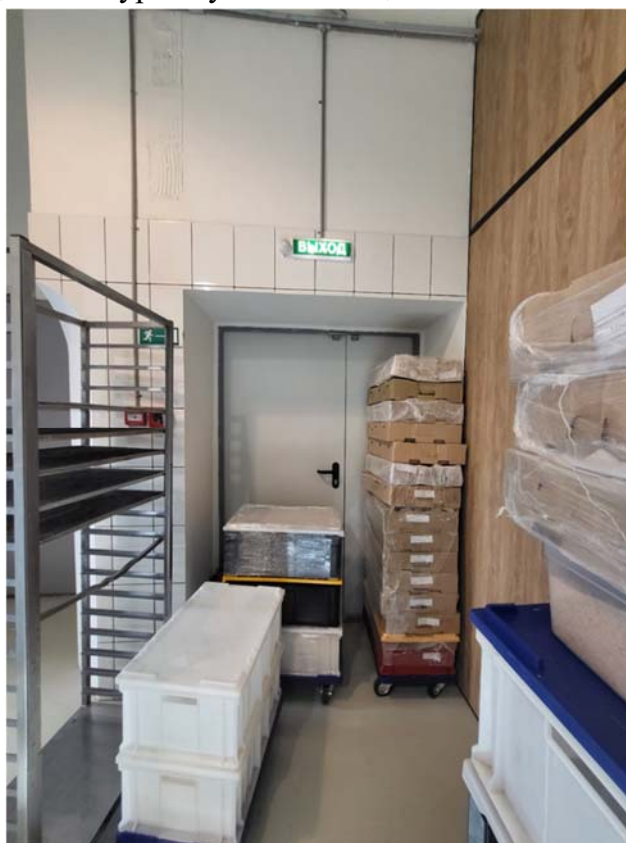
Фото №63. Вид на выход на лестничную клетку.
