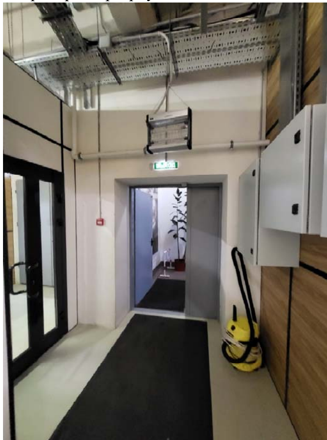
Фото №29. Вид на выход на лестничную клетку. Из помещения №4 в №43 согласно экспликации
