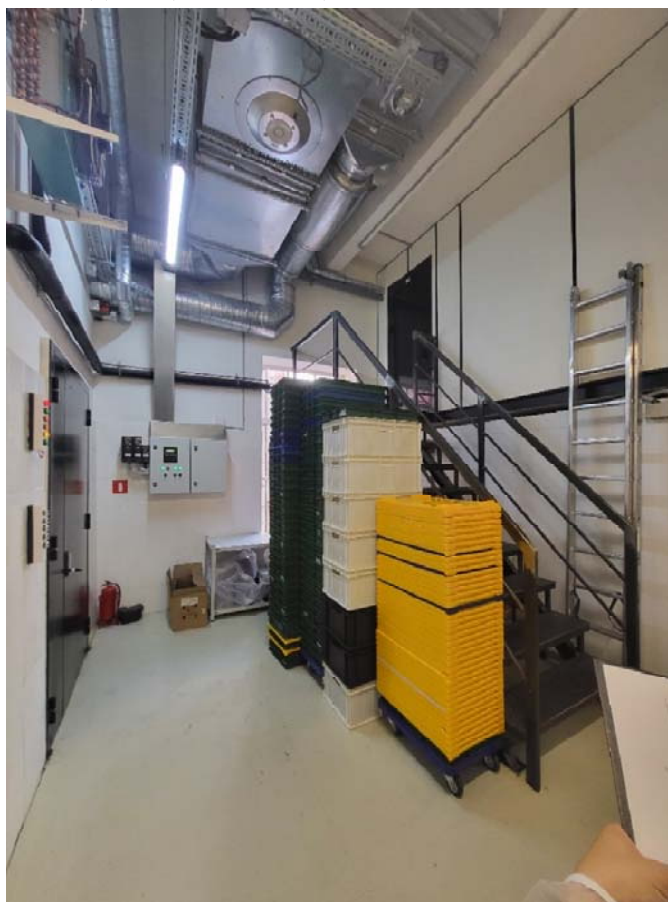
Фото №51. Вид на лестницу антресоли. Помещение №56 согласно экспликации.
