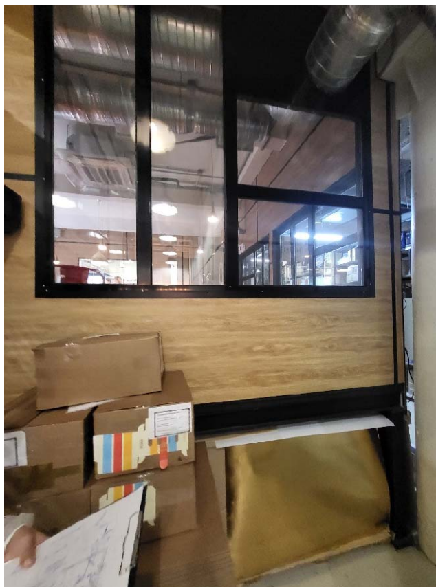
Фото №44. Вид на стену обеденного зала. Помещение №4 согласно экспликации.
