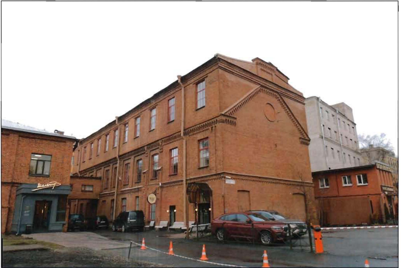
4. Общий вид части объекта культурного наследия с юго-востока.
