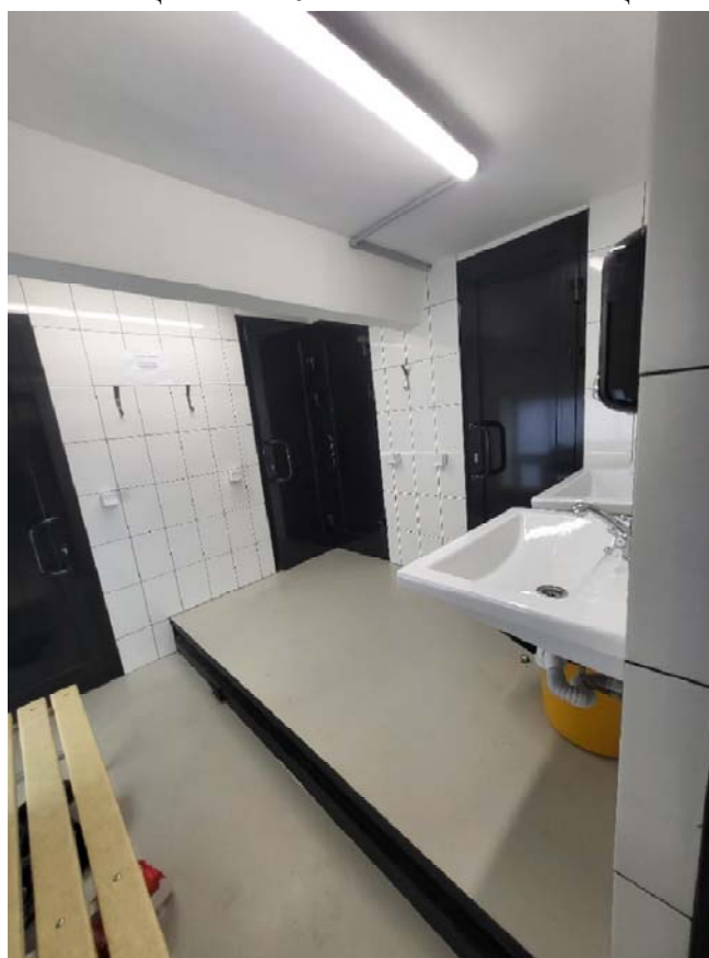
Фото №35. Вид на тамбур санузла 2-й антресоли. Помещение №29 согласно экспликации.
