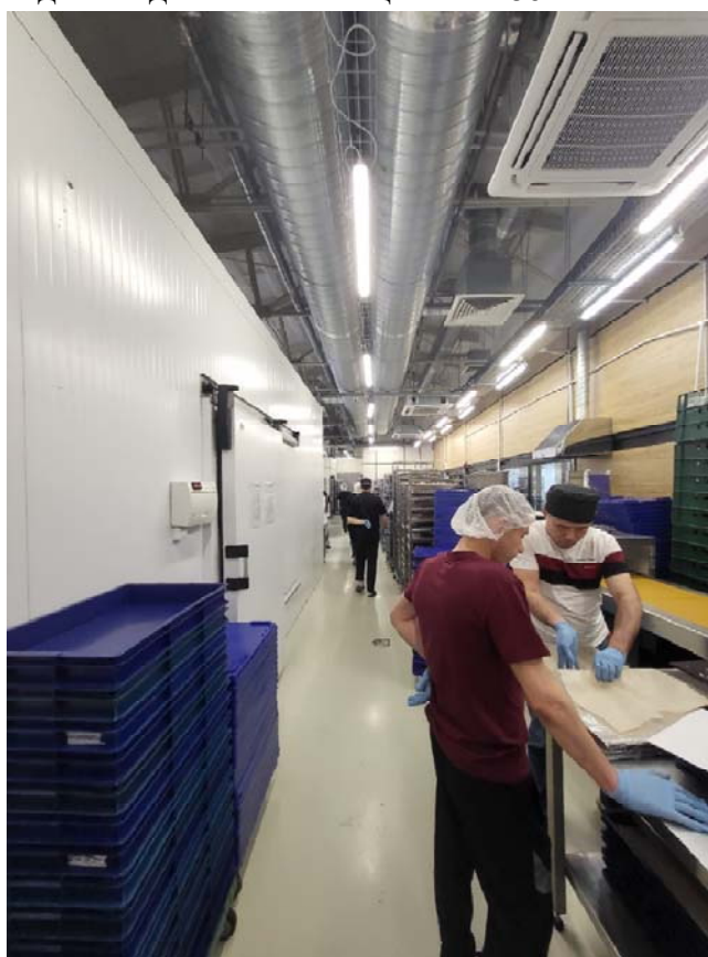
Фото №74. Вид на коридор и морозильные камеры. Помещение №85 согласно экспликации.
