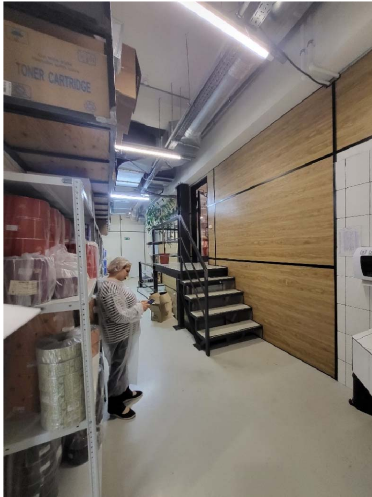
Фото №8. Вид на лестницу антресоли. Помещение №4 согласно экспликации.
