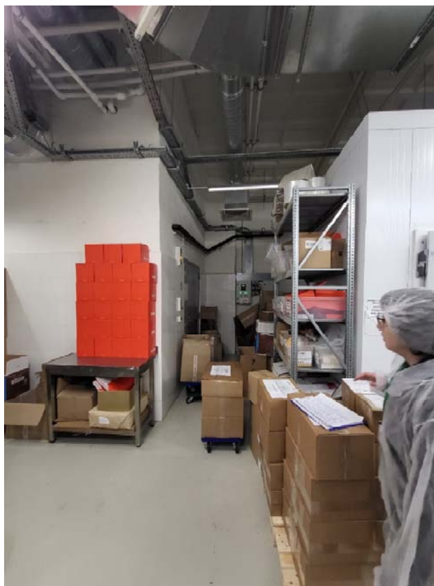
Фото №72. Вид на пространство у грузового лифта. Помещение №85 согласно экспликации.
