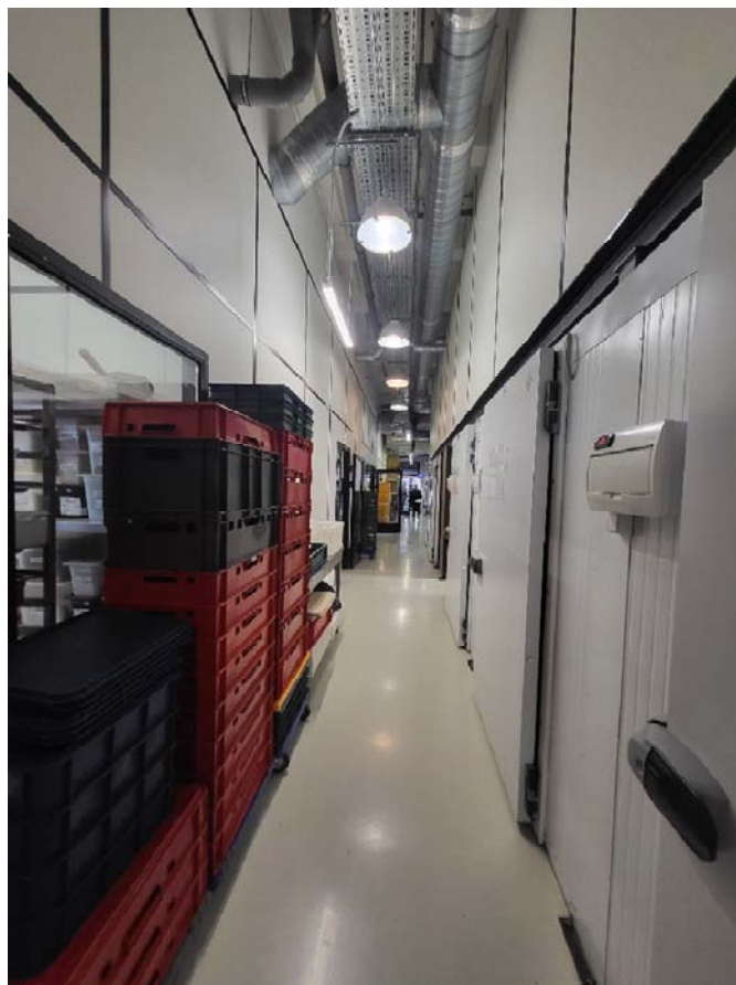
Фото №56. Вид на коридор и морозильные камеры. Помещение №56 согласно экспликации.
