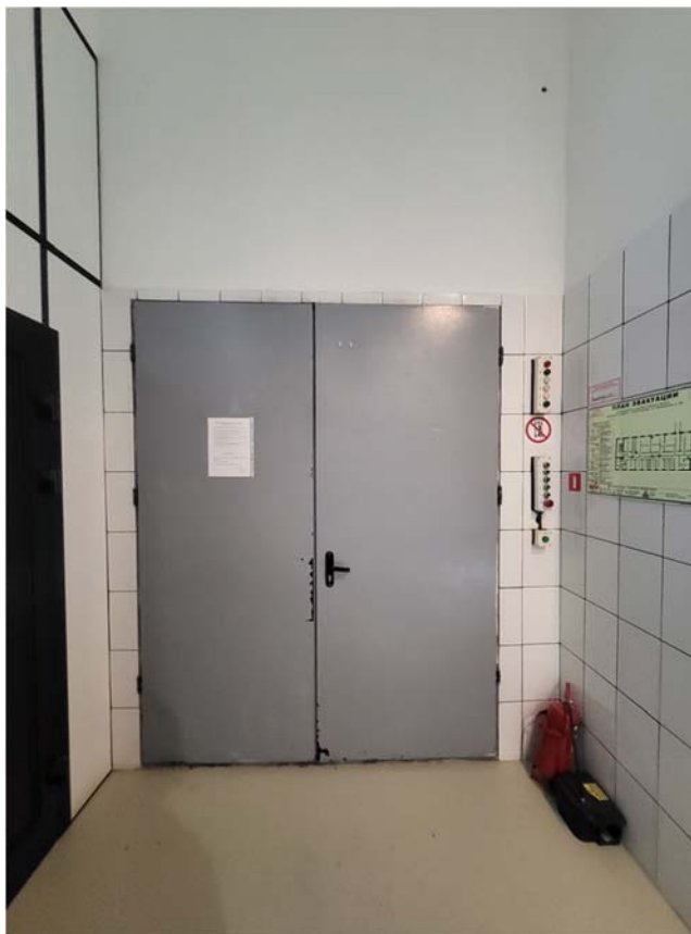
Фото №60. Вид на грузовой лифт. В помещении №56 согласно экспликации.
