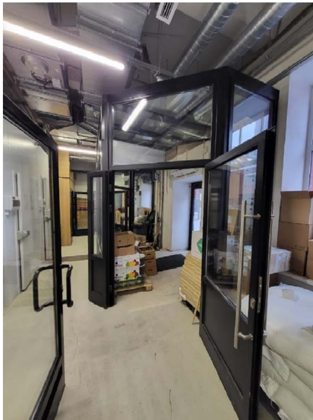
Фото №16. Вид на тамбур в погрузочной зоне. В помещении №40 согласно экспликации.
