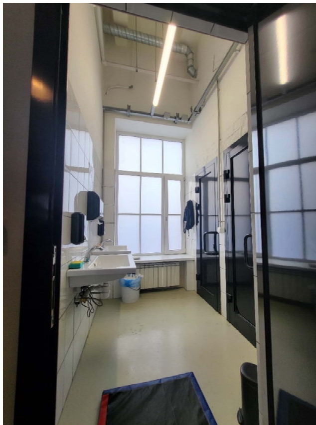
Фото №62. Вид на тамбур санузла. Помещение №66 согласно экспликации.
