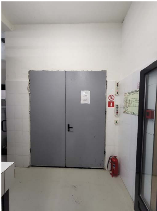
Фото №81. Вид на дверь грузового лифта. Помещение №85 согласно экспликации.
