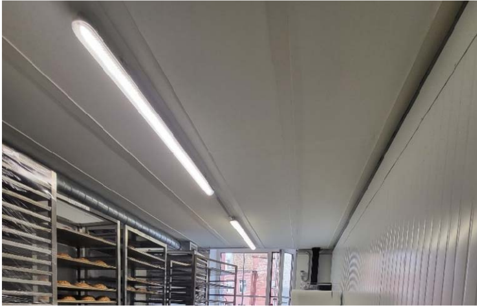
Фото №54. Вид на складское помещение под антресолю. Помещение №59 согласно экспликации.
