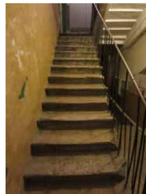
лестница – местоположение (дворовый корпус), тип (двухмаршевая), конструкция (по металлическим косоурам), вид материала ступеней (плиты из известняка), ограждение – вид материала (металл), техника исполнения (ковка), рисунок (вертикальные стойки с розетками);
