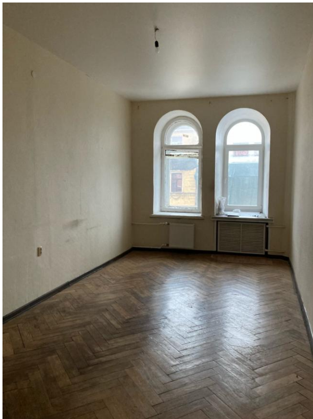
Фото 26. Интерьер квартиры № 24 выявленного объекта культурного наследия «Дом Н.И. Алексеева»
