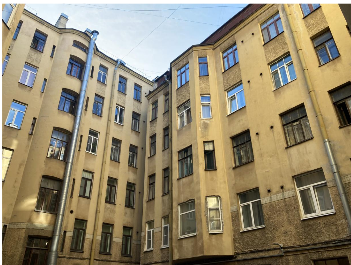
Фото 8. Фрагмент дворового фасада выявленного объекта культурного наследия «Дом Н.И. Алексева»
