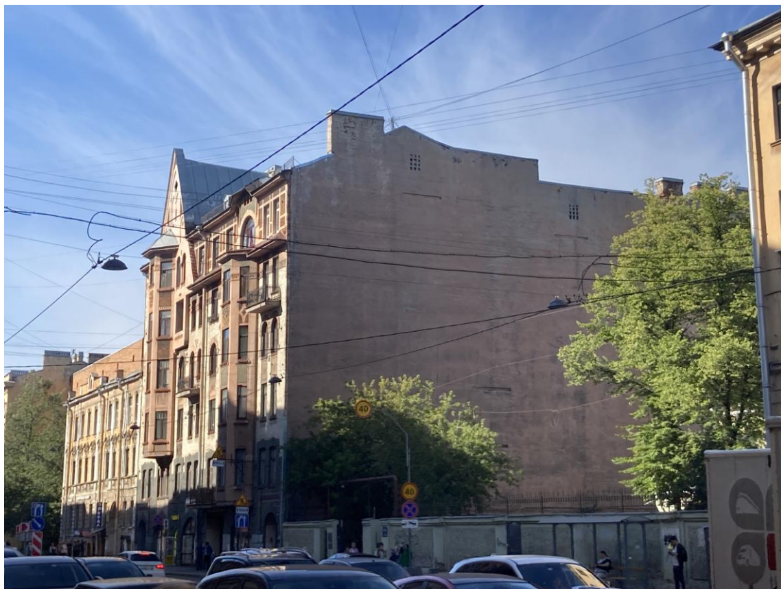
Фото 4. Фрагмент лицевого фасада выявленного объекта культурного наследия «Дом Н.И. Алексева»
