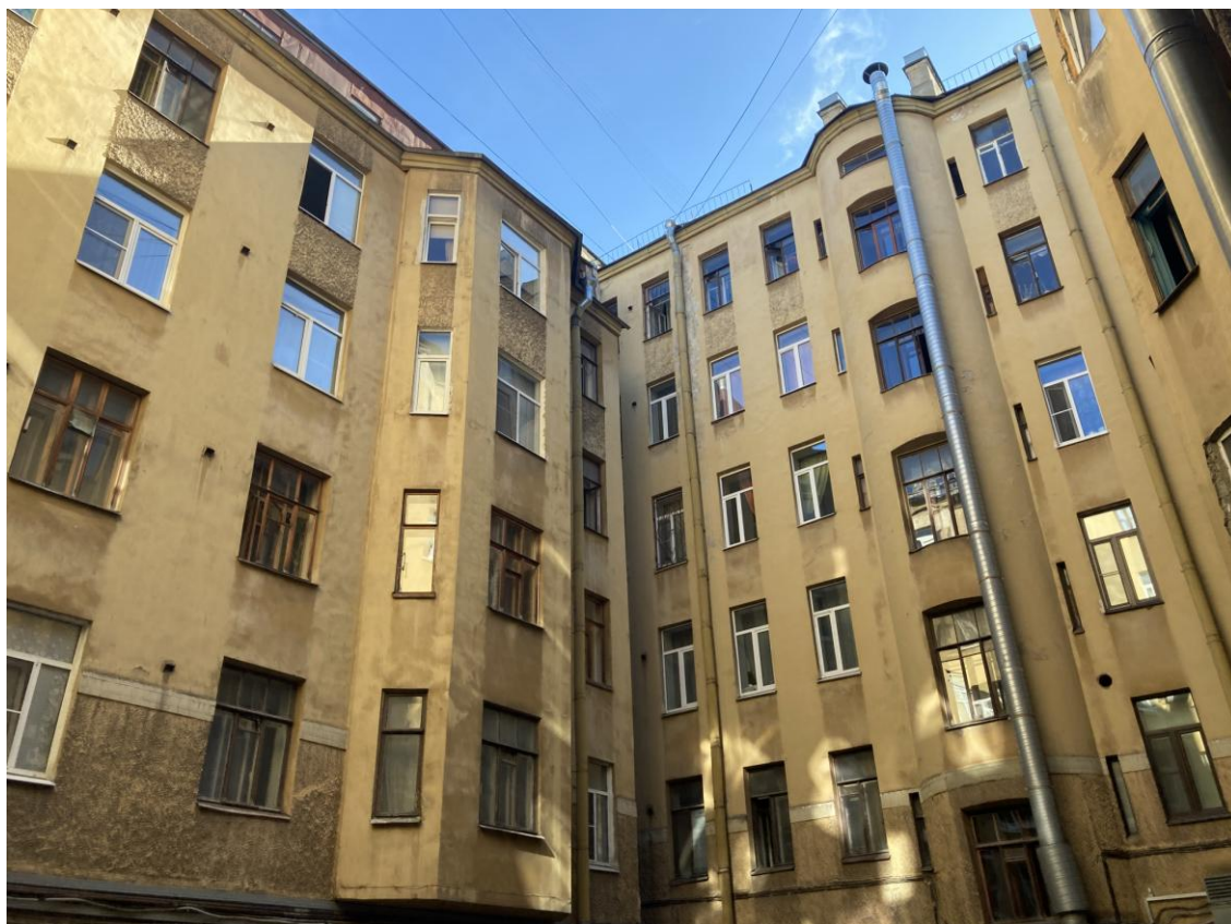
Фото 7. Фрагмент дворового фасада выявленного объекта культурного наследия «Дом Н.И. Алексева»
