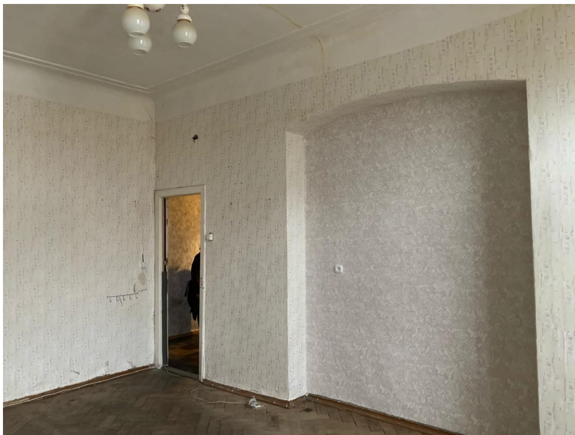
Фото 33. Интерьер квартиры № 24 выявленного объекта культурного наследия «Дом Н.И. Алексеева»
