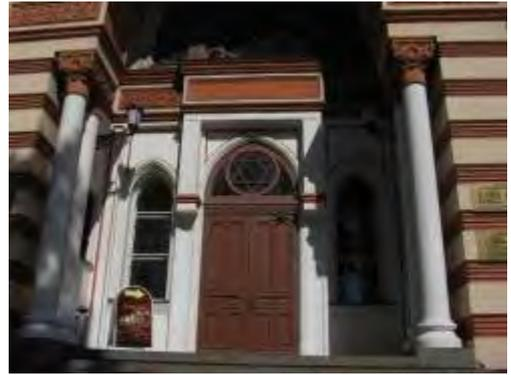
дверное заполнение – конструкция (двухстворчатое, с фигурной фрамугой с витражной расстекловкой), материал (дерево), техника исполнения (токарная работа, резьба), оформление (филенчатое с фигурными и резными деталями);
