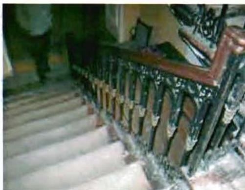
северная лестница – местоположение, габариты, конфигурация; тип (многомаршевая), конструкция (на косоурах), материал ступеней (известняк); ограждение – материал (чугун), техника исполнения (литье), рисунок; поручень – материал (дерево), форма (профилированный);
