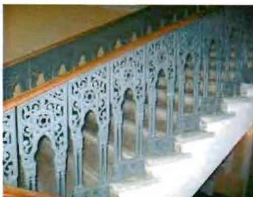
парадная лестница северного флигеля (Малой синагоги) – местоположение, габариты, конфигурация; тип (многомаршевая), конструкция (на косоурах), материал ступеней (известняк); ограждение - материал (металл), техника исполнения (литье), рисунок; поручень – материал (дерево), форма (профилированный);
