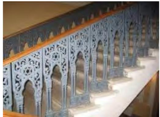
парадная лестница северного флигеля (Малой синагоги) – местоположение, габариты, конфигурация; тип (многомаршевая), конструкция (на косоурах), материал ступеней (известняк); ограждение - материал (металл), техника исполнения (литье), рисунок; поручень – материал (дерево), форма (профилированный);
