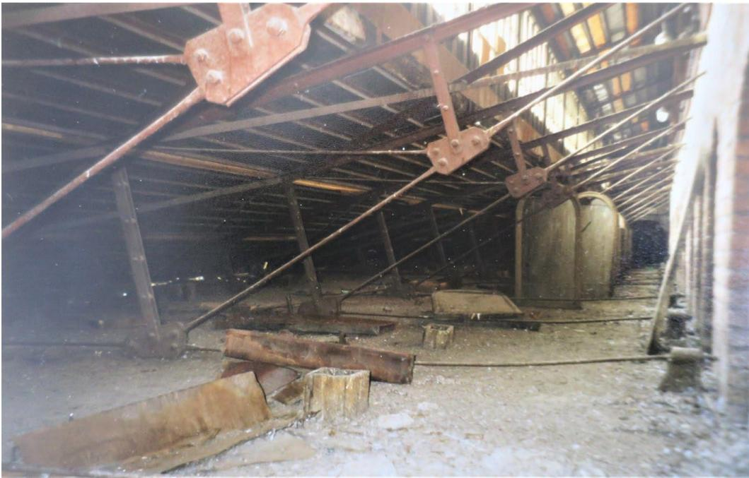
37. Вид на металлическую стропильную систему Большой хоральной синагоги. Фотография В.Д. Голуба (до реставрации). 1998 г. Институт «Спецпроектреставрация». Сектор хранения документированной информации Управления организационного обеспечения и контроля КГИОП (П.657, Пр.-13).
