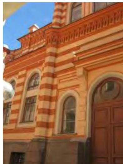
дверное заполнение – конструкция (двухстворчатое, с фигурной фрамугой с витражной расстекловкой), материал (дерево), техника исполнения (токарная работа), оформление (филенчатое с фигуреями);
