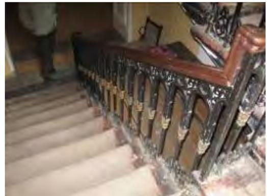
северная лестница – местоположение, габариты, конфигурация; тип (многомаршевая), конструкция (на косоурах), материал ступеней (известняк); ограждение - материал (чугун), техника исполнения (литье), рисунок; поручень – материал (дерево), форма (профилированный);
