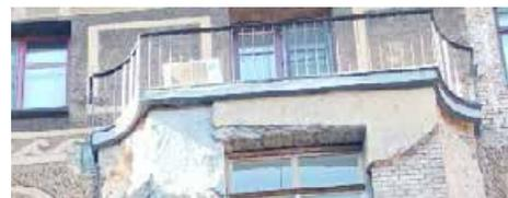
лоджии – местоположение (в уровне 3-5 этажей), габариты, конфигурация, оформление (с каннелированными полуколоннами по сторонам), ограждение – вид материала (металл), техника исполнения (ковка), рисунок (вертикальные стойки с геометрическим орнаментом);
