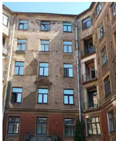
лоджии – местоположение (в уровне 6-го этажа), с кирпичными пилонами с лепными капителями, ограждение – вид материала (металл), техника исполнения (ковка), рисунок (вертикальные стойки);
