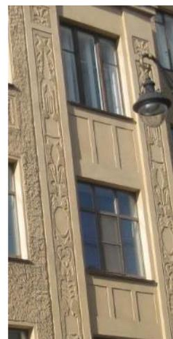
оформление оконного проема в уровне 4 этажа и балконного проема в уровне 5 этажа по 10 оси (фланкирующие филенки с рельефом из пальметт, листьев аканта);
