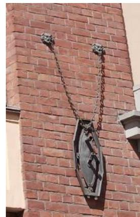
фонарь – местоположение (центральная часть воротного проезда), конструкция (подвесной, в форме сложного многогранника), способ крепления (на центральной цепи и растяжках), вид материала (черный металл), техника исполнения (ковка);
