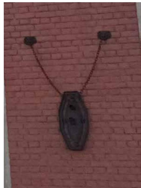
фонарь – местоположение (центральная часть воротного проезда), конструкция (подвесной, в форме сложного многогранника), способ крепления (на центральной цепи и растяжках), вид материала (черный металл), техника исполнения (ковка);
