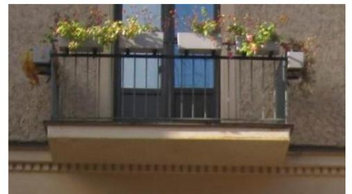
ограждение – вид материала (металл), техника исполнения (ковка), рисунок (вертикальные стойки, в том числе с геометрическим орнаментом);
