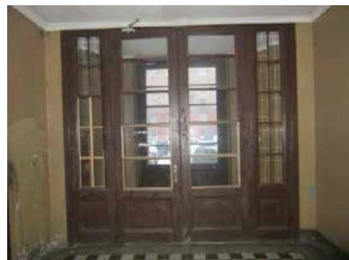
витражи – местоположение (оконные проемы парадных лестниц); конфигурация (прямоугольной формы), вид материала (фактурное стекло), рисунок (расстекловка, геометрический орнамент);
