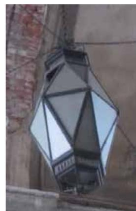
четыре фонаря – местоположение (боковые части воротного проезда), конструкция (подвесной, восьмигранный в плане, сегменты дна смыкаются на шишке пинии), способ крепления (на цепи), вид материала (черный металл), техника исполнения (ковка);
