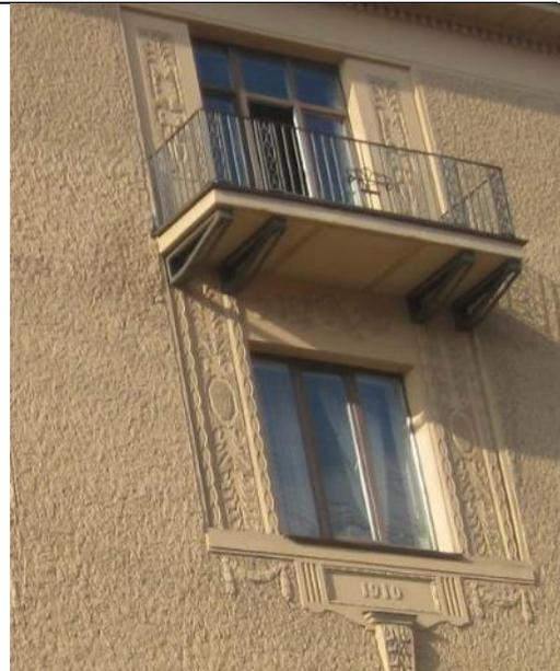
под оконным проемом расположена филенка в профилированной раме с цифрами «1910» под профилированным карнизом, фланкируемая провисающими гирляндами, под оконным проемом;
