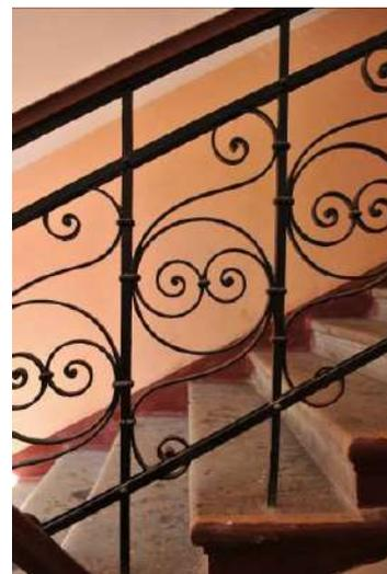
историческая лестница в южном ризалите лит. Б - местоположение, габариты, конструкция (средистенная), тип (веерообразная, с забежными ступенями и промежуточными площадками);
