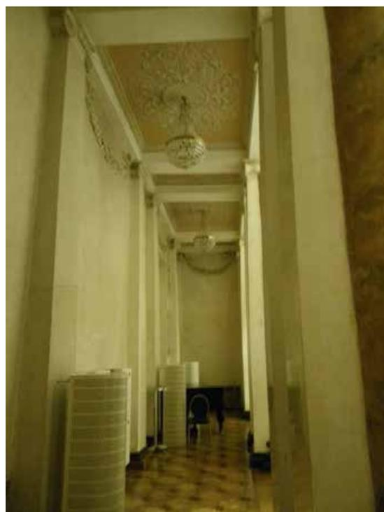
оформление восточной стены – в центральной части сверху – провисающая цветочная гирлянда; в боковых частях – прямоугольные ниши, фланкированные полуциркульными архивольтами с лепными завитками из акантовых волют на импостах в виде каннелированных пилястр;
