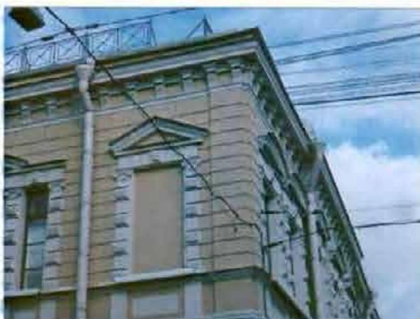
венчающий профилированный раскрепованный карниз на каннелированных консолях;
