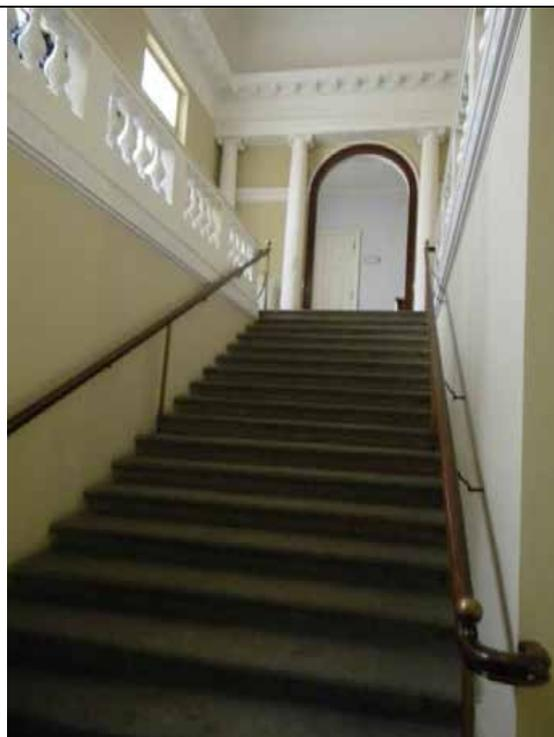
с парапетным деревянным ограждением из тумб, квадратных в плане, и точеных балясин между ними – в уровне площадки 3-го этажа;
