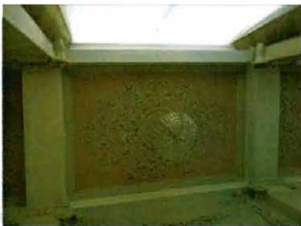
облицовка стен искусственным мрамором – нижние 1/3 – серого с прожилками, с профилированной тягой в верхней части, верхние 2/3 – белого, с профилированным карнизом;
