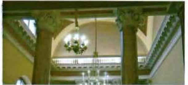
фриз аналогичного материала, профилированный карниз с большим выносом на акантовых кронштейнах, с порезками иоником, пальметтами;
