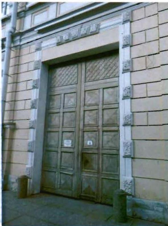
заполнение проема – материал (дерево), конструкция (ворота двустворчатые), оформление (профилированные филенки с алмазной гранью, в верхней части – филенки с трельяжной сеткой);
