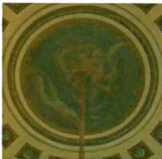
паруса свода с треугольными кессонами, обрамленными профилированными филёнками с порезками аналогичной формы; внутри с монохромными живописными изображениями в виде лавровых венков с пальмовыми ветвями, перевязанными бантами;
