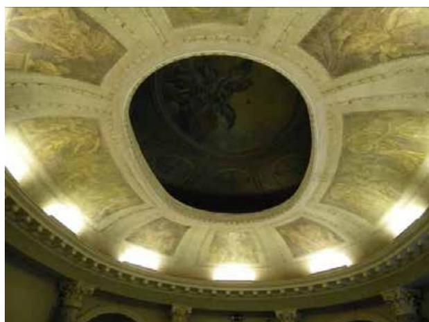
система сводов – сомкнутый с распалубками, зеркальный – зеркального зала (пом. № 203, площадью 202,18 кв.м.);
