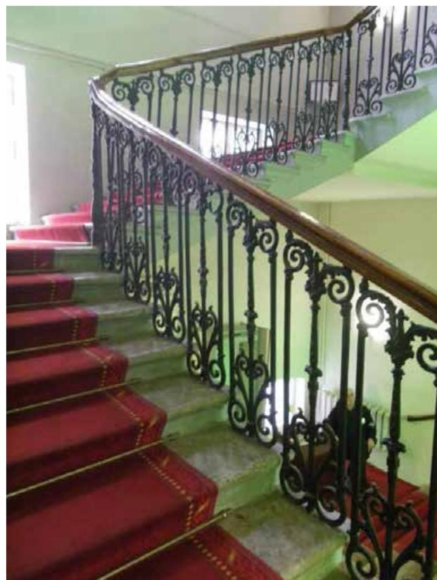
в поворотных частях ограждения – витые орнаментированные столбики; с профилированным деревянным поручнем;
