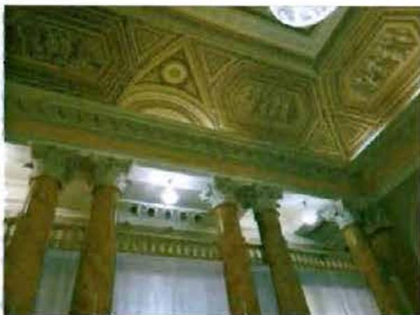
опоры балконов в виде выпущенных продольных и поперечных балок, образующих кессоны, опирающихся на пилястры ионического ордера торцевых стен и спаренных с колоннами;
