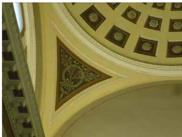
боковые части плафона – по периметру с профилированным карнизом с порезками иоником, растительными элементами; плоскость разделена на квадратные кессоны, обрамленные иоником, с лепными розетками в центре; по центральной оси крупный восьмиугольный кессон с порезкой иоником и лепной пальмовой гирляндой; по внешним углам четыре маленьких кессона с лепниной;
