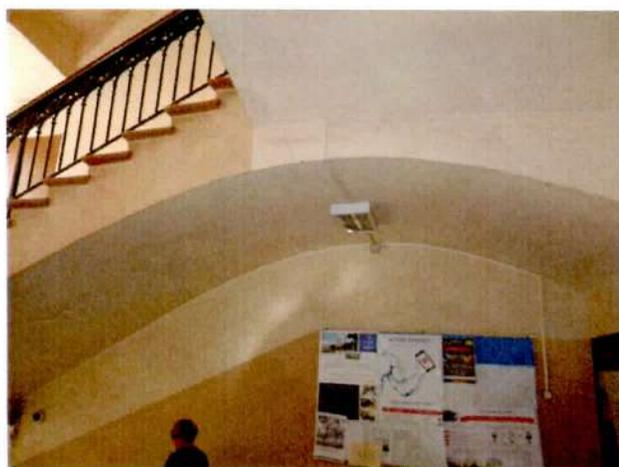
2-ЛК – трехмаршевую, с известняковыми ступенями, с площадками – наливными с мраморной крошкой, в технике терраццо, геометрического рисунка, с металлическим ограждением в виде вертикальных парных стоек, декорированных волютами и фигурных опорных столбиков, с профилированным деревянным поручнем, с площадками по сводам;
