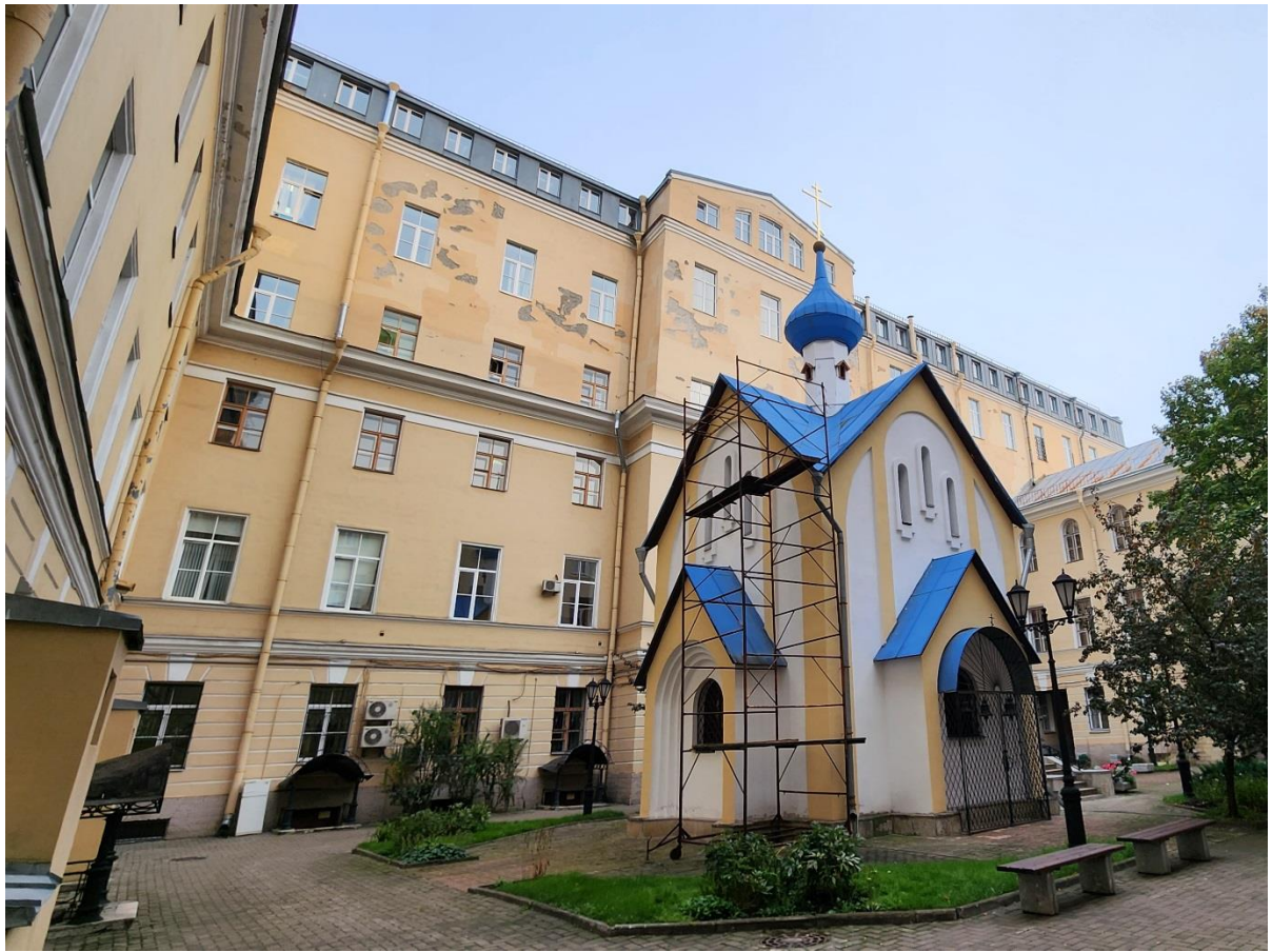
Фото 5. Дворовой фасад. Вид колонный зал. Институт инженеров путей сообщения.
