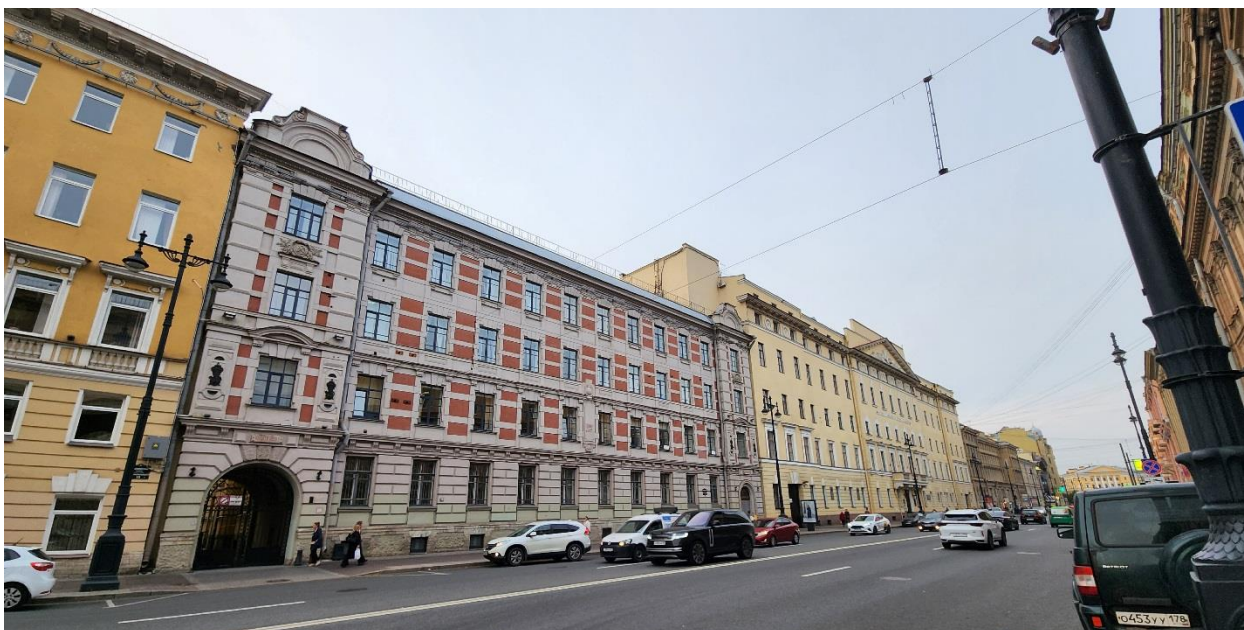
Фото 1. Лицевой фасад в перспективе Московского пр. Институт инженеров путей сообщения.
