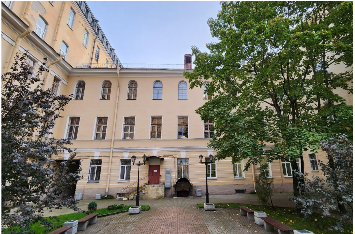
Фото 3. Дворовой фасад. Вид колонный зал. Институт инженеров путей сообщения.
