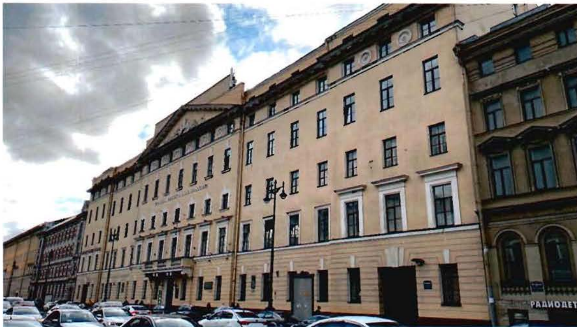
1. Общий вид лицевого фасада объекта культурного наследия.
