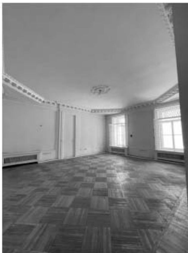
53. Здание по адресу: Санкт-Петербург, Моховая улица, д. 10, строение 1. Помещение с лепными элементами отделки на втором этаже. Фрагмент. Пом. 30-Н
