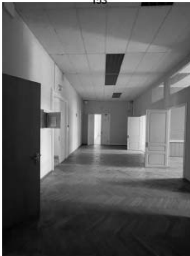
46. Здание по адресу: Санкт-Петербург, Моховая улица, д. 10, строение 1. Пом. МОП 1
