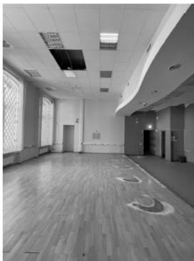
34. Здание по адресу: Санкт-Петербург, Моховая улица, д. 10, строение 1. Пом. МОП 1
