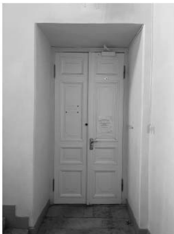
61. Здание по адресу: Санкт-Петербург, Моховая улица, д. 10, строение 1 Дверь с межлестничного пространства главной лестницы между 2 и 3 этажами. Пом. МОП 1.
