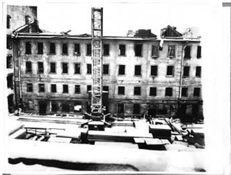
64. Фасад дворового флигеля, фрагмент, восточная часть. Фотофиксация в процессе реставрации. 1990–1991. ЦГАНТД СПб. Ф. Р-488. Оп. 314. Д. 161. Л. 5/8
