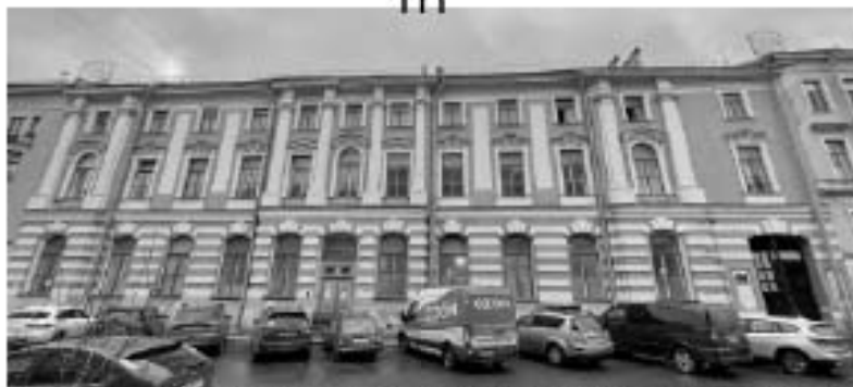
1. Здание по адресу: Санкт-Петербург, Моховая улица, д. 10, строение 1. Общий вид лицевого фасада
