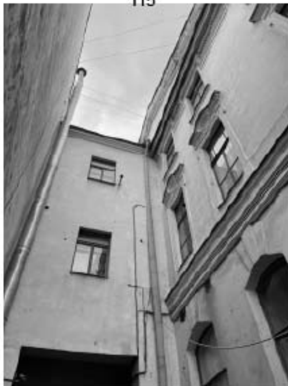
9. Здание по адресу: Санкт-Петербург, Моховая улица, д. 10, строение 1. Фрагмент южного фасада и пристройки с аркой проезда
