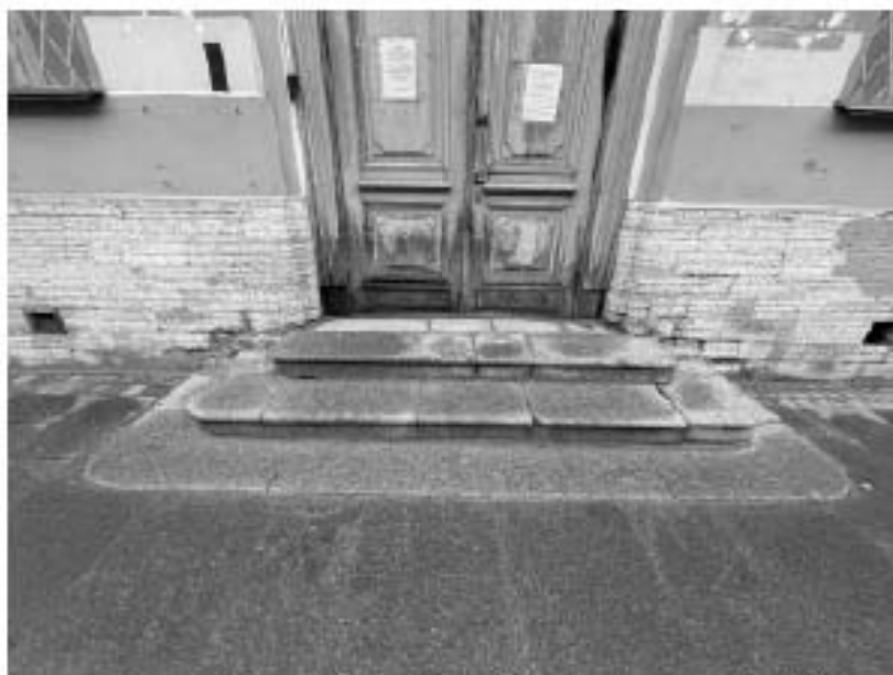
7. Здание по адресу: Санкт-Петербург, Моховая улица, д. 10, строение 1. Крыльцо со ступенями из красного гранита и фрагмент дверного заполнения главного входа в здание с Моховой улицы.
