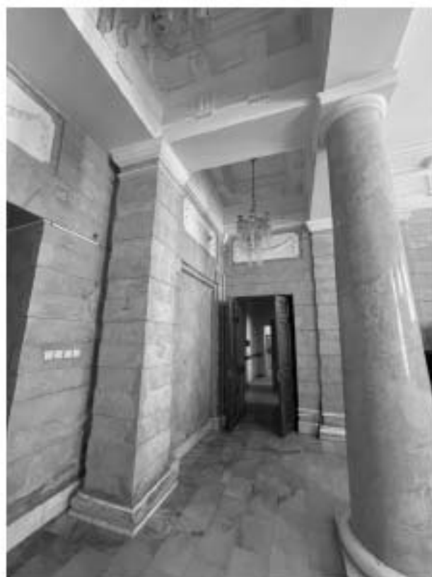
18. Здание по адресу: Санкт-Петербург, Моховая улица, д. 10, строение 1. Вид вестибюля. Пом. МОП 1
