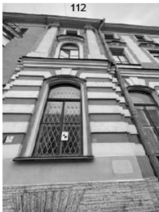
3. Здание по адресу: Санкт-Петербург, Моховая улица, д. 10, строение 1. Фрагмент лицевого фасада 1 световая ось (слева направо)
