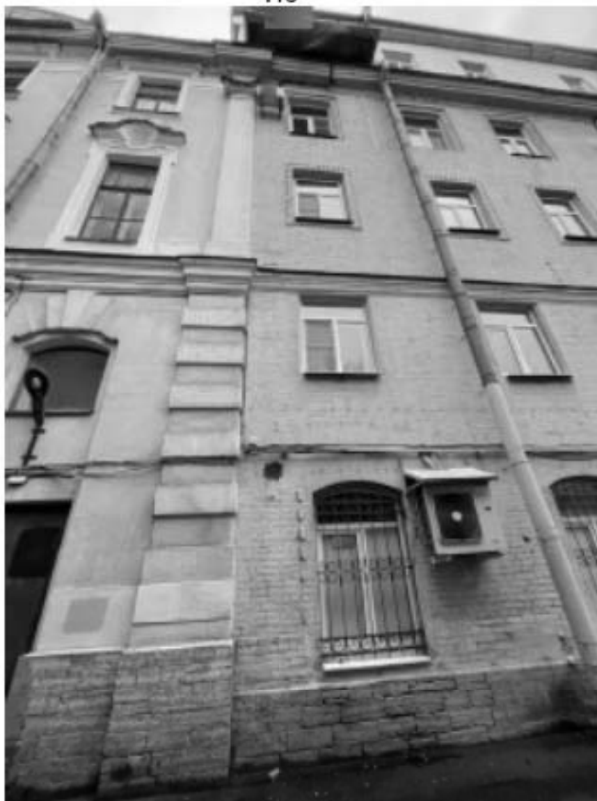
11. Здание по адресу: Санкт-Петербург, Моховая улица, д. 10, строение 1. Фрагмент южного фасада
