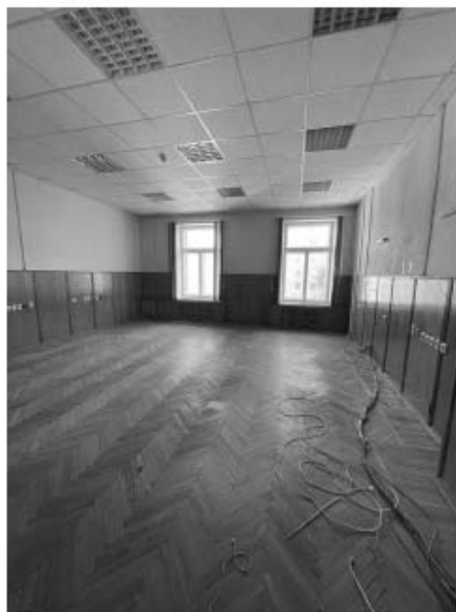
65. Здание по адресу: Санкт-Петербург, Моховая улица, д. 10, строение 1. Пом. 47-Н
