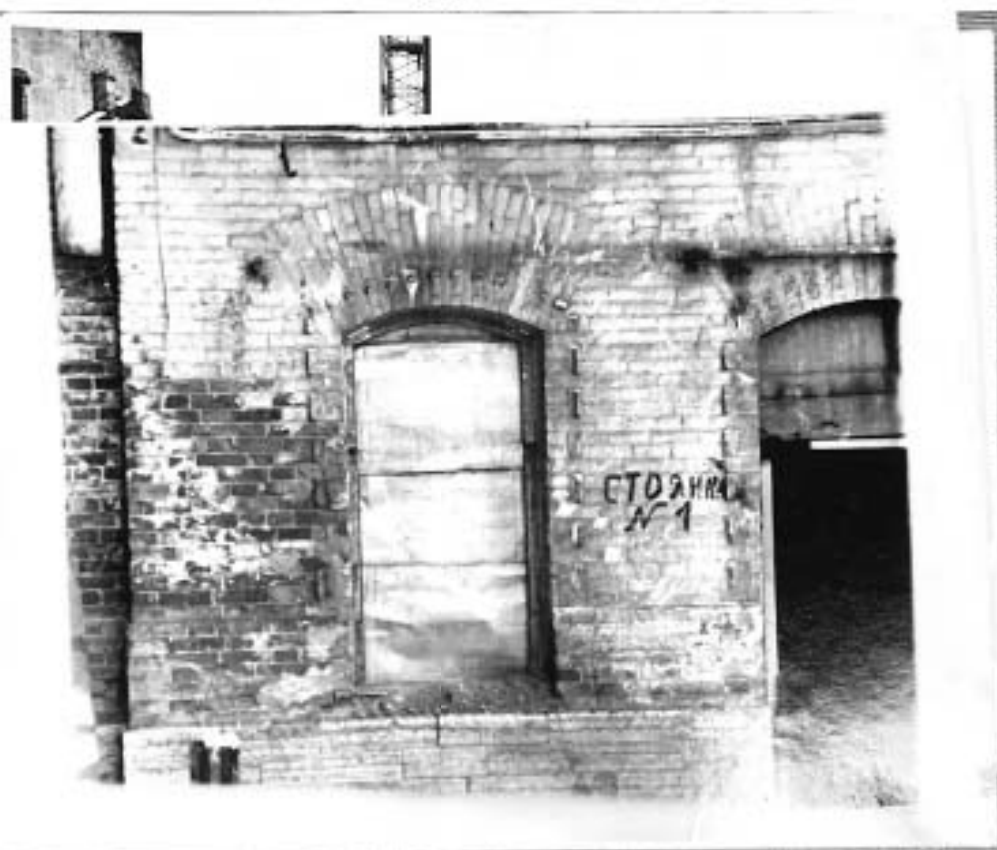
63. Фасад дворового флигеля, фрагмент окна 1 этажа. Фотофиксация в процессе реставрации. 1990–1991. ЦГАНТД СПб. Ф. Р-488. Оп. 314. Д. 161. Л. 4/8
