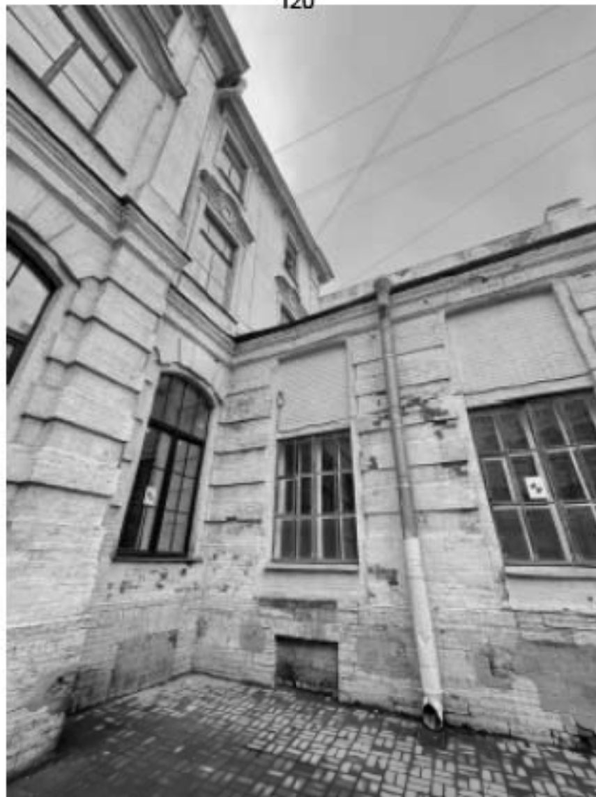
16. Здание по адресу: Санкт-Петербург, Моховая улица, д. 10, строение 1. Фрагмент дворового фасада
