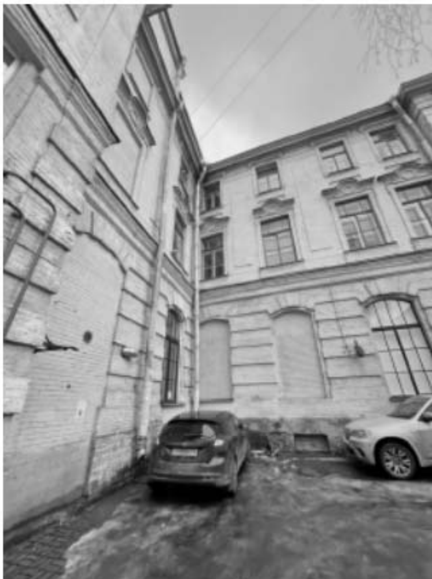
12. Здание по адресу: Санкт-Петербург, Моховая улица, д. 10, строение 1. Фрагмент южного фасада
