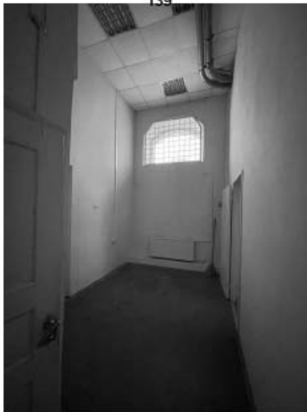
23. Здание по адресу: Санкт-Петербург, Моховая улица, д. 10, строение 1. Пом. МОП 1
