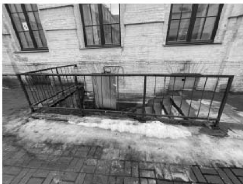
15. Здание по адресу: Санкт-Петербург, Моховая улица, д. 10, строение 1. Вход в подвал со стороны дворового фасада
