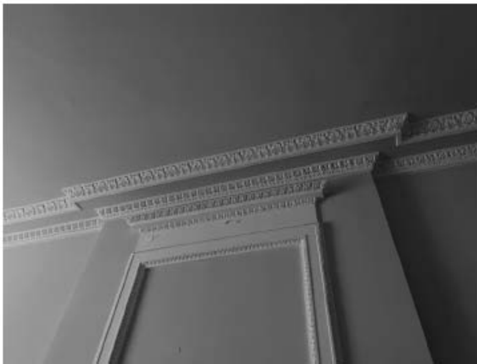
58. Здание по адресу: Санкт-Петербург, Моховая улица, д. 10, строение 1. Помещение с лепными элементами отделки на втором этаже. Фрагмент. Пом. 29-Н
