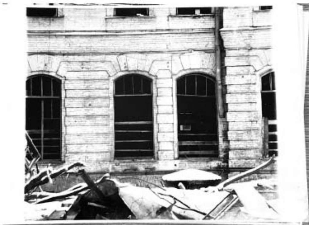
61. Лицевой корпус, дворовой фасад, фрагмент окна 2 этажа. Фотофиксация в процессе реставрации. 1990–1991. ЦГАНТД СПб. Ф. Р-488. Оп. 314. Д. 161. Л. 1/8
