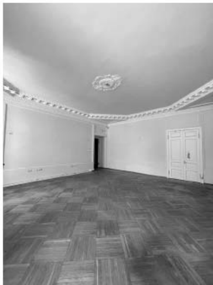
55. Здание по адресу: Санкт-Петербург, Моховая улица, д. 10, строение 1. Помещение с лепными элементами отделки на втором этаже. Фрагмент. Пом. 30-Н
