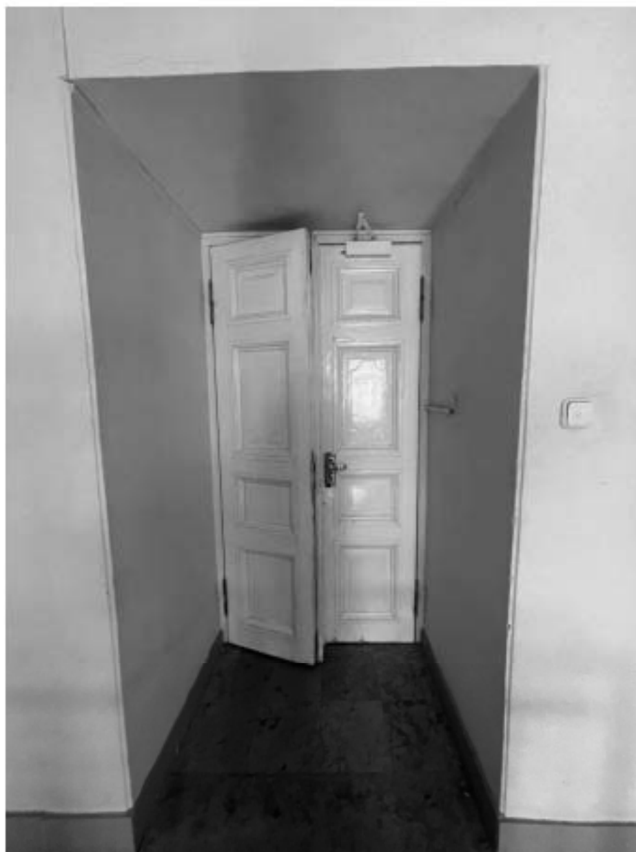
63. Здание по адресу: Санкт-Петербург, Моховая улица, д. 10, строение 1. Вид двери с лестничной площадки в уровне 3 этажа. Пом. 1-Н
