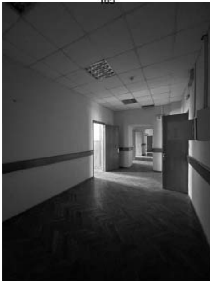
64. Здание по адресу: Санкт-Петербург, Моховая улица, д. 10, строение 1. Коридор 3 этажа. Пом. МОП 1
