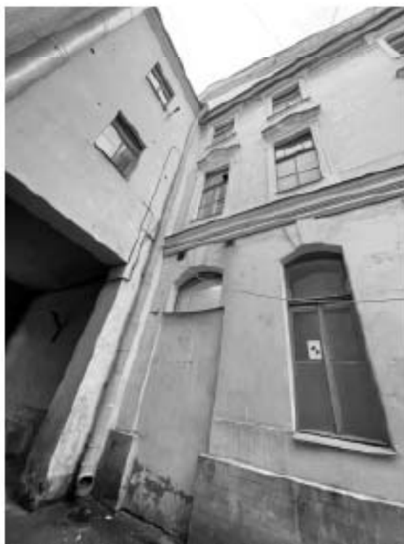
10. Здание по адресу: Санкт-Петербург, Моховая улица, д. 10, строение 1. Фрагмент южного фасада и пристройки с аркой проезда
