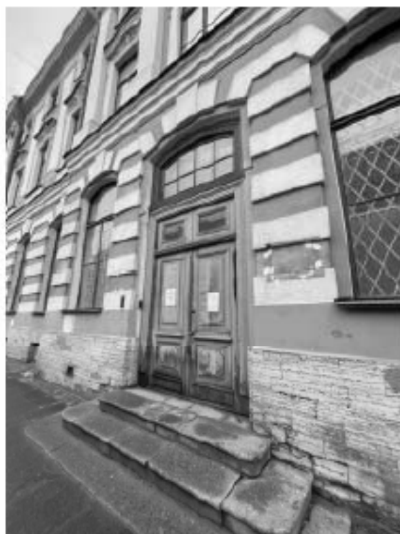
2. Здание по адресу: Санкт-Петербург, Моховая улица, д. 10, строение 1. Фрагмент лицевого фасада. Общий вид входной двери в здание
