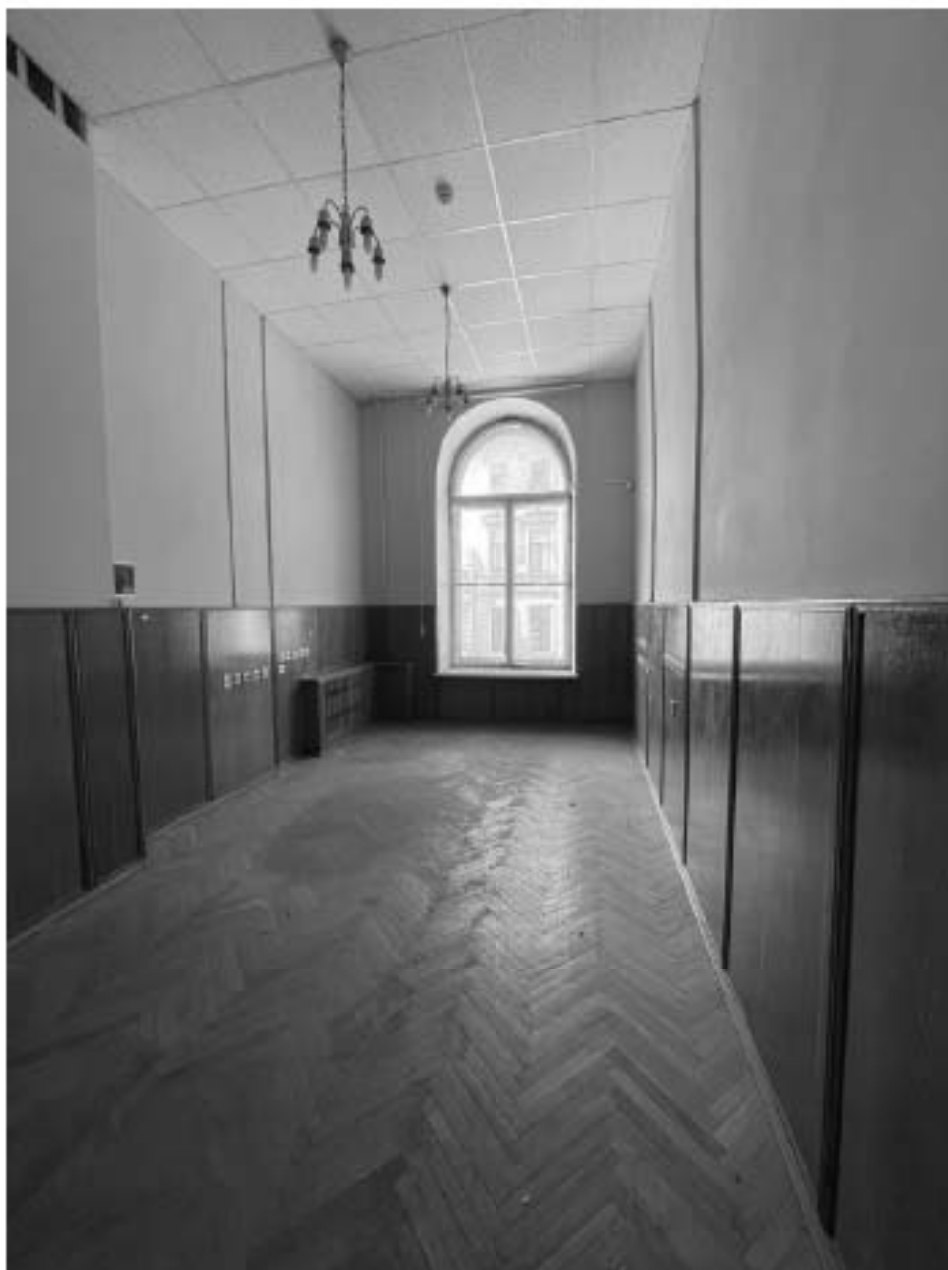
45. Здание по адресу: Санкт-Петербург, Моховая улица, д. 10, строение 1. Пом. 22-Н
