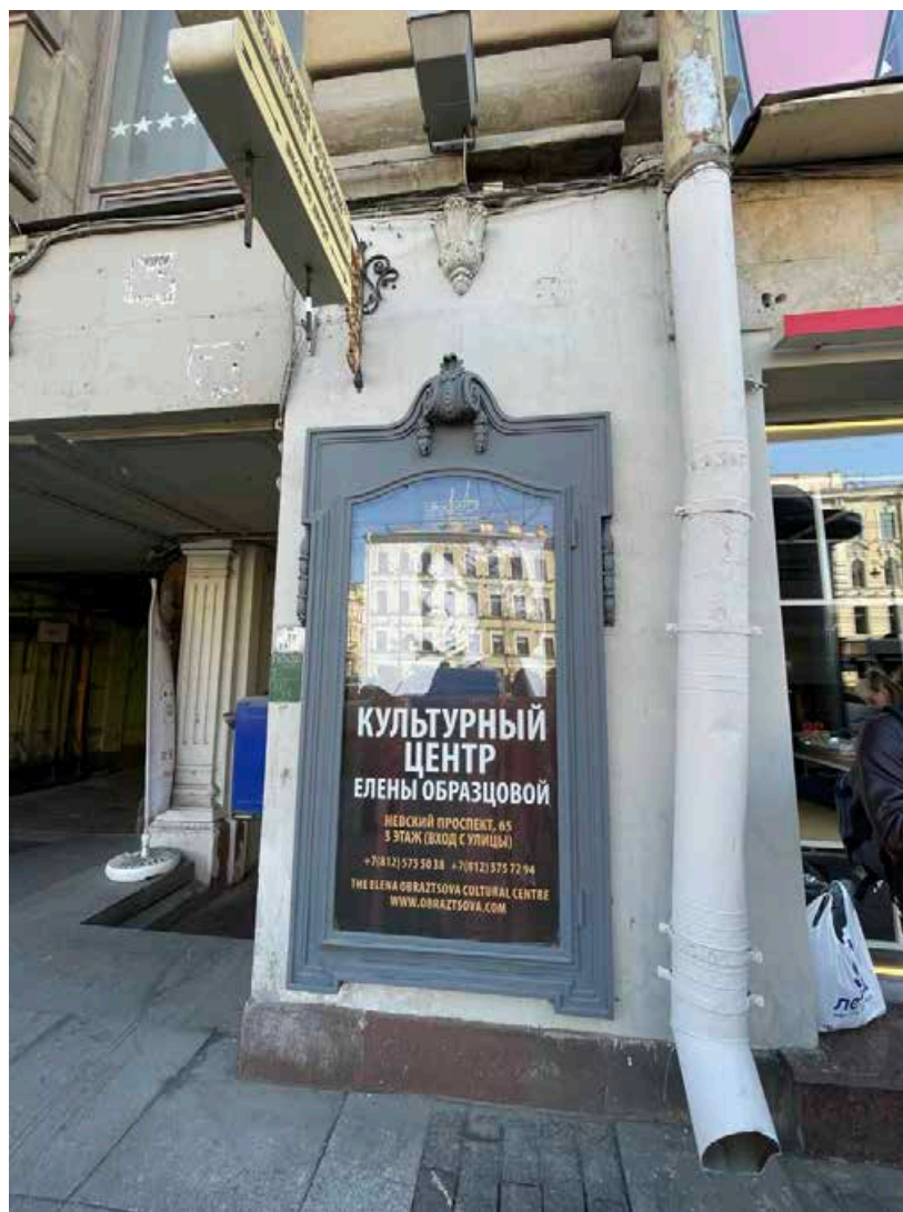
10. Стенная панель с остеклением для театральных афиш с картушем в виде волюты с акантом и гирляндами из цветочных бутонов. Немного выше – флагодержатель металлический, окрашенный в цвет фасада, в виде половины бутона цветка.
