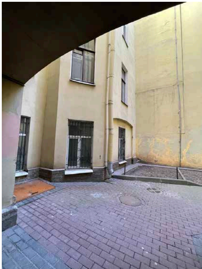
29. Фрагмент южного двора.
