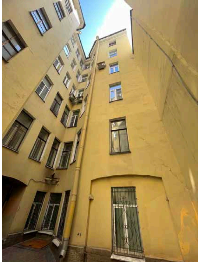
32. Общий вид восточного фасада южного двора.
