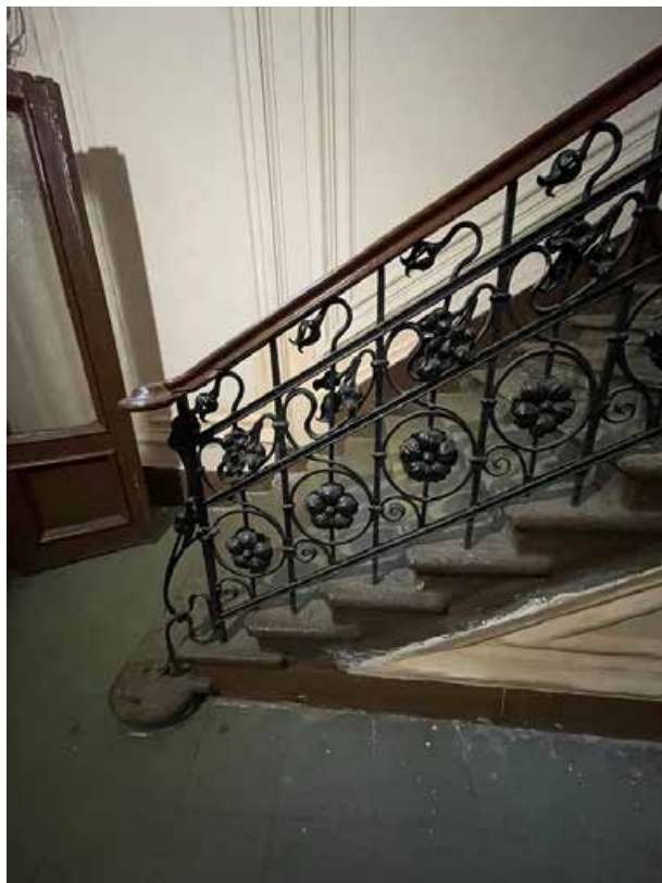
160. Фрагмент кованного металлического ограждения лестничных маршей с растительными и цветочными элементами. Поручень деревянный профилированный, закругляется горизонтально на конце.
