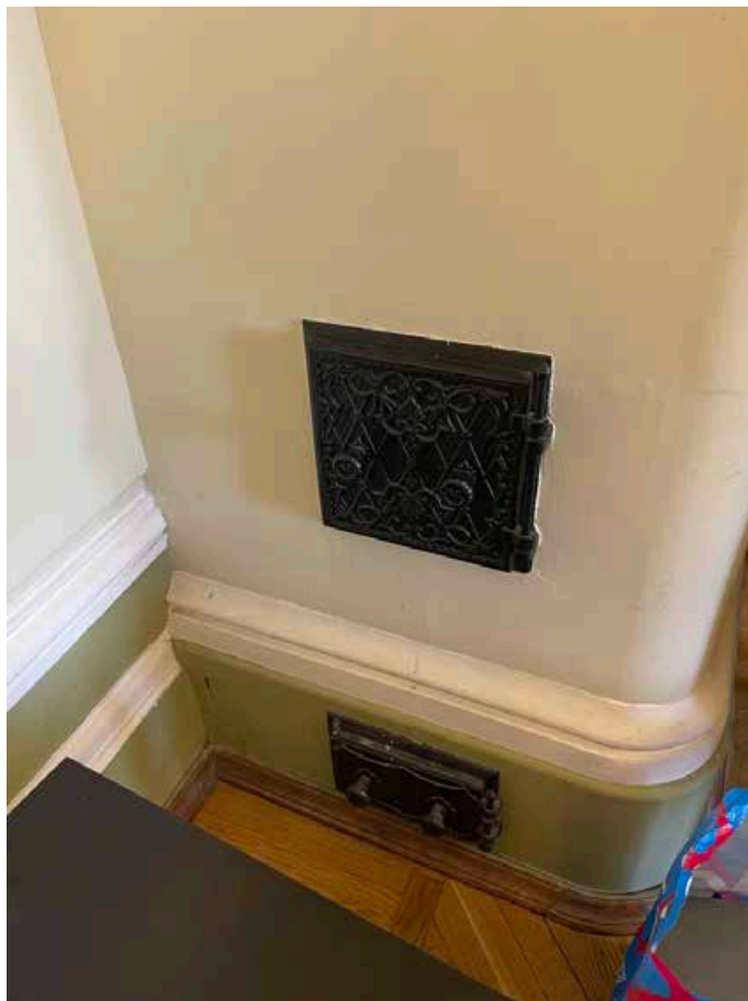
130. Дверцы металлические в печи в помещении 26(Н)-2.
