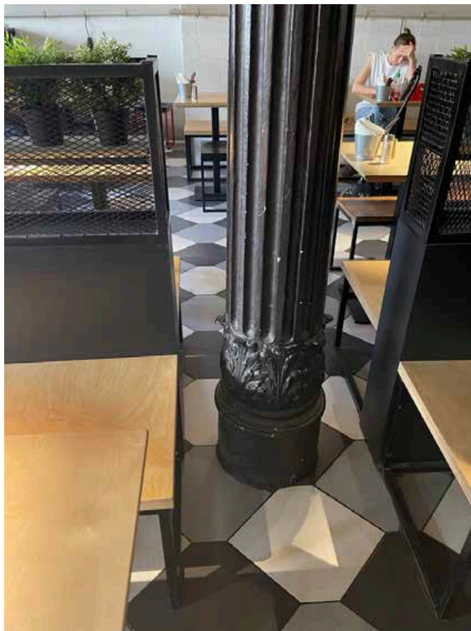
191. База колонны в помещении 2-Н(1).
