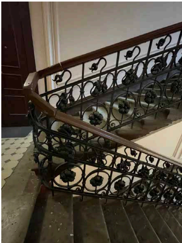
178. Фрагмент лестничного кованного металлического ограждения.
