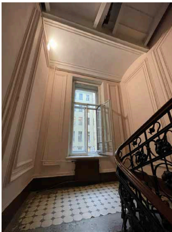
173. Общий вид площадки лестничной клетки между первым и вторым этажами. Оконный проем оформлен профилированным наличником. Стены оформлены профилированными панелями.
