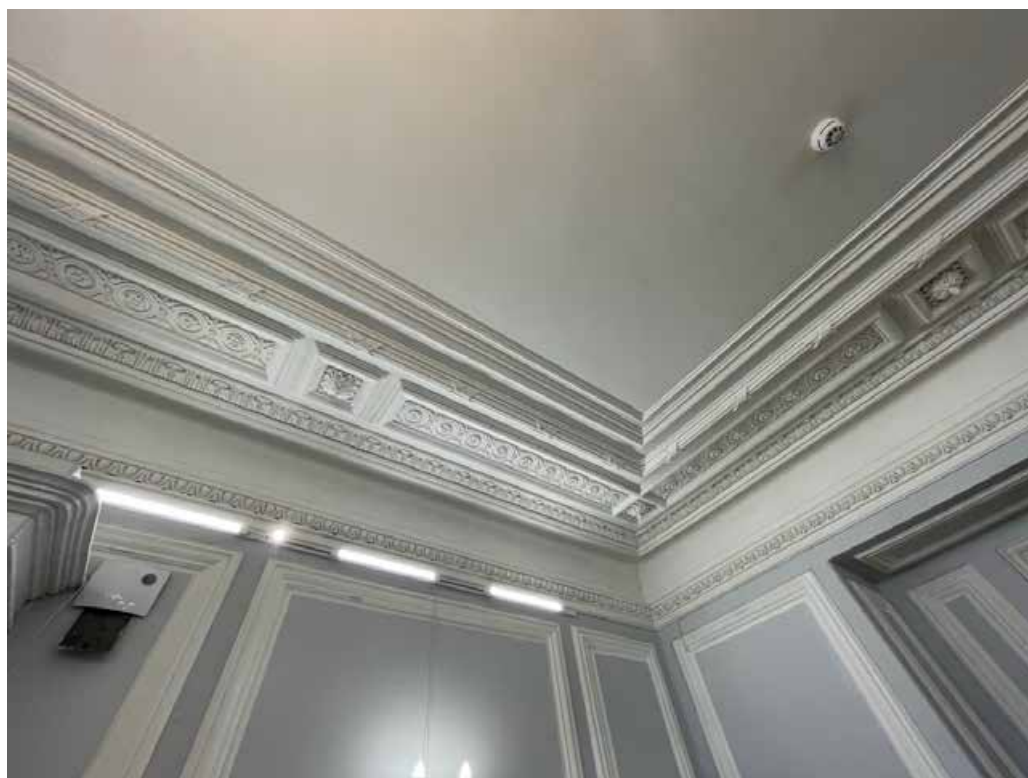
95. Фрагмент оформления плафона потолка помещения 23-Н(2) многоуровневым карнизом: овы, падуга, листья аканта, цветочными розетки, ленты и простые профилированные карнизы.
