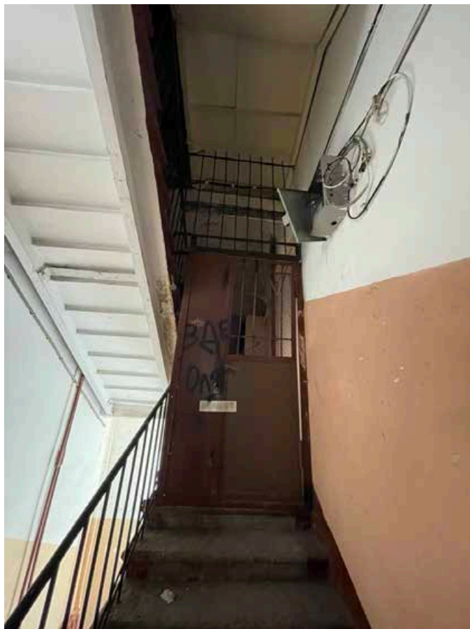
215. Общий вид лестничного пролета с мансардного этажа на крышу. Лестничная клетка западного фасада.
