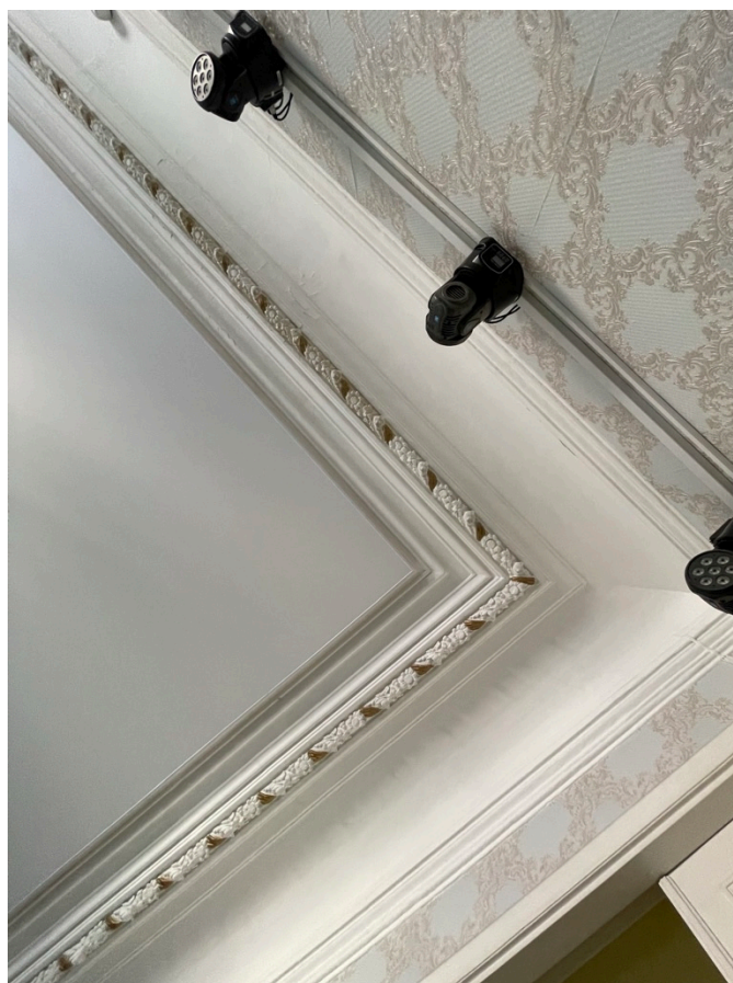
143. Фрагмент оформления плафона потолка помещения 26(Н)-4.
