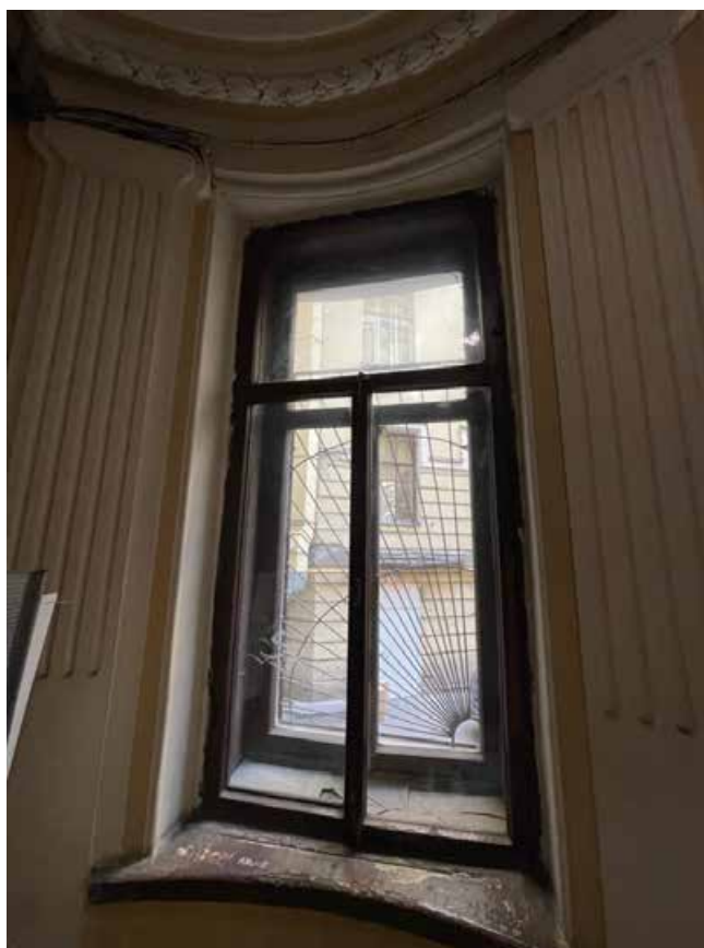
19. Оконный проем круглого ризалита лестничной клетки между первым и вторым этажами в восточную сторону.
