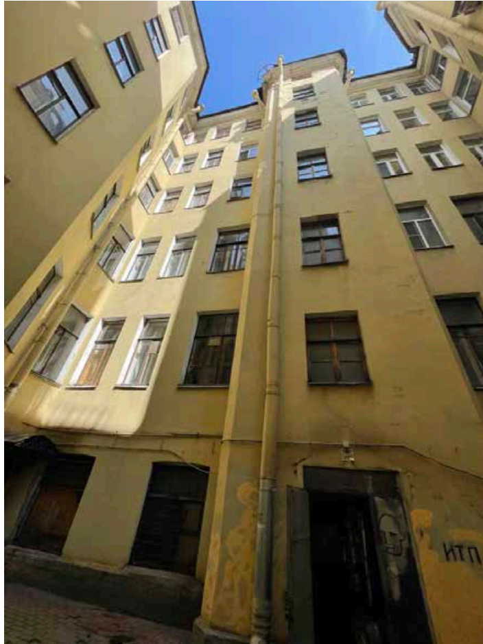
31. Общий вид северного фасада южного двора.
