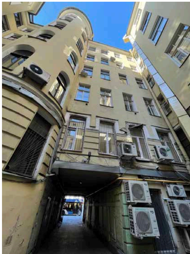
17. Общий вид северного фасада северного двора.
