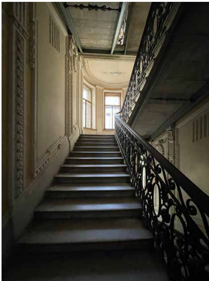
79. Общий вид лестничного марша с четвертого этажа на пятый.
