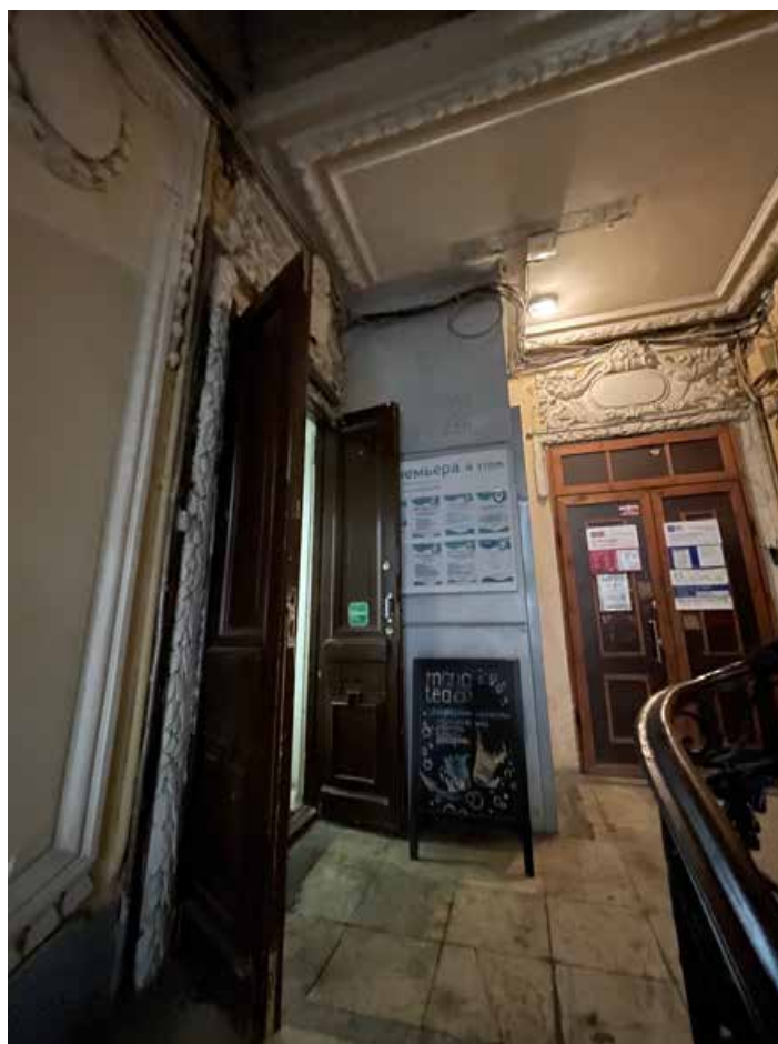
27. Общий вид площадки второго этажа лестничной клетки.
