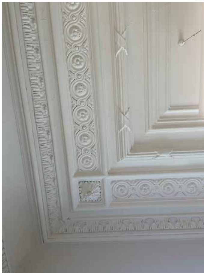
77. Многоуровневый карниз плафона потолка помещения 12-Н(7) выполнен рядами листьев аканта, цветочными розетками, лентами и простыми профилированными карнизами.
