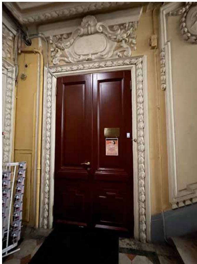
51. Дверной проем в помещении 4-Н(1).
