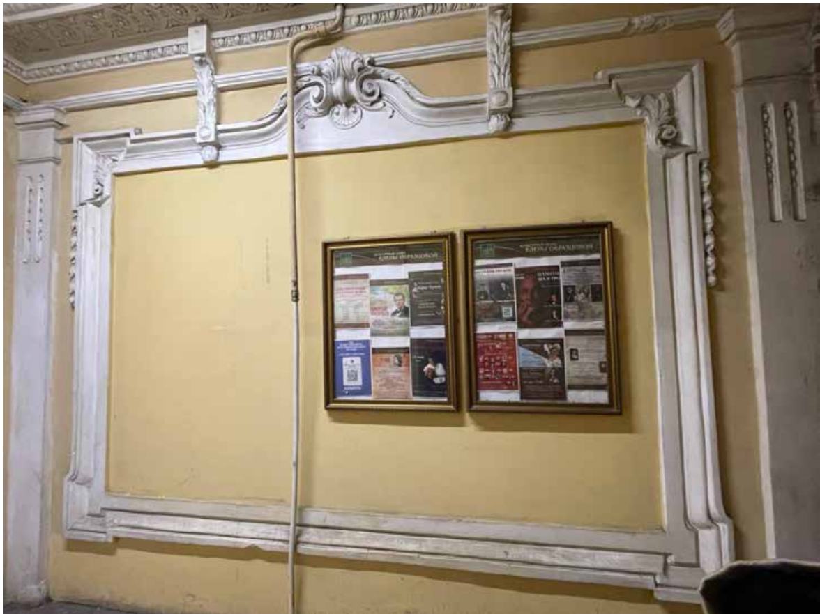
5. Оформление западной стены вестибюля профилированной панелью с картушем в виде волути с акантом и ракушкой.
