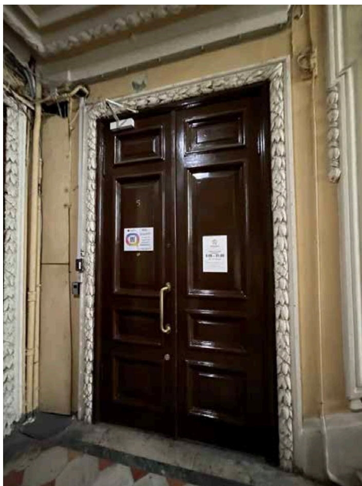
66. Дверной проем в помещении 22-Н(1).
