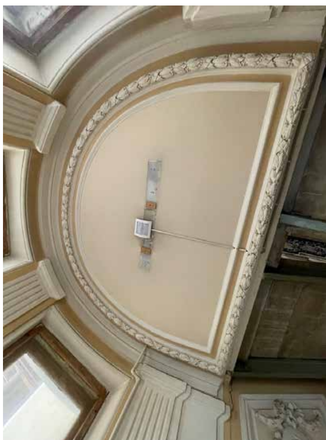
84. Оформление плафона потолка лестничной площадки между четвертым и пятым этажами аналогичное оформлению плафонов потолка лестничных площадок этажами ниже.
