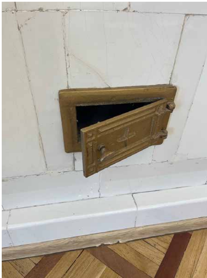
98. Металлическая дверца печи в помещении 23-Н(2).
