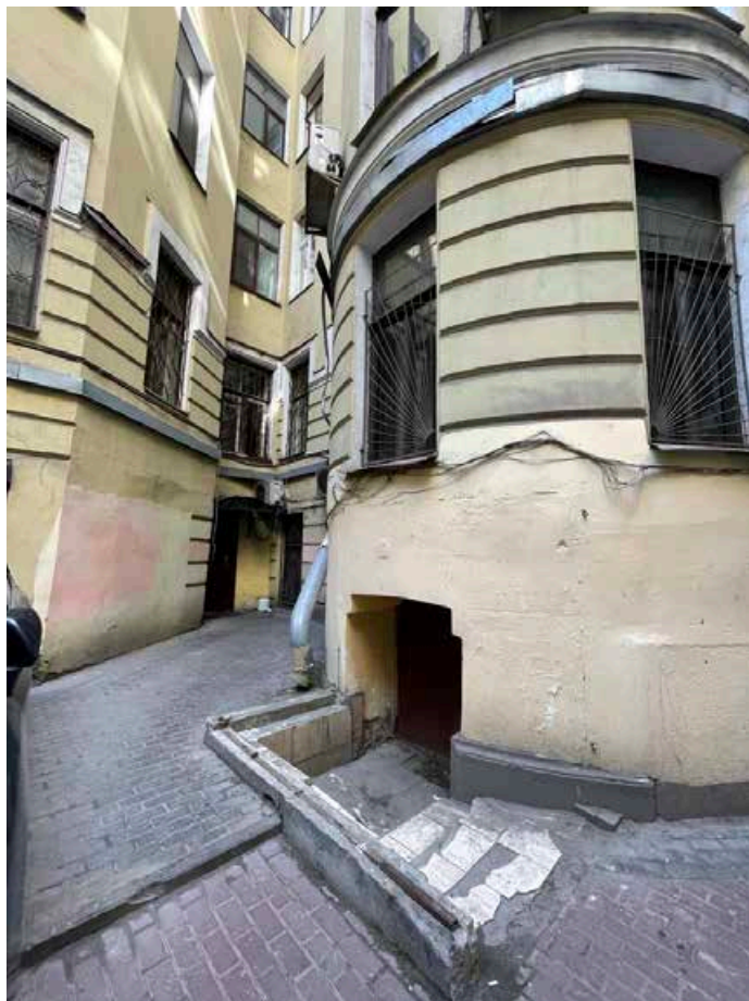
19. Фрагмент круглого ризалита северного фасада северного двора – дверной проем в подвальные помещения лестничной клетки с приямком.
