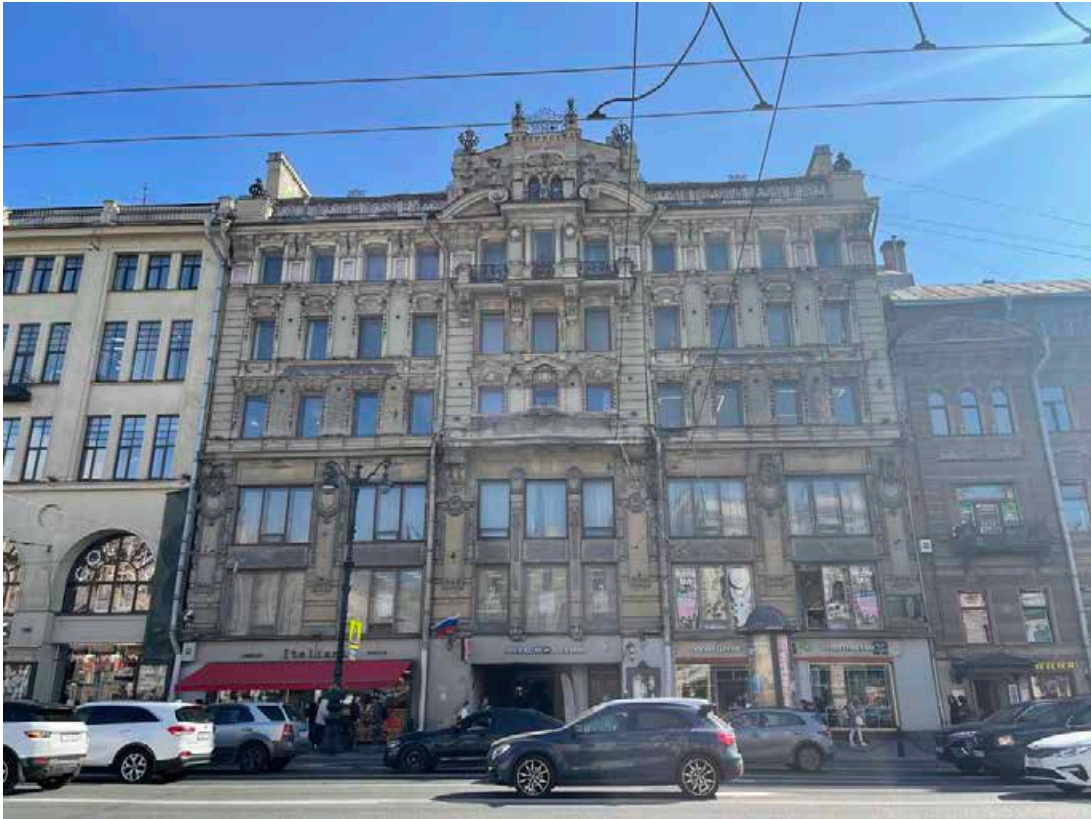
1. Общий вид лицевого фасада с Невского проспекта.
