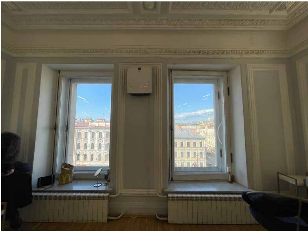
100. Общий вид оформления стен между оконными проемами в помещении 23-Н(2).
