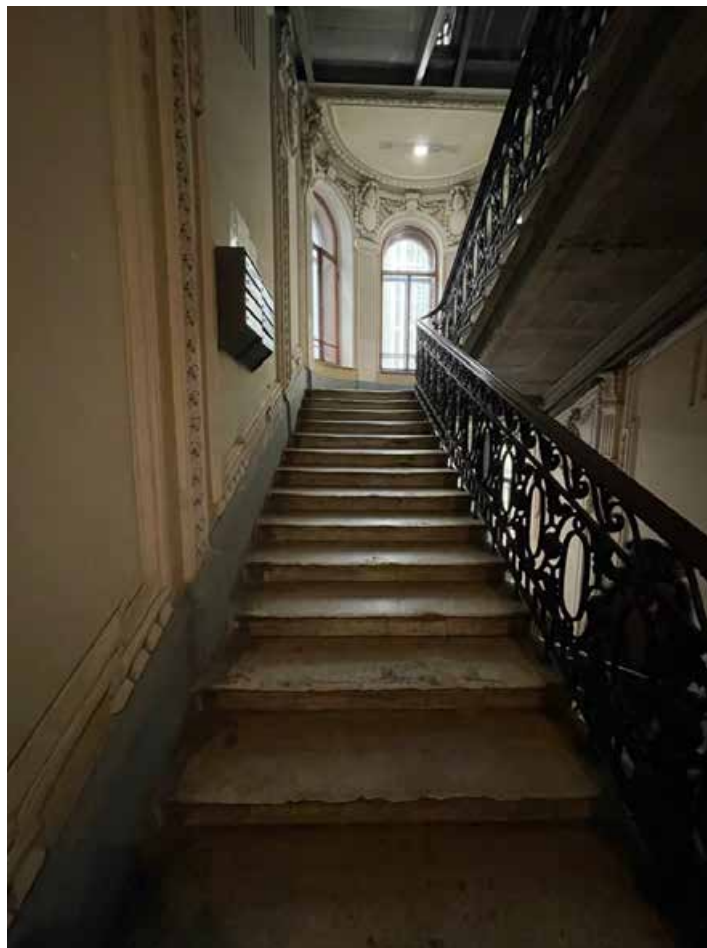
39. Лестничный марш со второго на третий этаж. Общий вид.
