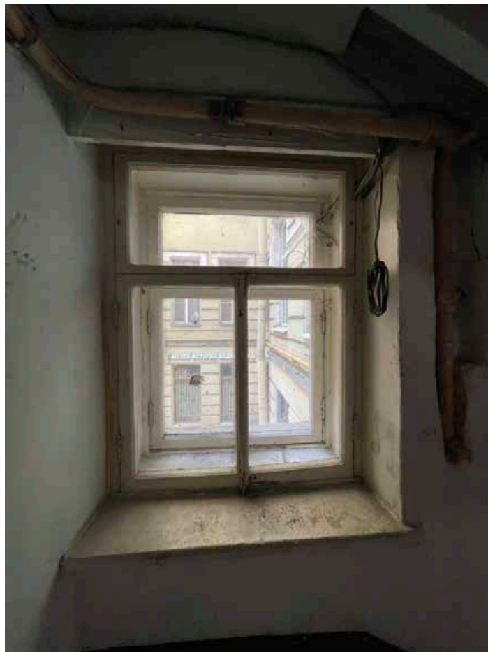
197. Оконный проем на лестничной площадке второго этажа (вид на юг). Лестничная клетка западного фасада.
