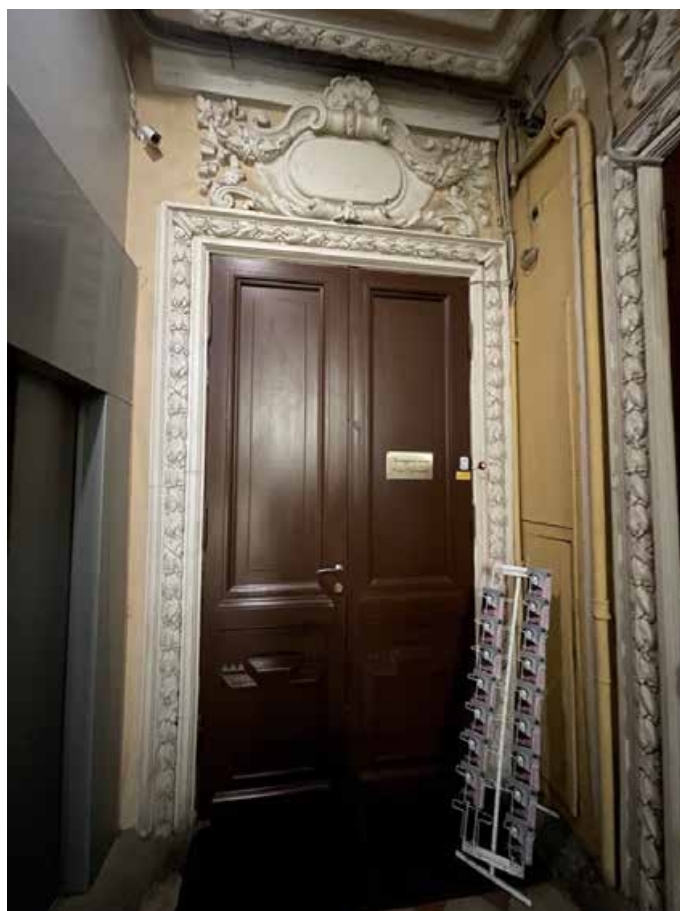
50. Дверной проем в помещение 4-Н(7).
