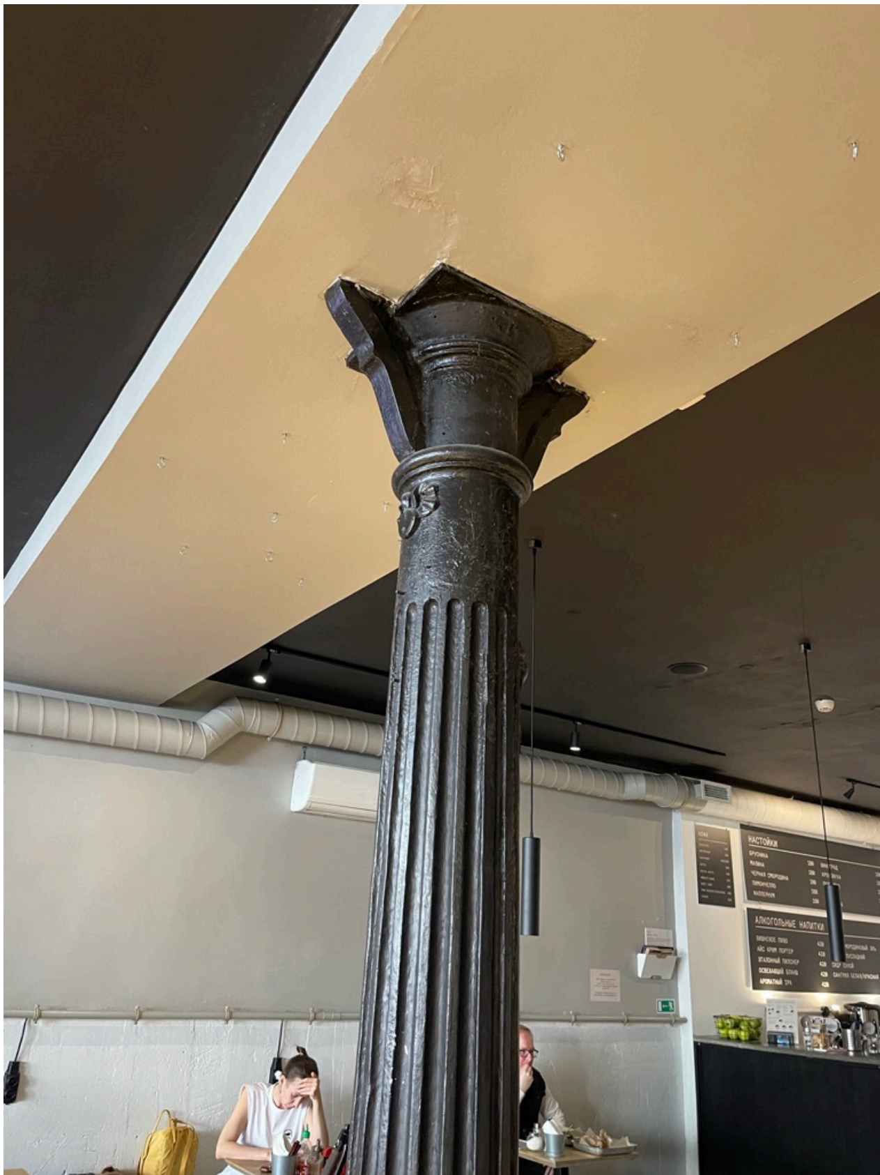
190. Капитель колонны в помещении 2-Н(1).
