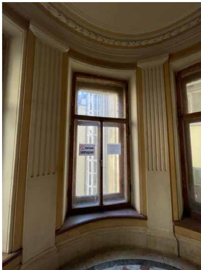
82. Оконный проем круглого ризалита лестничной площадки между четвертым и пятым этажами. Вид в южную сторону. Оформление пилястр маскаронами в простенках между окнами отсутствует.
