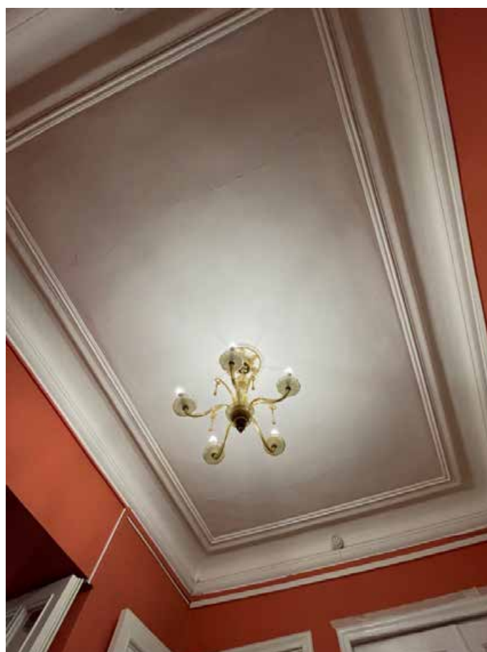
127. Оформление плафона потолка помещения 26(Н)-1 падугой и профилированным карнизом. Розетка в центре потолка поздняя.
