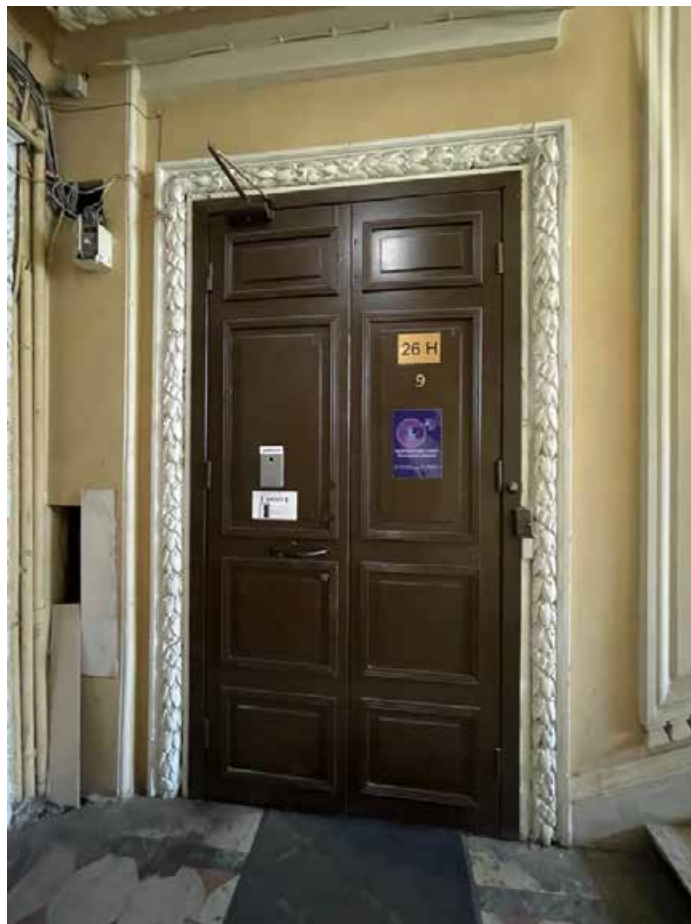
126. Дверной проем в помещении 26(Н)-2.
