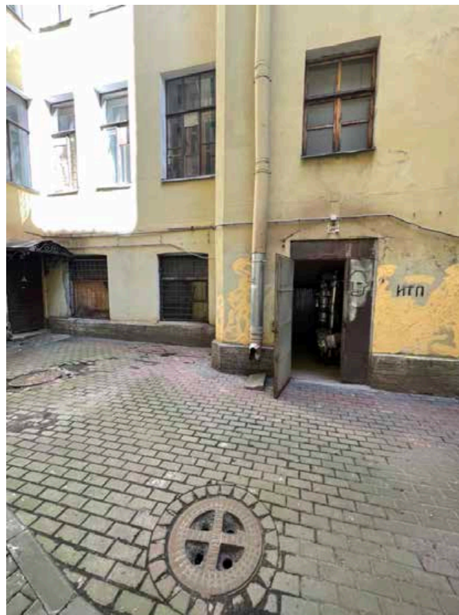
34. Фрагмент северного фасада южного двора. Цоколь отделан известняком. Дверной проем в ризалите ведет в ИТП под лестницей.
