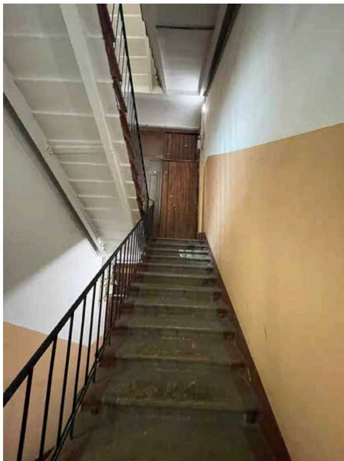
203. Лестничный марш со второго на третий этаж лестничной клетки западного фасада.
