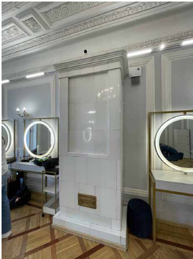
94. Печь изразцовая прямоугольная в плане в помещении 23-Н(2). Оформлена белыми глазурованными изразцами без рельефов. Завершается профилированным карнизом.
