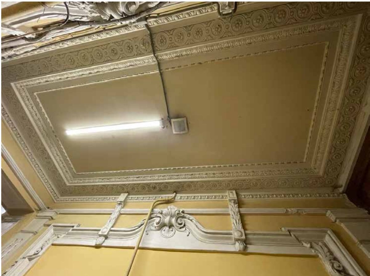
6. Общий вид оформления потолка плафона вестибюля. Многоуровневый карниз с бусинами, листьями аканта, рядом цветочных розеток и овами.
