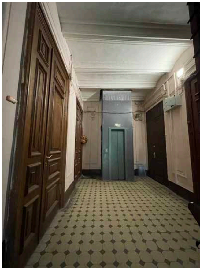
184. Общий вид лестничной площадки мансардного этажа.
