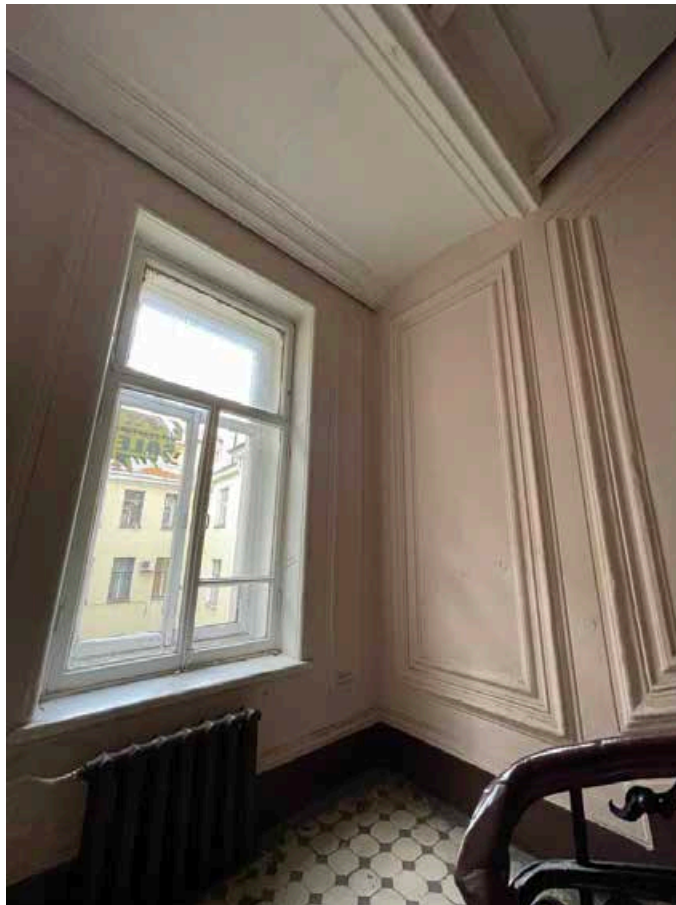
183. Общий вид оконного проема лестничной площадки между шестым и мансардным этажами.
