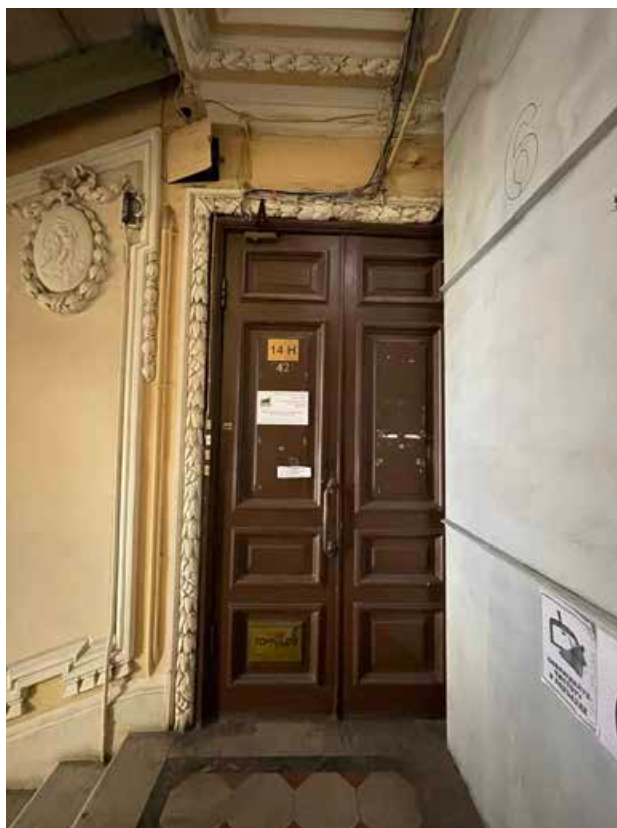
123. Дверной проем в помещении 14-Н(1).
