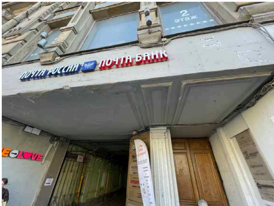
9. Общий вид профилированных панелей потолка над проездной аркой и главным входом с Невского проспекта.
