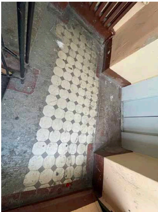
209. Покрытие лестничной площадки между пятым и шестым этажами аналогичной метлахской плиткой. Лестничная клетка западного фасада.
