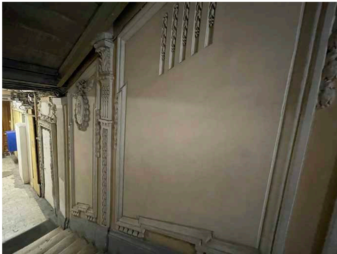
17. Стеновые панели лестничного марша с первого на второй этаж.
