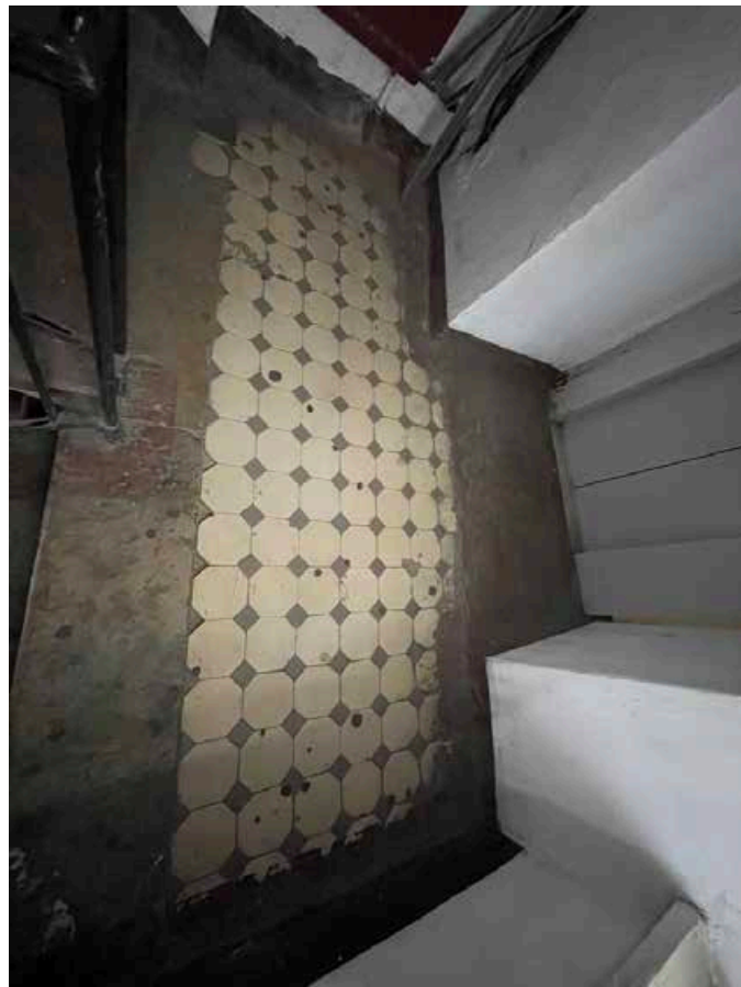
196. Покрытие пола аналогичной метлахской плиткой на площадке второго этажа.
