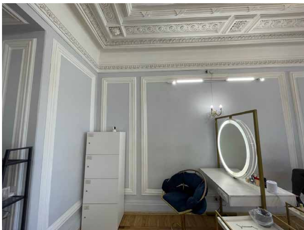
93. Фрагмент оформления стен помещения 23-Н(2) профилированными стенными панелями.
