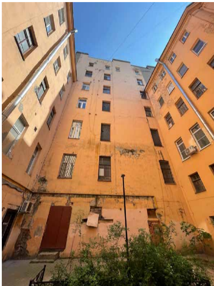
36. Общий вид западного фасада.
