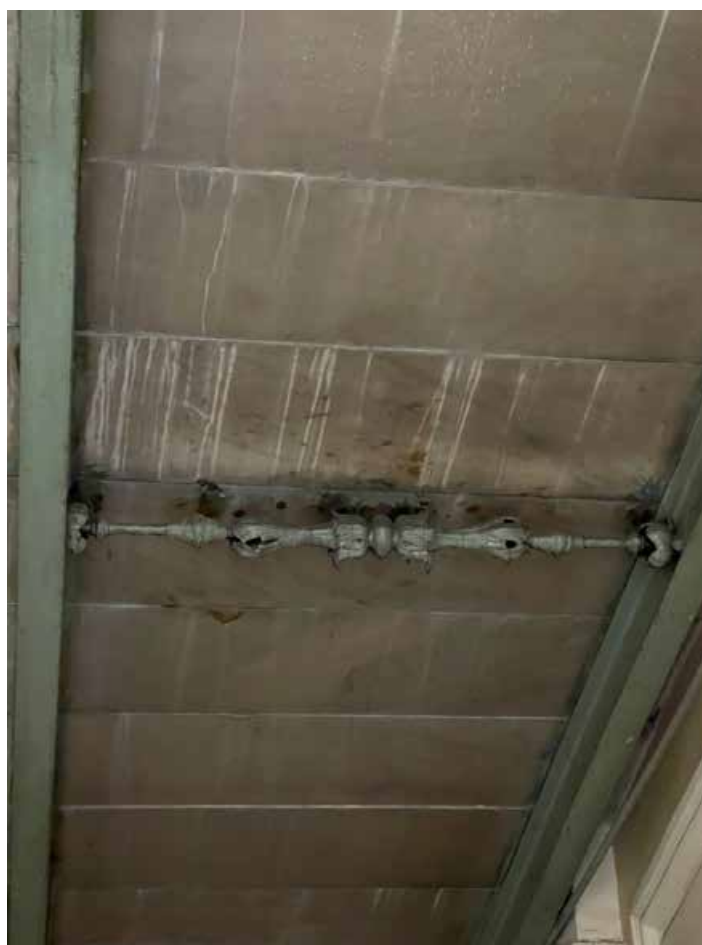
48. Металлическая декоративная стяжка между двутаврами лестничного марша с цветочными и растительными элементами.
