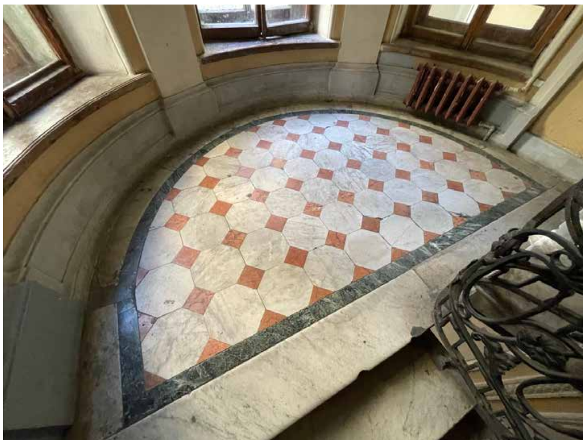
56. Покрытие пола лестничной площадки между третьим и четвертым этажами аналогичное покрытиям площадок этажами ниже. Утраты минимальные.
