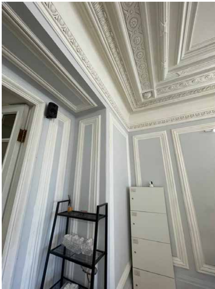
92. Фрагмент оформления стен помещения 23-Н(2) профилированными стенными панелями.
