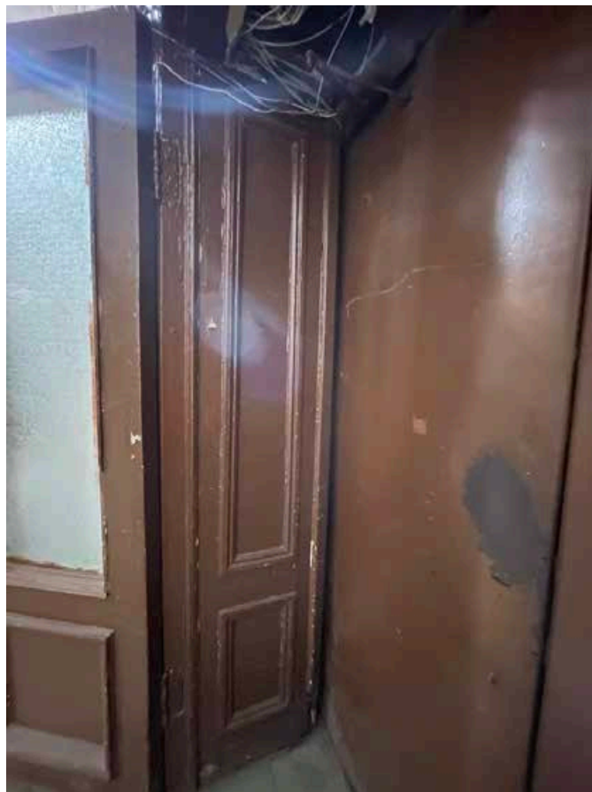
186. Профилированные панели деревянного тамбура входа в лестничную клетку.
