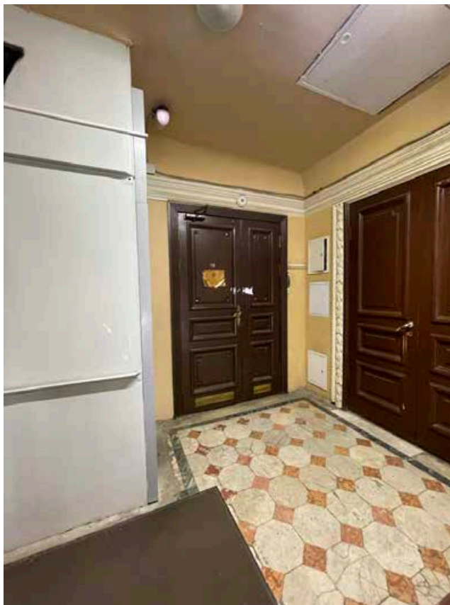
156. Общий вид лестничной площадки мансардного этажа.
