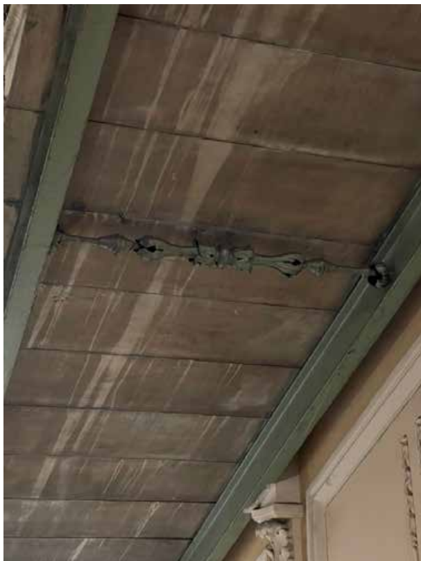
53. Металлическая декоративная стяжка между двутаврами лестничного марша с цветочными и растительными элементами.
