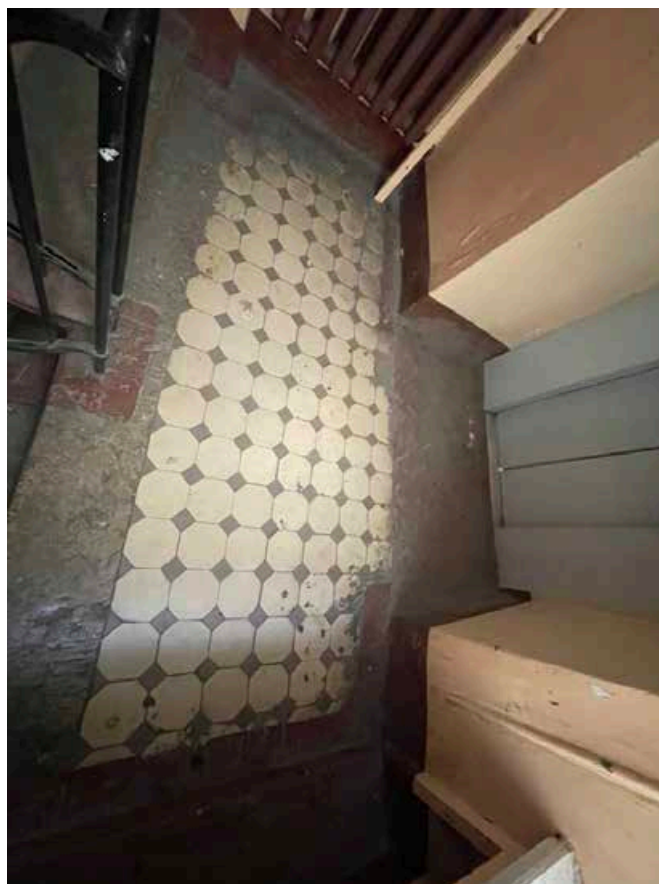
200. Покрытие пола аналогичной метлахской плиткой на лестничной площадке между вторым и третьим этажами лестничной клетки западного фасада.
