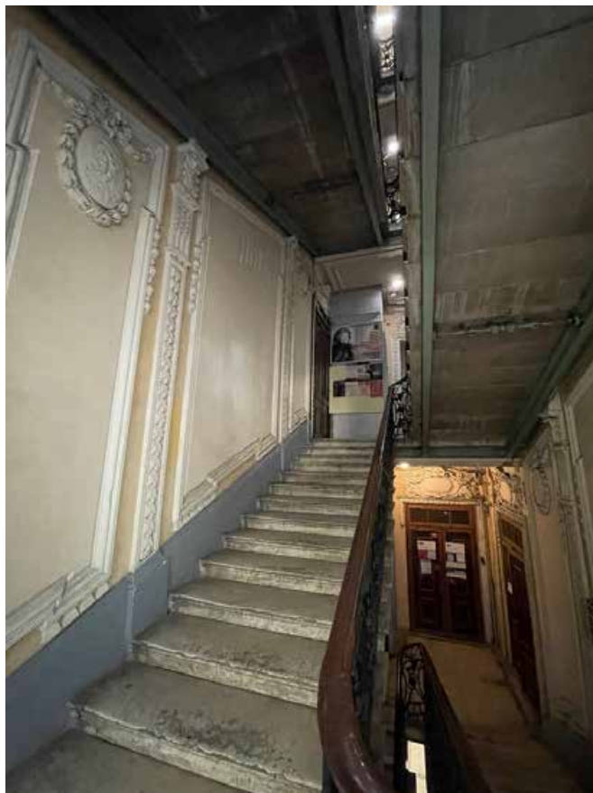
47. Общий вид лестничного марша со второго этажа на третий.
