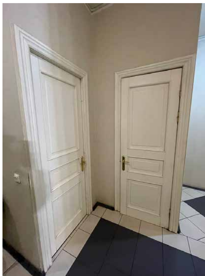
115. Дверные проемы в помещении 25(Н)-3.
