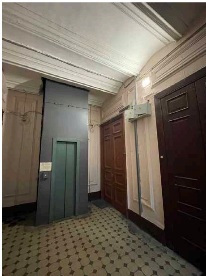
179. Общий вид лестничной площадки пятого этажа.
