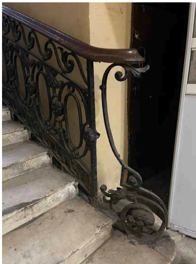
14. Ограждение лестничного марша – металлическое кованное с растительными элементами. Поручень деревянный профилированный, завершается горизонтальным завитком.
