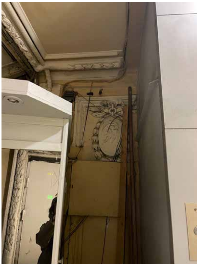
11. На стене рядом с лифтовой шахтой сохранился медальон с низким рельефом и цветочной гирляндой, аналогичный медальонам на стенах лестничных маршей.
