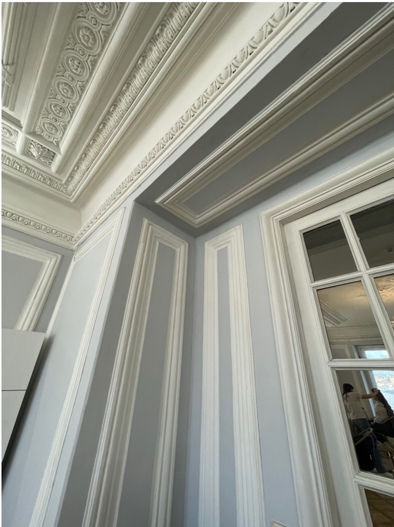
91. Оформление проема помещения 23-Н(2) профилированными панелями. Фрагмент многоуровневого карниза потолка.
