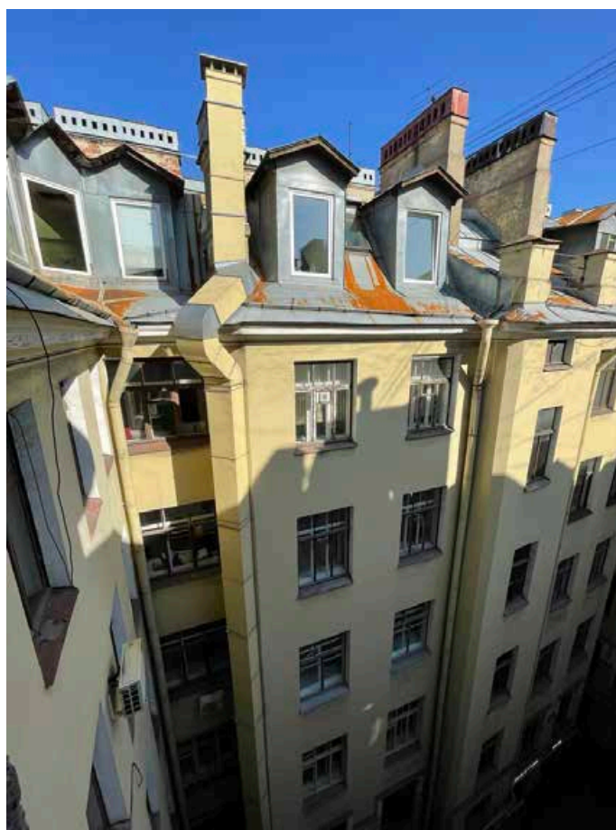
147. Вид во двор из окна лестничной клетки.
