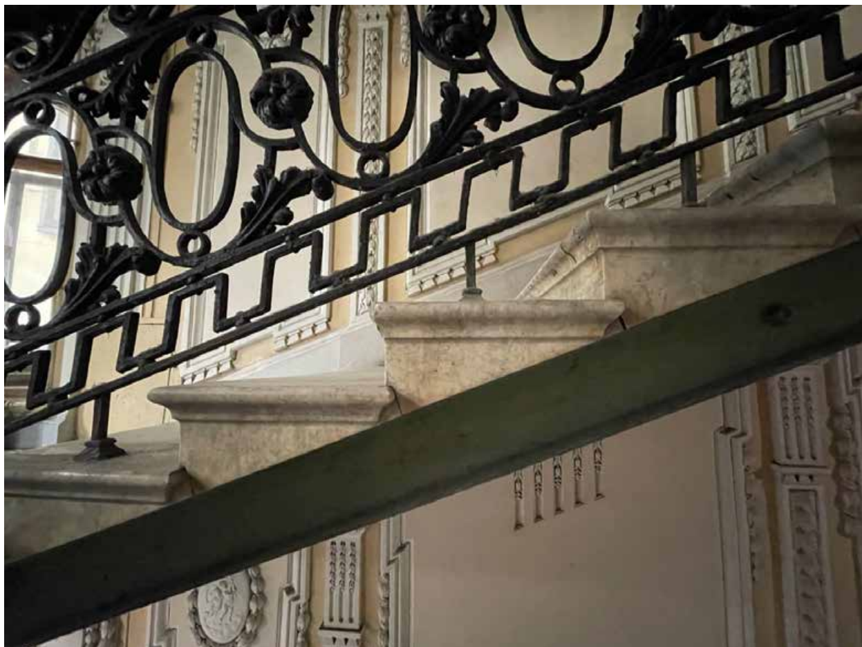
55. Профиль мраморных ступеней лестничного марша с третьего на четвертый этаж.
