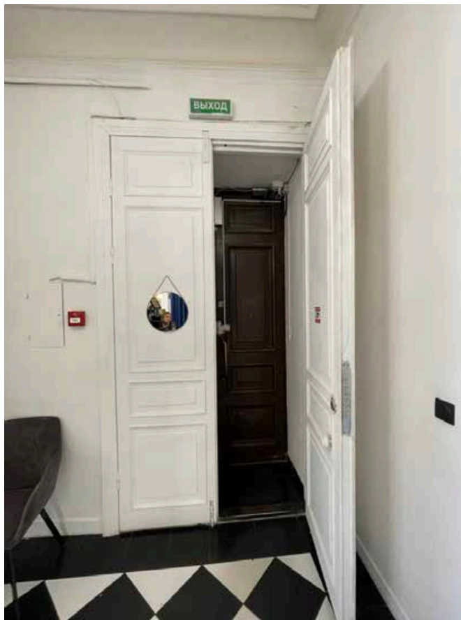
89. Дверной проем в помещении 23-Н(1).
