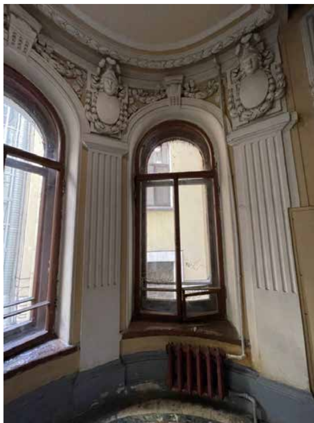
44. Оконный проем круглого ризалита в западную сторону. Лестничная площадка между вторым и третьим этажами. Простенки между окнами оформлены каннелированными частично пилястрами с плоскими капителями.
