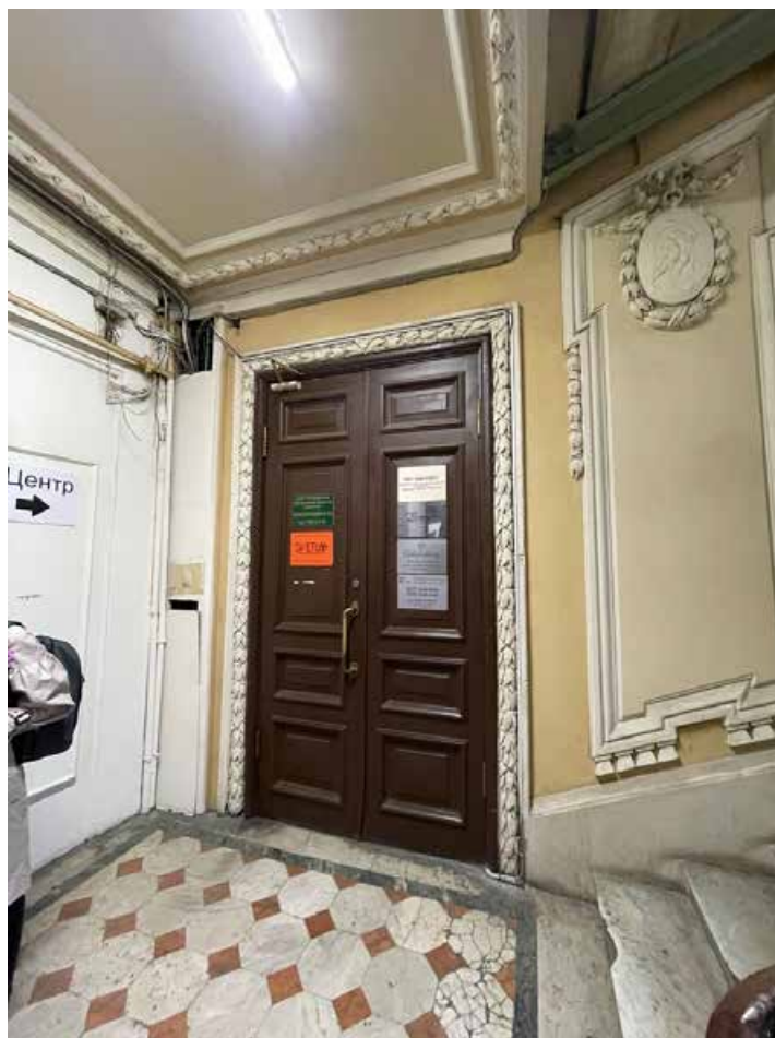
86. Дверной проем в помещение 25-Н(1). Оформление проема аналогично оформлению проема этажом ниже. Заполнение двустворчатое деревянное, каждая створка делится на 4 филенки.
