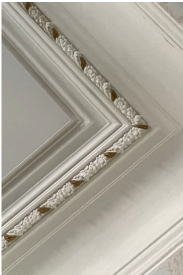
144. Фрагмент оформления плафона потолка помещения 26(Н)-4.
