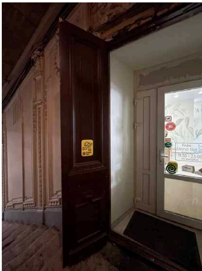
29. Дверной проем в помещение 3-Н(1). Двустворчатое филенчатое деревянное дверное заполнение, каждая створка делится на три филенки.
