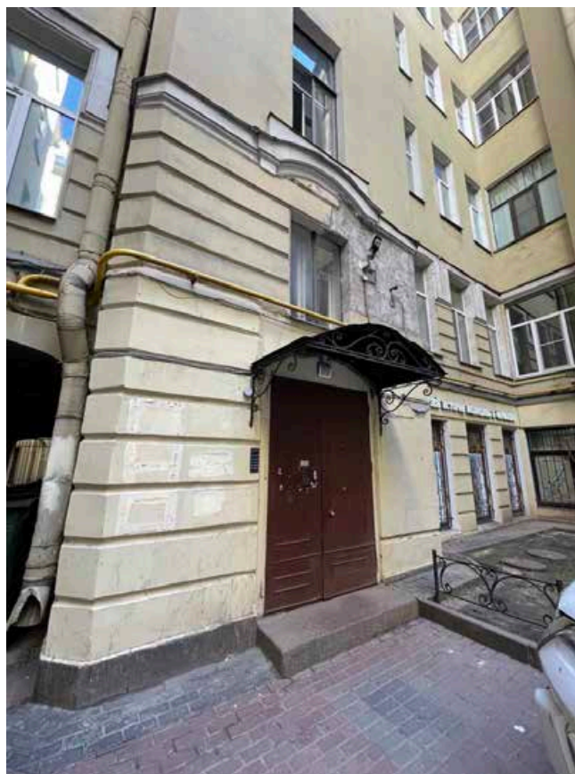
24. Дверной проем западнее воротного проезда в южный двор (южный ризалит северного двора, ведущий в лестничную клетку).
