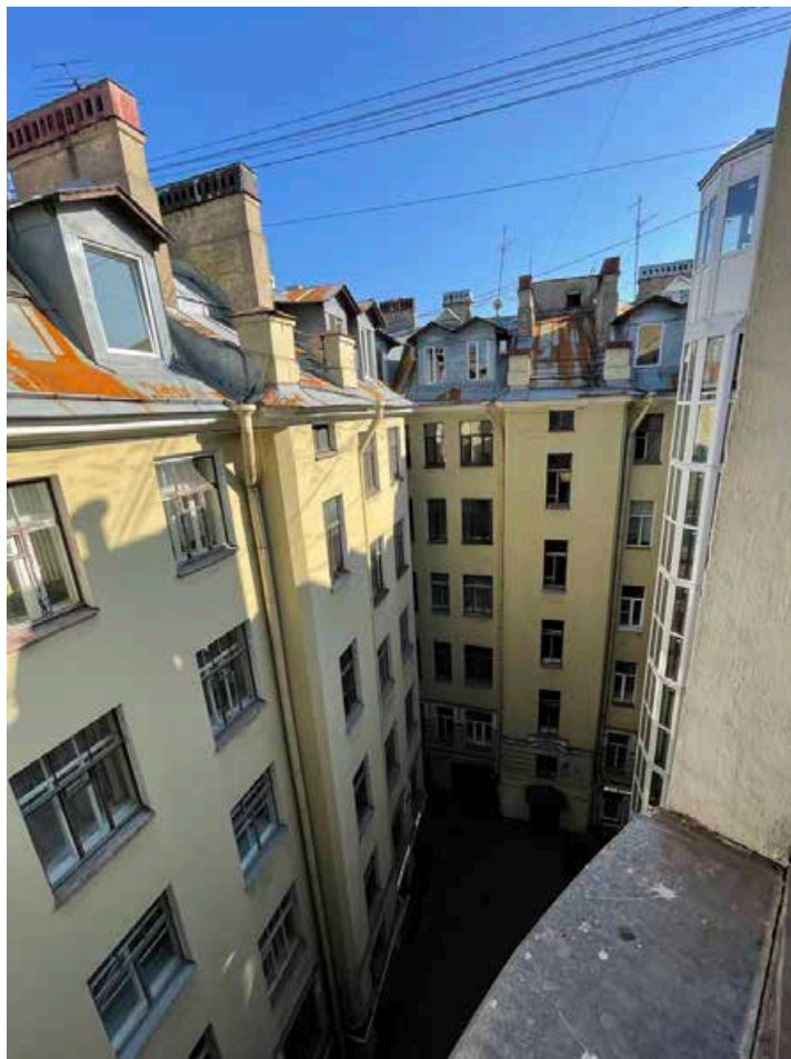
148. Вид во двор из окна лестничной клетки.
