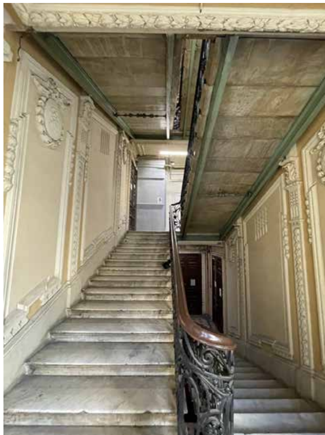
85. Общий вид лестничного марша с четвертого на пятый этаж.
