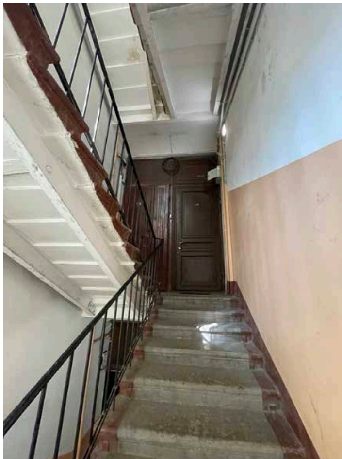
211. Общий вид лестничного марша с пятого на шестой этаж. Лестничная клетка западного фасада.
