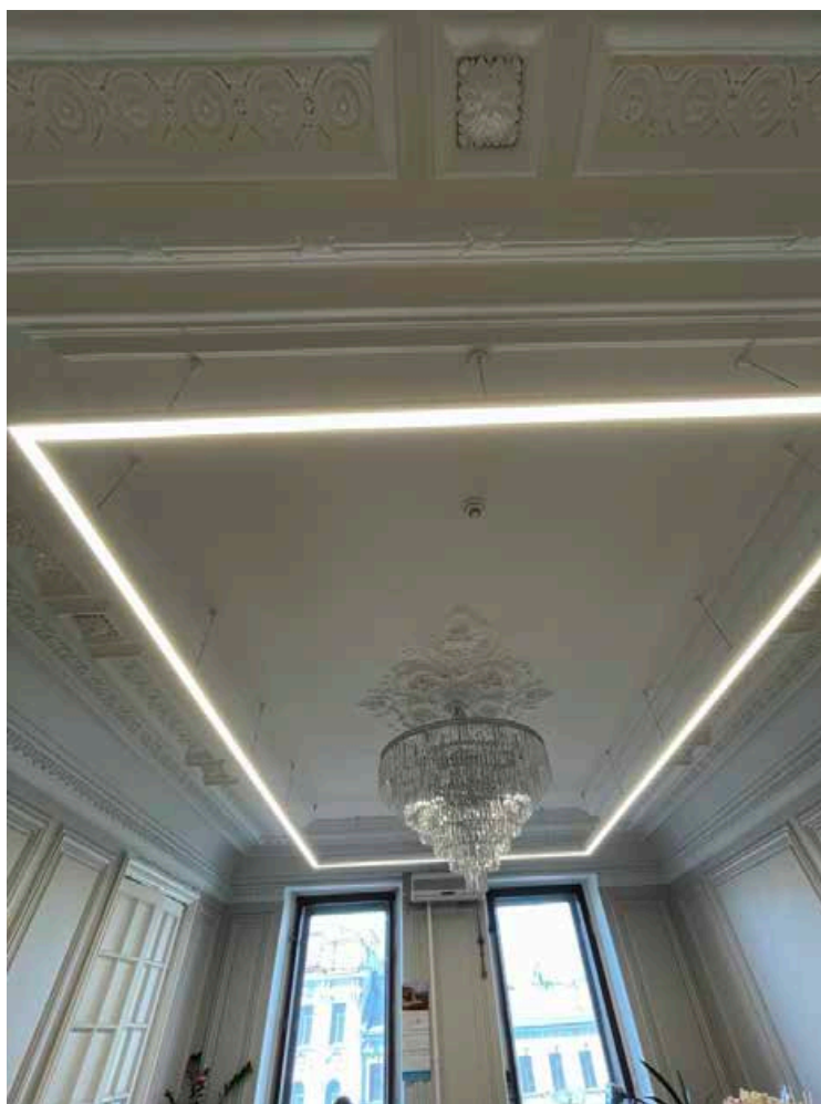
73. Общий вид оформления плафона потолка помещения 12-Н(7).
