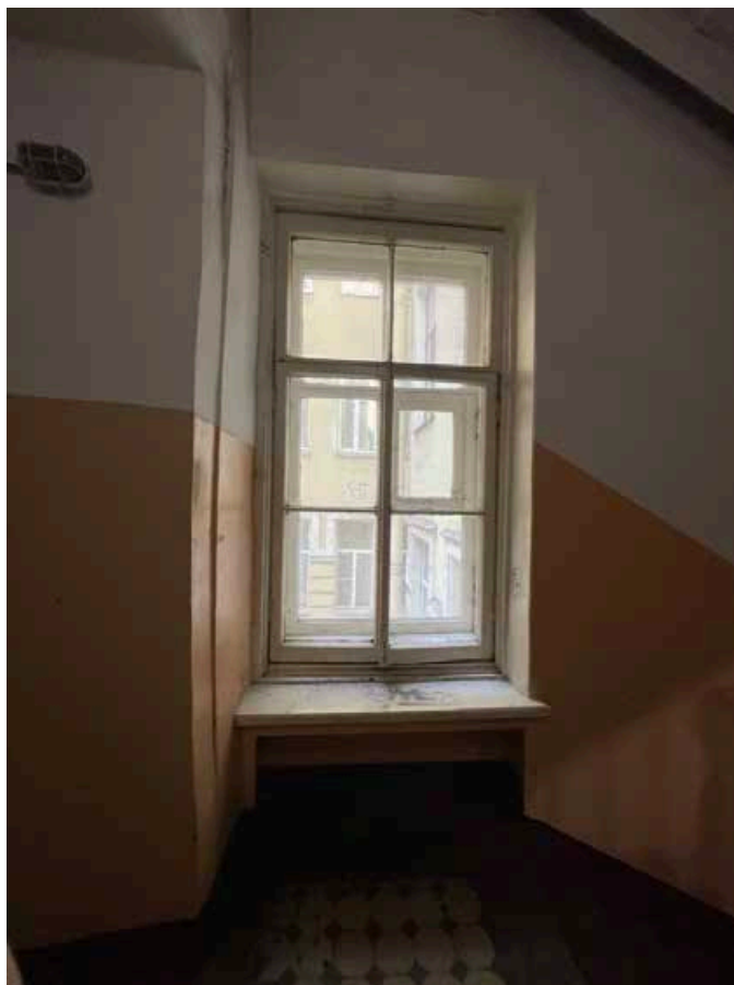
201. Оконный проем на лестничной площадке между вторым и третьим этажами. Лестничная клетка западного фасада.
