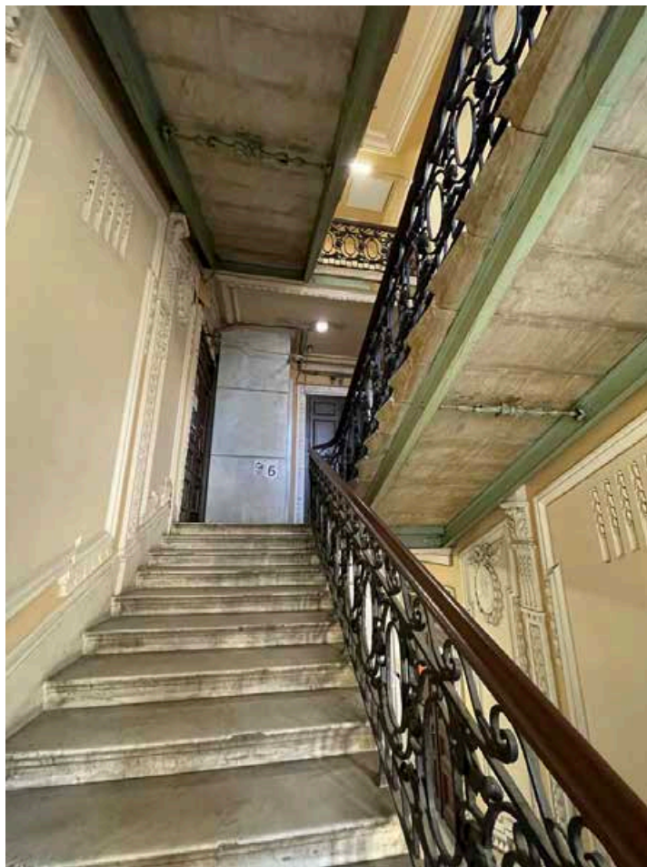
122. Общий вид лестничного марша с пятого на шестой этаж.
