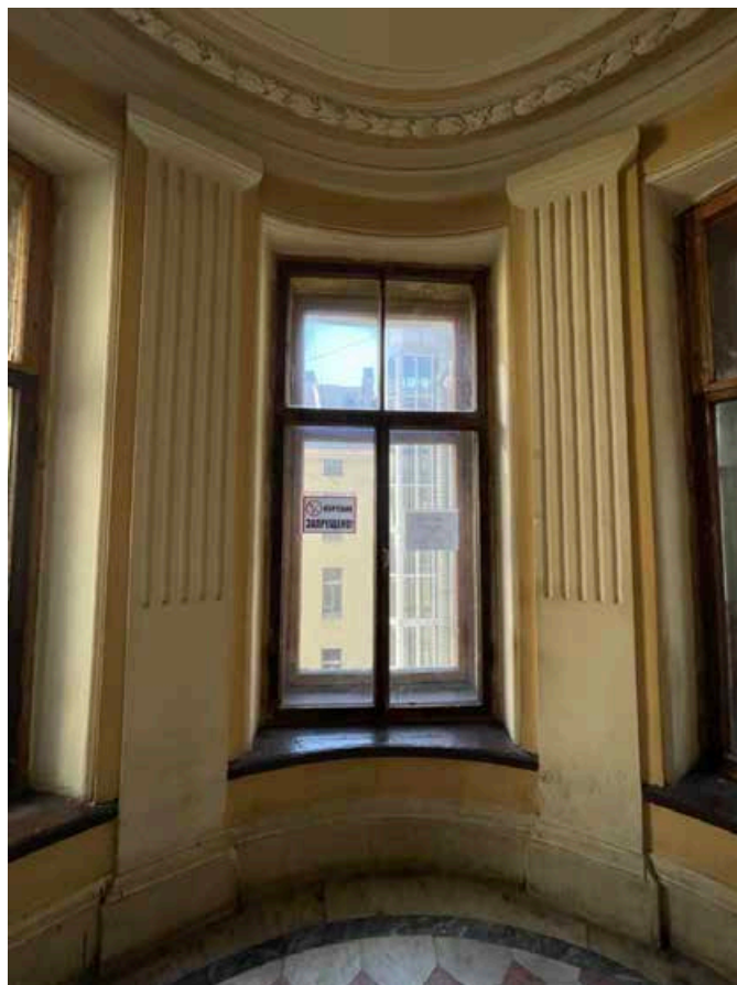
120. Оконный проем круглого ризалита лестничной площадки между пятым и шестым этажами. Вид в южную сторону.
