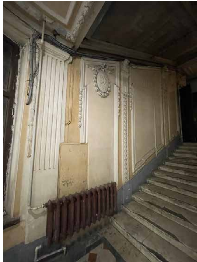
23. Общий вид оформления стены лестничного марша на второй этаж.
