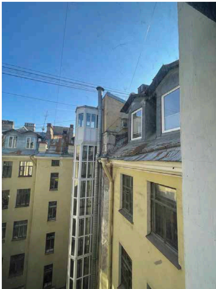
150. Вид во двор из окна лестничной клетки.
