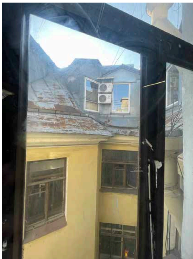
151. Вид на мансардный этаж из окна лестничной клетки.
