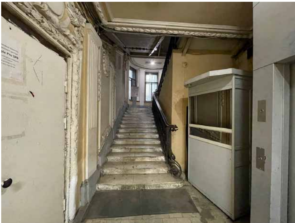
9. Общий вид лестничной клетки в уровне первого этажа. Справа под лестницей установлена сторожевая будка, а также лифтовая шахта (на всю высоту здания).
