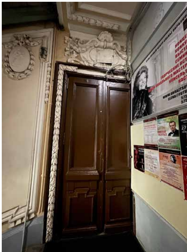
49. Дверной проем в помещение 10-Н(1).
