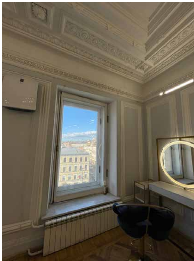
99. Фрагмент оформления стен у оконного проема в помещении 23-Н(2).
