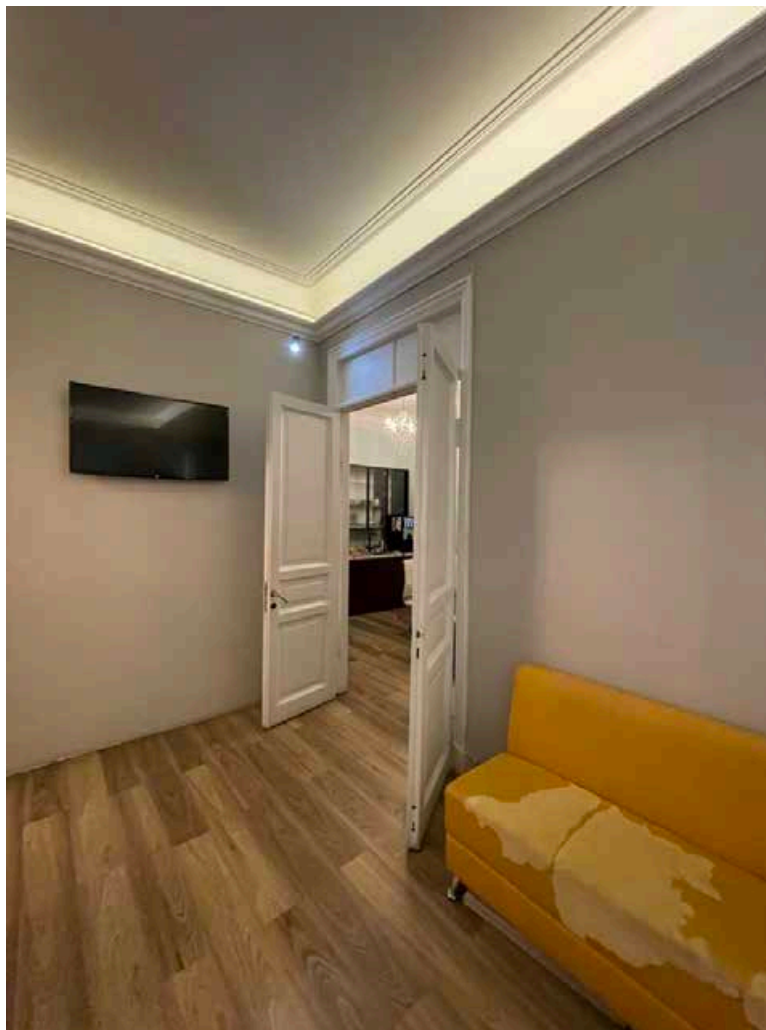
69. Фрагмент помещения 12-Н(1). Вход в помещении 12-Н(5).
