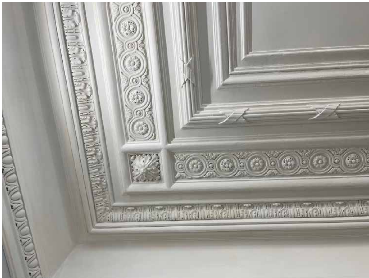
96. Фрагмент оформления плафона потолка помещения 23-Н(2) многоуровневым карнизом.
