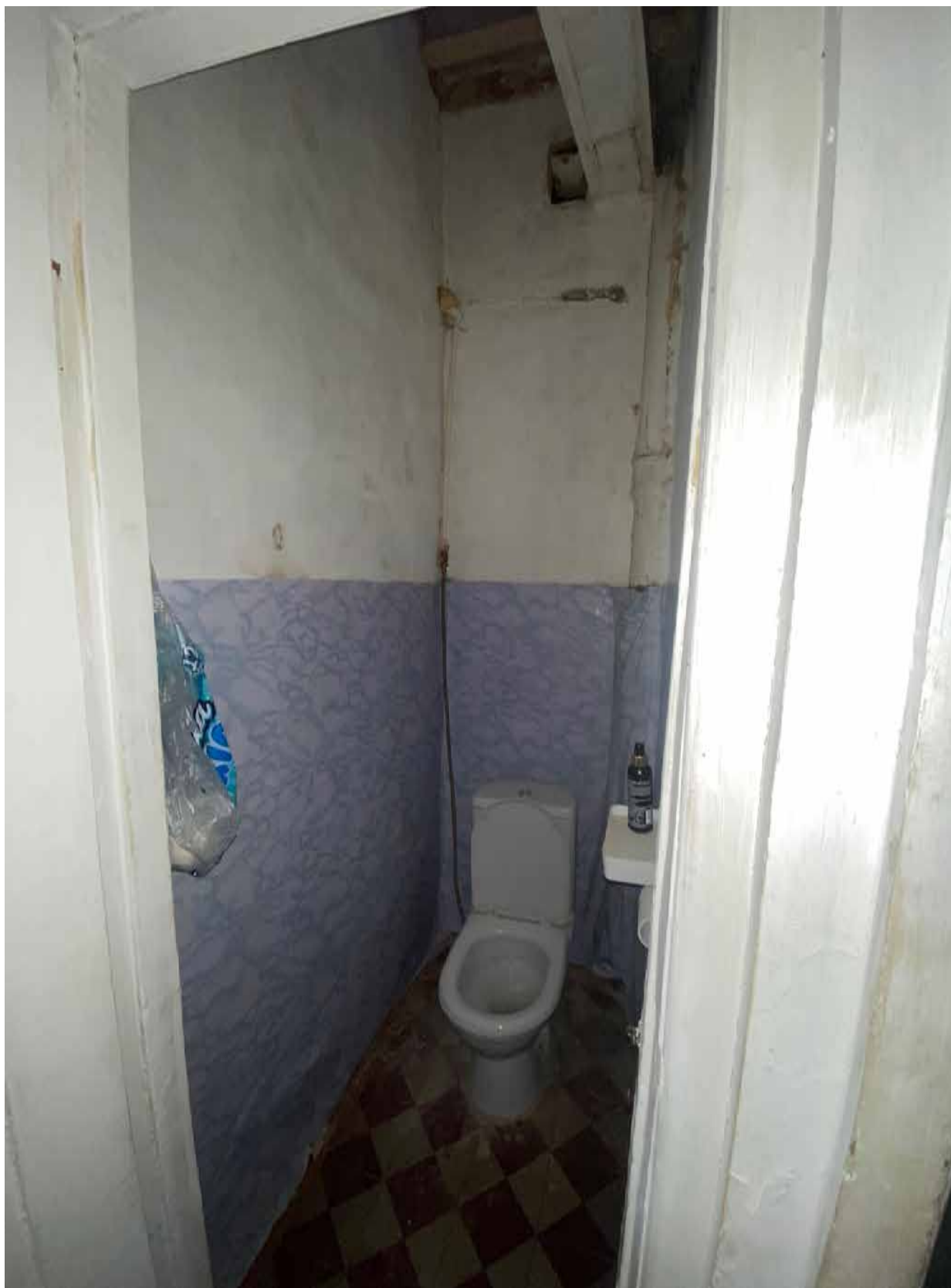
20. Фрагмент интерьера туалета (помещение 9/1.2).
