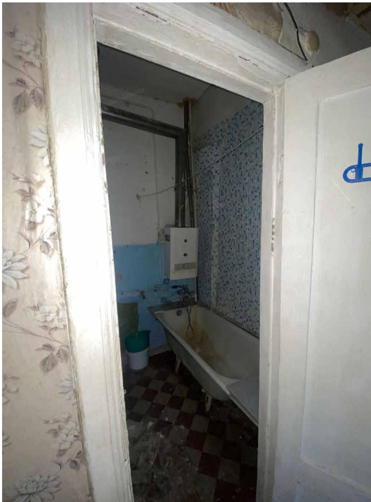
19. Фрагмент интерьера ванной (помещение 7/3);
