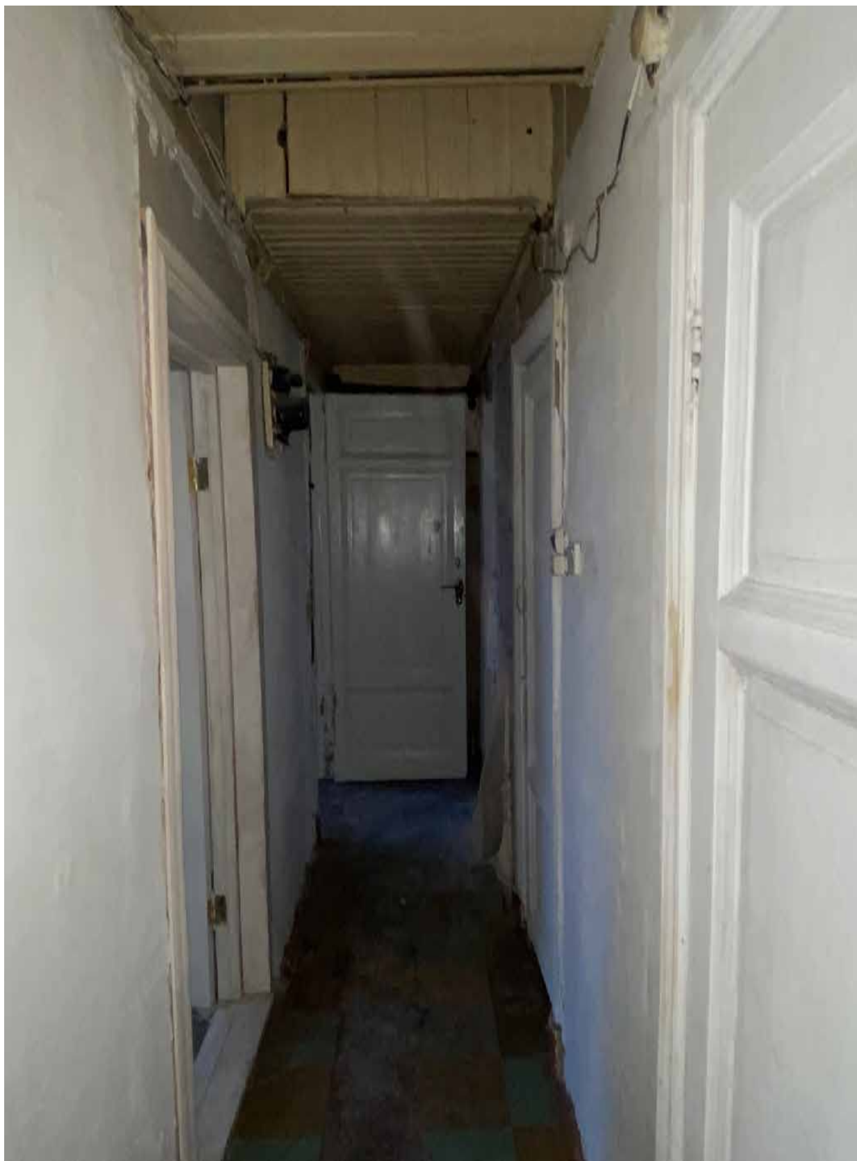
10. Фрагмент интеръера коридора (помещение 8/3.9);
