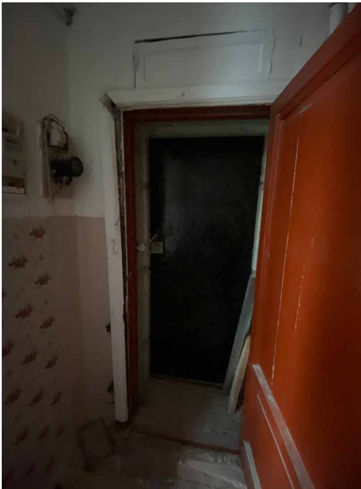
17. Вид на входную дверь в квартире;
