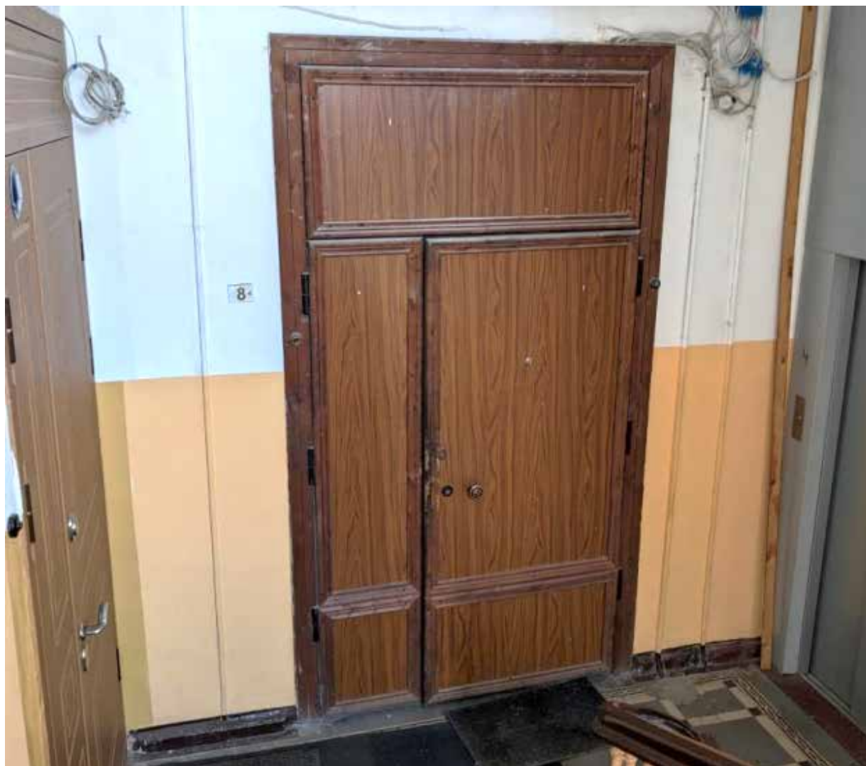
3. Вид на входную дверь в квартиру;
