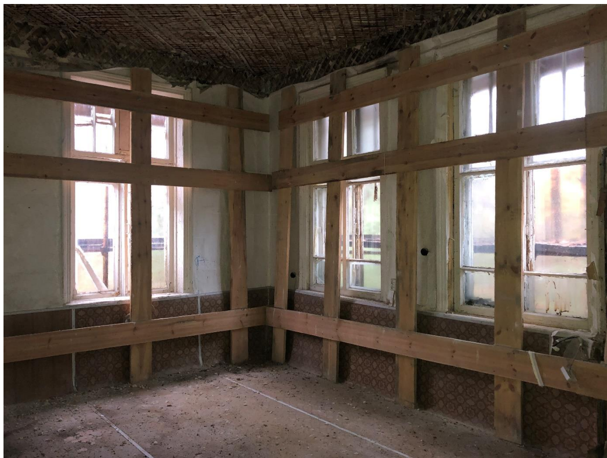
Фото 15. Второй этаж. Помещение № 3.
