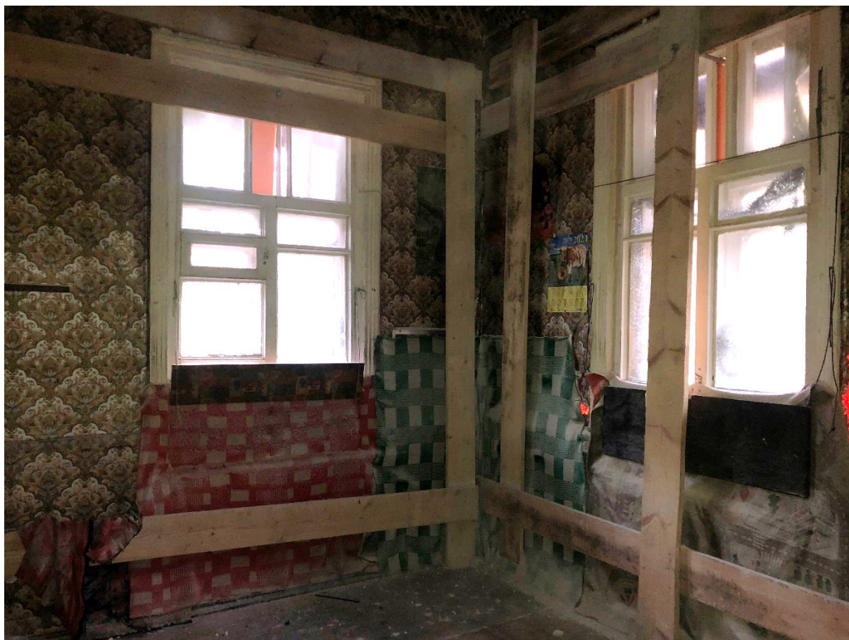
Фото 7. Первый этаж. Помещение № 11.
