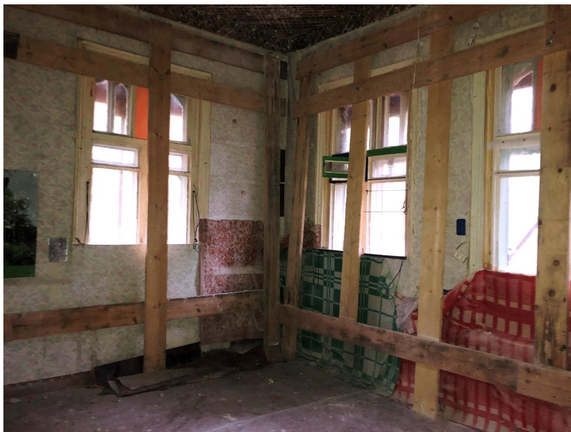
Фото 8. Первый этаж. Помещение № 10.
