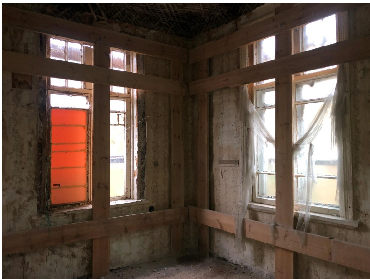
Фото 14. Второй этаж. Помещение № 2.
