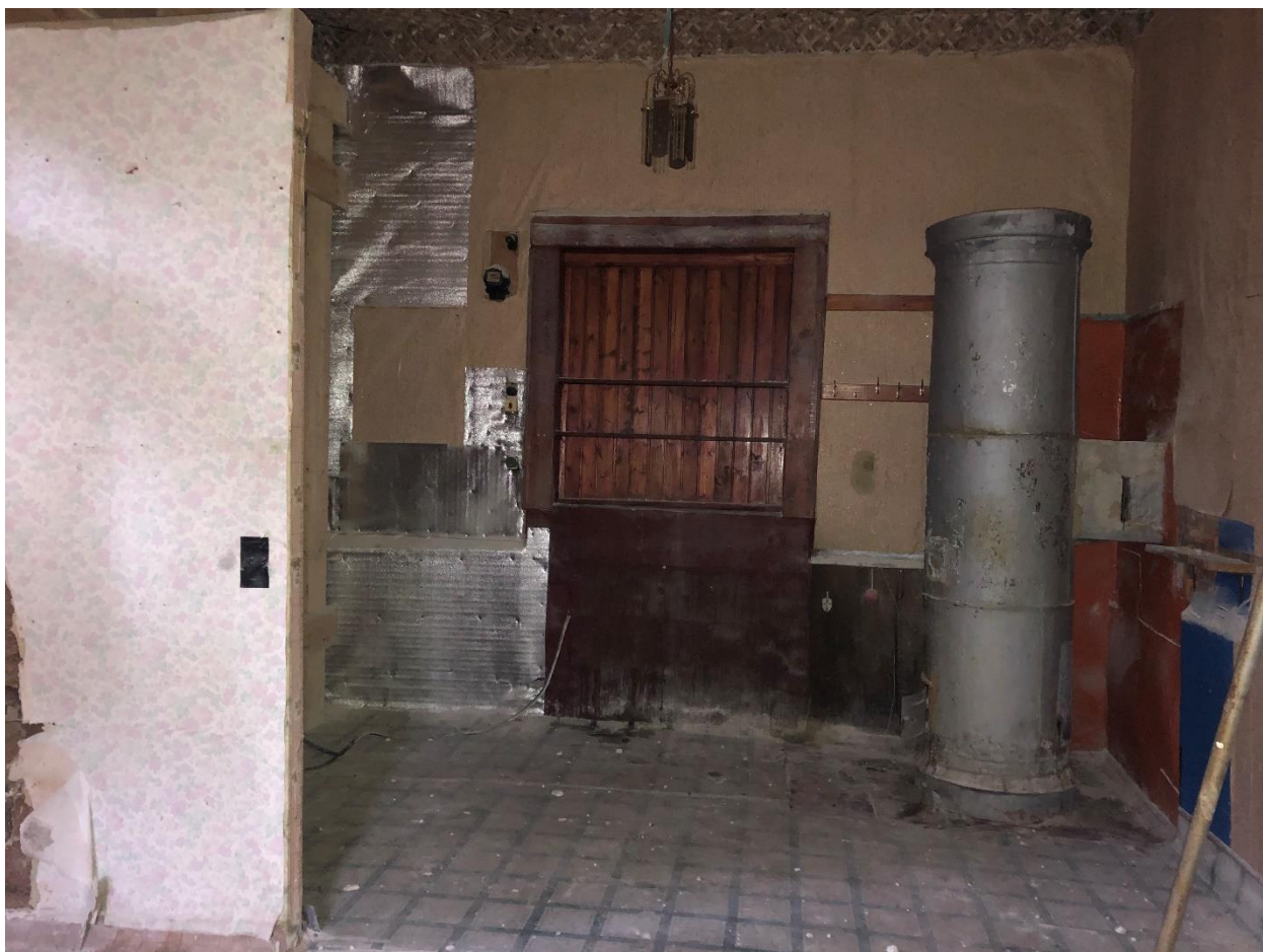
Фото 9. Первый этаж. Помещение № 9.
