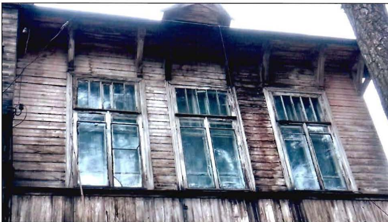
4. Свесы кровли на кронштейнах и кобылках.
