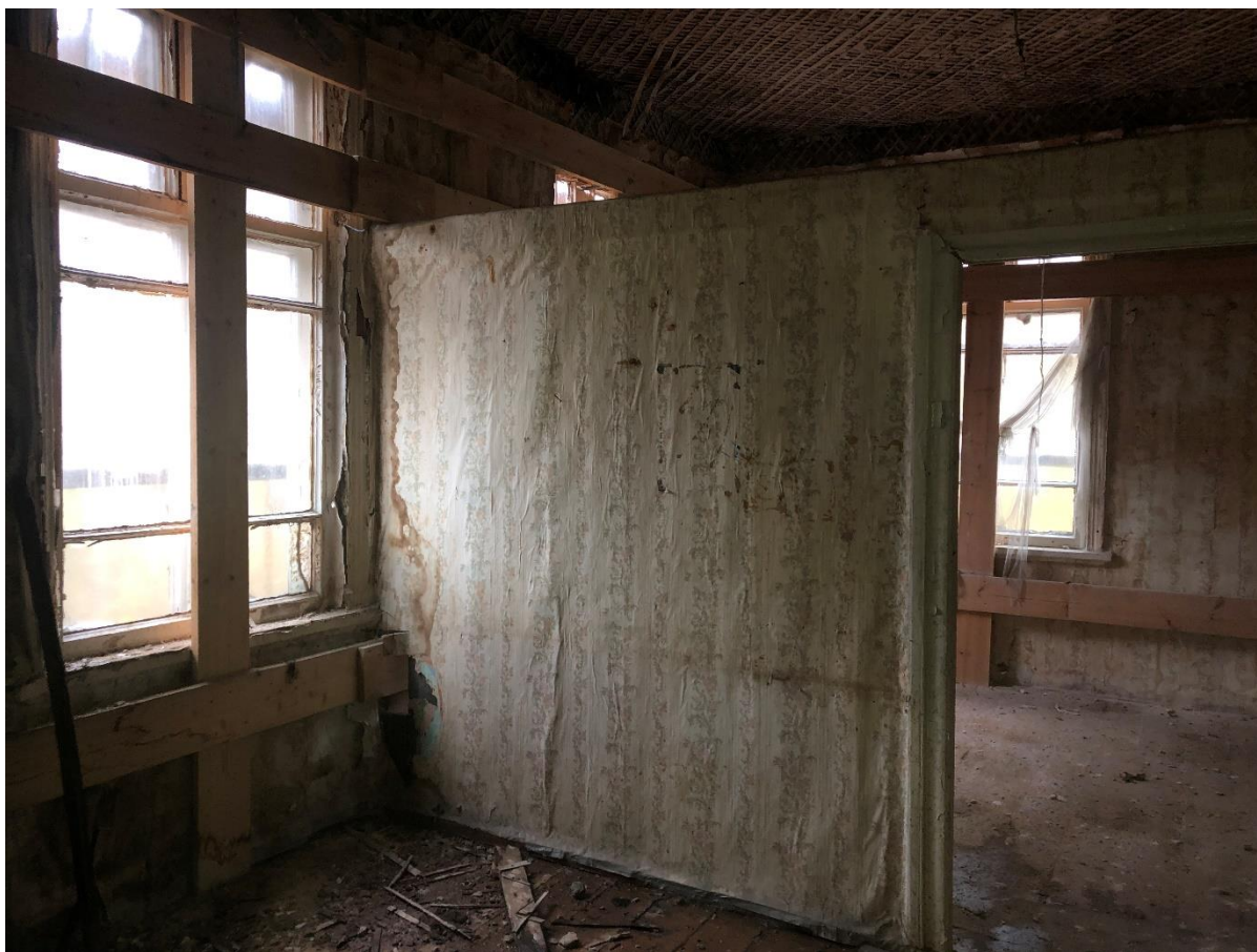
Фото 13. Второй этаж. Помещение № 2.
