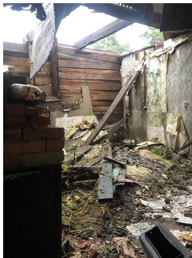
Фото 11. Второй этаж. Помещение № 1.
