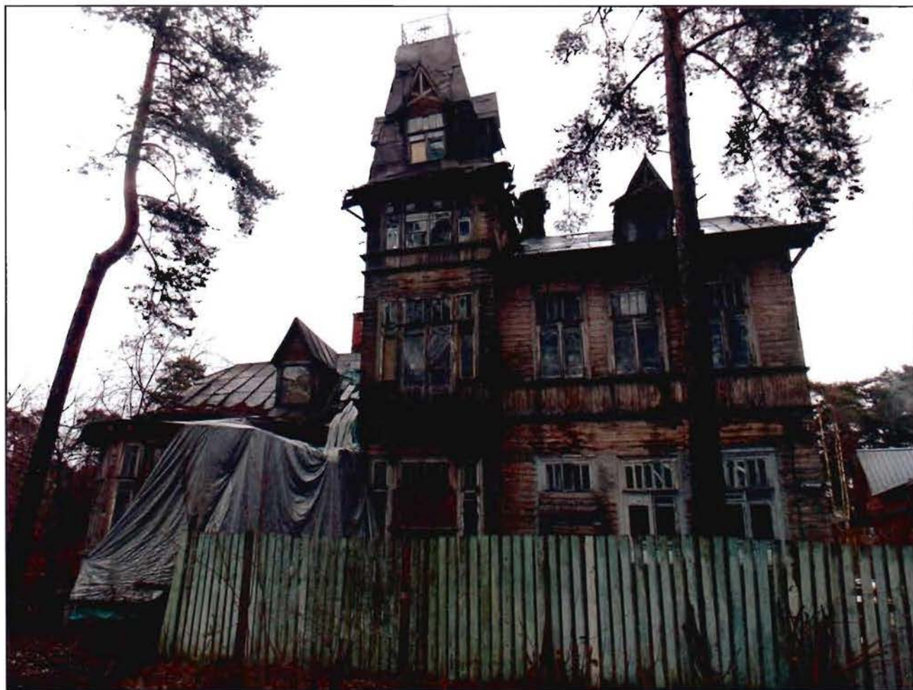
1.Общий вид на западный фасад.
