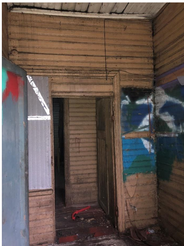
Фото 1. Первый этаж. Помещение № IV.
