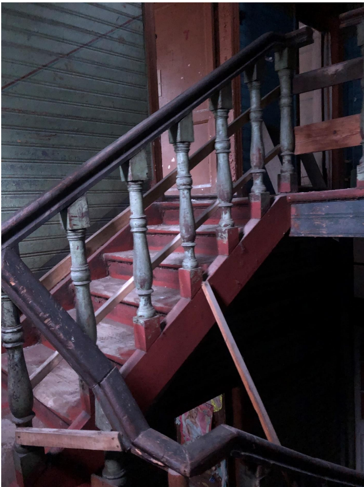
Фото 12. Лестница, ведущая в уровень чердачного этажа.
