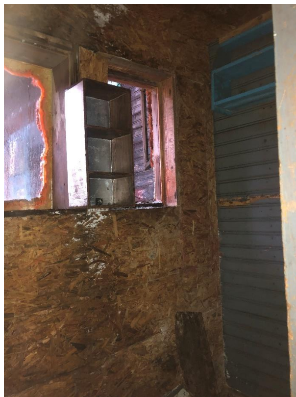
Фото 2. Первый этаж. Помещение № V.
