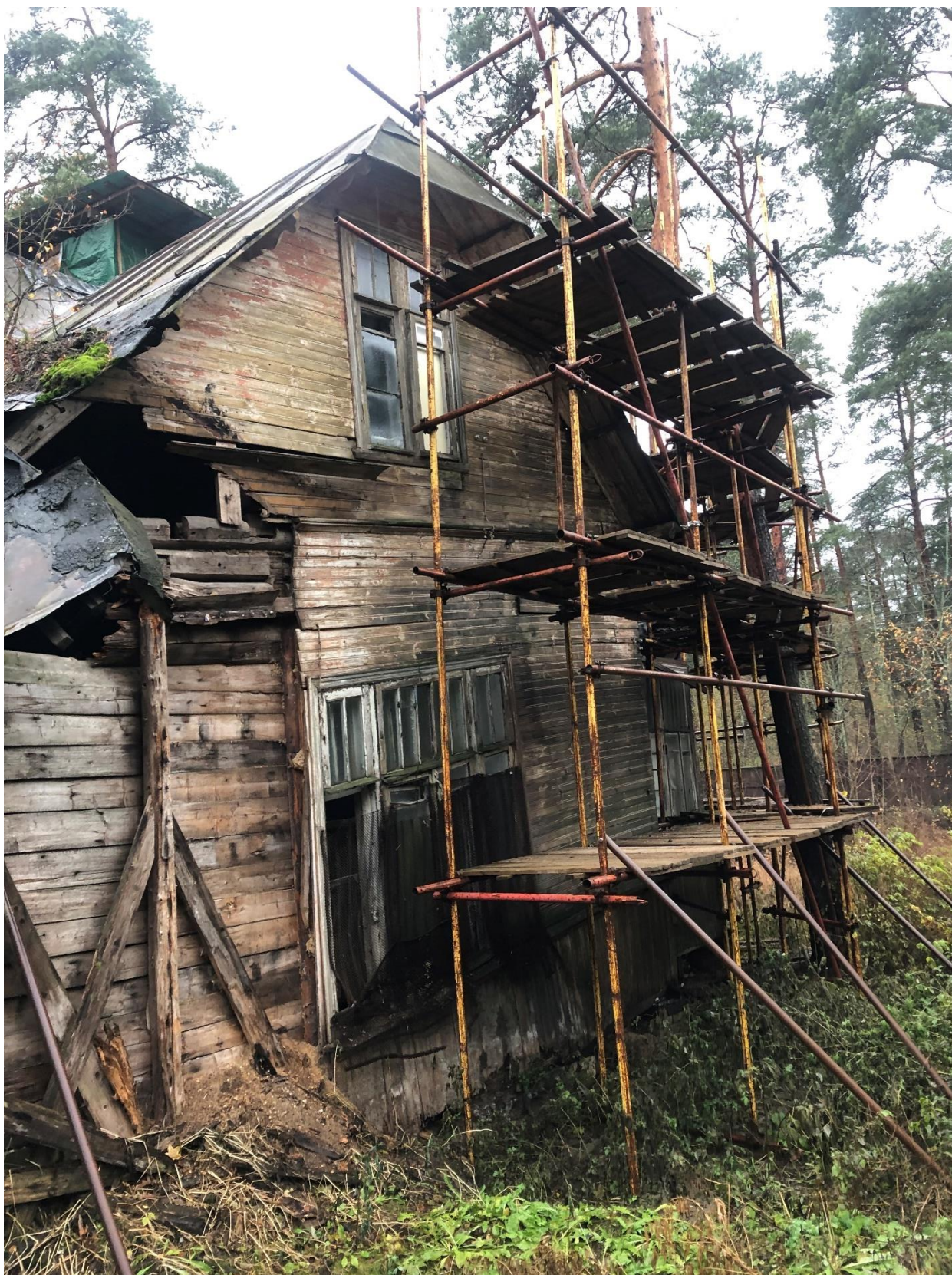
Фото 6. Фрагмент северного фасада.
