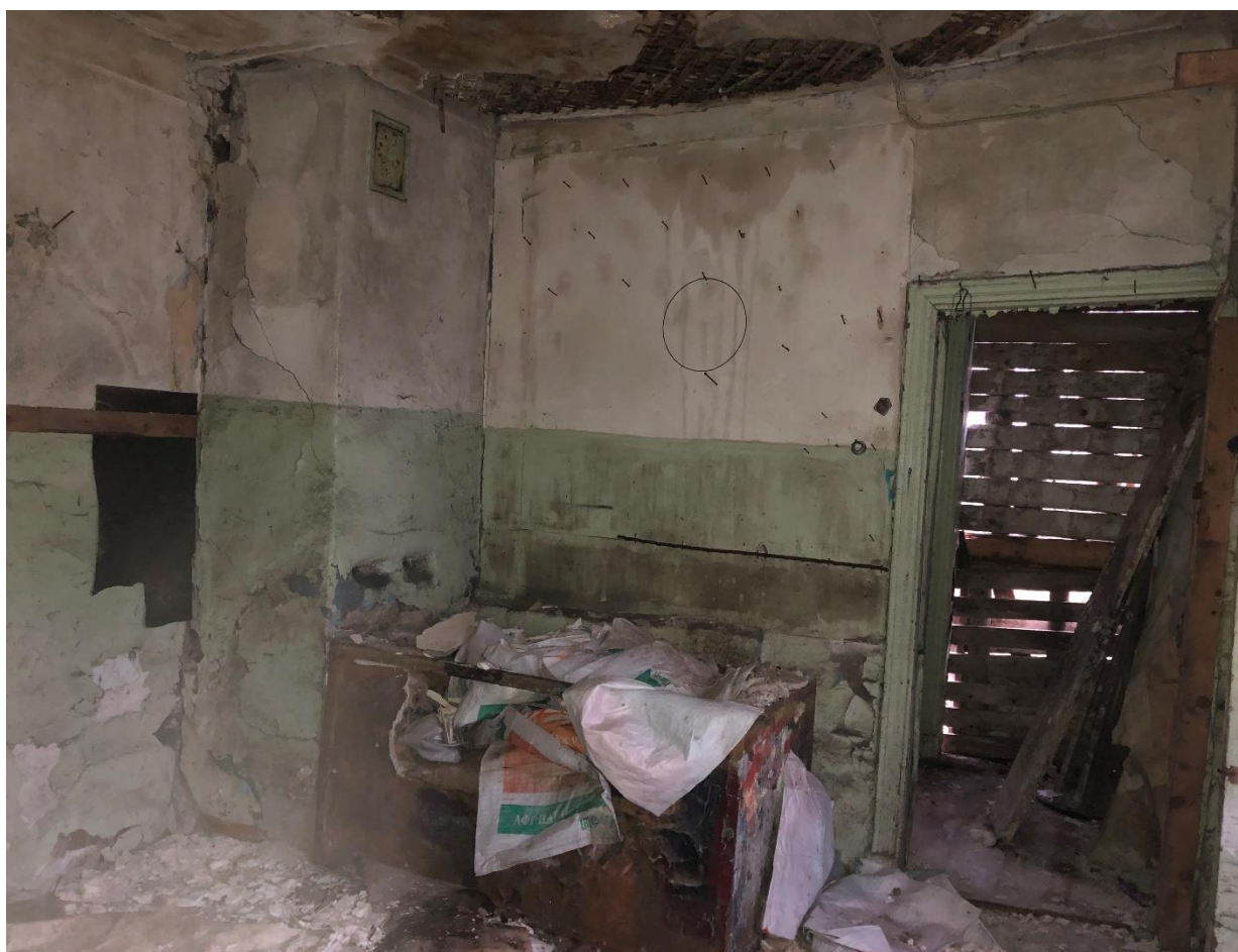
Фото 3. Первый этаж. Помещение № 1.
