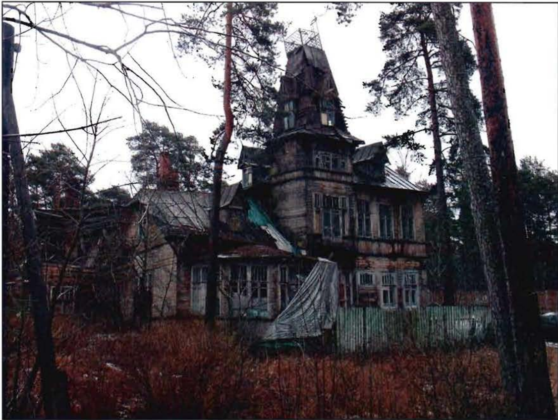
2.Общий вид на северо-западный фасад.
