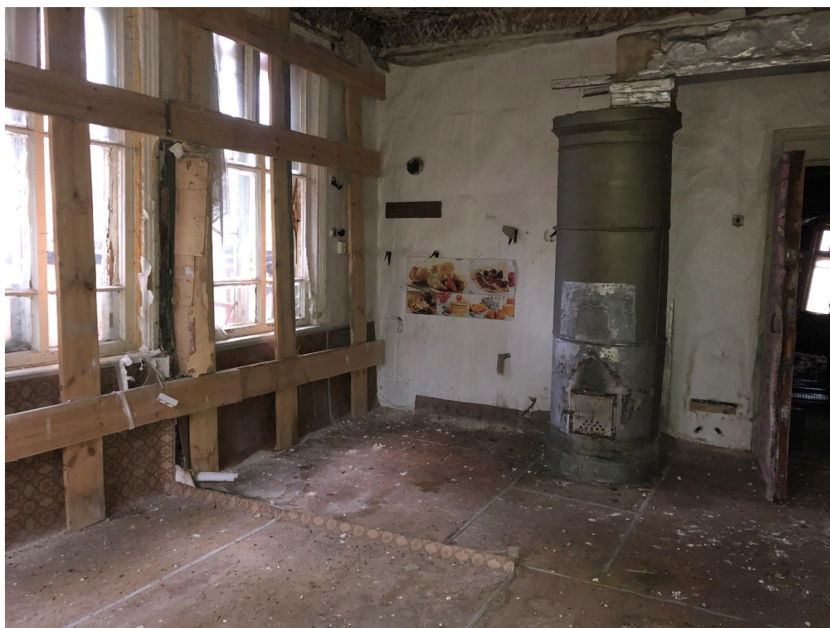
Фото 16. Второй этаж. Помещение № 3.
