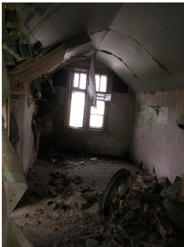
Фото 17. Второй этаж. Помещение № 5.
