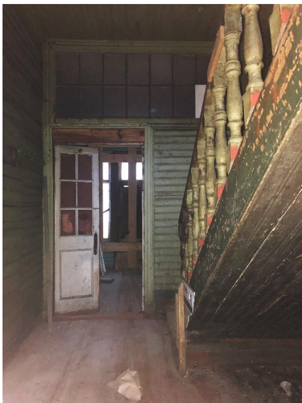
Фото 4. Первый этаж. Помещение № I.
