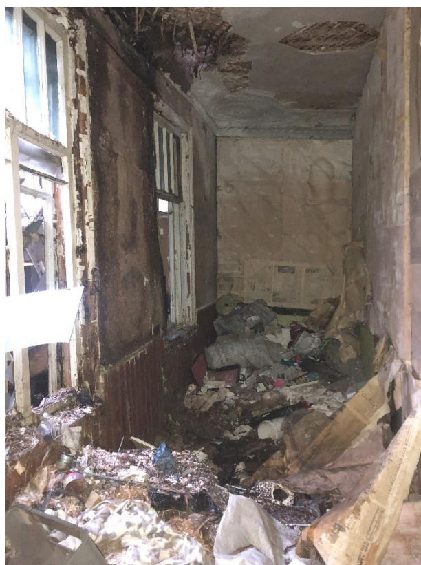
Фото 10. Первый этаж. Помещение № 8.
