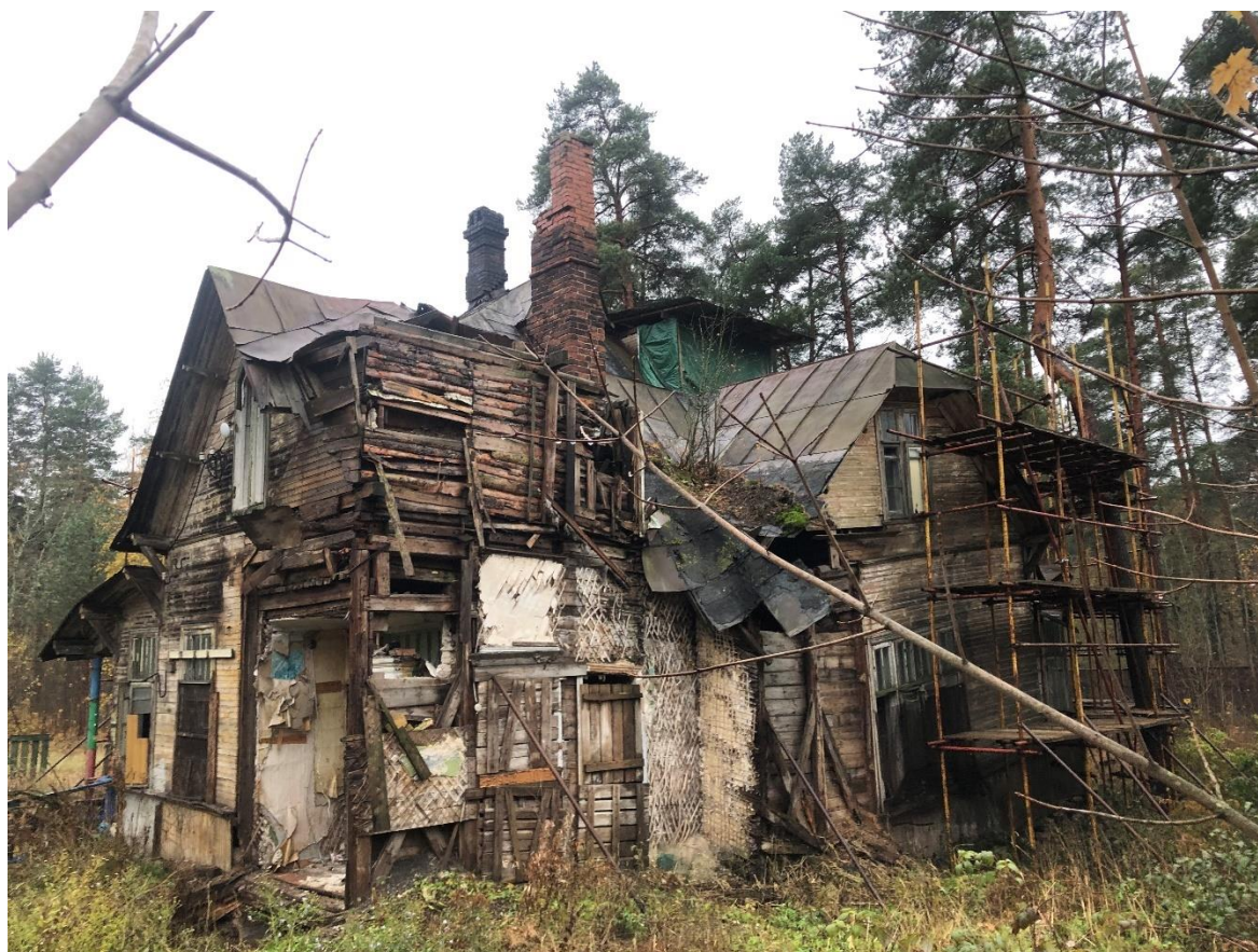
Фото 5. Угол северного и восточного фасадов.
