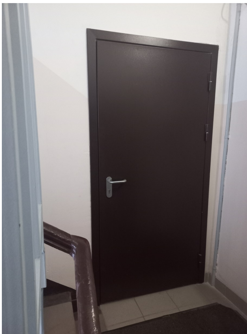
Фото 5. Существующий вход в помещения.
