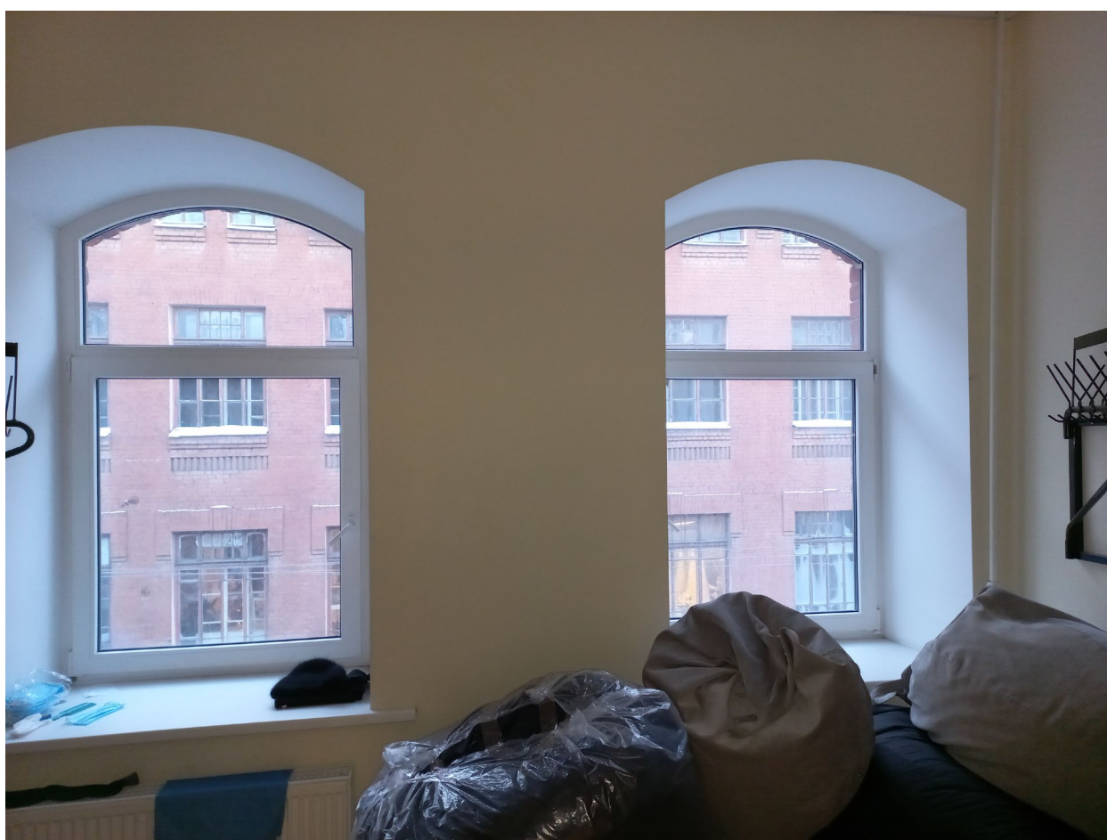
Фото 17. Раздевалка, помещение 8 по проектной экспликации.
