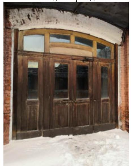
заполнения дверных проемов восточного фасада (два) – исторические конструкция (трехстворчатое с двумя нестворными частями, с остекленной фрамугой и двустворчатое с остекленной фрамугой), материал (дерево), рисунок остекления фрамуги, цвет (коричневый), профили, оформление (прямоугольные филенки на дверных полотнах);
