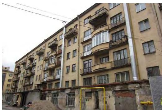
двадцать четыре «французских» балкона - местоположение, габариты и конфигурация, остекление (четырёхчастное); ограждение балкона: материал (металл), техника исполнения (прокат), рисунок (в виде горизонтального ряда прутьев, скрепленных с большим интервалом вертикальными стойками); венчающий профилированный карниз;
