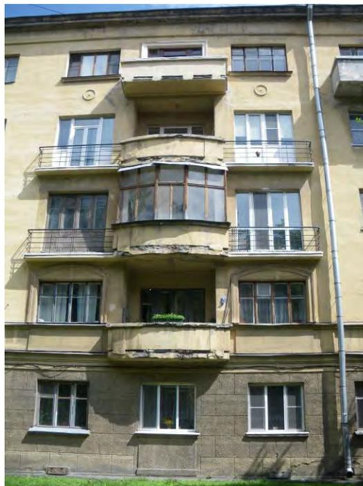
двенадцать балконов - местоположение, габариты, конфигурация (криволинейное очертание выносной плиты), ограждение (глухое, бетонное);
