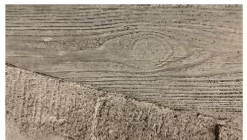
оформление стен: бетон брут (со следами опалубки), сложной фактуры разнонаправленных граней (стилизованная имитация естественной скалы);
