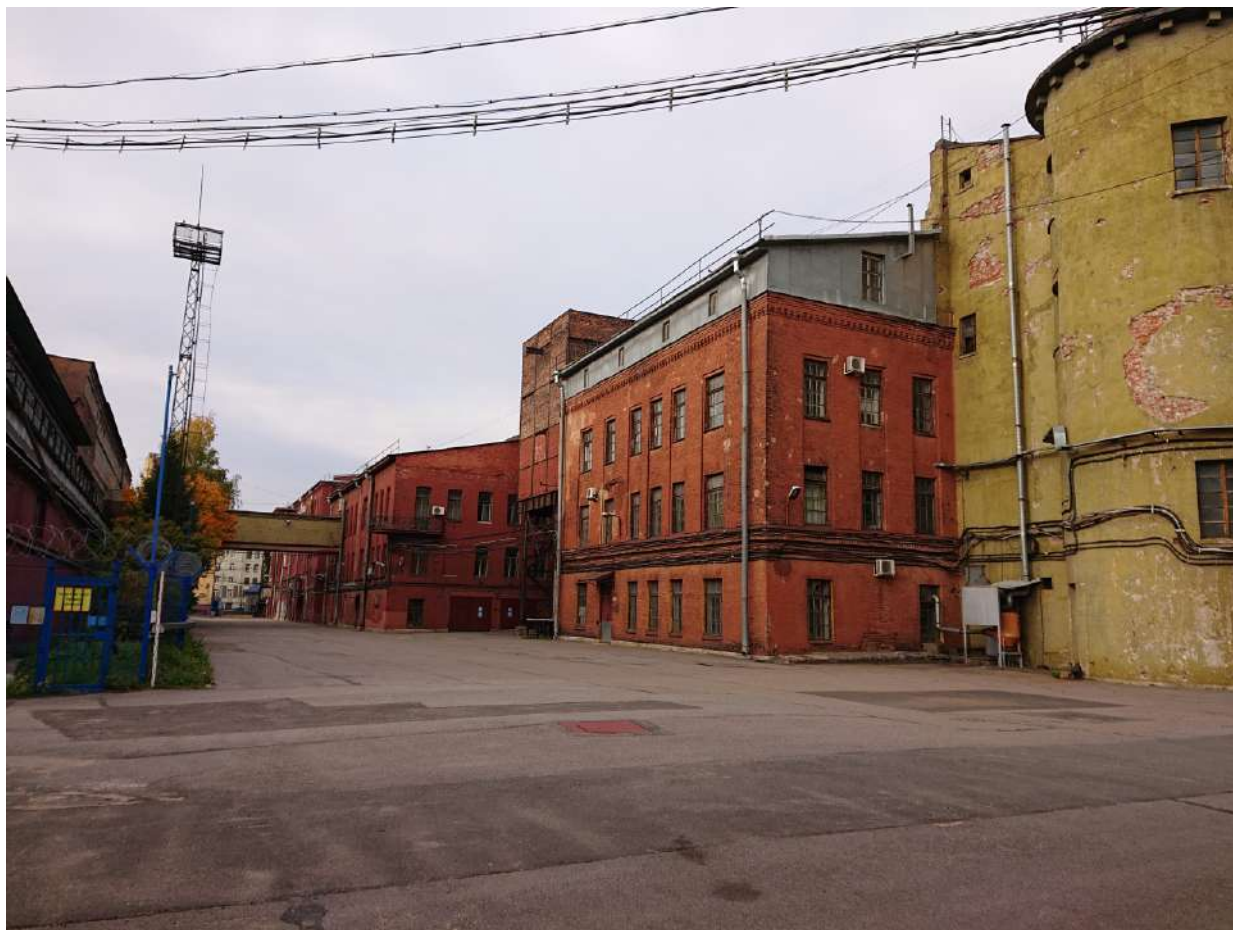
Ил. 28. Санкт-Петербург, Московский район, наб. Обводного канала, д. 76. Археологическая разведка. Точка фотофиксации 5. Западная часть участка обследования, центральная часть территории электростанции. Вид с Ю.
