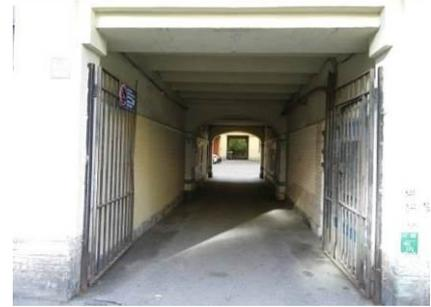
облицовка стен воротного проезда на две трети высоты глазурированным «кабанчиком» желтовато-белого цвета с фризами сверху и внизу голубого цвета;
