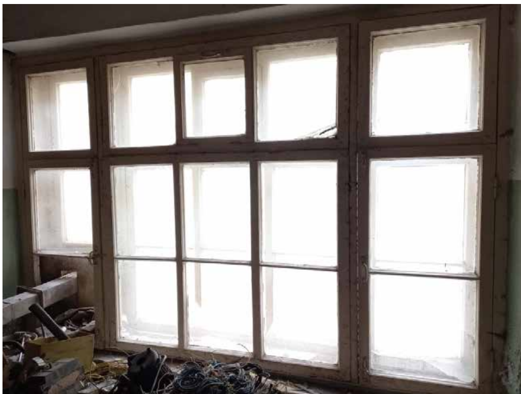
Фото 33. Оконное заполнение, 1 этаж, вид из помещения.
