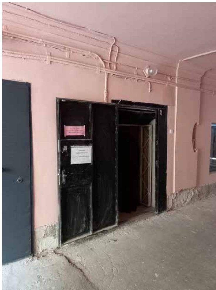
Фото 8. Стена арочного проезда. Поздние металлические двери
