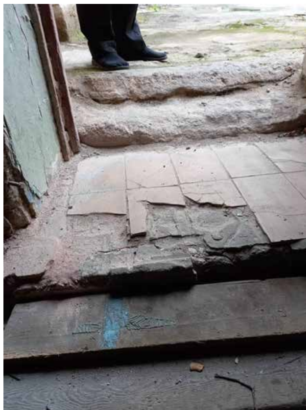
Фото 38. Дворовой фасад. Порог входа в помещение со двора. Наблюдаются разрушения дверной коробки, откоса
