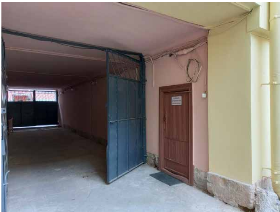
Фото 9. Стена арочного проезда. Поздние металлические ворота, утилитарное дверное заполнение входа в здание
