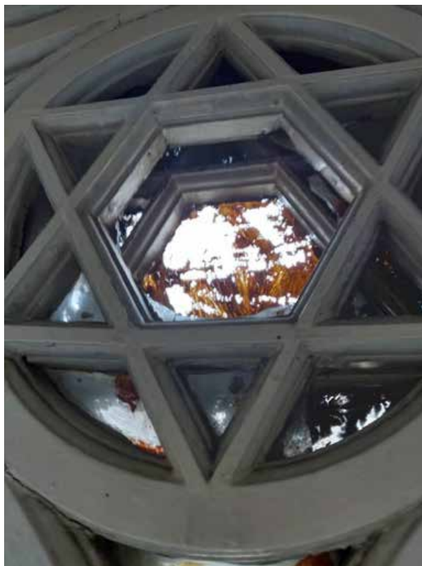
Фото 29. Фрагмент оконного заполнения, парадная лестница, 3 этаж.
