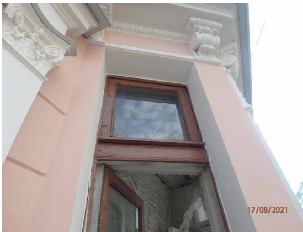
Фото 12. Лицевой фасад. Балконная дверь (левая) третьего этажа имеет дефекты и повреждения в виде трещин, коверн и поздних вставок
