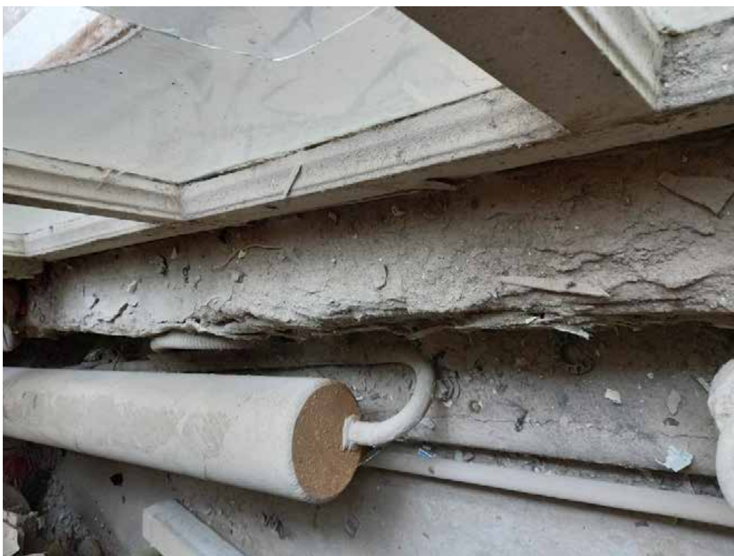
Фото 34. Оконное заполнение, 1 этаж, вид из помещения.
