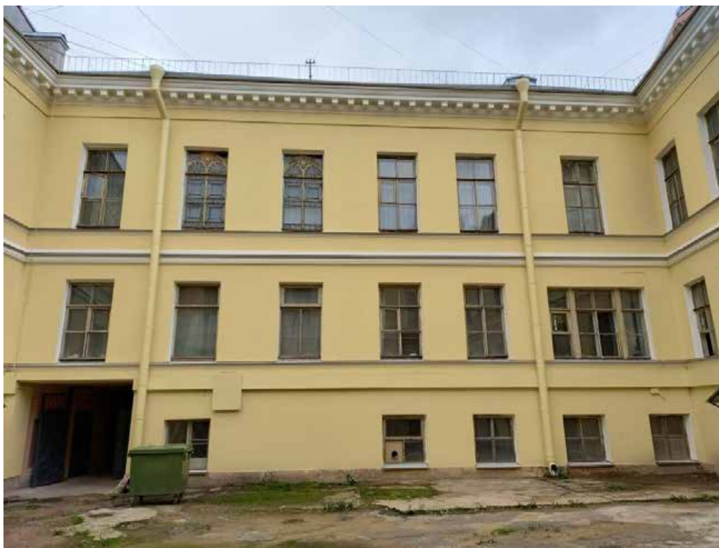
Фото 3. Дворовой фасад. Оконные заполнения за годы эксплуатации получили естественный физический износ, наблюдаются следы биоповреждений, деструкция древесины, поздние вставки и замены.
