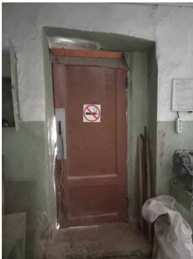
Фото 39. Дверное заполнение, 1 этаж, вид из помещения.
