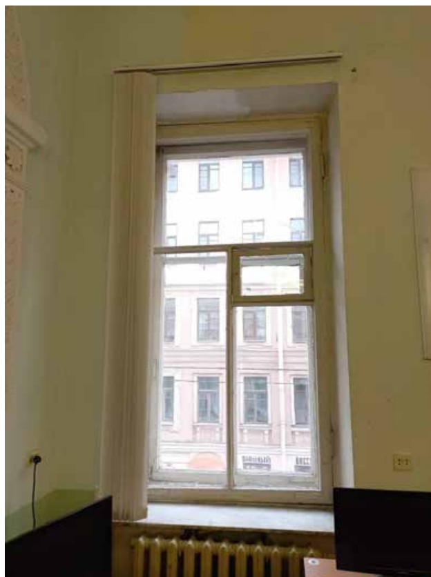
Фото 21. Оконное заполнение 3 этаж, лицевой фасад, вид из помещения. Наблюдаются нарушения геометрии окна, перекося створок, поздние вставки, многочисленные следы поздней покраски.
