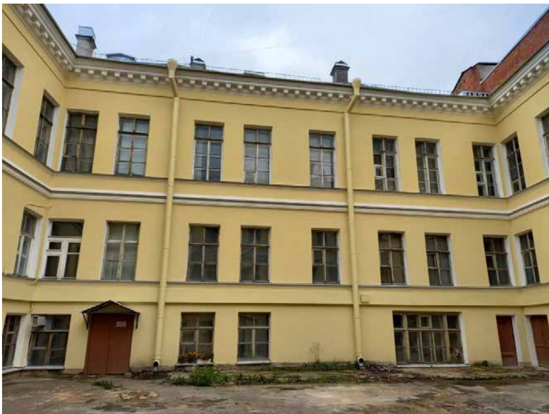
Фото 5. Дворовой фасад. Оконные заполнения за годы эксплуатации получили естественный физический износ, наблюдаются следы биоповреждений, деструкция древесины, поздние вставки и замены. Двери поздние, утилитарные.
