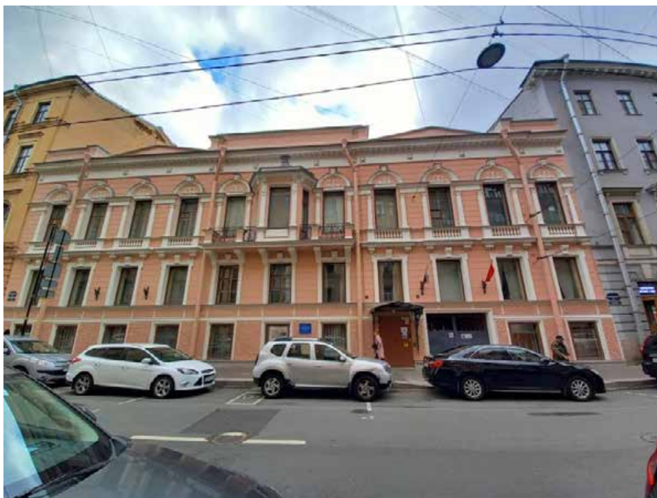
Фото 1. Общий вид. На фасаде наблюдаются оконные заполнения позднего периода с изменением расстекловки. Дверь заменена на утилитарную металлическую. Въездные ворота металлические с решеткой из арматуры.
