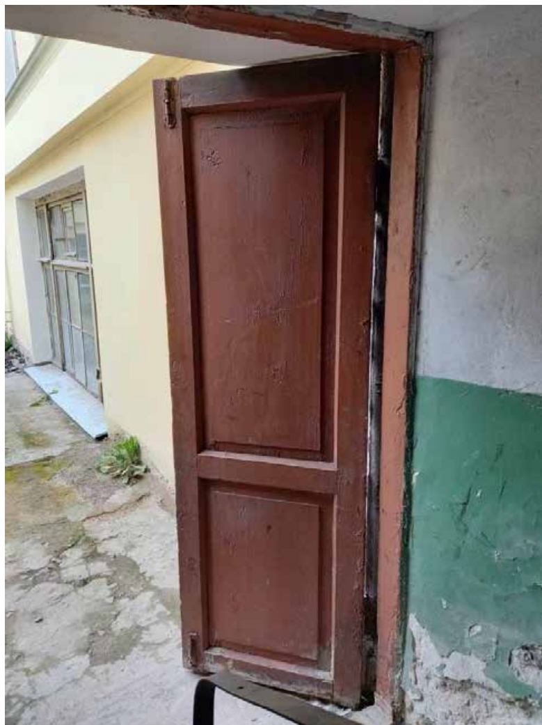
Фото 42. Дверное заполнение, 1 этаж, вид из помещения. Наблюдается перекос створок, следы деформаций, поздняя фурнитура
