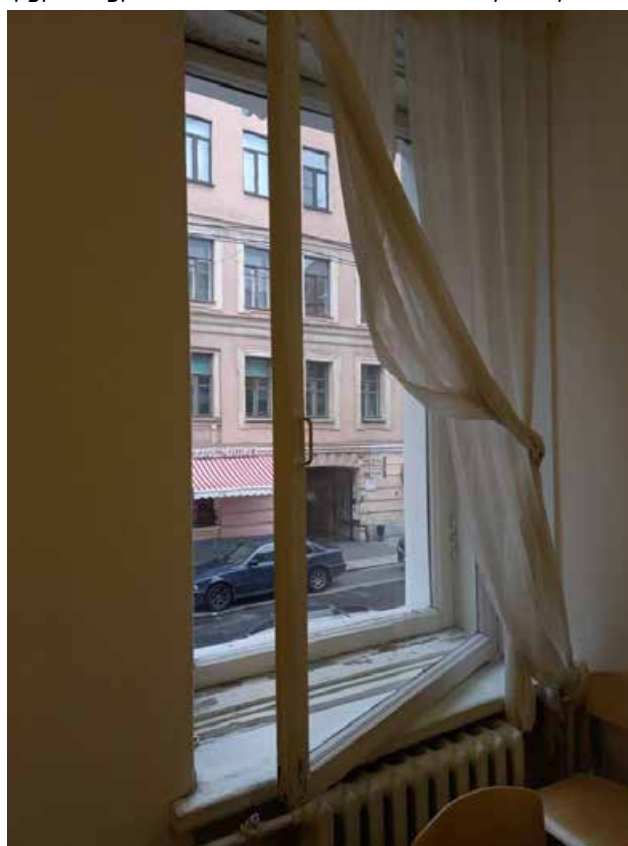
Фото 16. Оконное заполнение лицевого фасада, вид из помещения. Наблюдаются многочисленные следы поздней покраски, расхождение узловых соединений, перекося створок
