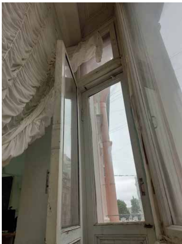
Фото 13. Балконная дверь (правая), вид из помещения. Наблюдается общий износ, трещины, разнообразная поздняя фурнитура, поздние вставки
