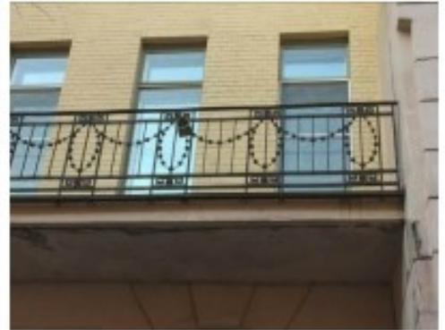
балконные ограждения – кованые черного металла, рисунок (в центральной части вертикальные прутья прямоугольного сечения с накладными провисающими гирляндами и овалами из стилизованных «пронизей»; вдоль верхней и нижней тетивы фризы с рисунком геометрического характера);
