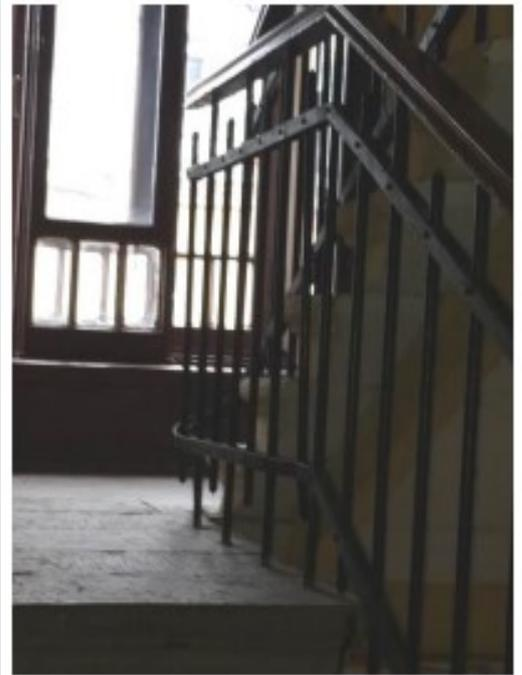
ограждение маршей (лестницы Л-3, Л-5) черного металла; техника исполнения (прокат, ковка, слесарная сборка); рисунок (вертикальные прутья прямоугольного сечения с «каблучками» в основании, фриз вдоль верхней тетивы ограждения из завитков и четырехлепестковых квадратных розеток);
