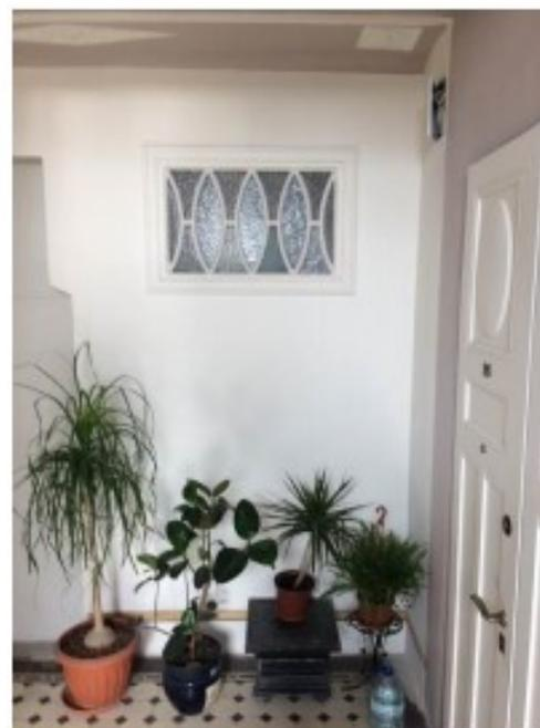
дверные заполнения – двустворчатые, каждая створка на четыре разноформатные филенки, с овалами в верхней части; профилированные наличники с «ушками»;
