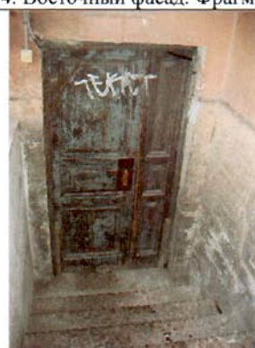
6. Входной проем восточного фасада. Общий вид.
