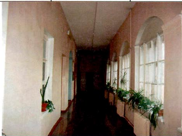
26. Коридор в уровне 3-го этажа. Общий вид.
