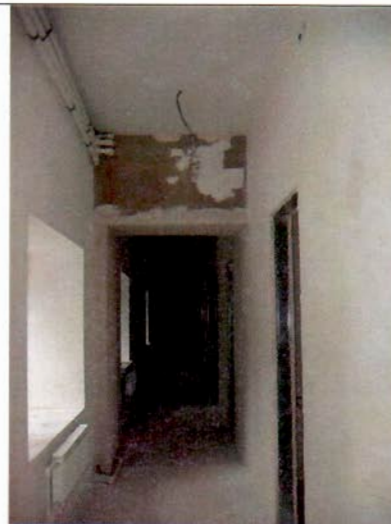
10. Коридор 2-го этажа. Общий вид.
