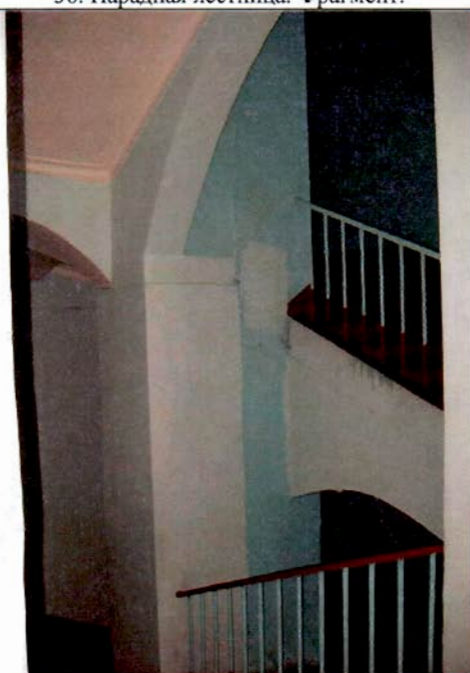
38. Лестница в южном крыле. Фрагмент.
