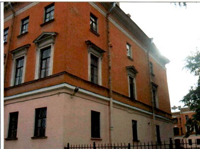
8. Западный торцевой фасад северного флигеля. Общий вид.
