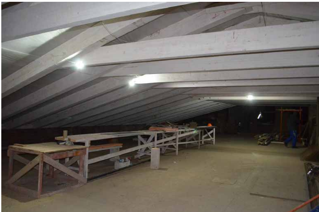
Фото 09. ОКН регионального значения «Духовная академия» (наб. Обводного канала, 7, литер Г). Стропильная система в осях Б-Д/16-20. Съёмка 22.03.2021 г.
