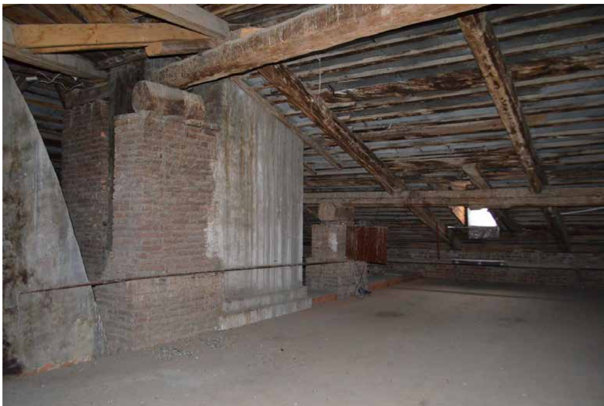
Фото 20. ОКН регионального значения «Духовная академия» (наб. Обводного канала, 7, литер Г). Стропильная система в осях Б-Д/1-5. Съёмка 22.03.2021 г.
