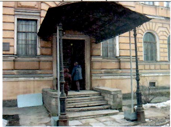
10. Входная группа северного фасада. Общий вид.
