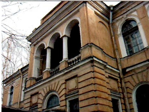
9. Северный фасад. Фрагмент.
