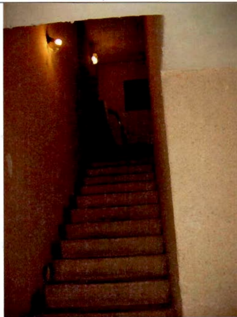
10. Лестница. Общий вид.
