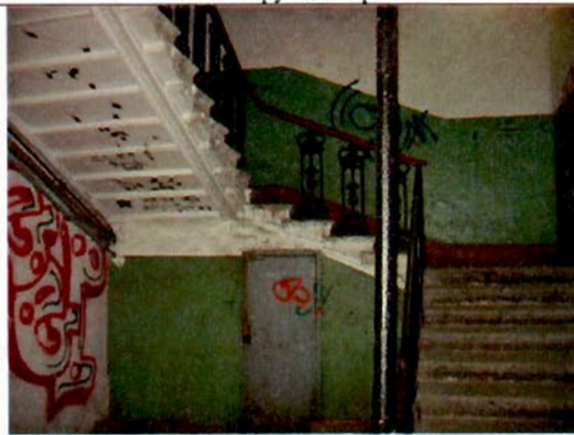
28. Лестница в южной части здания. Общий вид.
