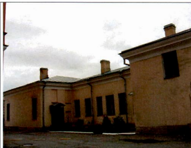
1. Восточный фасад. Общий вид.
