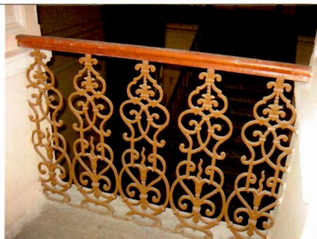
16. Ограждение лестницы северной части здания. Фрагмент.
