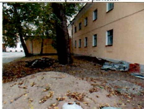
4. Восточный фасад. Фрагмент.
