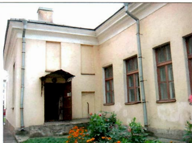
2. Фрагмент восточного фасада.
