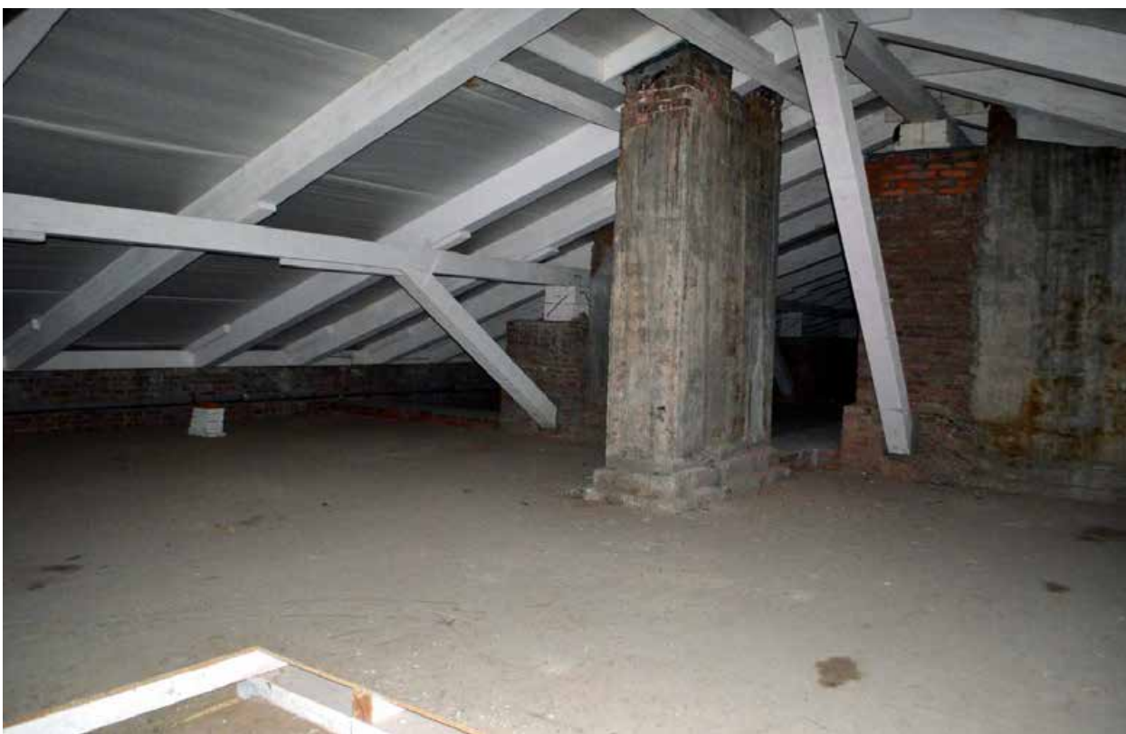
Фото 07. ОКН регионального значения «Духовная академия» (наб. Обводного канала, 7, литер Г). Стропильная система в осях Б-Д/12-16. Съёмка 22.03.2021 г.
