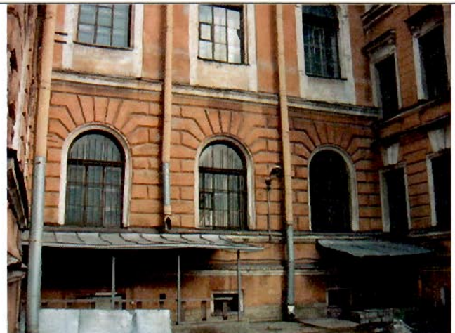
12. Западный фасад. Фрагмент.
