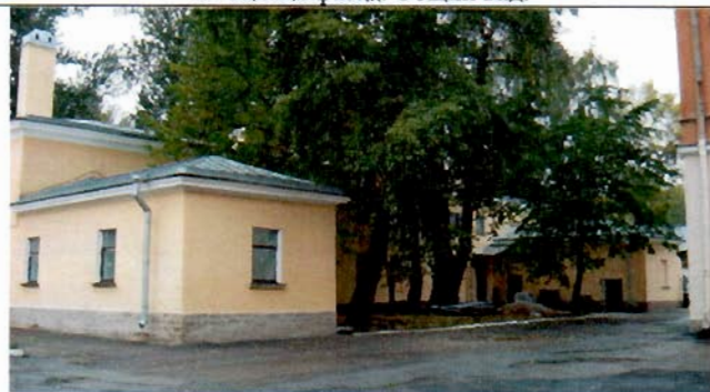
3. Восточный фасад. Общий вид
