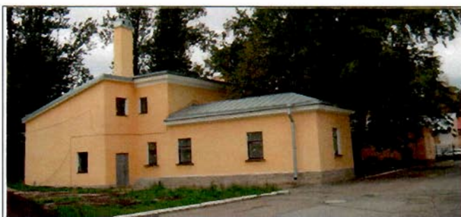
1. Южный фасад. Общий вид.
