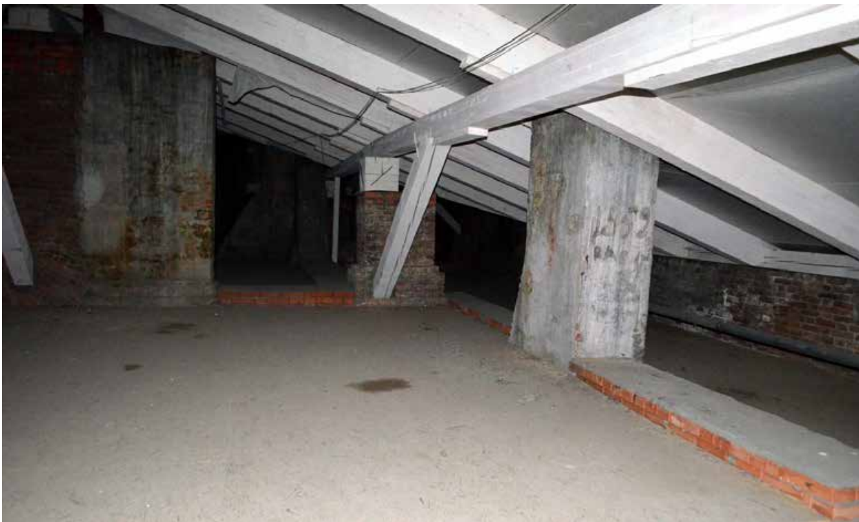
Фото 06. ОКН регионального значения «Духовная академия» (наб. Обводного канала, 7, литер Г). Стропильная система в осях Б-Д/12-16. Съёмка 22.03.2021 г.
