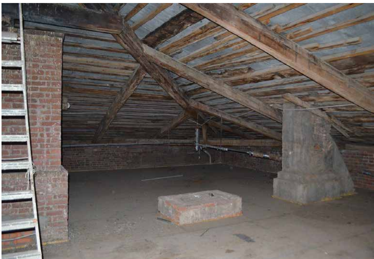
Фото 25. ОКН регионального значения «Духовная академия» (наб. Обводного канала, 7, литер Г). Стропильная система в осях Д-Л/1-5. Съёмка 22.03.2021 г.
