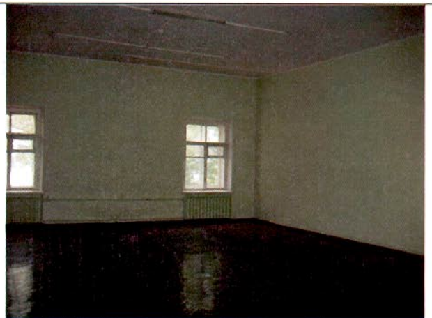
25. Помещения в уровне 2-го этажа. Общий вид.
