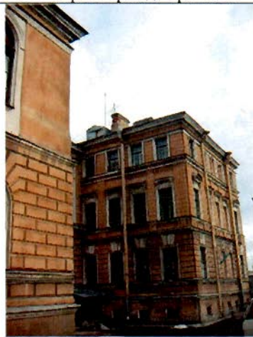
11. Западный фасад. Фрагмент.
