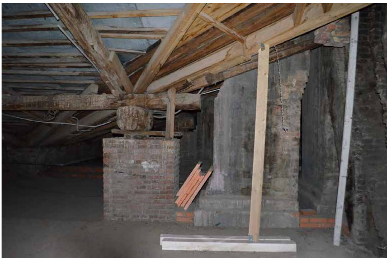
Фото 23. ОКН регионального значения «Духовная академия» (наб. Обводного канала, 7, литер Г). Стропильная система в осях Л-Н/5-7. Съёмка 22.03.2021 г.
