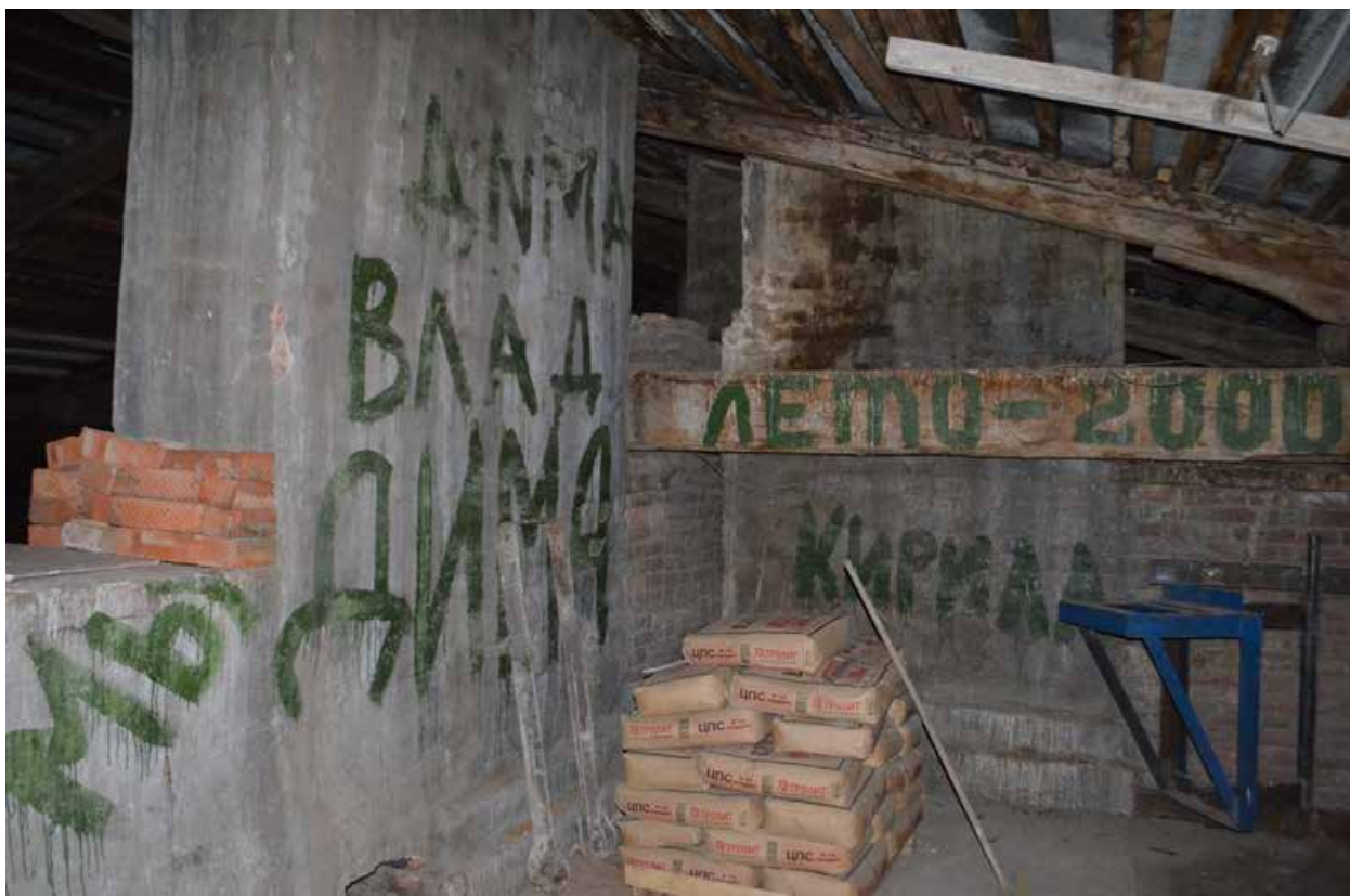
Фото 18. ОКН регионального значения «Духовная академия» (наб. Обводного канала, 7, литер Г). Стропильная система в осях Б-Д/5-10. Съёмка 22.03.2021 г.
