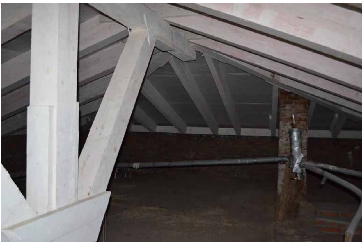
Фото 03. ОКН регионального значения «Духовная академия» (наб. Обводного канала, 7, литер Г). Стропильная система в осях Б-Д/12-16. Съёмка 22.03.2021 г.
