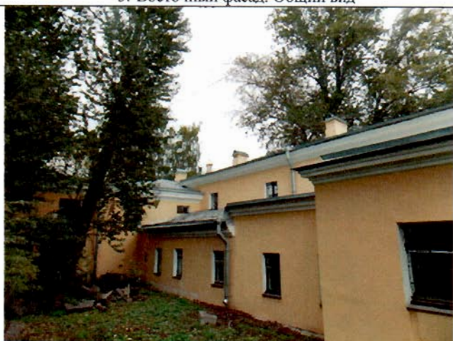
5. Западный фасад. Общий вид.
