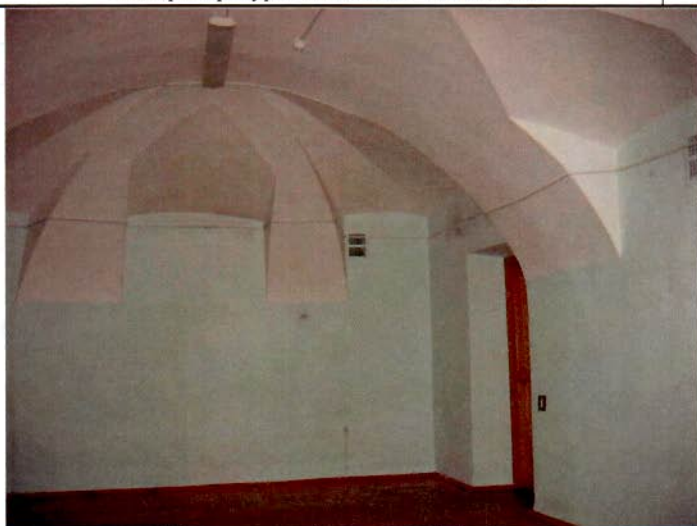
16. Помещения 1-го этажа. Общий вид.
