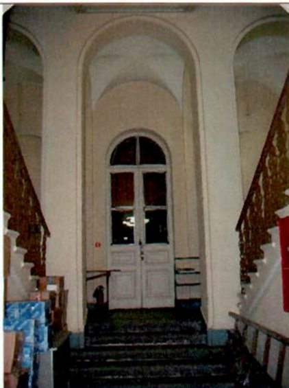
21. Помещение 1-го этажа. Фрагмент.
