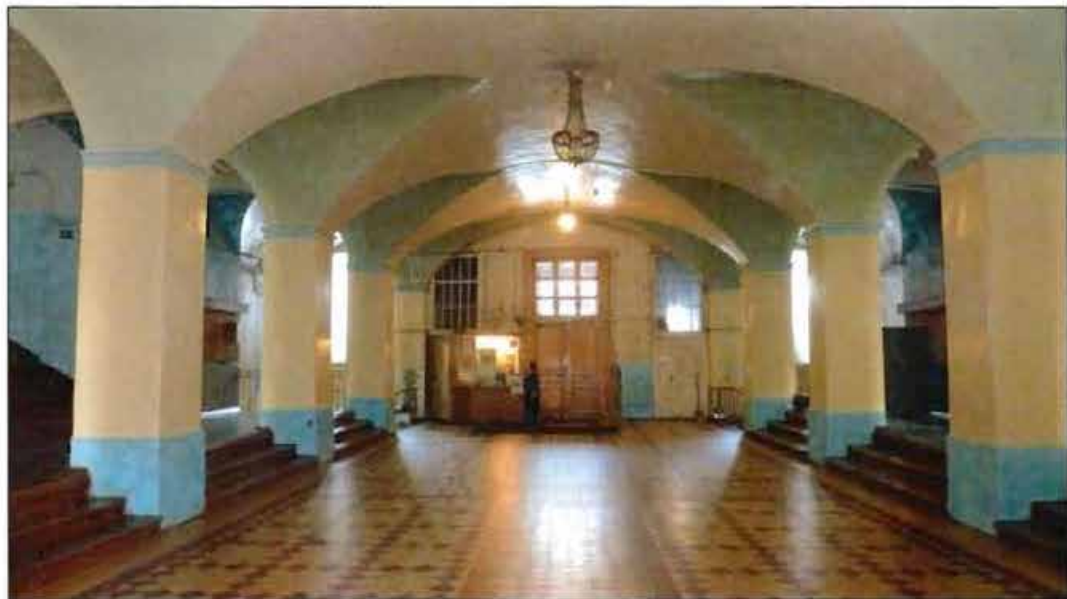
10. Вестибюль (пом. 3-Н (2)).
