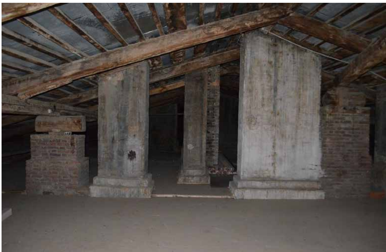
Фото 21. ОКН регионального значения «Духовная академия» (наб. Обводного канала, 7, литер Г). Стропильная система в осях Л-Н/5-7. Съёмка 22.03.2021 г.
