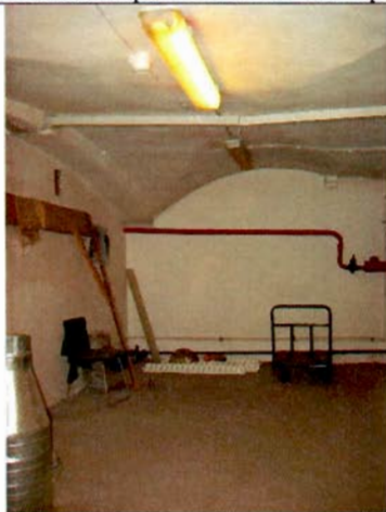
25. Помещение подвала. Общий вид.
