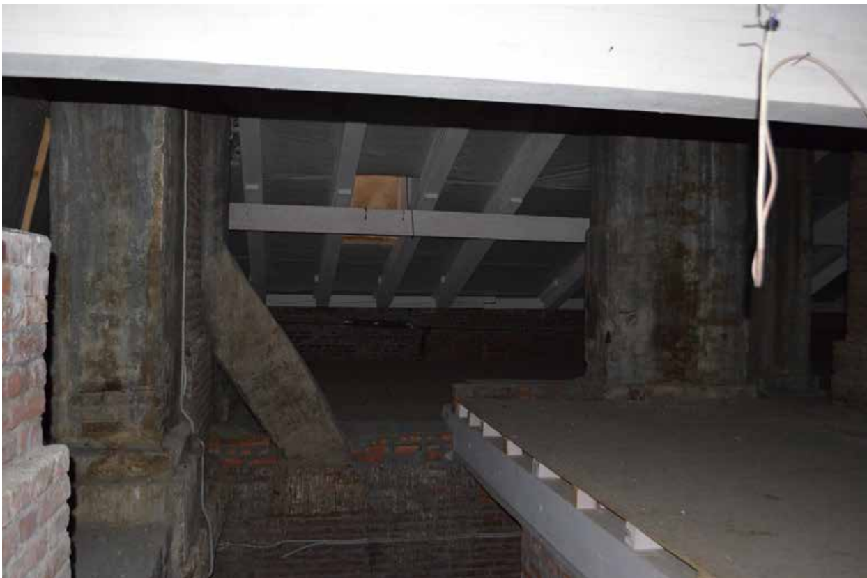
Фото 02. ОКН регионального значения «Духовная академия» (наб. Обводного канала, 7, литер Г). Чердачное перекрытие в осях И-Л/18-19. Съёмка 22.03.2021 г.
