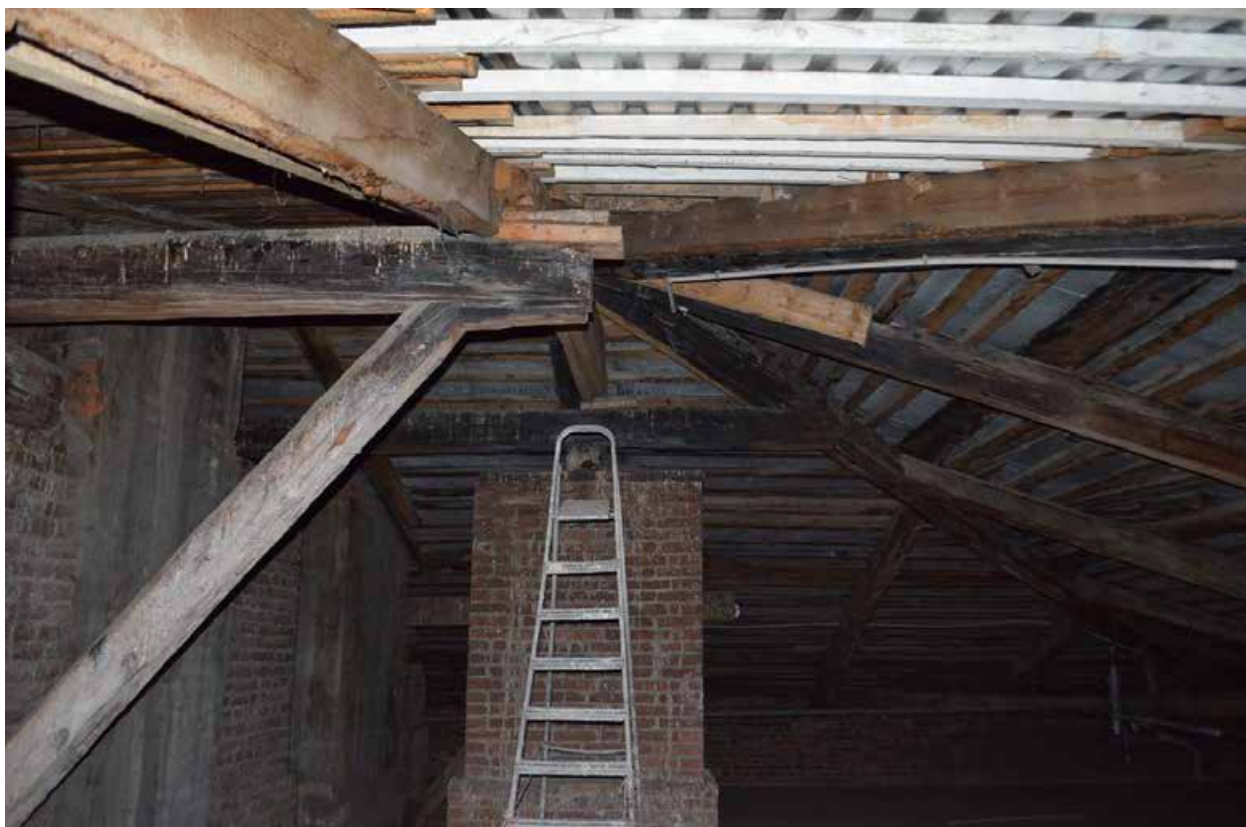
Фото 24. ОКН регионального значения «Духовная академия» (наб. Обводного канала, 7, литер Г). Стропильная система в осях Д-Л/1-5. Съёмка 22.03.2021 г.
