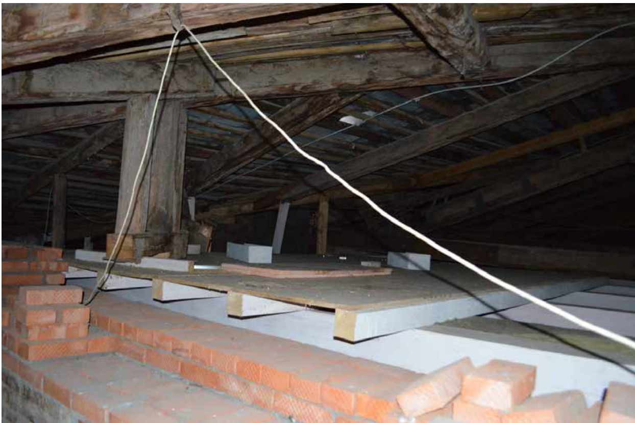
Фото 14. ОКН регионального значения «Духовная академия» (наб. Обводного канала, 7, литер Г). Стропильная система в осях Б-Д/1-5. Съёмка 22.03.2021 г.
