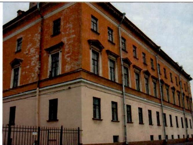
1. Южный фасад. Общий вид
