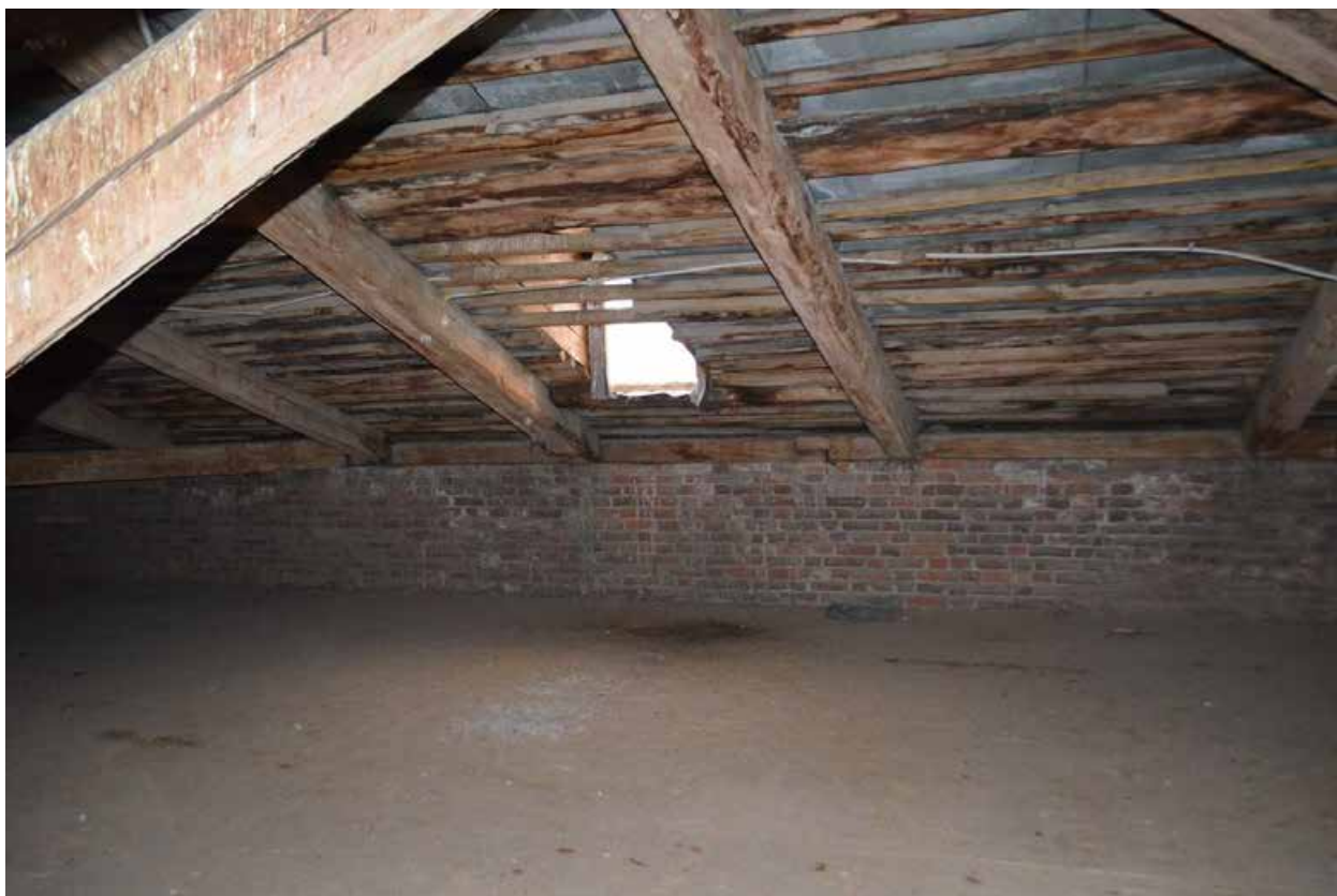
Фото 16. ОКН регионального значения «Духовная академия» (наб. Обводного канала, 7, литер Г). Стропильная система в осях Д-Л/1-5. Съёмка 22.03.2021 г.
