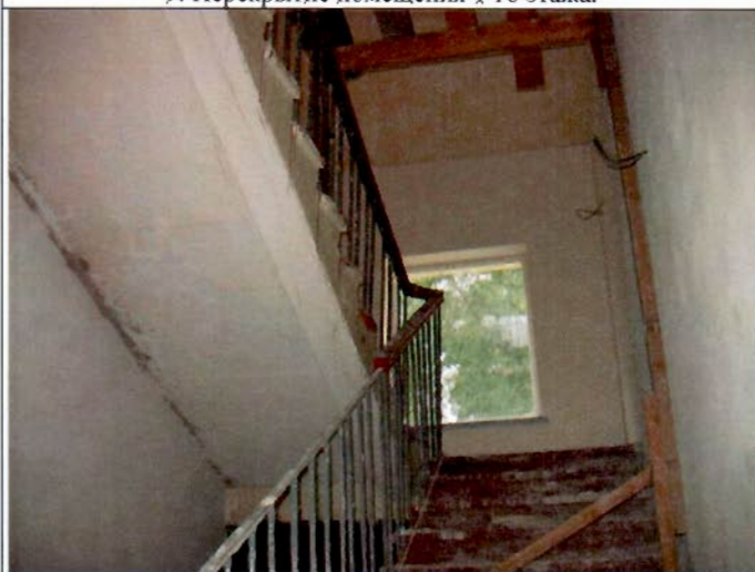
11. Лестницы. Общий вид.
