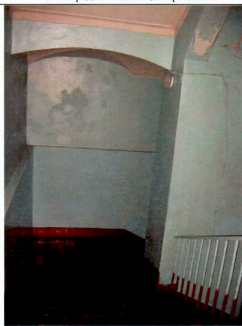
39. Лестница в южном крыле. Фрагмент.
