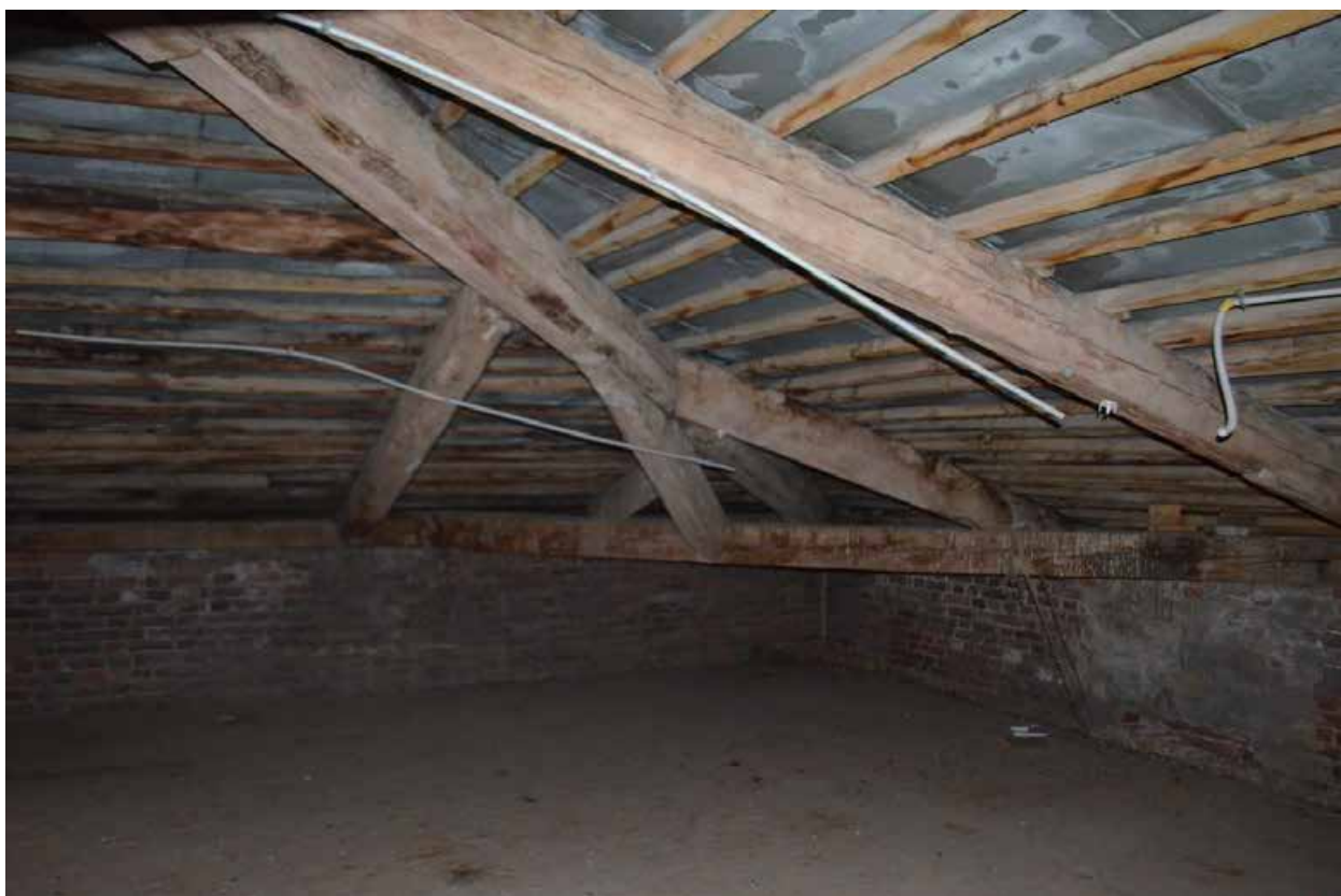
Фото 17. ОКН регионального значения «Духовная академия» (наб. Обводного канала, 7, литер Г). Стропильная система в осях Б-Д/1-5. Съёмка 22.03.2021 г.
