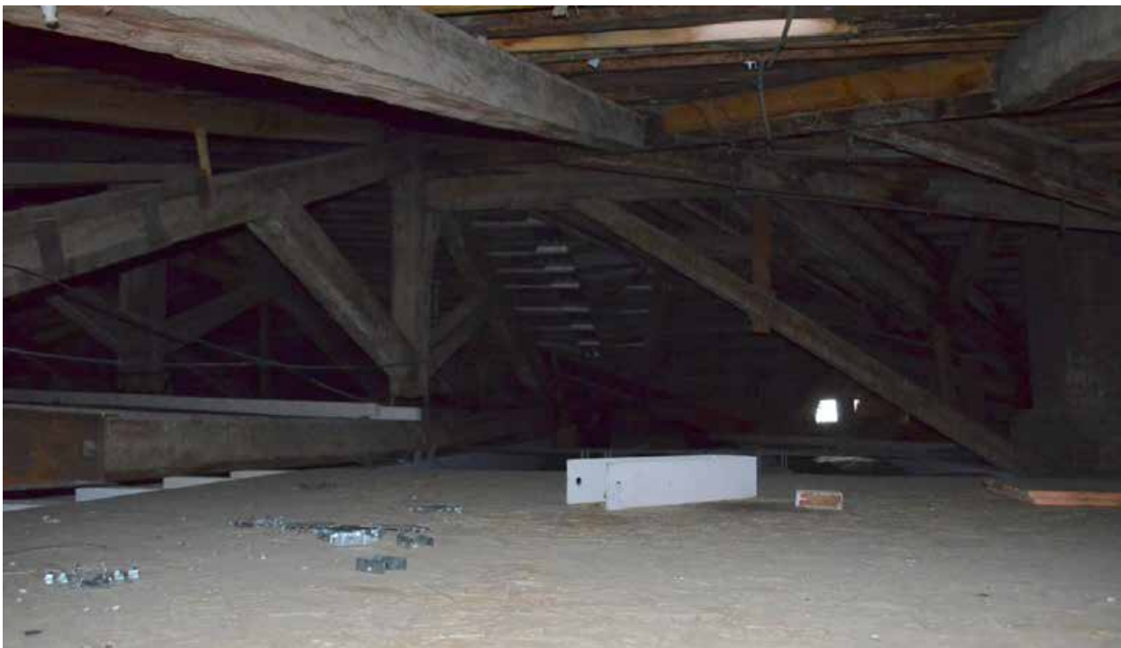
Фото 12. ОКН регионального значения «Духовная академия» (наб. Обводного канала, 7, литер Г). Стропильная система в осях Б-Д/1-5. Съёмка 22.03.2021 г.
