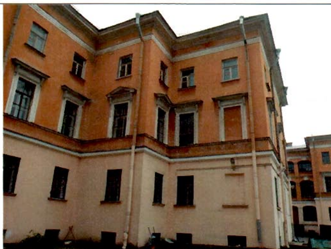
12. Дворовые фасады северного флигеля.
