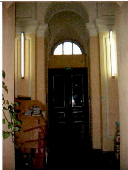
22. Помещение 1-го этажа. Фрагмент.
