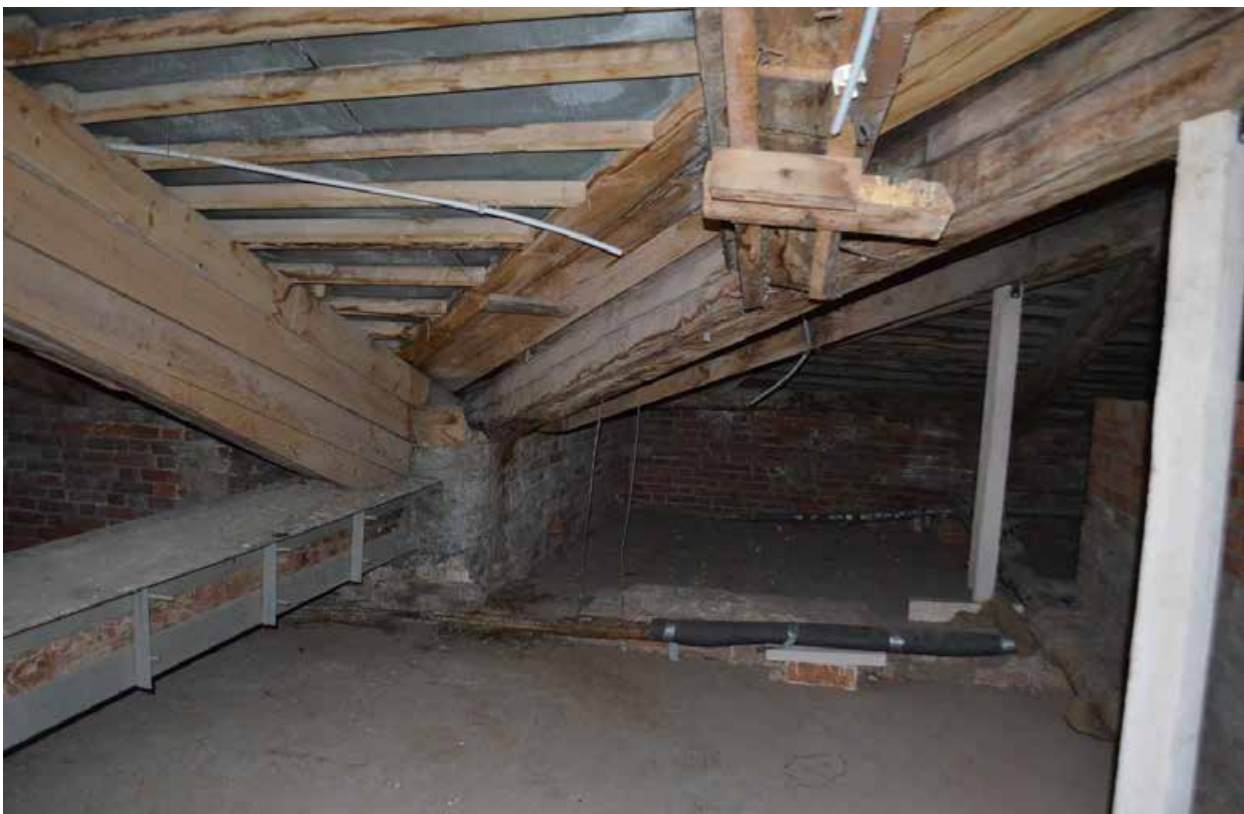
Фото 15. ОКН регионального значения «Духовная академия» (наб. Обводного канала, 7, литер Г). Стропильная система в осях Д-Л/1-5. Съёмка 22.03.2021 г.
