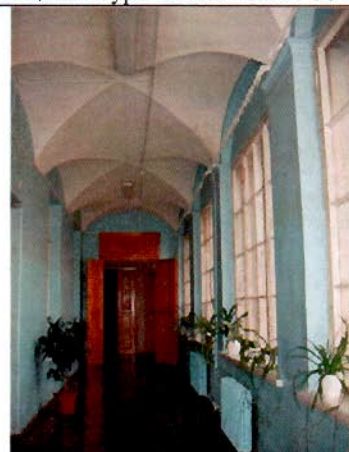
27. Коридор в уровне 2-го этажа. Общий вид.
