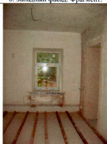
8. Помещение 1-го этажа. Общий вид.
