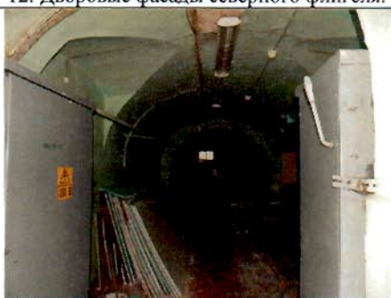
14. Коридор в уровне подвала. Общий вид.
