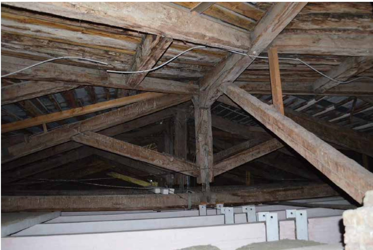
Фото 13. ОКН регионального значения «Духовная академия» (наб. Обводного канала, 7, литер Г). Стропильная система в осях Б-Д/3-10. Съёмка 22.03.2021 г.
