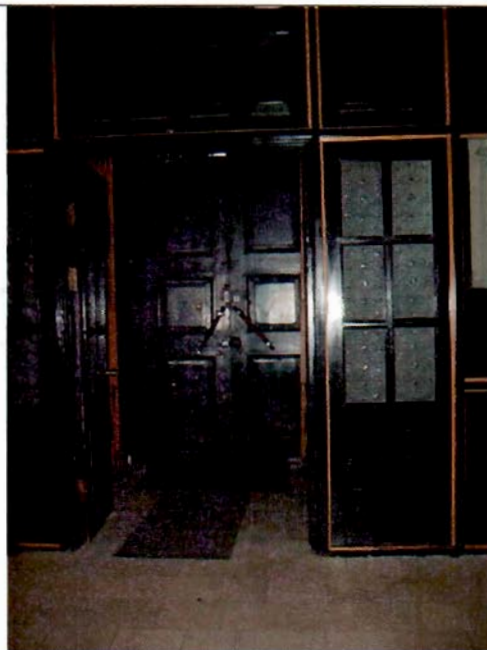
8. Помещение 1-го этажа.
