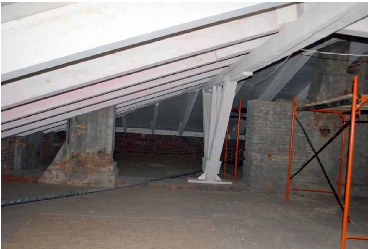
Фото 04. ОКН регионального значения «Духовная академия» (наб. Обводного канала, 7, литер Г). Стропильная система в осях Б-Д/12-16. Съёмка 22.03.2021 г.
