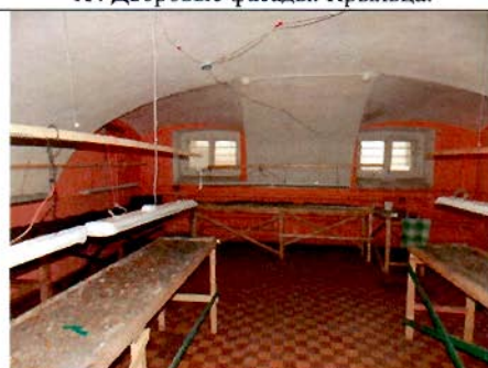
15. Помещение в уровне подвала. Общий вид.
