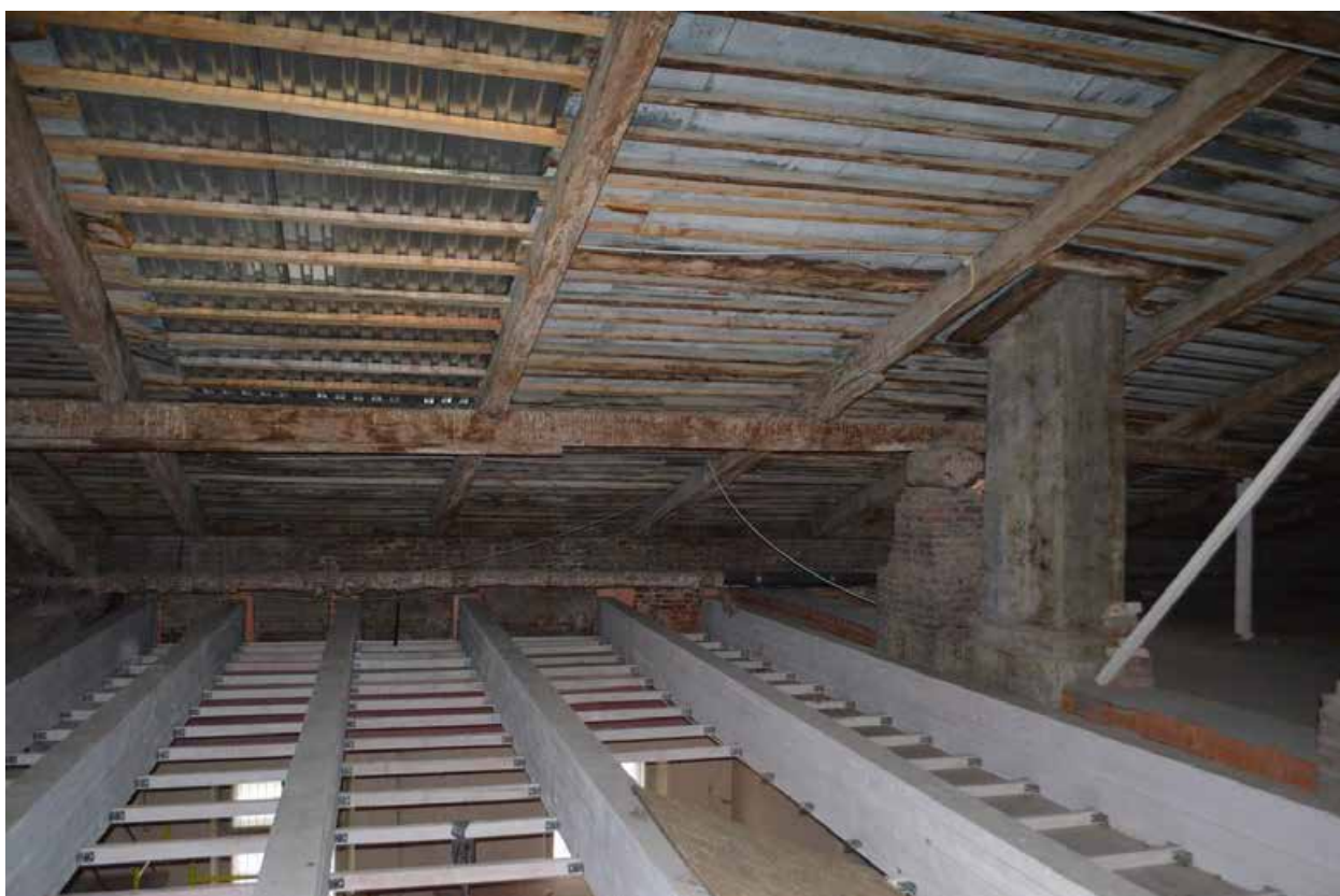
Фото 19. ОКН регионального значения «Духовная академия» (наб. Обводного канала, 7, литер Г). Стропильная система в осях Б-Д/10-12. Съёмка 22.03.2021 г.
