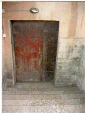
7. Входной проем восточного фасада. Общий вид.
