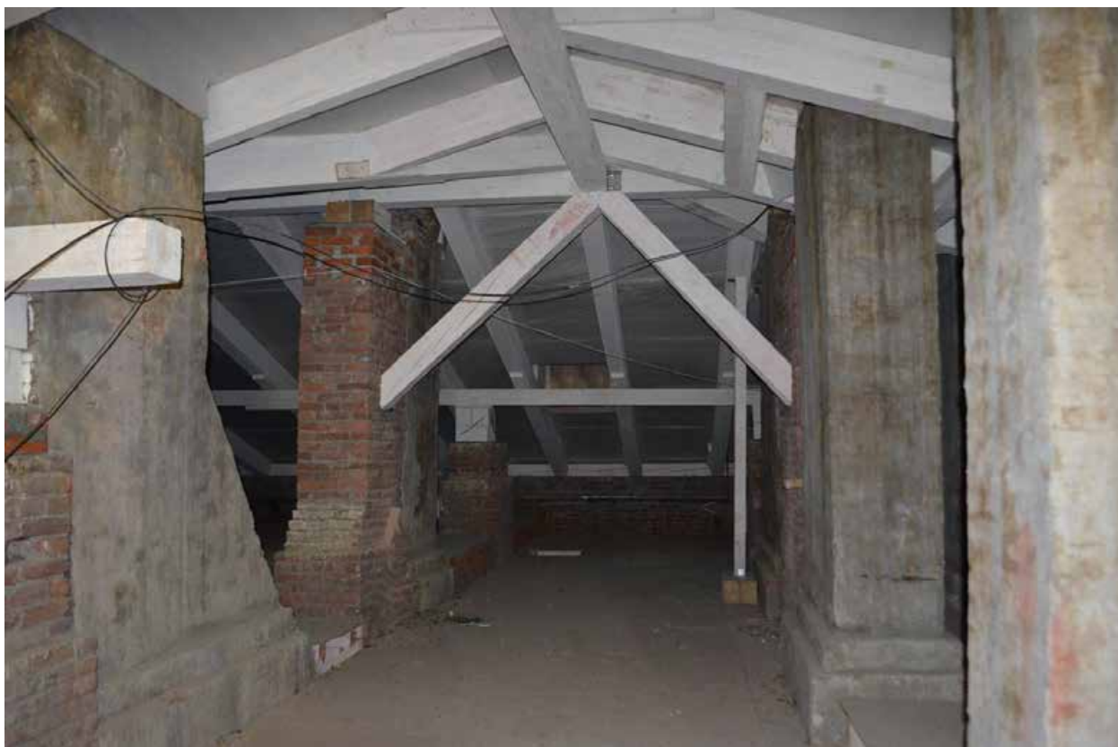
Фото 08. ОКН регионального значения «Духовная академия» (наб. Обводного канала, 7, литер Г). Стропильная система в осях Б-Д/16-20. Съёмка 22.03.2021 г.
