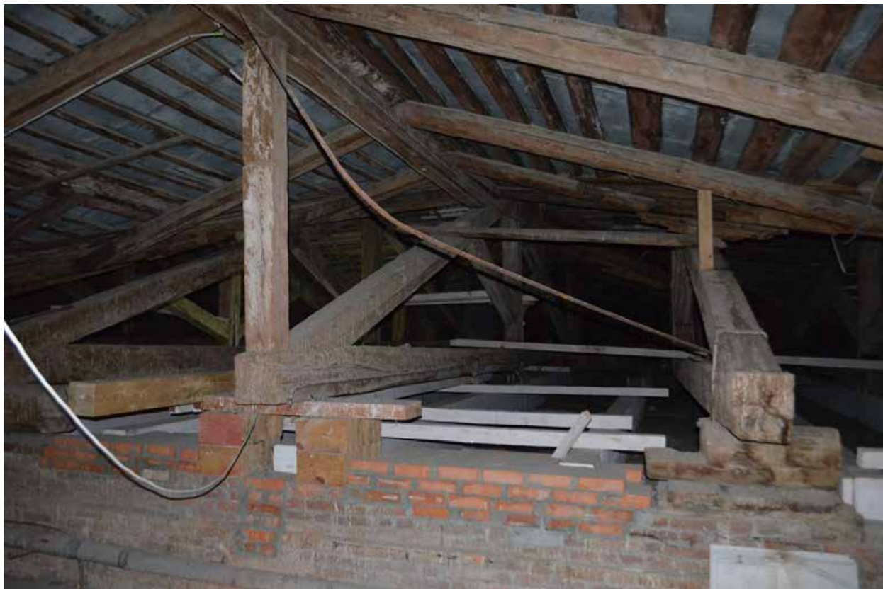
Фото 10. ОКН регионального значения «Духовная академия» (наб. Обводного канала, 7, литер Г). Стропильная система в осях Л-Н/1-5. Съёмка 22.03.2021 г.
