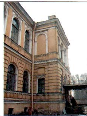
8. Северный фасад. Фрагмент.
