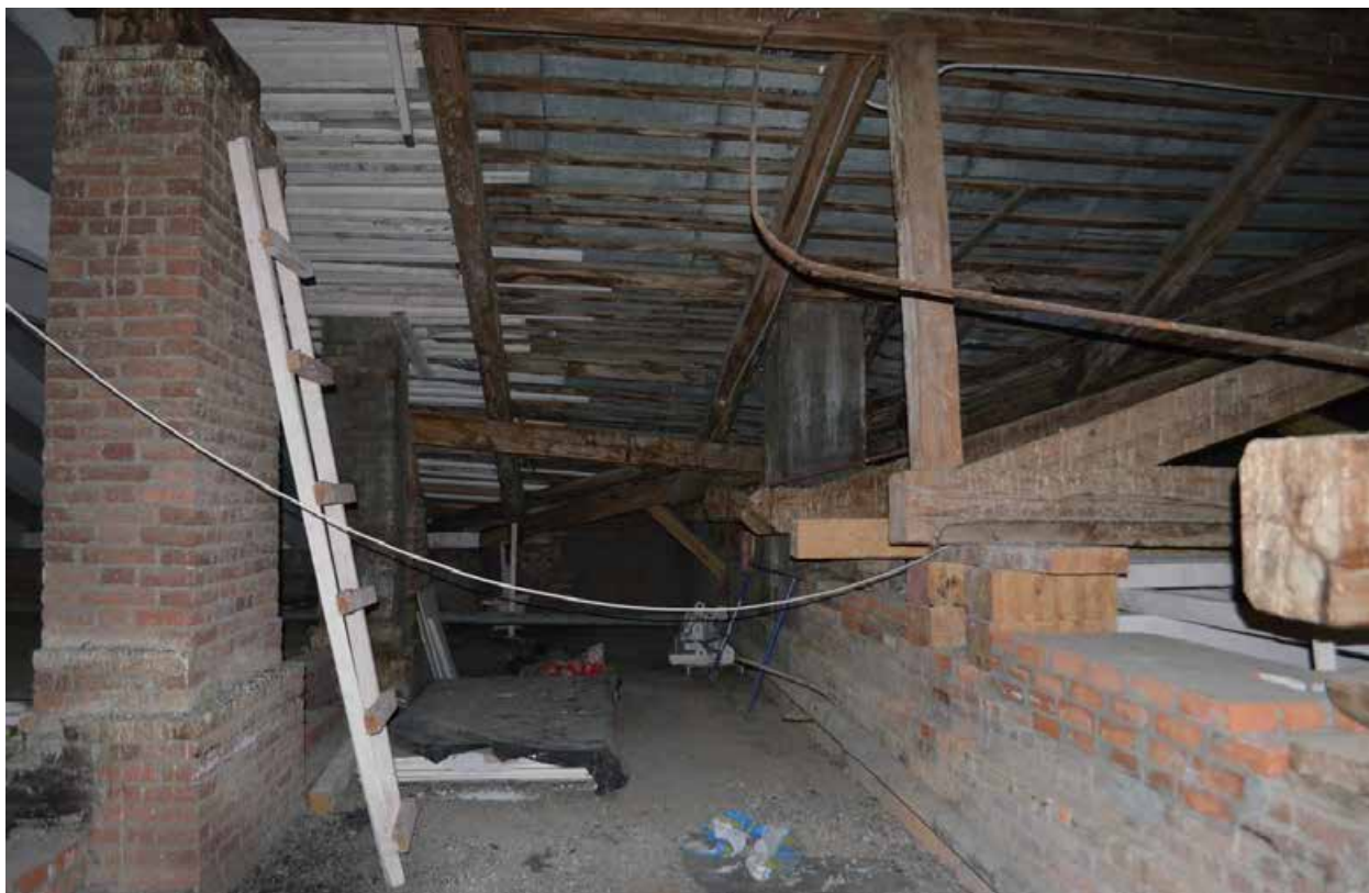
Фото 11. ОКН регионального значения «Духовная академия» (наб. Обводного канала, 7, литер Г). Стропильная система в осях Л-Н/1-5. Съёмка 22.03.2021 г.
