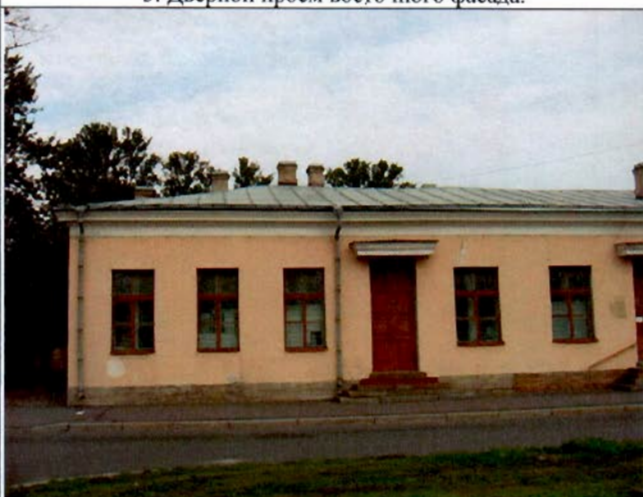
5. Южный фасад. Общий вид.
