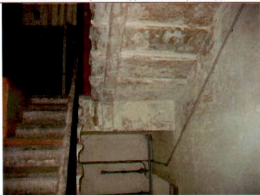
27. Лестница в западной части здания. Общий вид.
