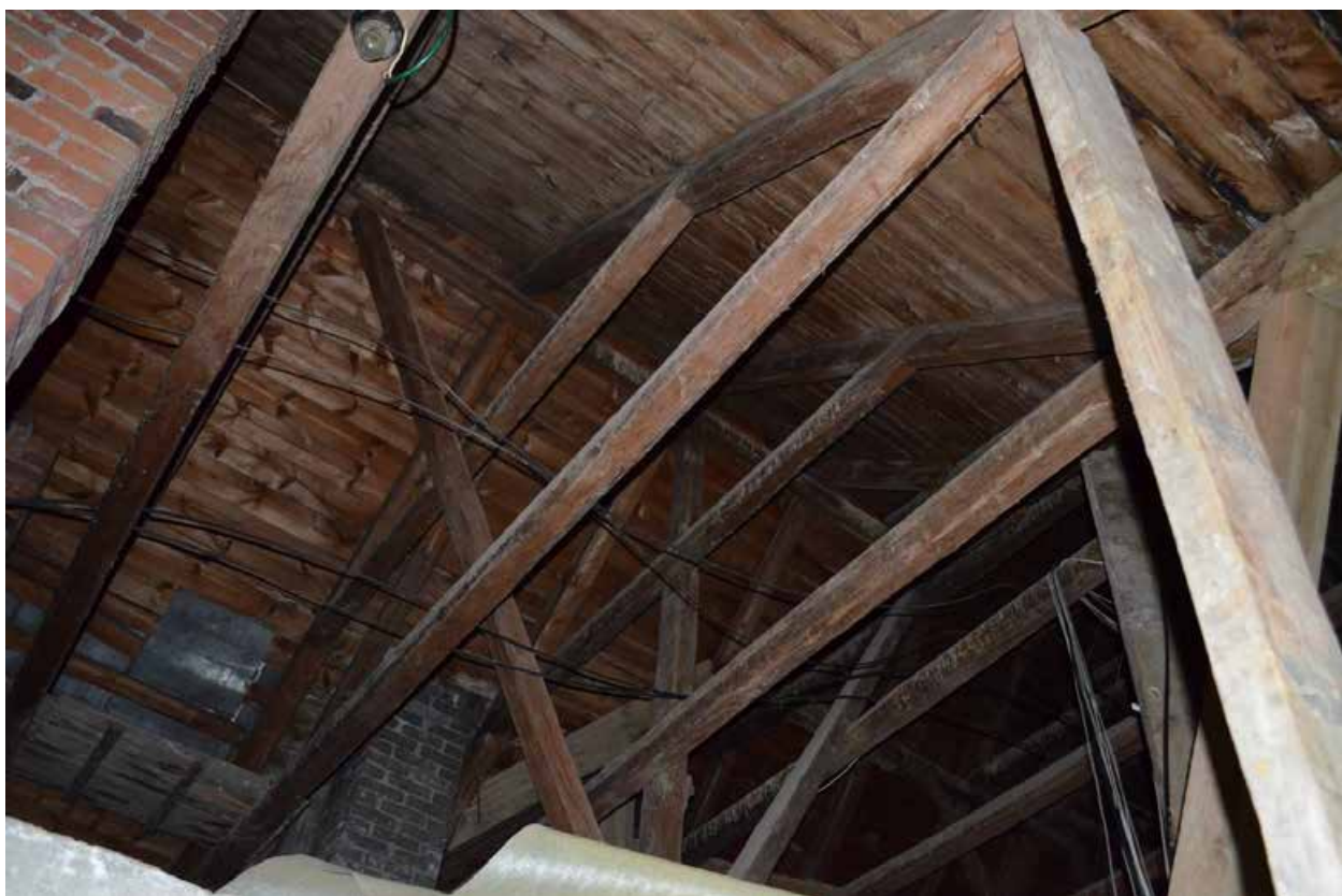
Фото 01. ОКН регионального значения «Духовная академия» (наб. Обводного канала, 7, литер Г). Чердачное перекрытие в осях И-Л/2-5. Съёмка 22.03.2021 г.
