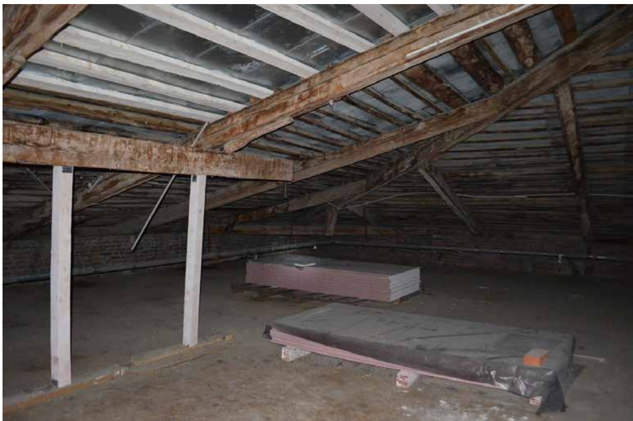
Фото 22. ОКН регионального значения «Духовная академия» (наб. Обводного канала, 7, литер Г). Стропильная система в осях Л-Н/5-7. Съёмка 22.03.2021 г.
