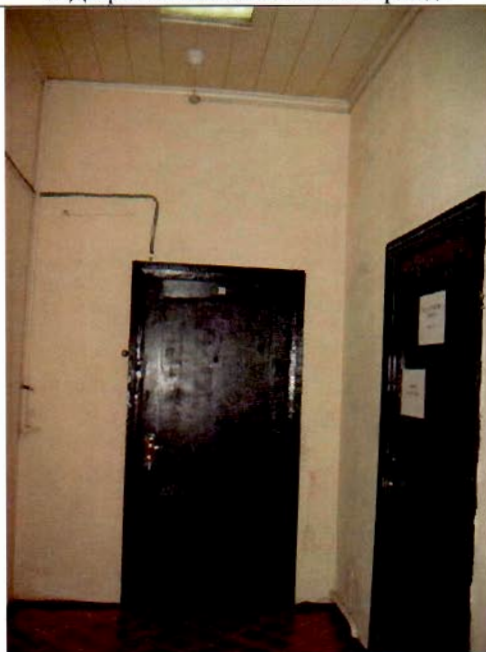
9. Коридор 1-го этажа.
