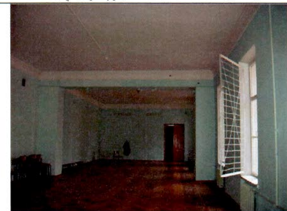
28. Помещение 2-го этажа. Общий вид.
