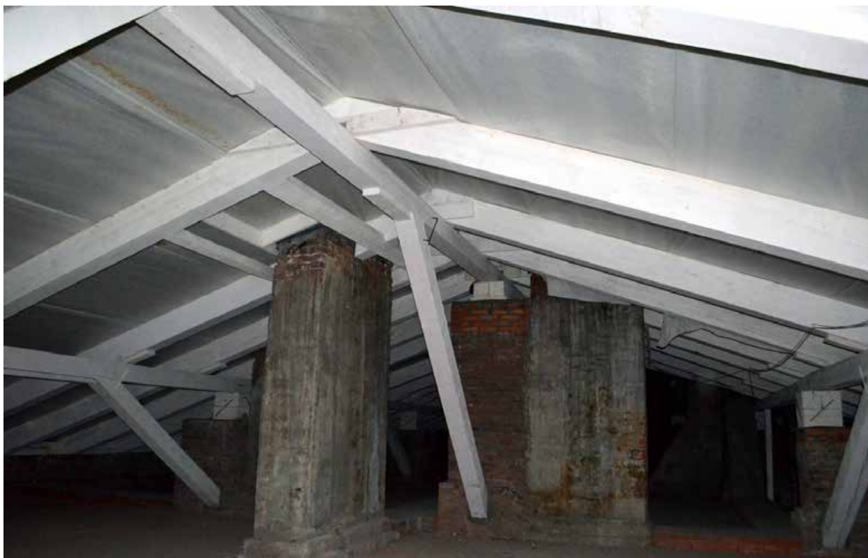
Фото 05. ОКН регионального значения «Духовная академия» (наб. Обводного канала, 7, литер Г). Стропильная система в осях Б-Д/12-16. Съёмка 22.03.2021 г.
