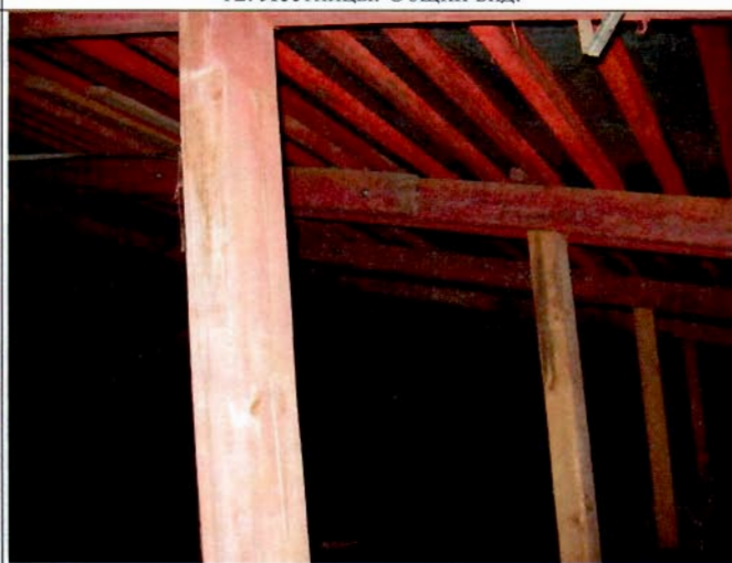
14. Конструкции крыши. Общий вид.
