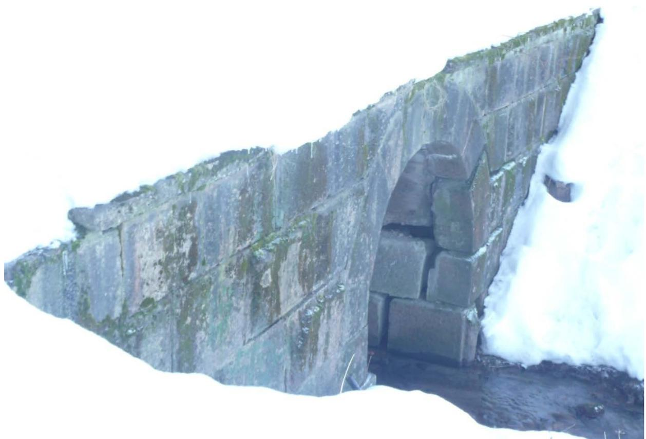
Фото 16. Смещение камней облицовки свода. Вид с низовой стороны моста.
