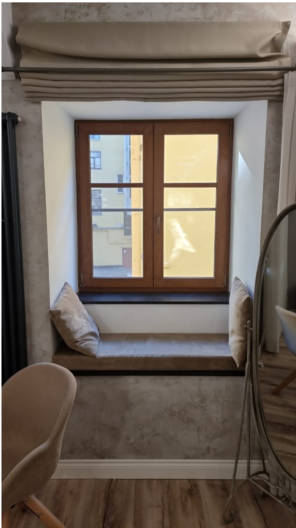
Фото №8. Оконное заполнение. Помещение квартиры № 46, расположенной в выявленном объекте культурного наследия «Дом Зверкова (И.С. Никитина)» по адресу: г. Санкт-Петербург, Столярный пер., д. 18/69, лит. А. Дата съемки: 15.02.2021г.
