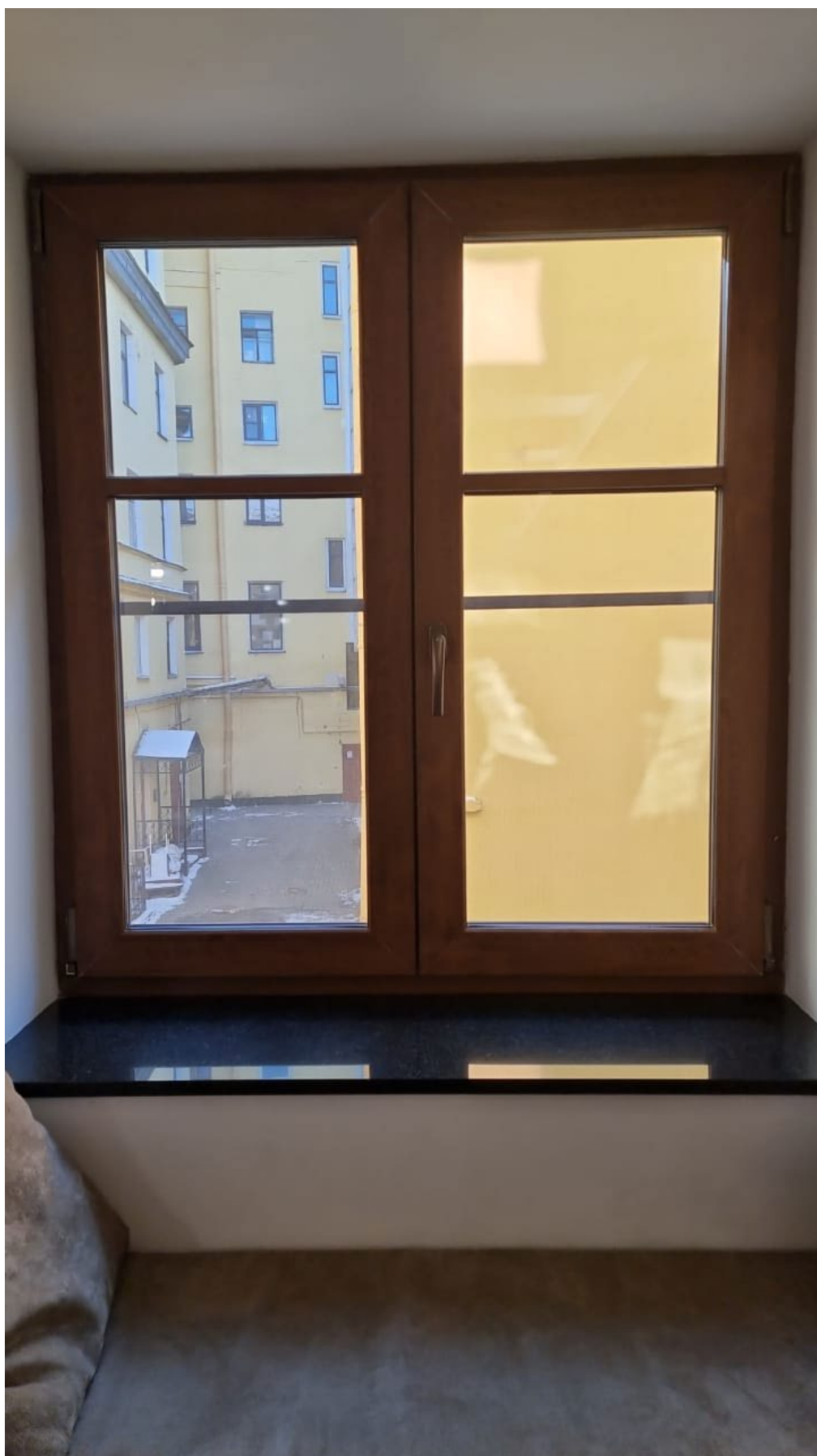
Фото №7. Оконное заполнение. Помещение квартиры № 46, расположенной в выявленном объекте культурного наследия «Дом Зверкова (И.С. Никитина)» по адресу: г. Санкт-Петербург, Столярный пер., д. 18/69, лит. А. Дата съемки: 15.02.2021г.
