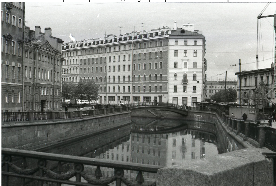
Илл. 4. Вид с Кокушкина моста на канал Грибоедова. 1972 год. [Электронный доступ]: http://www.etomesto.ru .
