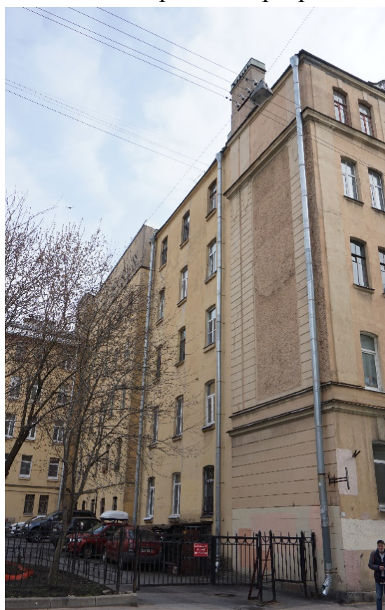
17. Фасад, выходящий в сквер на улице Лизы Чайкиной
