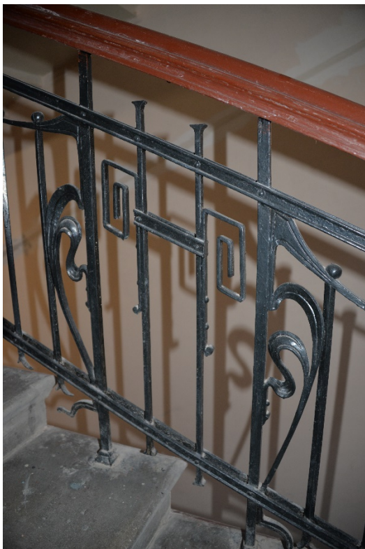
66. Фрагмент ограждения лестницы ЗЛК
