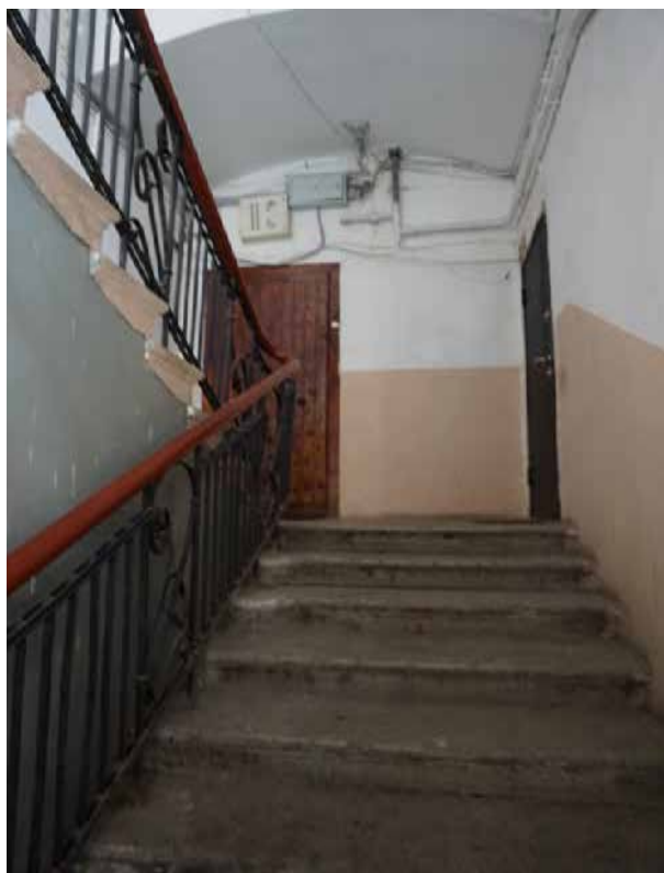
27. Лестница 1ЛК в уровне первого этажа
