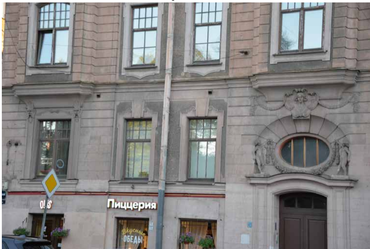
7. Фрагмент фасада, выходящего на Кронверкский проспект, в уровне второго этажа
