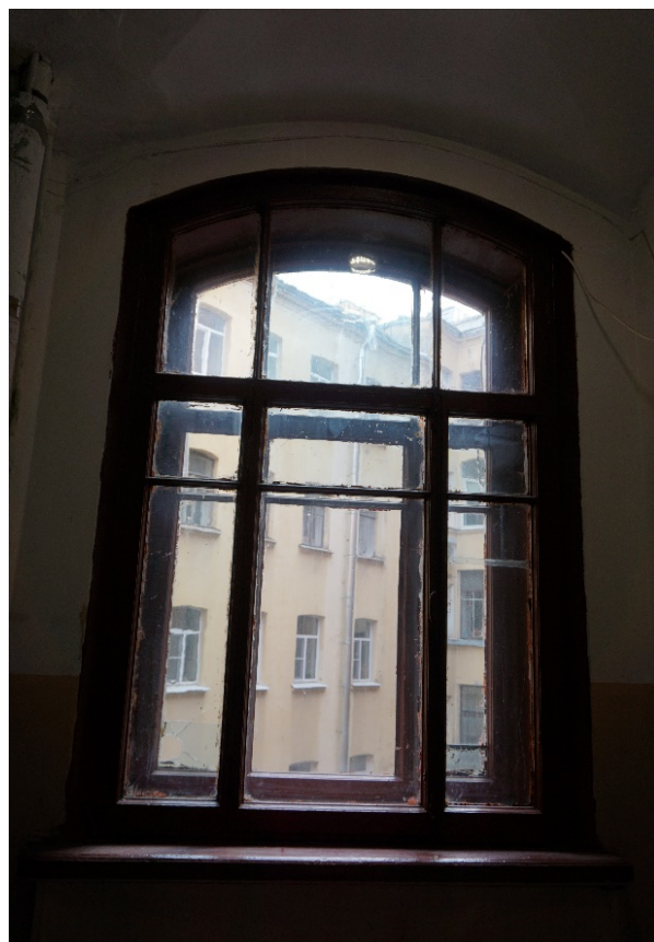
32. Оконный проем на лестнице 1ЛК в уровне третьего этажа
