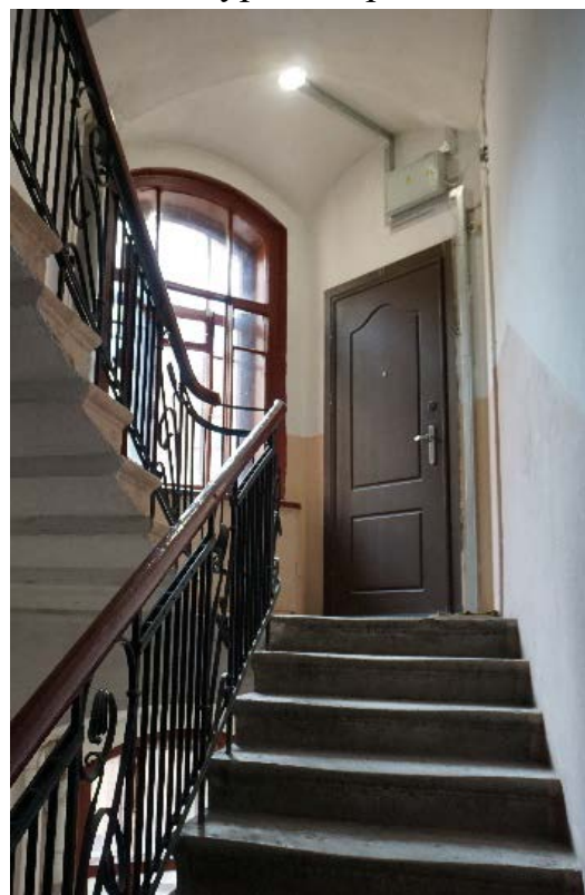
34. Лестница 1ЛК в уровне четвертого этажа
