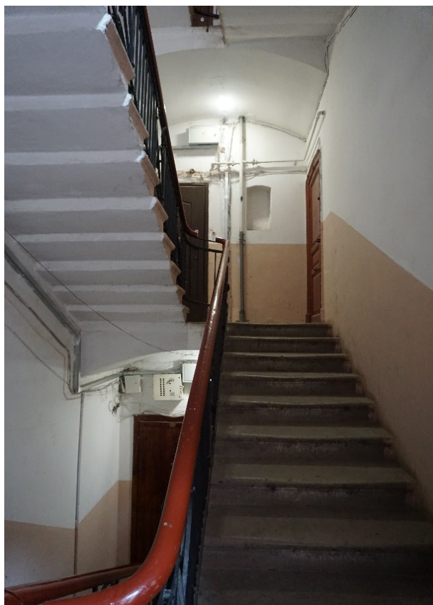
29. Лестница 1ЛК в уровне второго этажа
