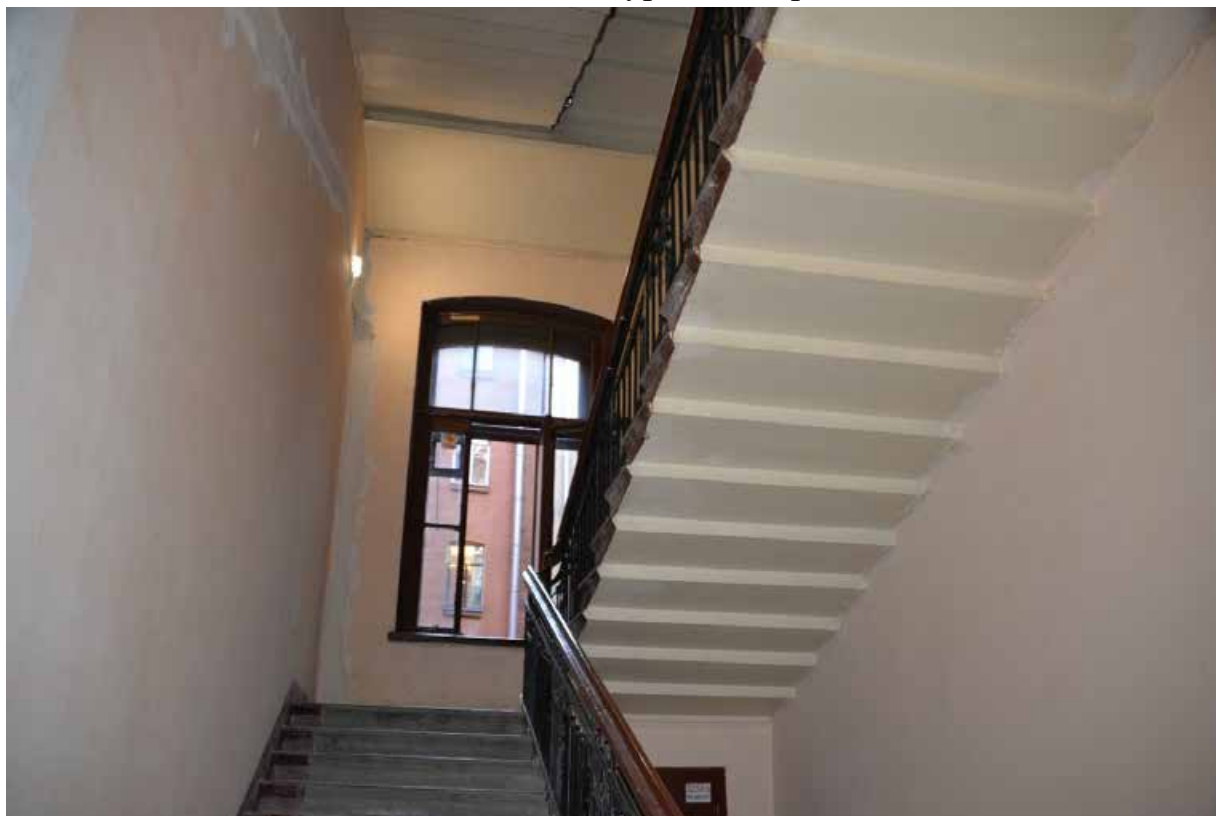
60. Лестница 3ЛК в уровне второго этажа
