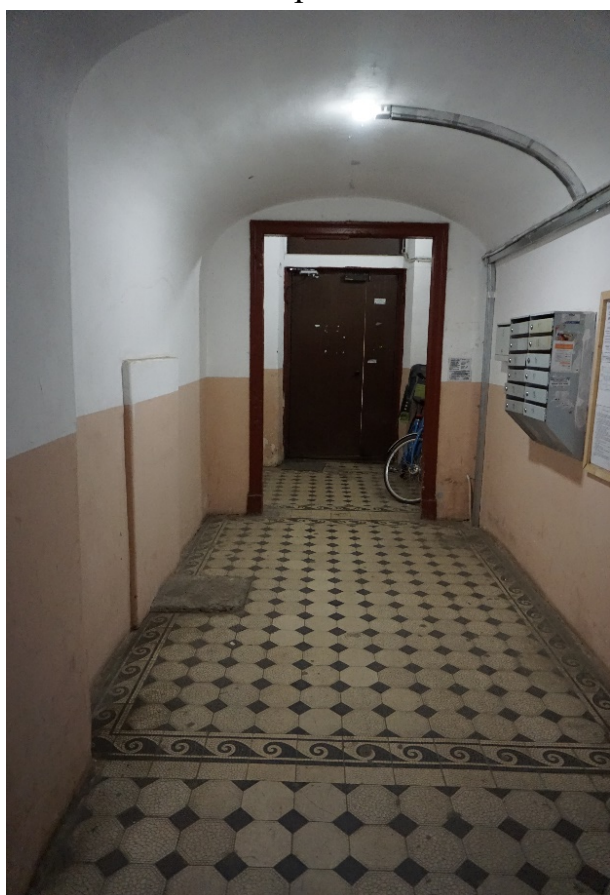
42. Вестибюль лестницы 1ЛК
