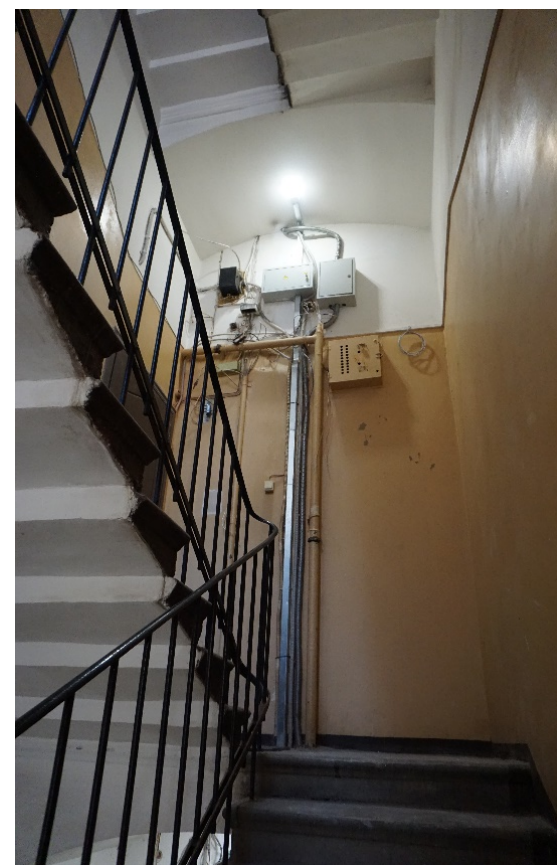
47. Лестница 2ЛК в уровне третьего этажа
