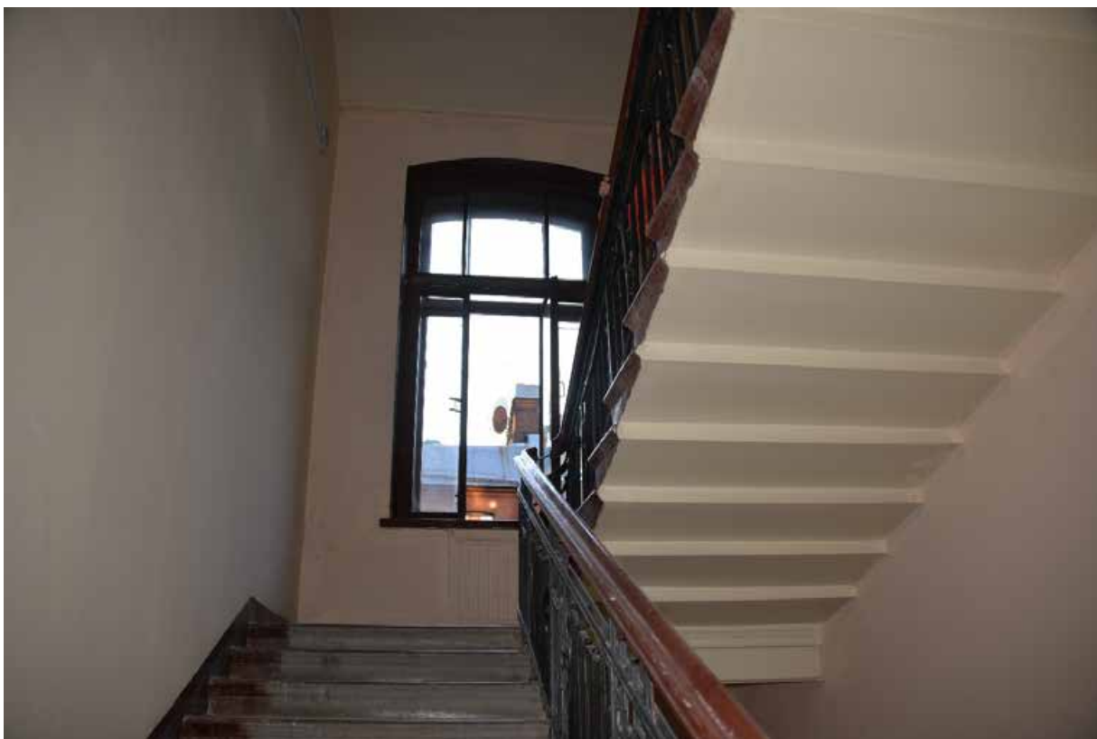
69. Лестница ЗЛК в уровне четвертого этажа
