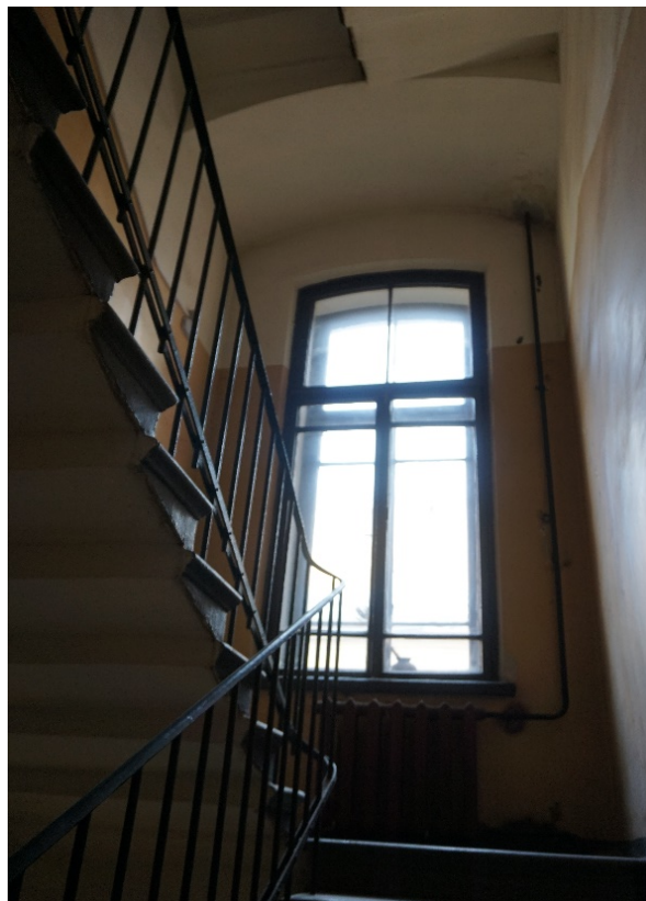
50. Лестница 2ЛК в уровне четвертого этажа
