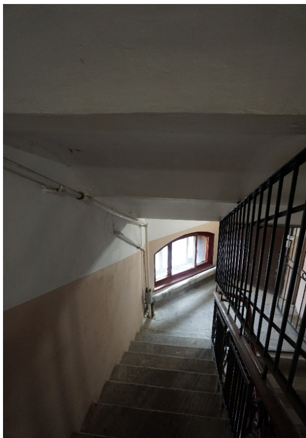
40. Лестница 1ЛК в уровне мансардного этажа
