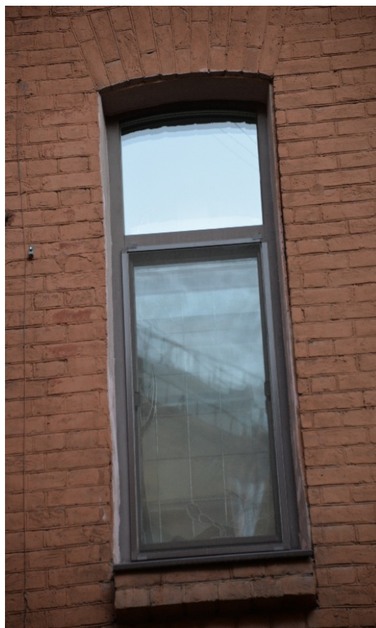
24. Оконный проем на дворовом фасаде
