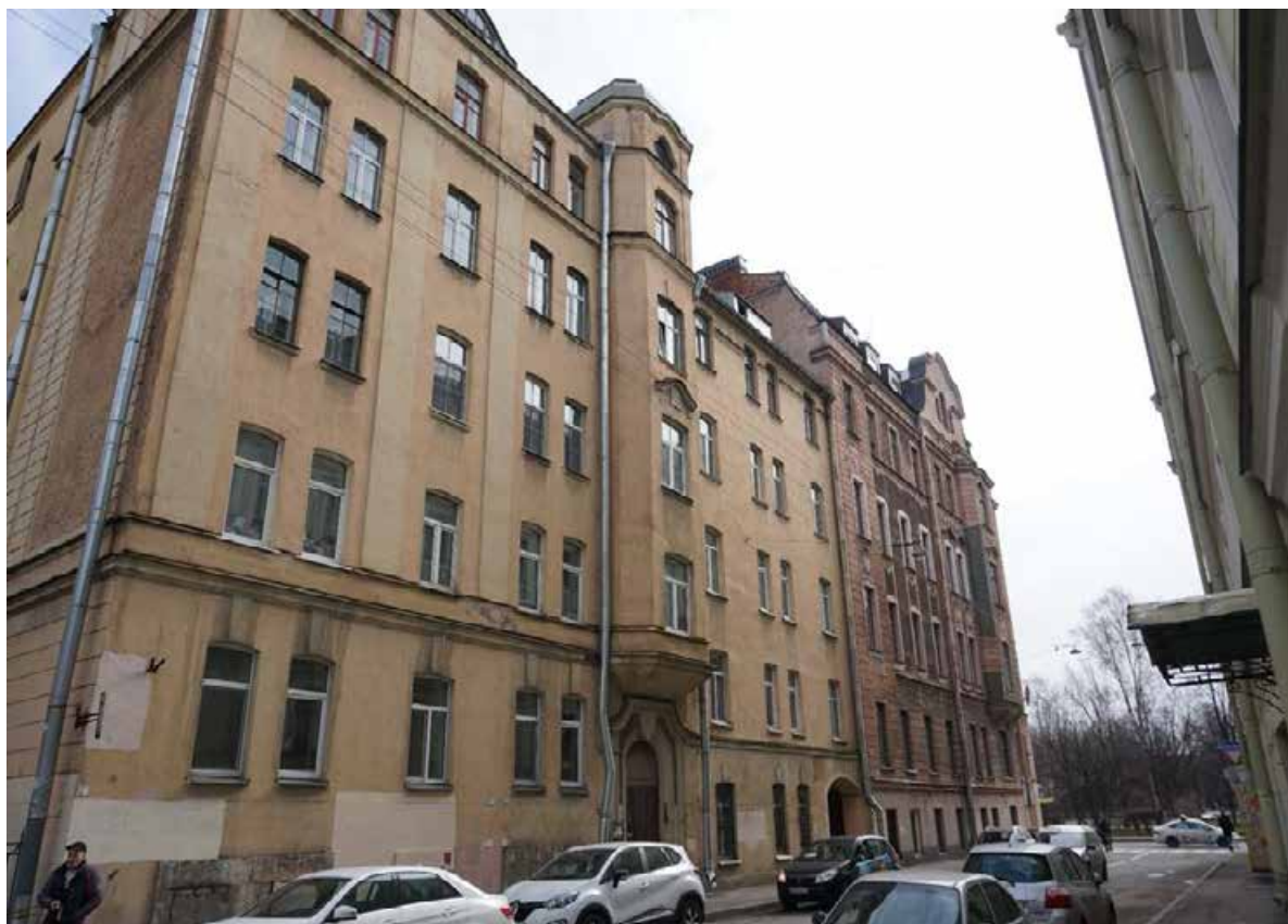
18. Фасад, выходящий на улицу Лизы Чайкиной
