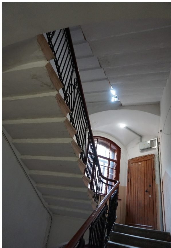
31. Лестница 1ЛК в уровне третьего этажа
