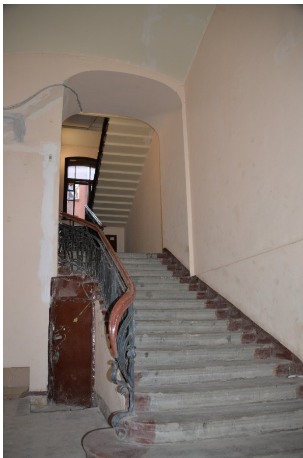
57. Вестибюль лестницы 3ЛК
