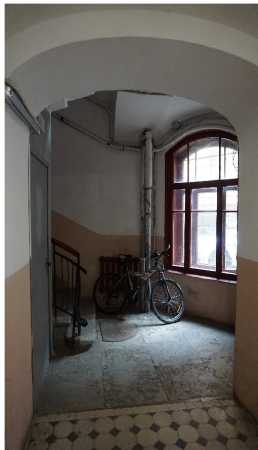
26. Вестибюль лестницы 1ЛК
