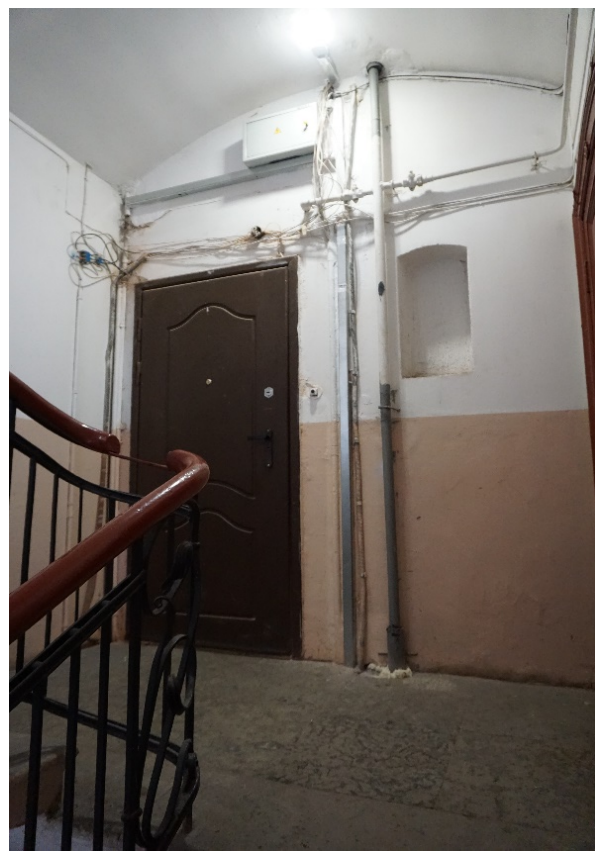
30. Лестница 1ЛК в уровне второго этажа
