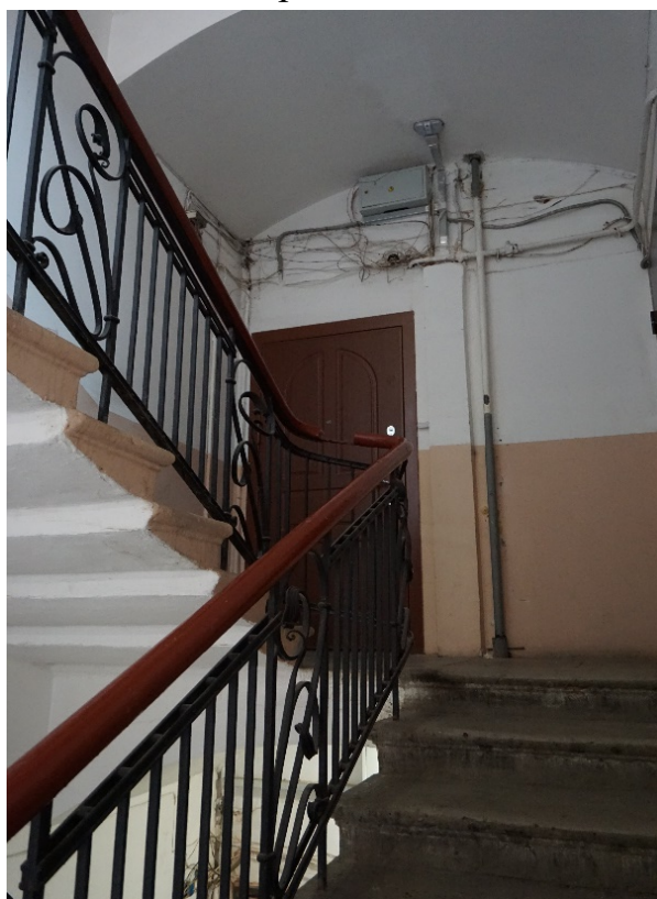
33. Лестница 1ЛК в уровне третьего этажа
