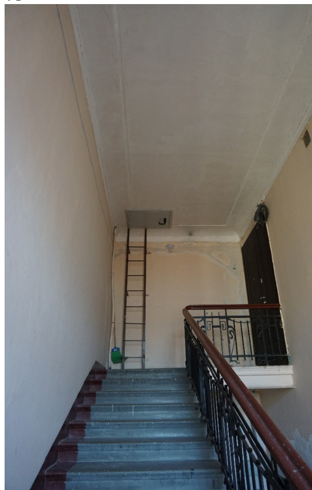
73. Лестница ЗЛК в уровне мансардного этажа
