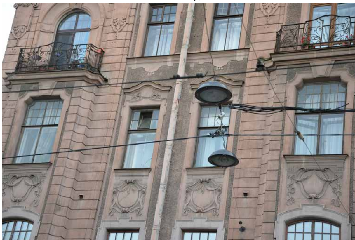
5. Фрагмент фасада, выходящего на Кронверкский проспект, в уровне четвертого этажа
