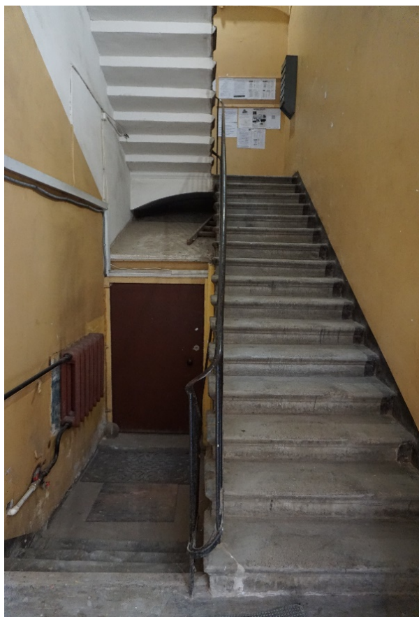
44. Лестница 2ЛК в уровне первого этажа
