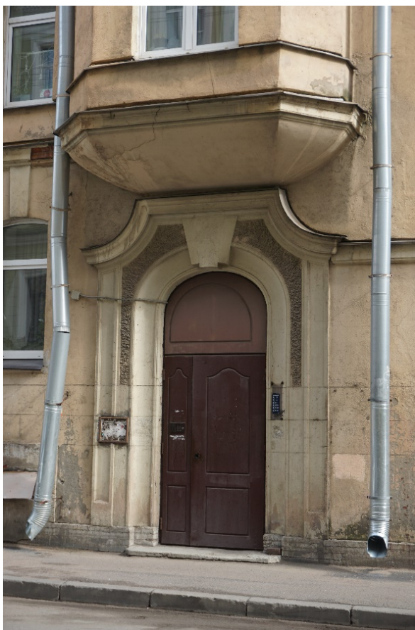
14. Вход на лестницу 1ЛК
