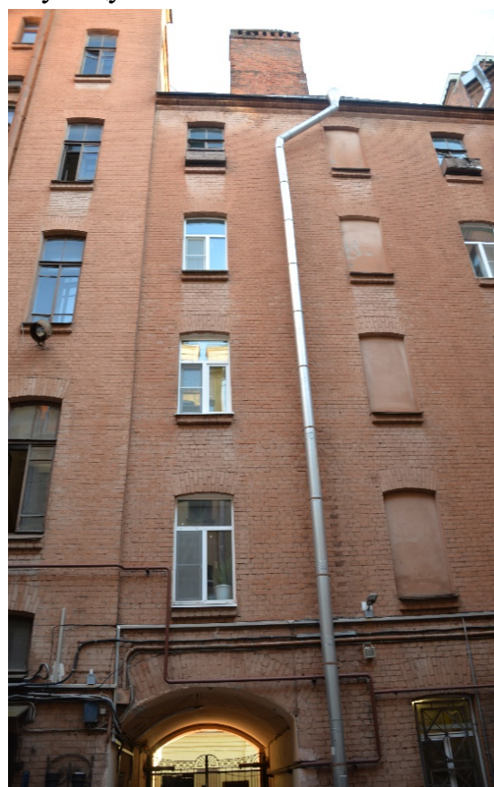
22. Фрагмент дворового фасада
