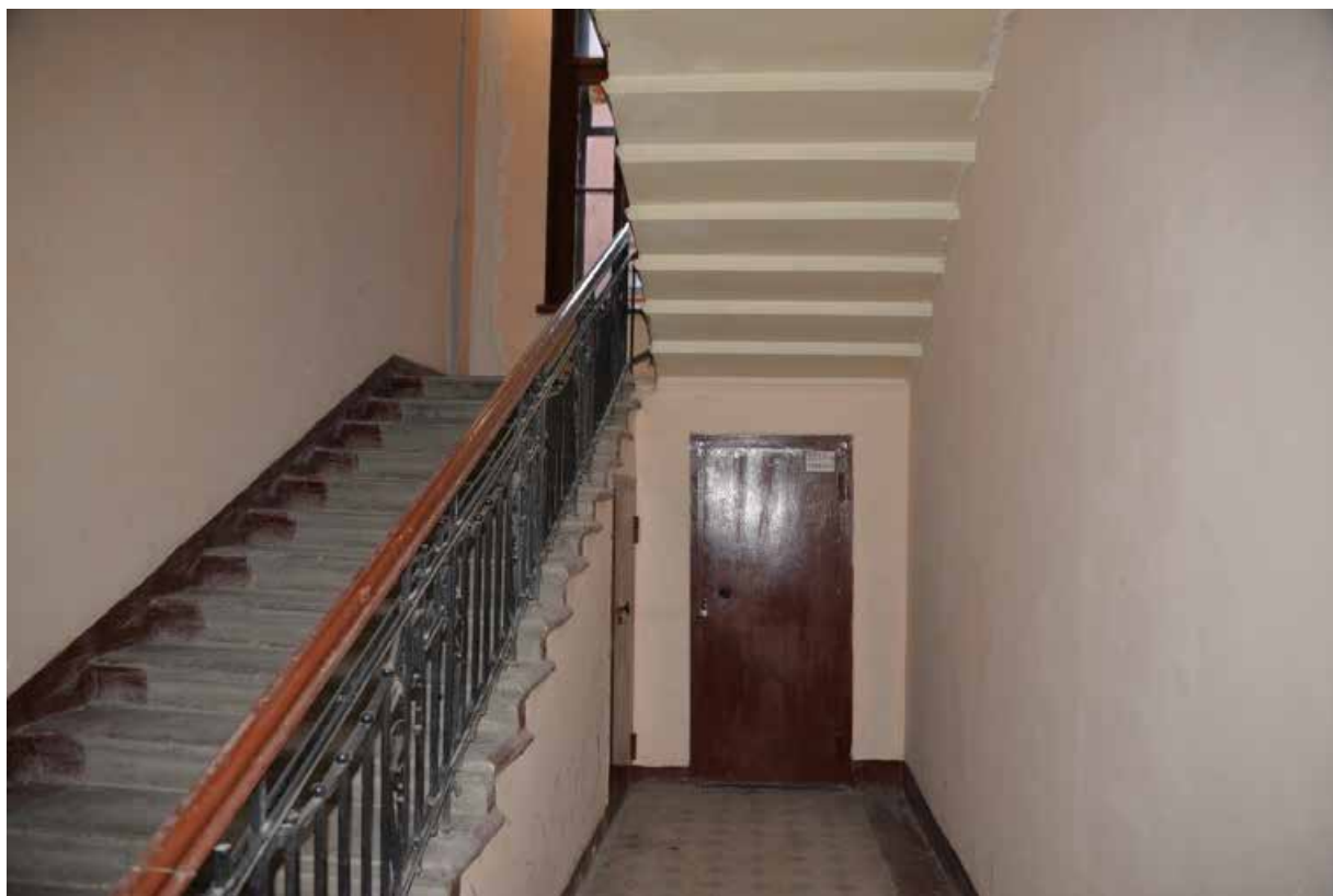
59. Лестница 3ЛК в уровне второго этажа
