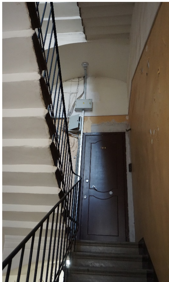
49. Лестница 2ЛК в уровне четвертого этажа
