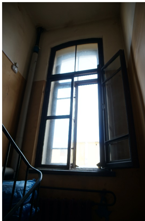
53. Лестница 2ЛК в уровне пятого этажа
