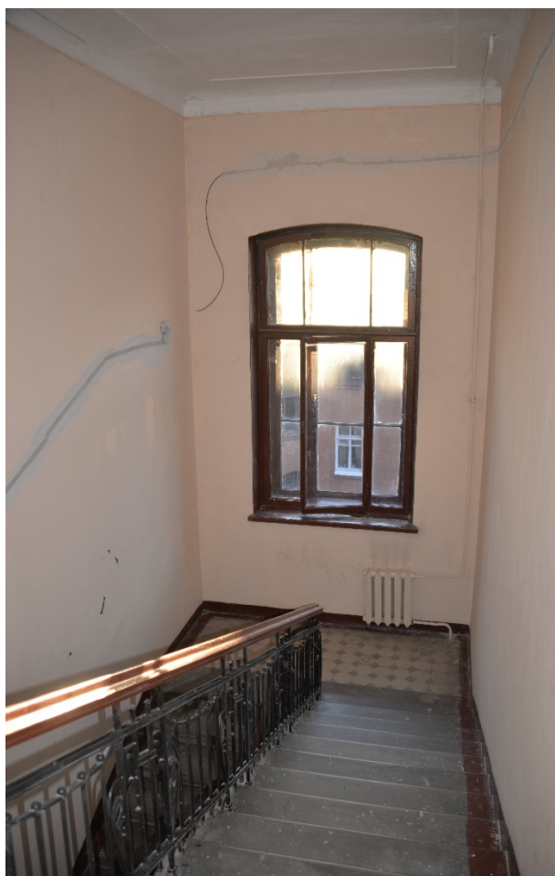
72. Лестница ЗЛК в уровне мансардного этажа
