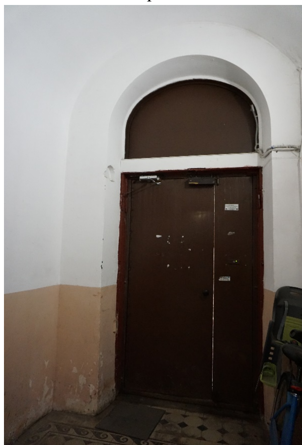
43. Дверь на лестницу 1ЛК
