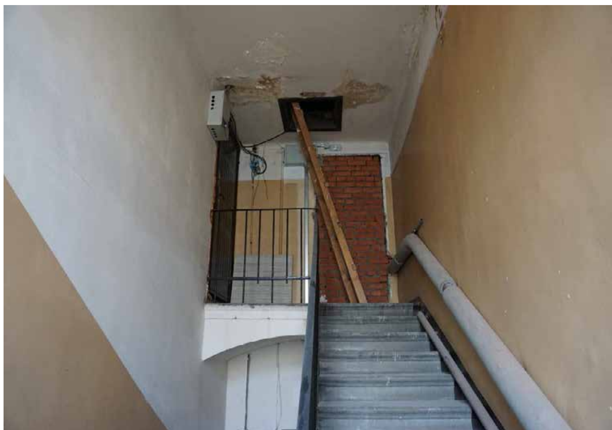
54. Лестница 2ЛК в уровне мансардного этажа
