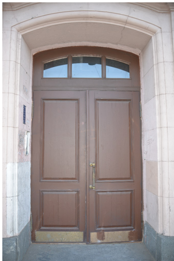
2. Вход на лестницу 3ЛК
