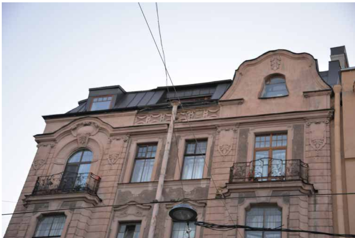
4. Фрагмент фасада, выходящего на Кронверкский проспект, в уровне пятого и мансардного этажей
