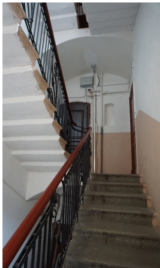
36. Лестница 1ЛК в уровне четвертого этажа
