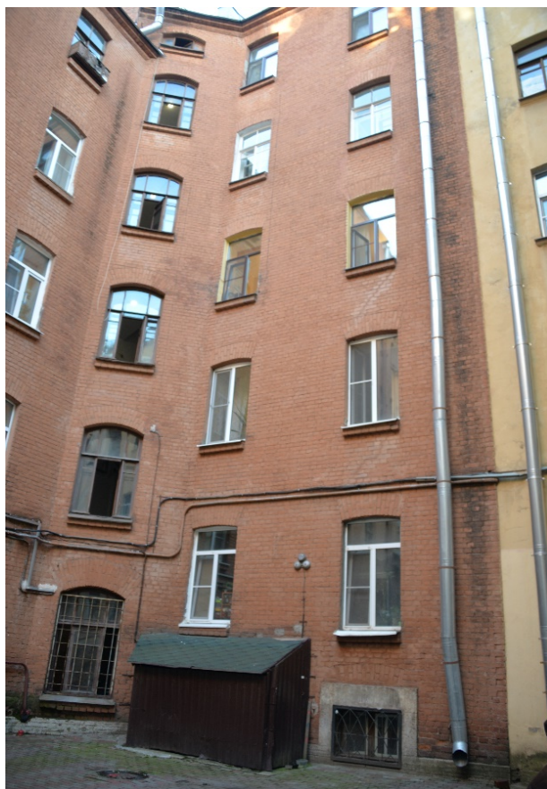
23. Фрагмент дворового фасада
