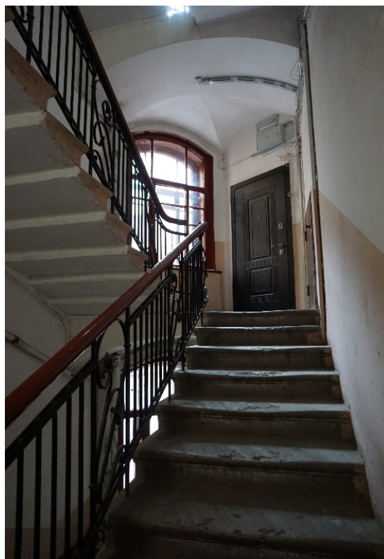
28. Лестница 1ЛК в уровне второго этажа
