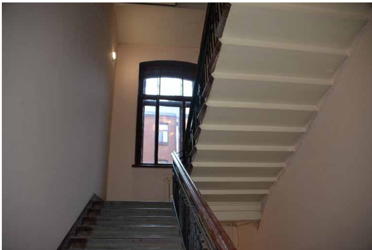
64. Лестница ЗЛК в уровне третьего этажа
