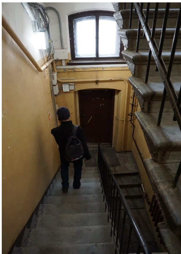
55. Лестница 2ЛК в уровне первого этажа
