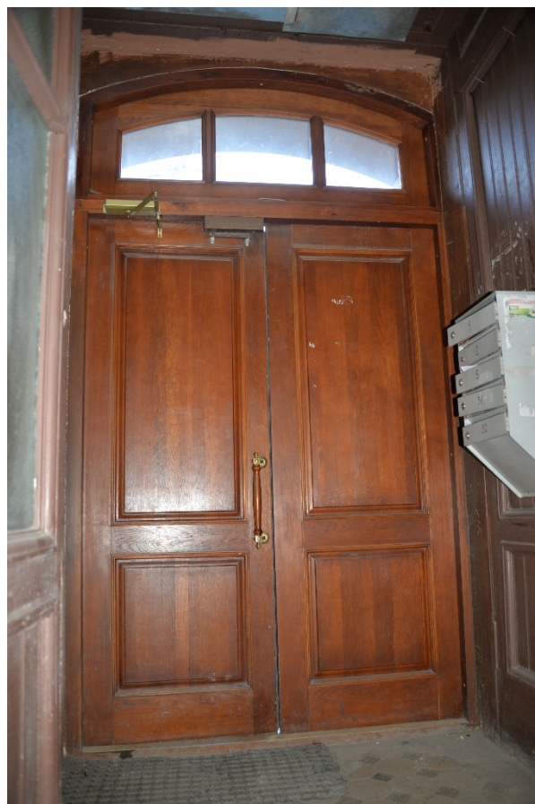
58. Дверь на лестницу 3ЛК
