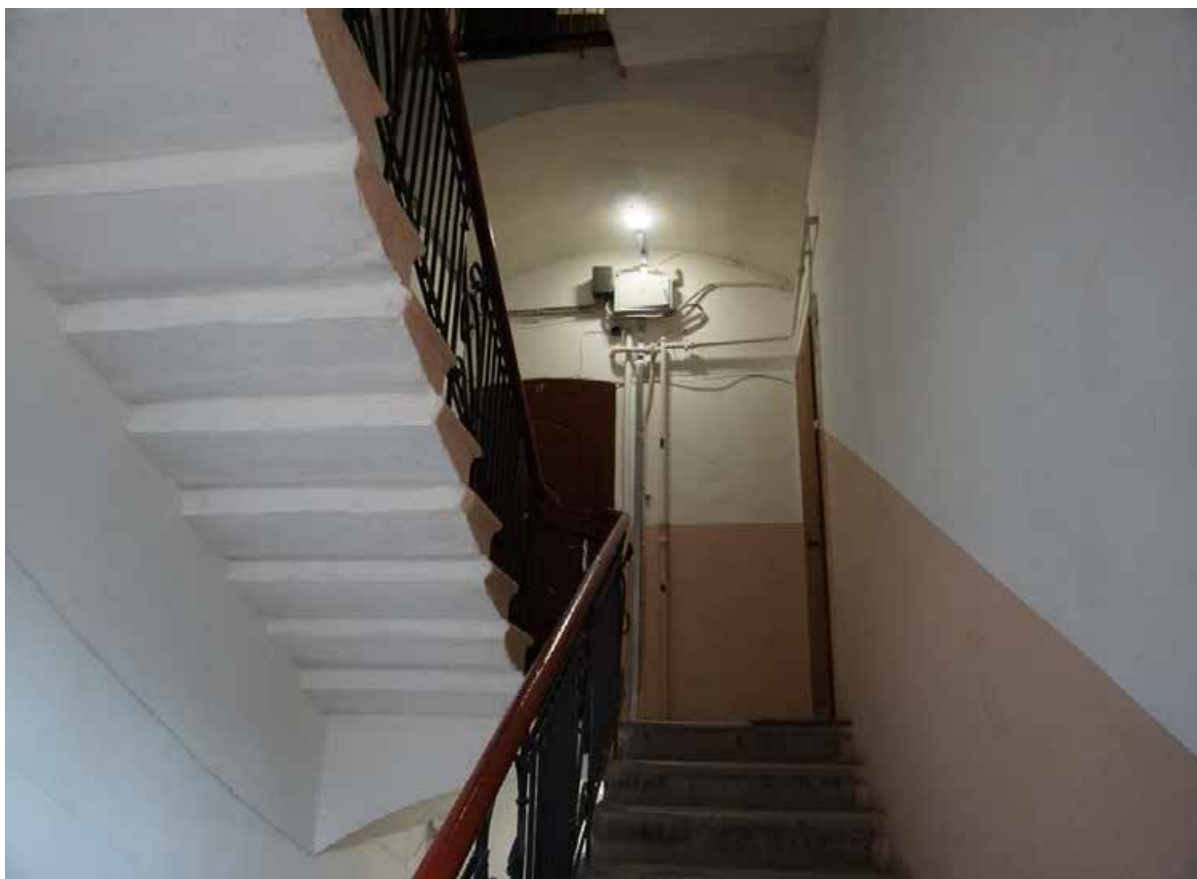
38.Лестница 1ЛК в уровне пятого этажа
