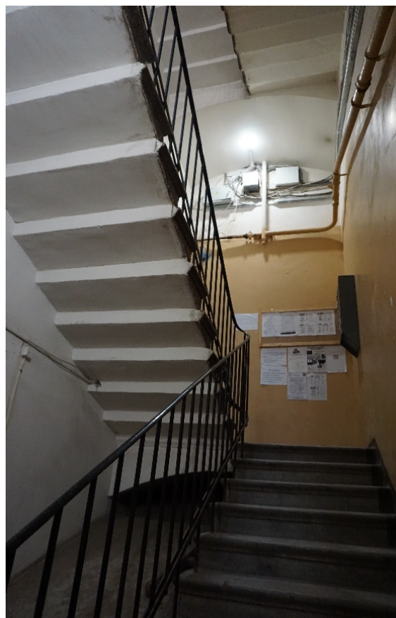
45. Лестница 2ЛК в уровне второго этажа
