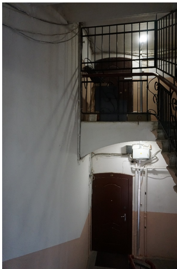
41. Лестница 1ЛК в уровне мансардного этажа
