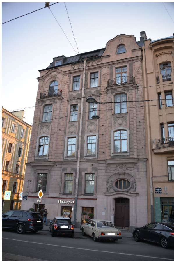
1. Лицевой фасад, выходящий на Кронверкский проспект
