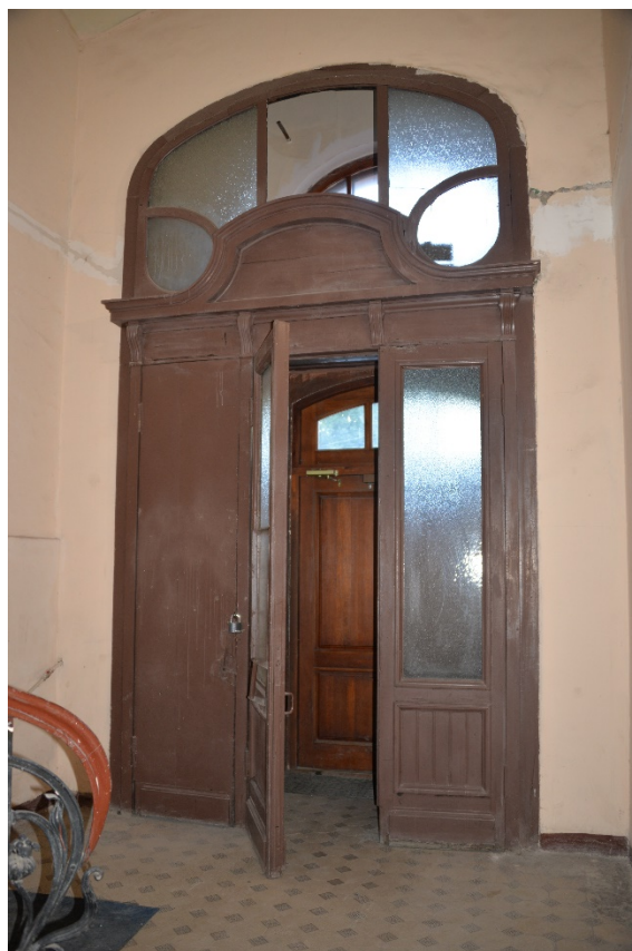
56. Тамбур лестницы 3ЛК
