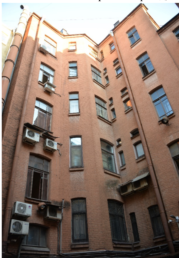
21. Фрагмент дворового фасада
