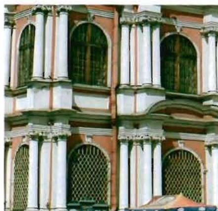
металлические кованые решетки оконных заполнений 1-го этажа, рисунок – вертикальные тяги со стреловидными окончаниями, волотообразные элементы, круглые элементы);
