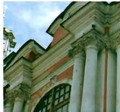
разорванные лучковые фронтоны с волнитообразными элементами — на каждом из тех фасадов лестничной пристройки;
