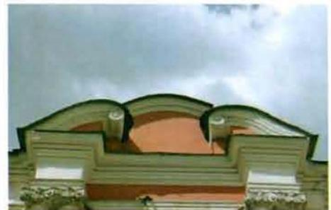
северный фасад здания в уровне второго и третьего ярусов оформлен пилястрами ионического ордера с известняковыми базами;
