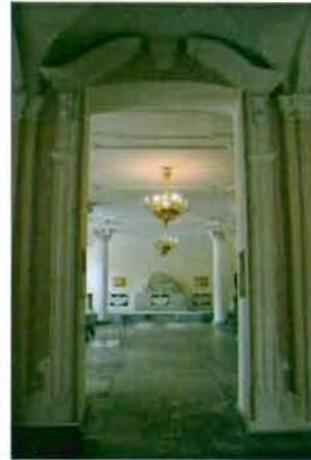
боковые входные проемы оформлены профилированными фигурными наличниками с трехчастными замковыми камнями;
