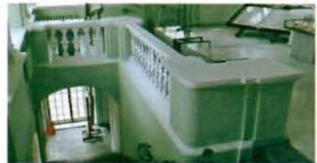
раскрепованные опорные тумбы, со скругленными углами и профилированным цоколем, профилированные поручни;
