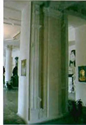
центральный входной проем в помещение церкви оформлен профилированным наличником с разорванным фронтоном и трехчастным замковым камнем, откосы декорированы волютами в нижних и верхних частях, профилированными тягами и лепными цветочными гирляндами;
