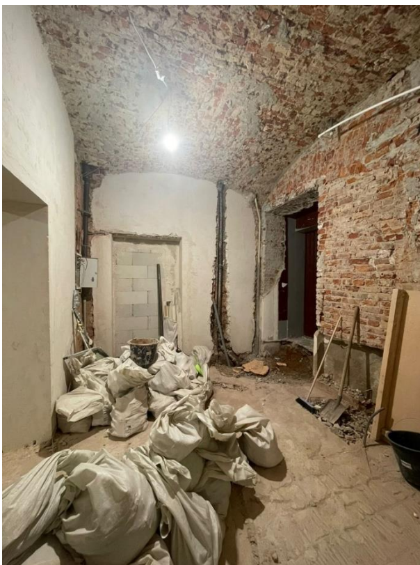
8. «Бывш. Дом Бутурлиной», ул. Чайковского, д.10, лит. А. 1 этаж. Квартира №61. Помещение №4-5. Общий вид. Фото 26.10.2023г.
