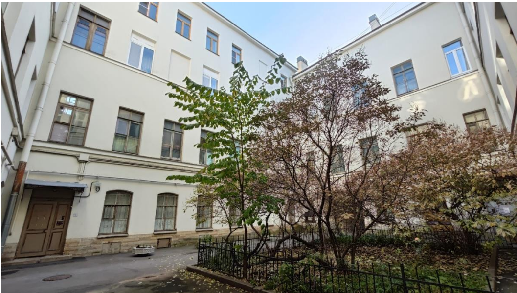
2. «Бывш. Дом Бутурлиной», ул. Чайковского, д.10, лит. А. Дворовый фасад. Общий вид. Фото 26.10.2023г.
