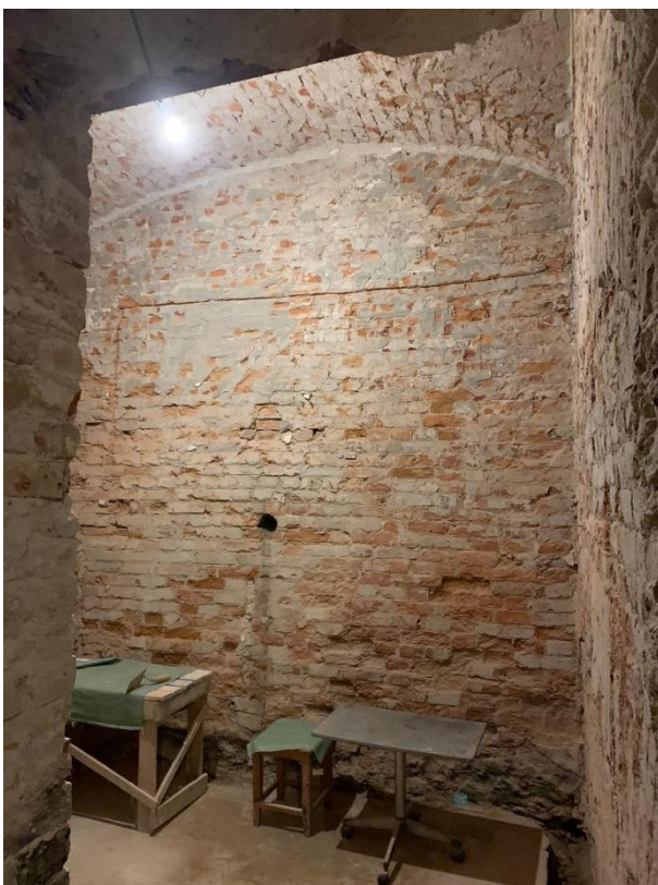
5. «Бывш. Дом Бутурлиной», ул. Чайковского, д.10, лит. А. 1 этаж. Квартира №61. Помещение №2. Общий вид. Фото 26.10.2023г.
