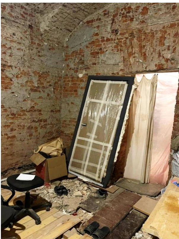
12. «Бывш. Дом Бутурлиной», ул. Чайковского, д.10, лит. А. 1 этаж. Квартира №61. Помещение №3. Общий вид. Фото 26.10.2023г.
