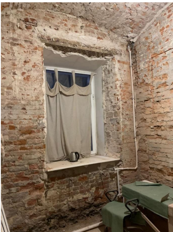
6. «Бывш. Дом Бутурлиной», ул. Чайковского, д.10, лит. А. 1 этаж. Квартира №61. Помещение №2. Общий вид. Фото 26.10.2023г.
