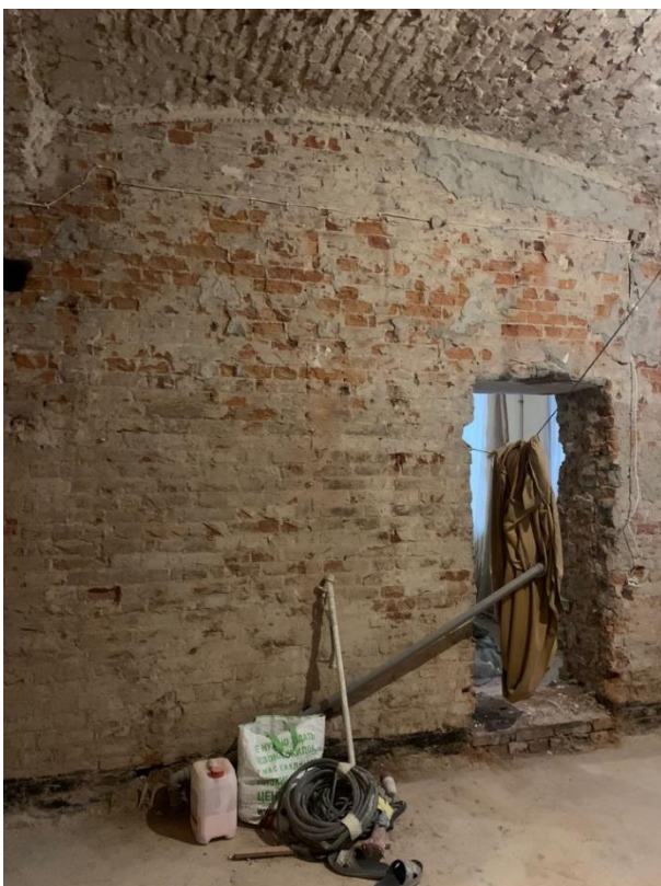
11. «Бывш. Дом Бутурлиной», ул. Чайковского, д.10, лит. А. 1 этаж. Квартира №61. Помещение №3. Общий вид. Фото 26.10.2023г.
