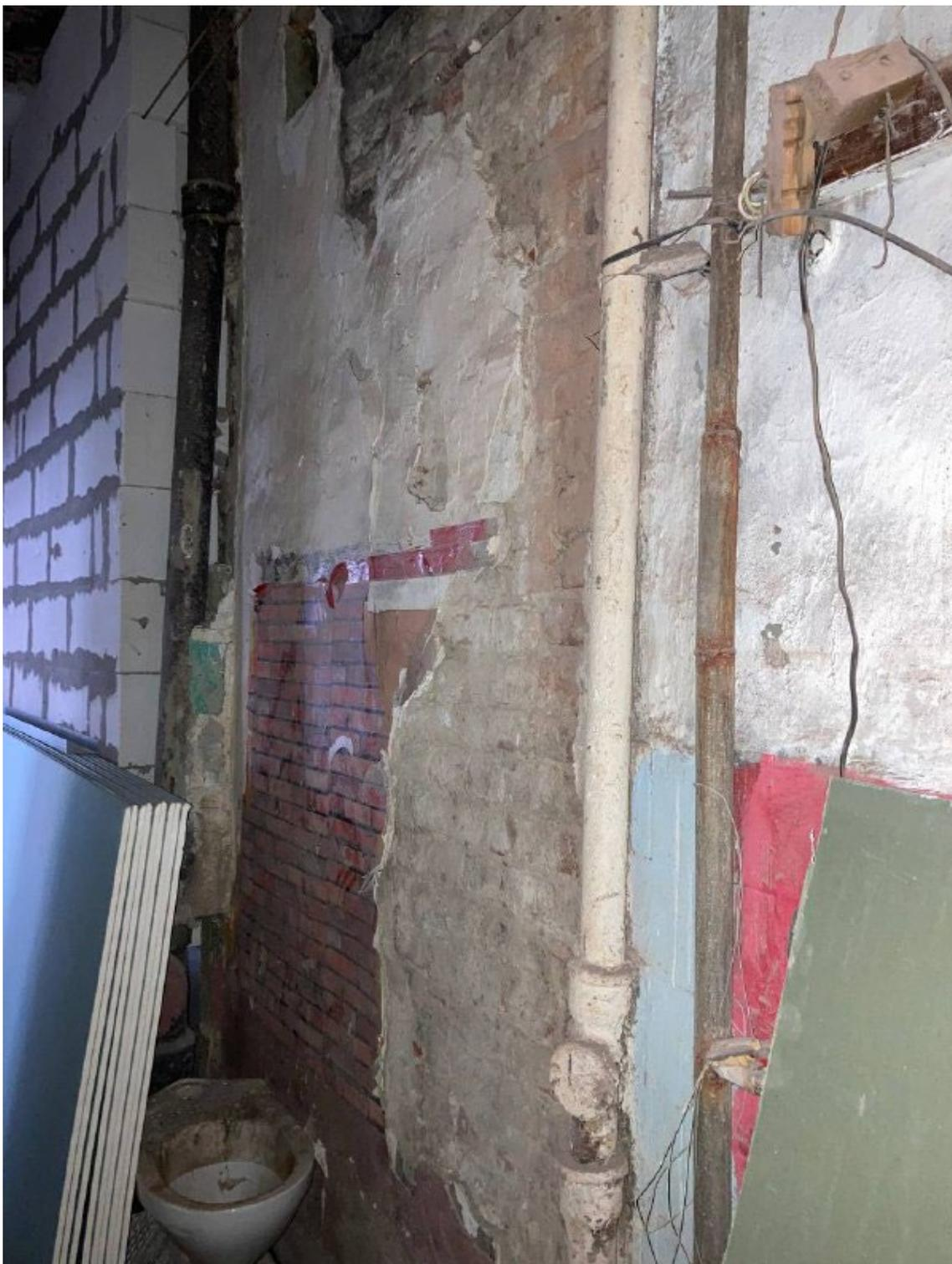
*Фото 4. Фрагмент стены в коридоре. Канализационные стояки.*
