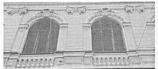
оформление конных проемов боковых раскреповок 3-го этажа – профилированные наличники, гермы с порезкой из «цехинов» в межоконном пространстве, стилизованные плоские пилястры, профилированный раскрепованный карниз, над оконными проемами и под ними – прямоугольные филенки с провисающими гирляндами; над оконными проемами;
