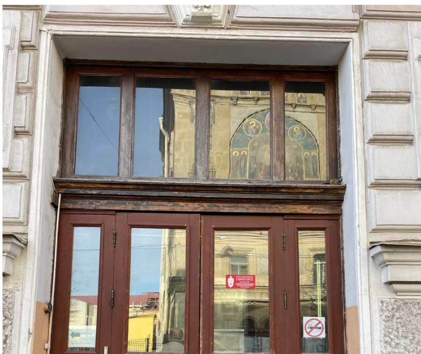
Фото 4. Фрагмент дверного заполнения, наблюдается отслоение окрасочного слоя, загрязнение.
