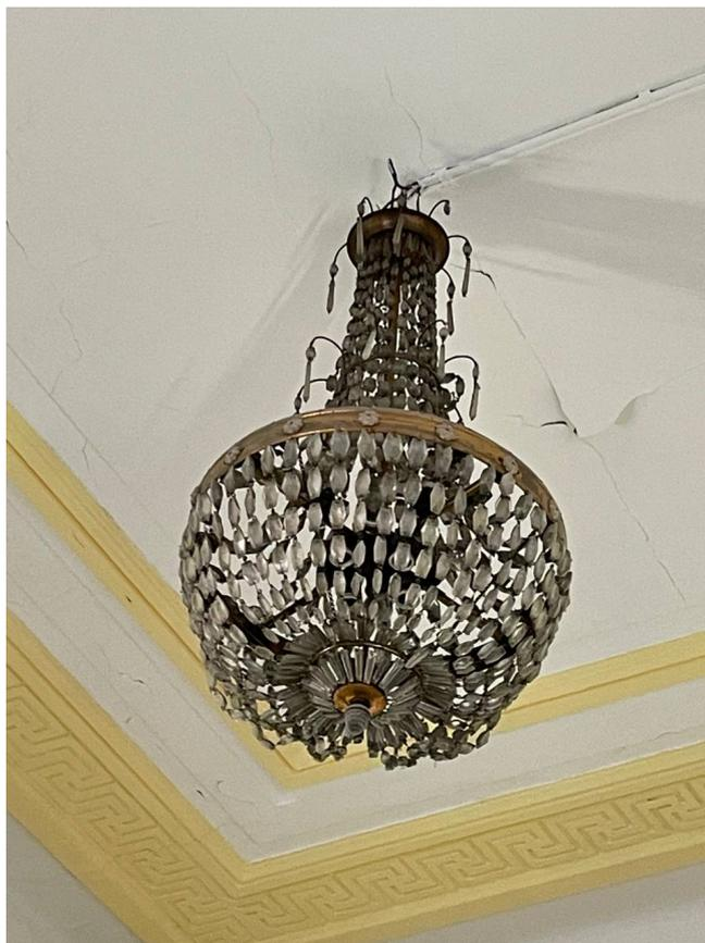
*Фото 31. Фрагмент помещения. Наблюдается отслоение штукатурного слоя, волосяные трещины и загрязнение.*
