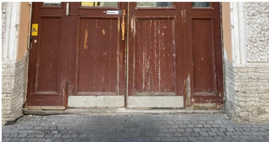
Фото 3. Фрагмент дверного заполнения, наблюдается отслоение окрасочного слоя, загрязнение.
