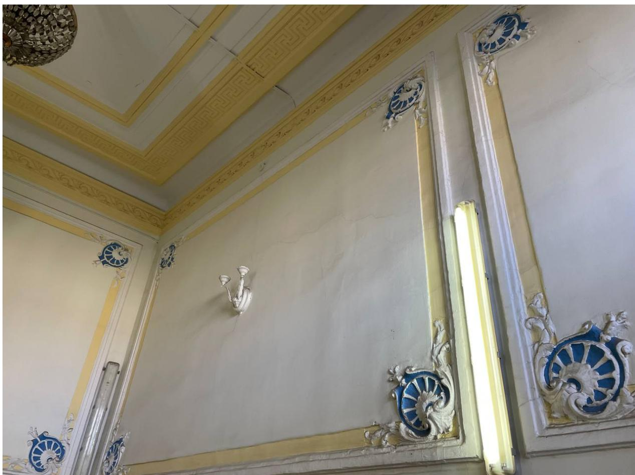
Фото 30. Фрагмент помещения. Наблюдается отслоение штукатурного слоя, волосяные трещины и загрязнение.
