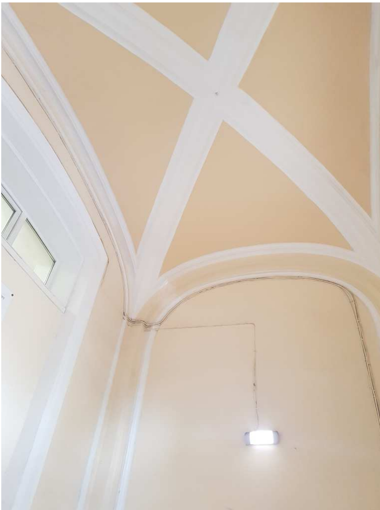
4. Сводчатое перекрытие пом. тамбура.
