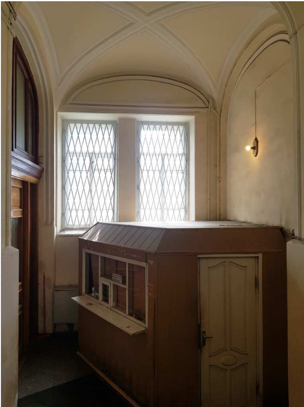
5. Общий вид пом. тамбура с будкой охраны.
