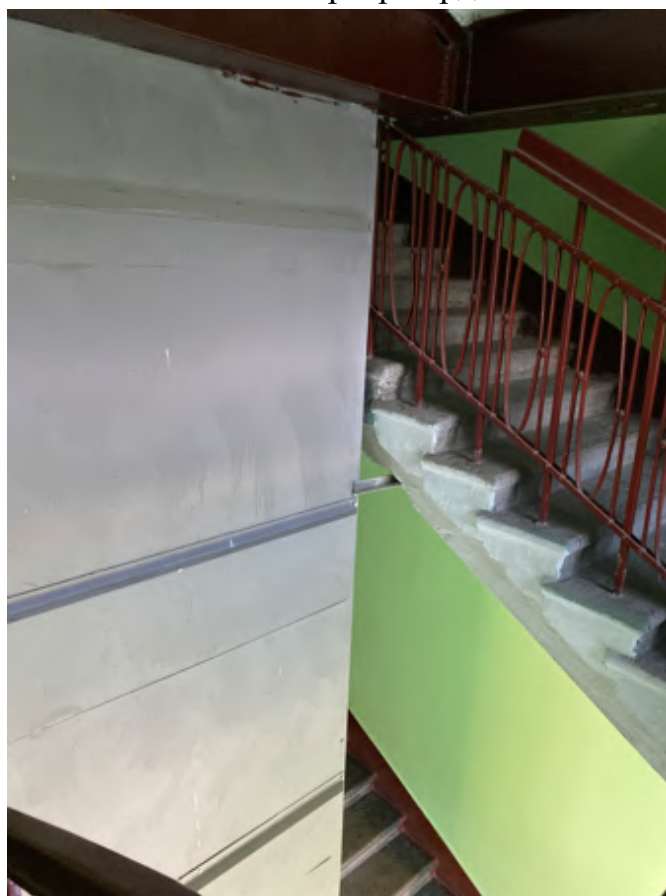
24. Фрагмент интерьера лестницы №1
