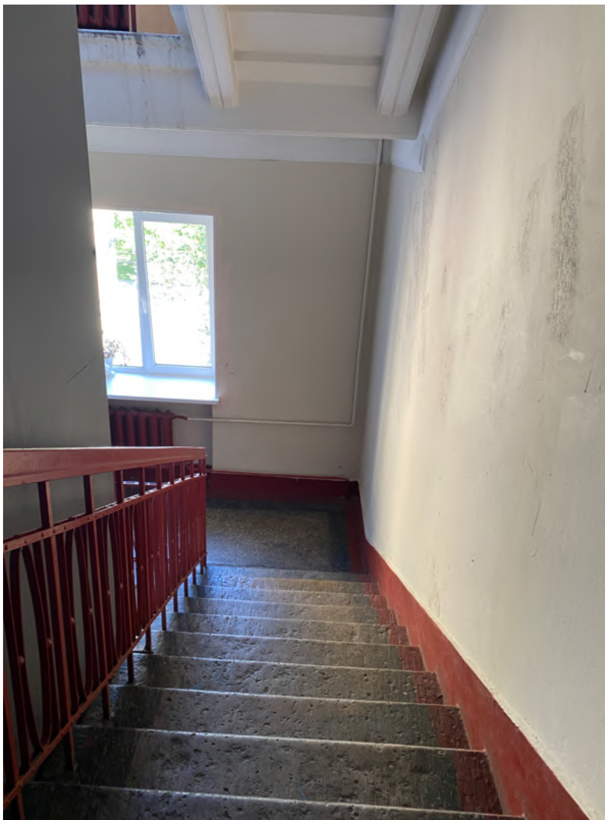
51. Фрагмент интерьера лестницы №4
