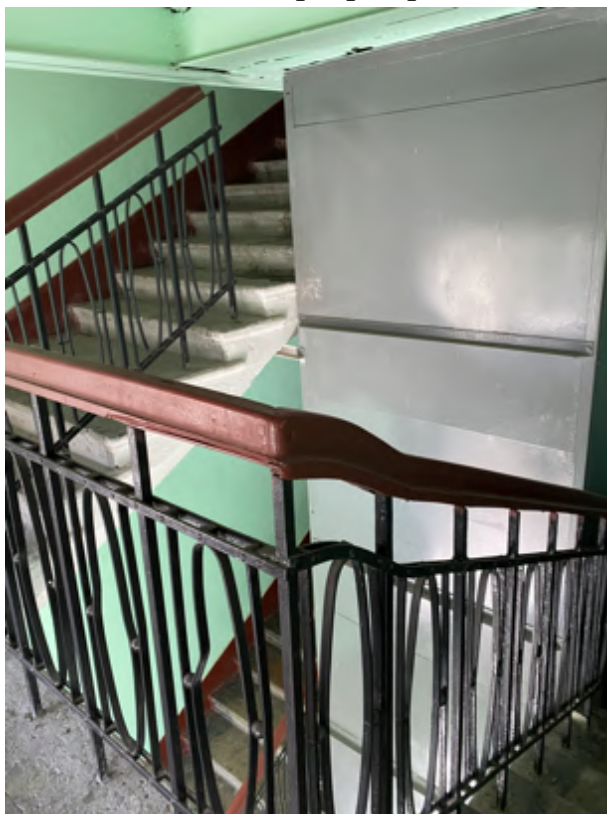
43. Фрагмент интерьера лестницы №3
