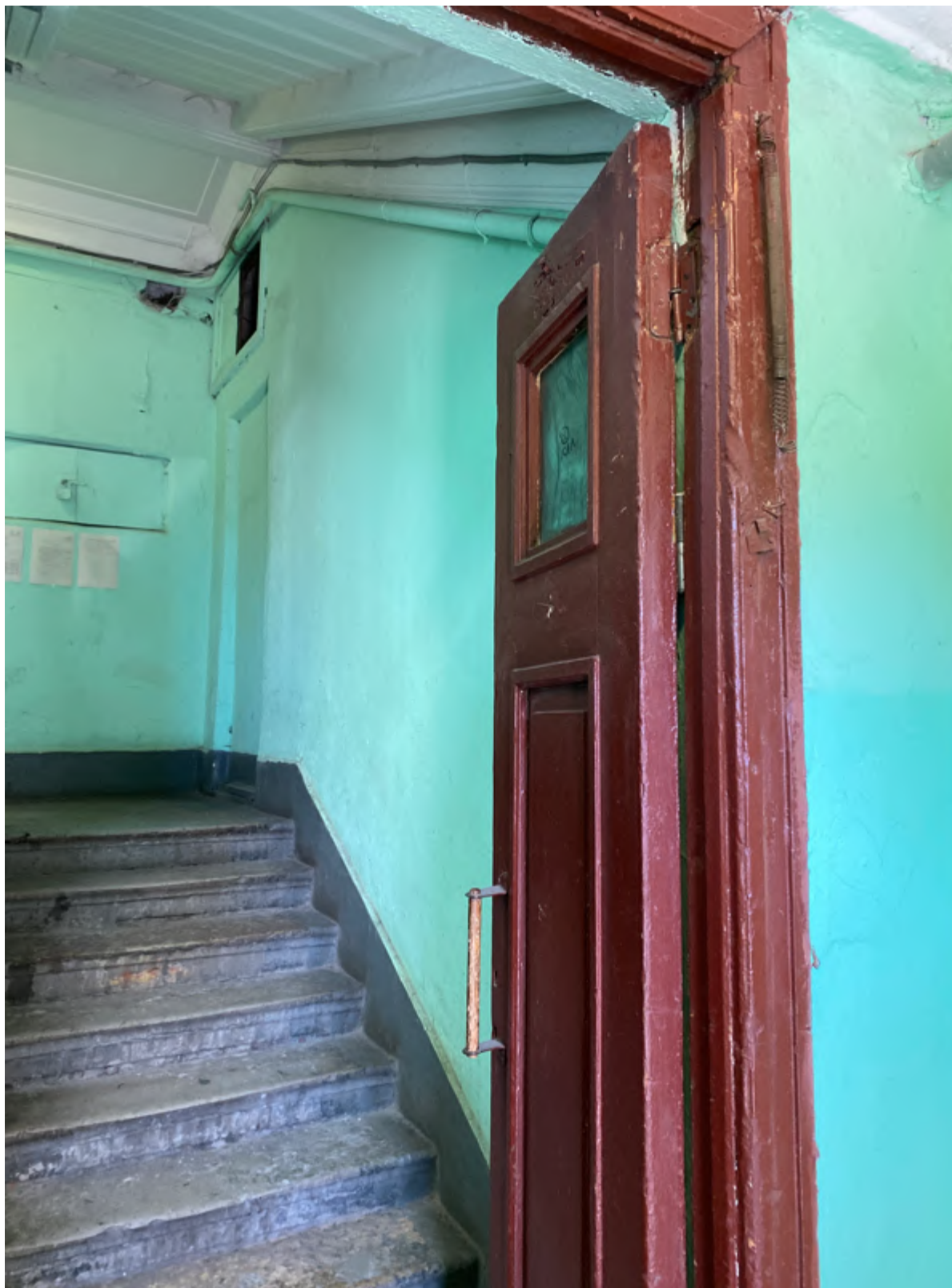
30. Фрагмент интерьера лестницы №2
