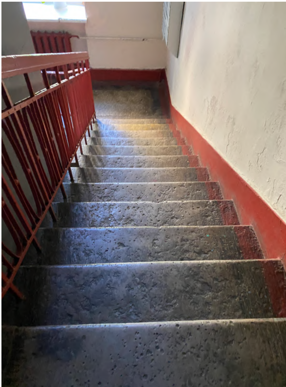
54. Фрагмент интерьера лестницы №4
