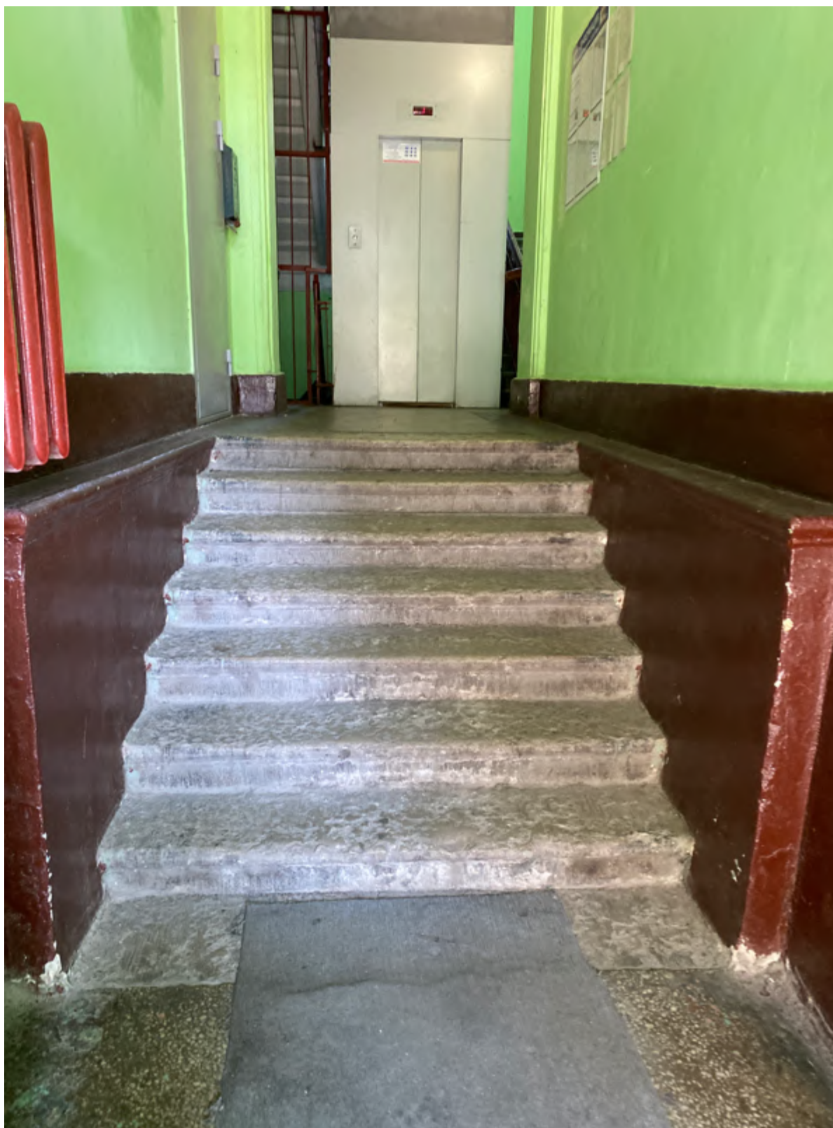
22. Фрагмент интерьера лестницы №1
