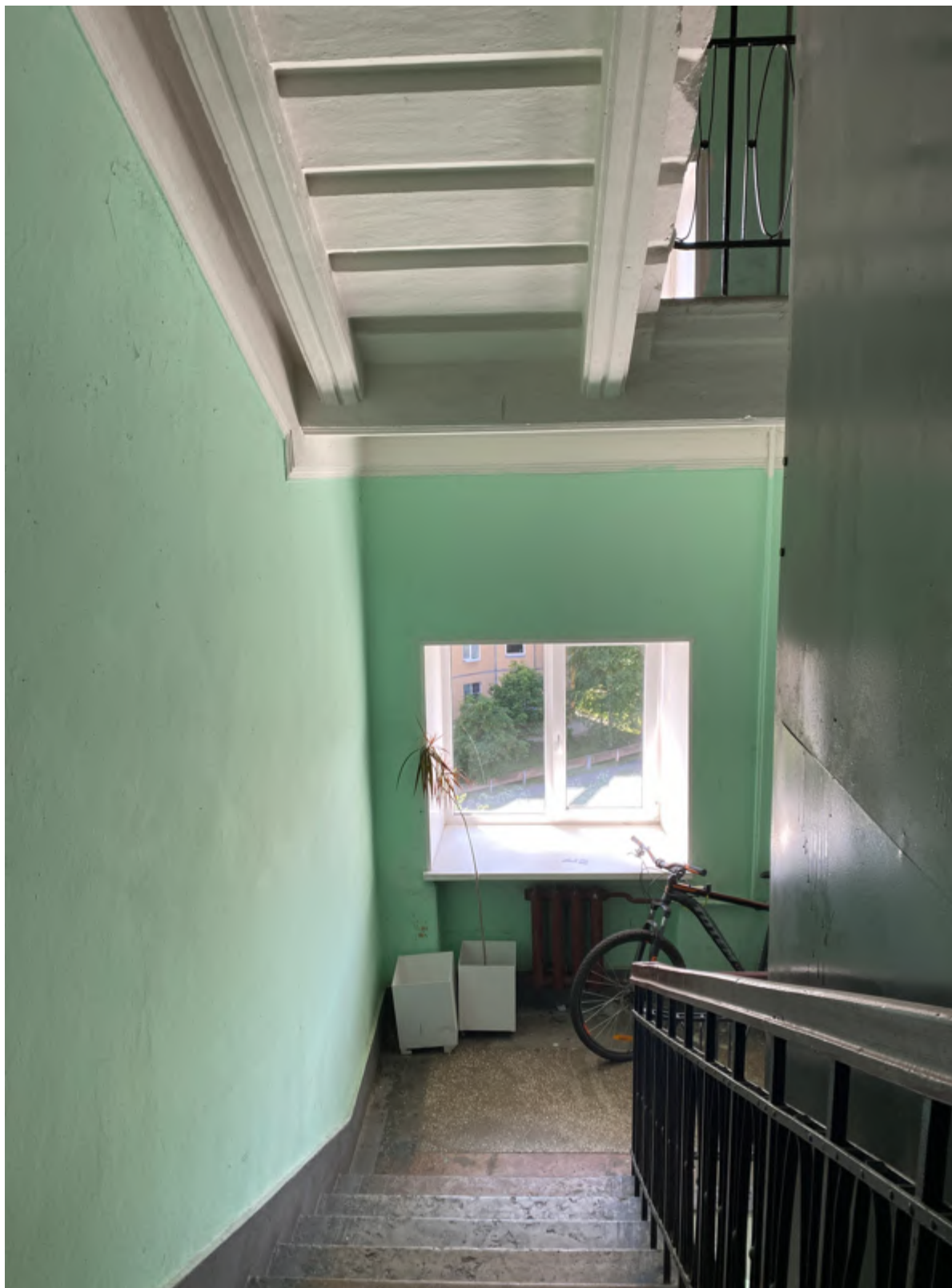
34. Фрагмент интерьера лестницы №2
