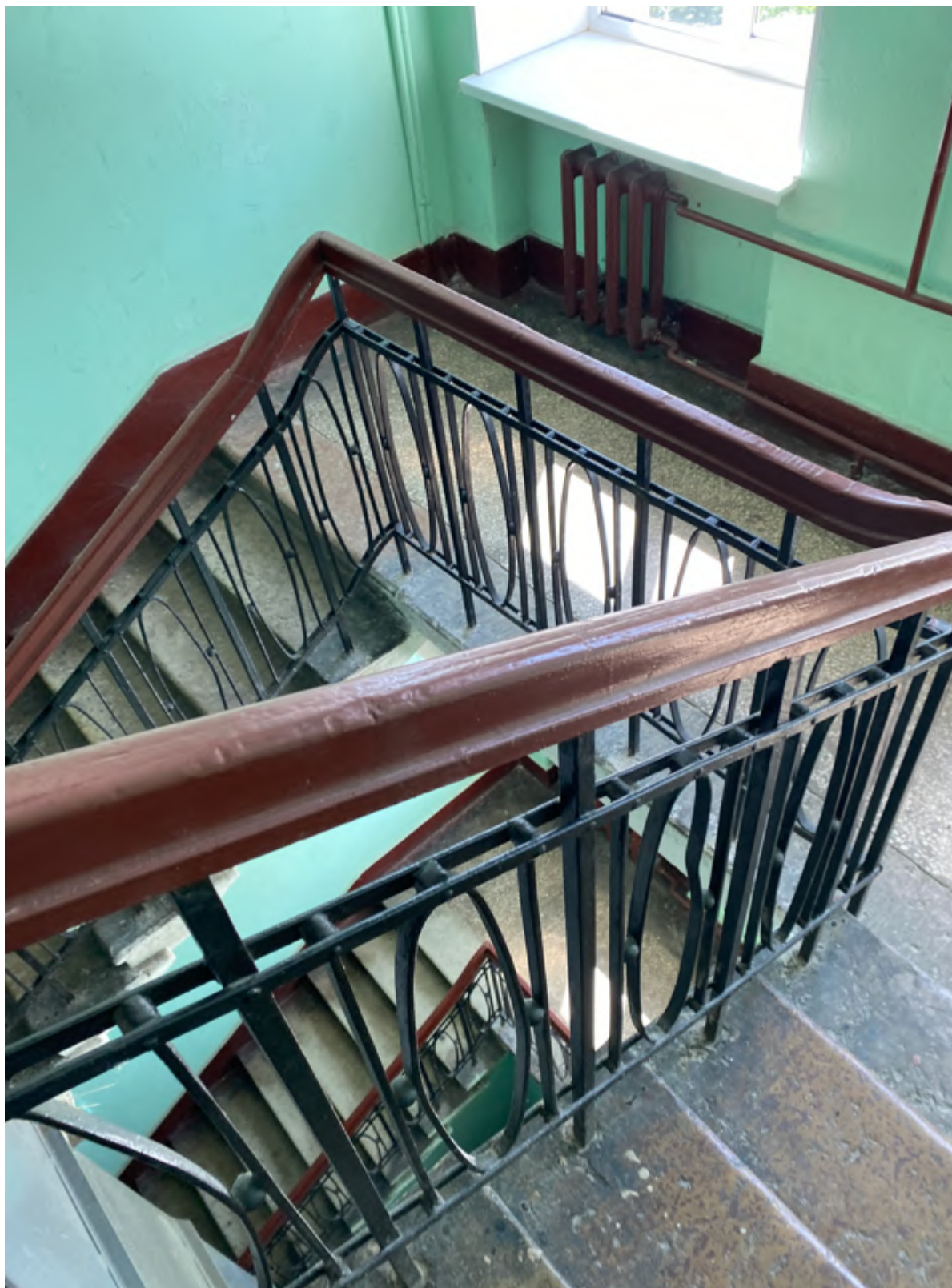
46. Фрагмент интерьера лестницы №3
