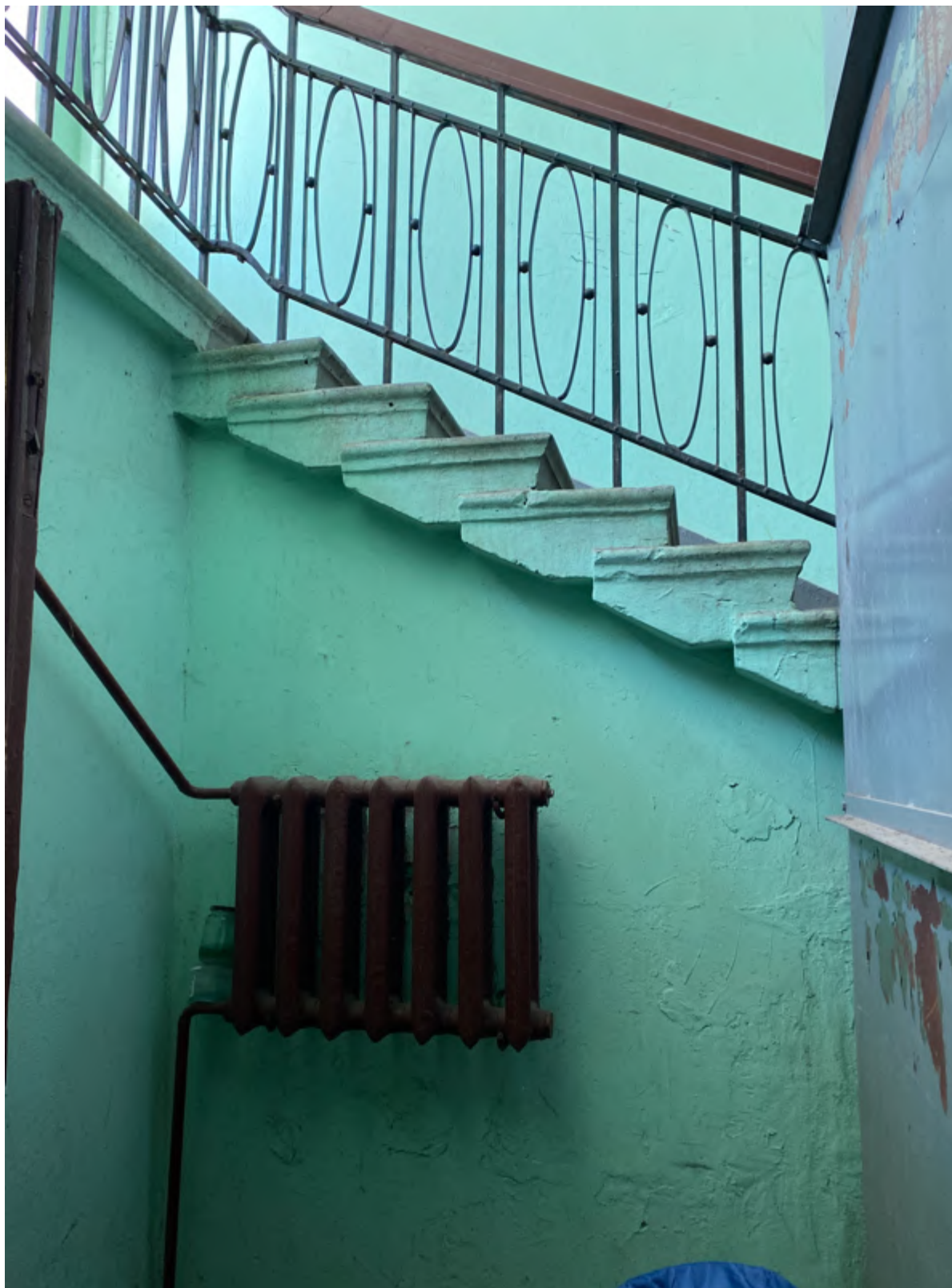
31. Фрагмент интерьера лестницы №2
