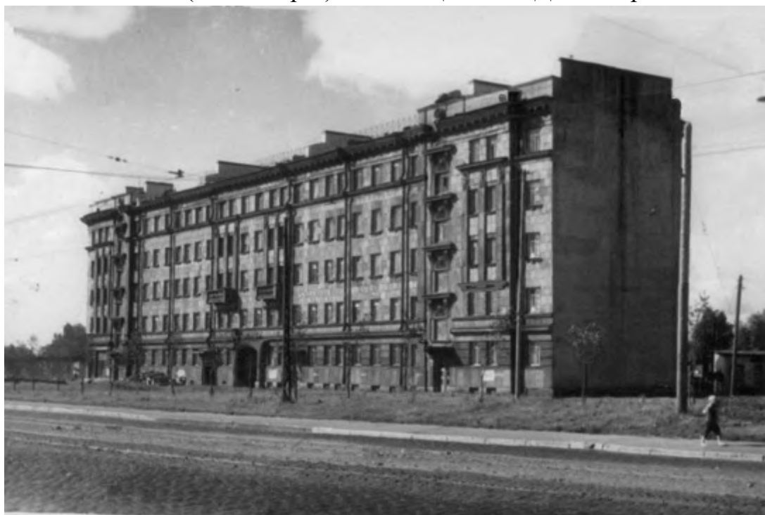
24. Вид на дом №35 на Шлиссельбургском проспекте. 1950–1953 гг. ЦГАКФФД СПб Бр 13981
