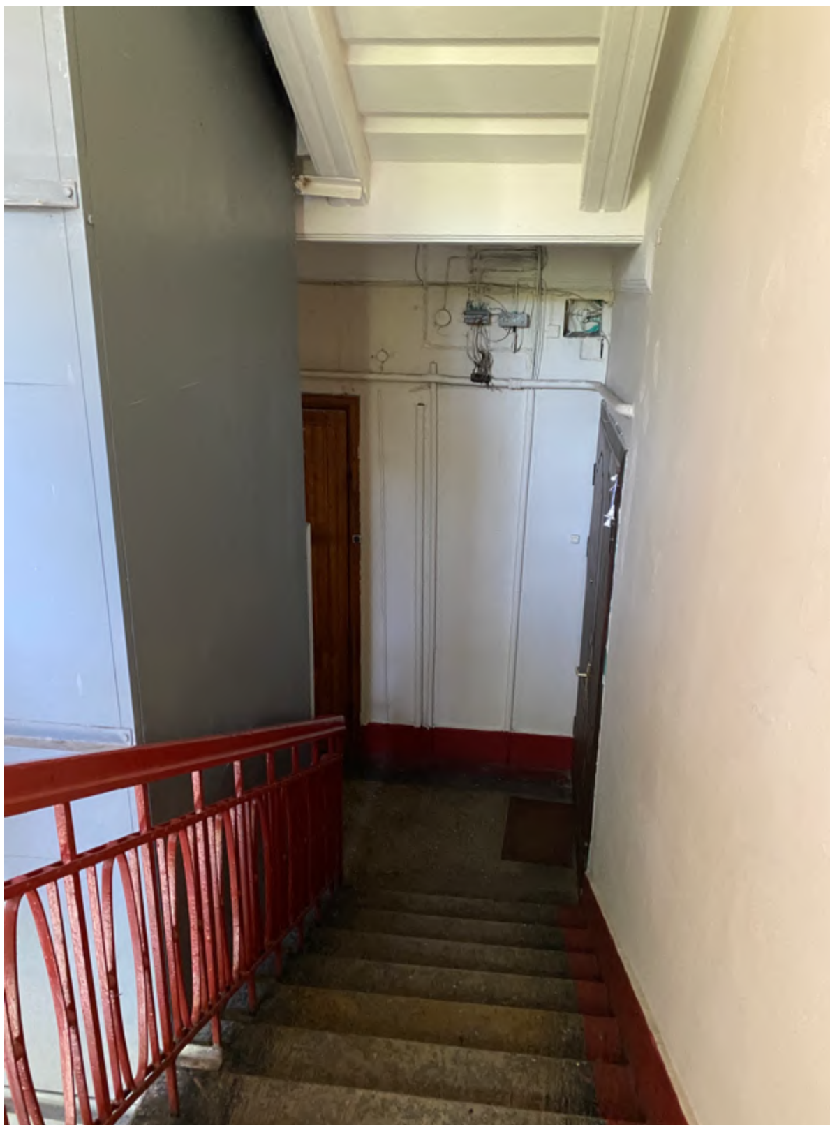
52. Фрагмент интерьера лестницы №4
