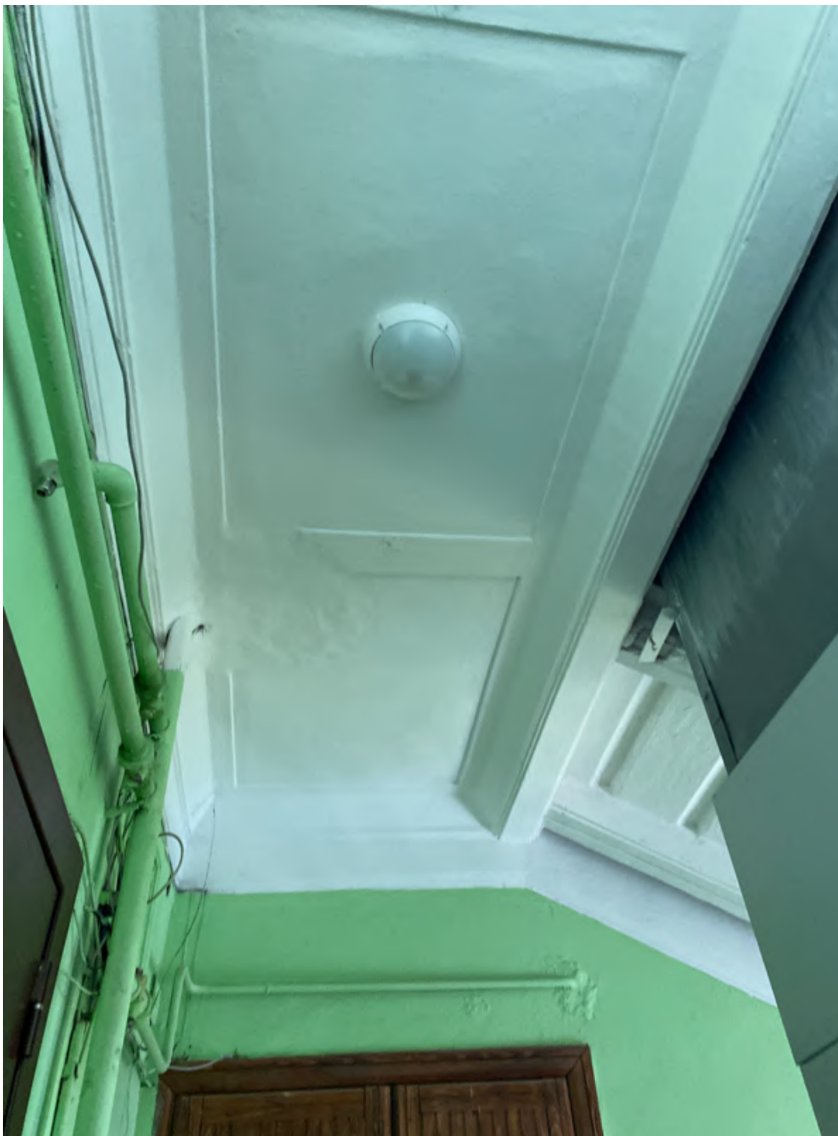
26. Фрагмент интерьера лестницы №1
