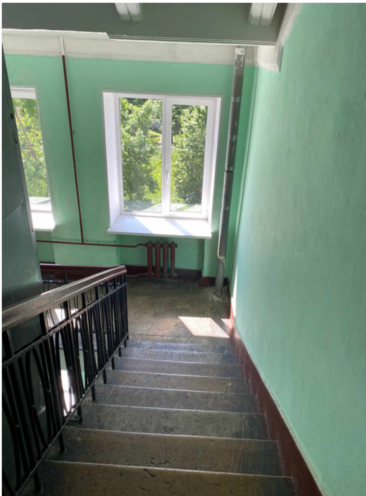
44. Фрагмент интерьера лестницы №3
