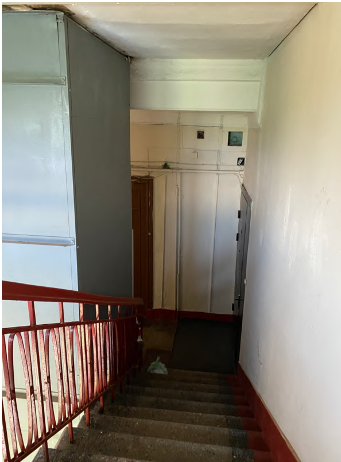
49. Фрагмент интерьера лестницы №4
