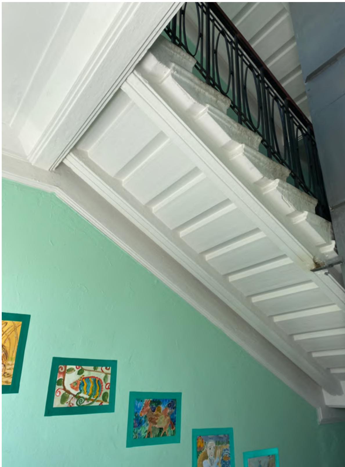
36. Фрагмент интерьера лестницы №2
