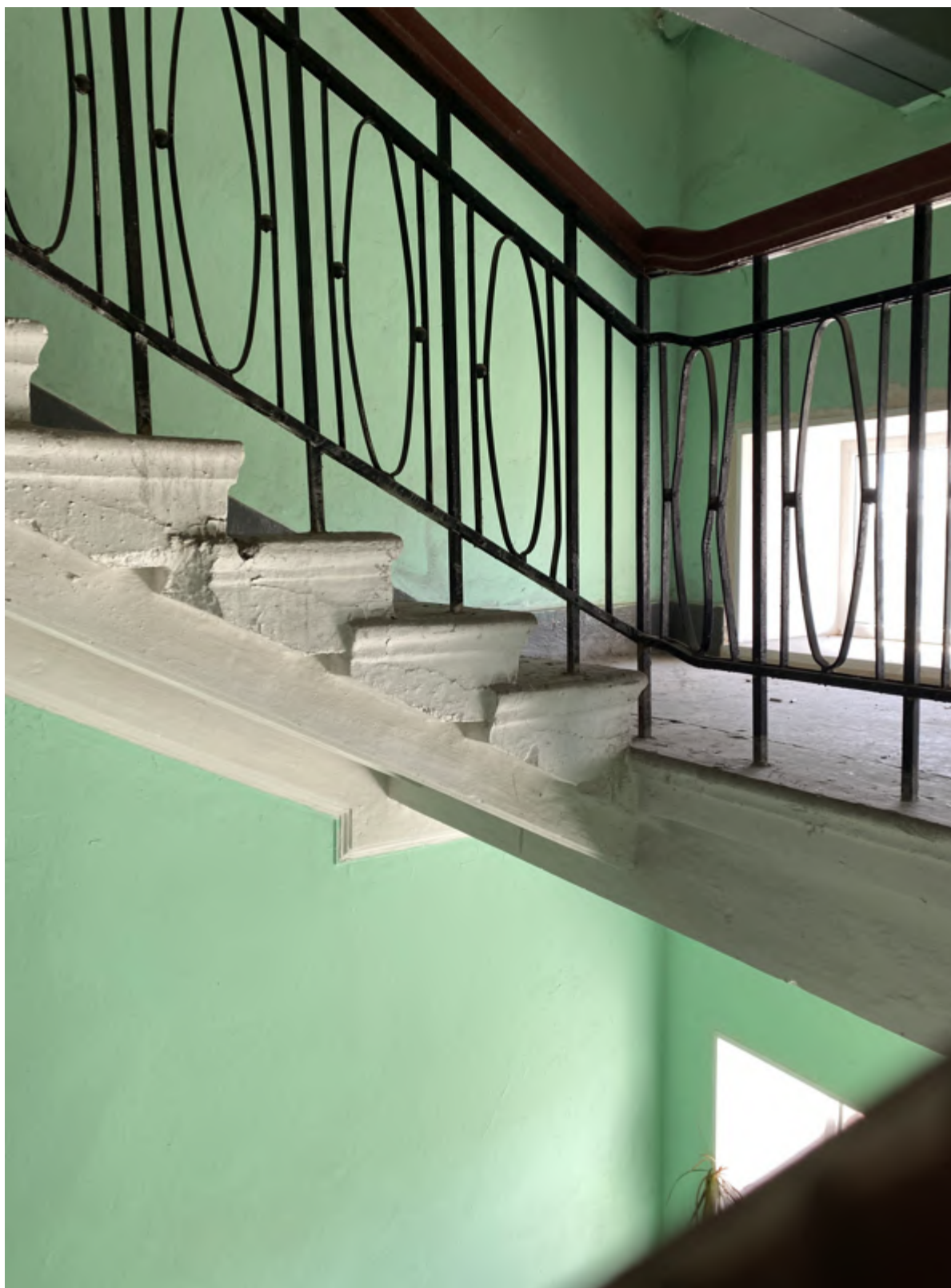
33. Фрагмент интерьера лестницы №2
