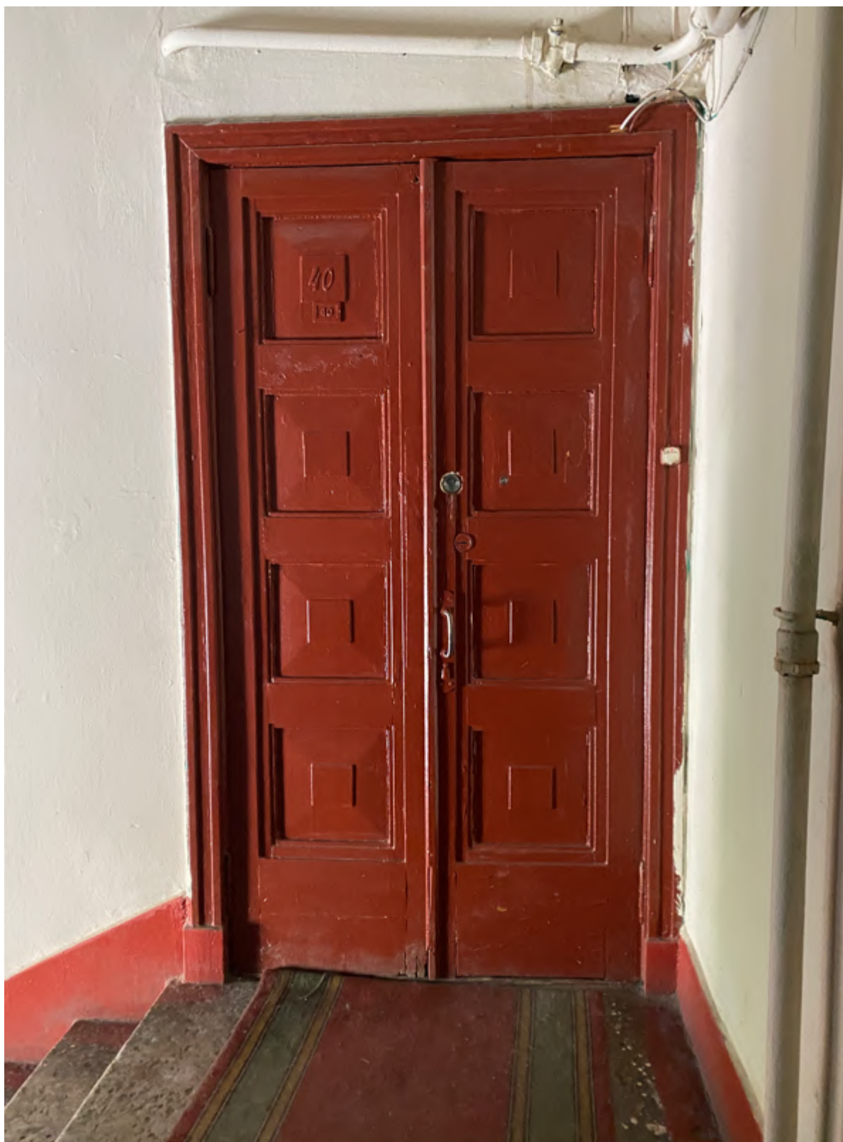
50. Фрагмент интерьера лестницы №4
