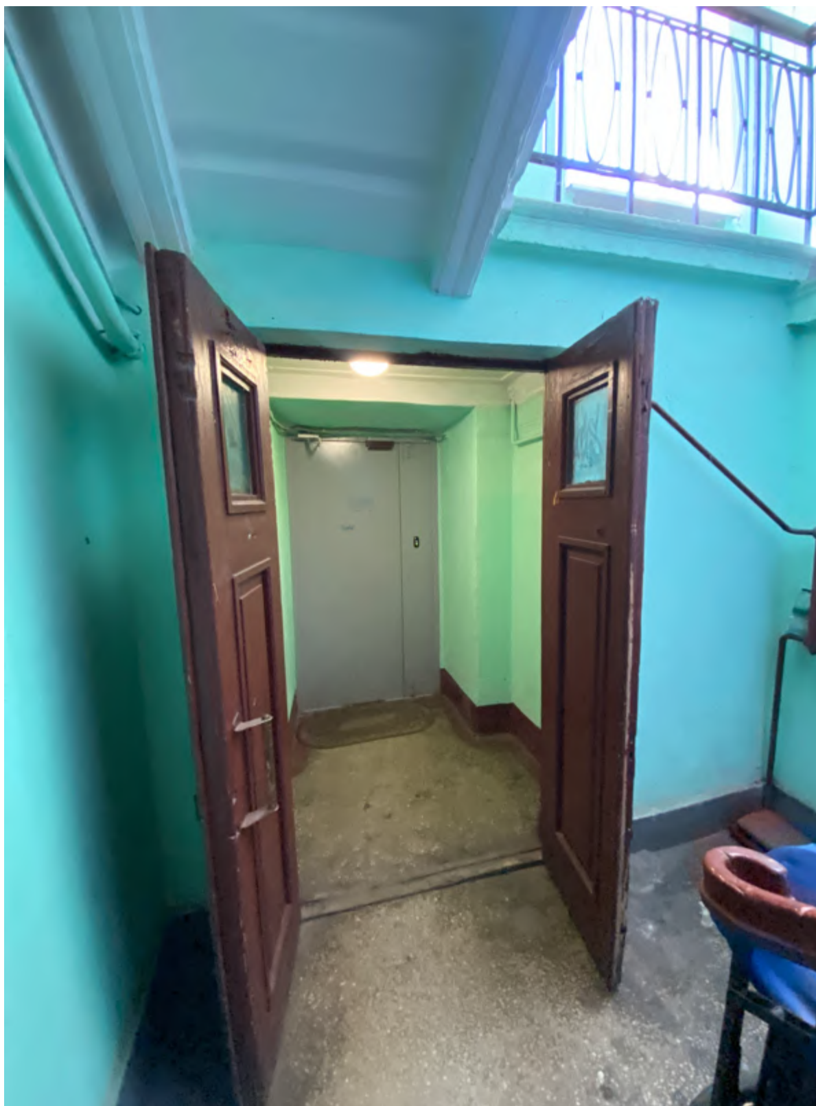
32. Фрагмент интерьера лестницы №2
