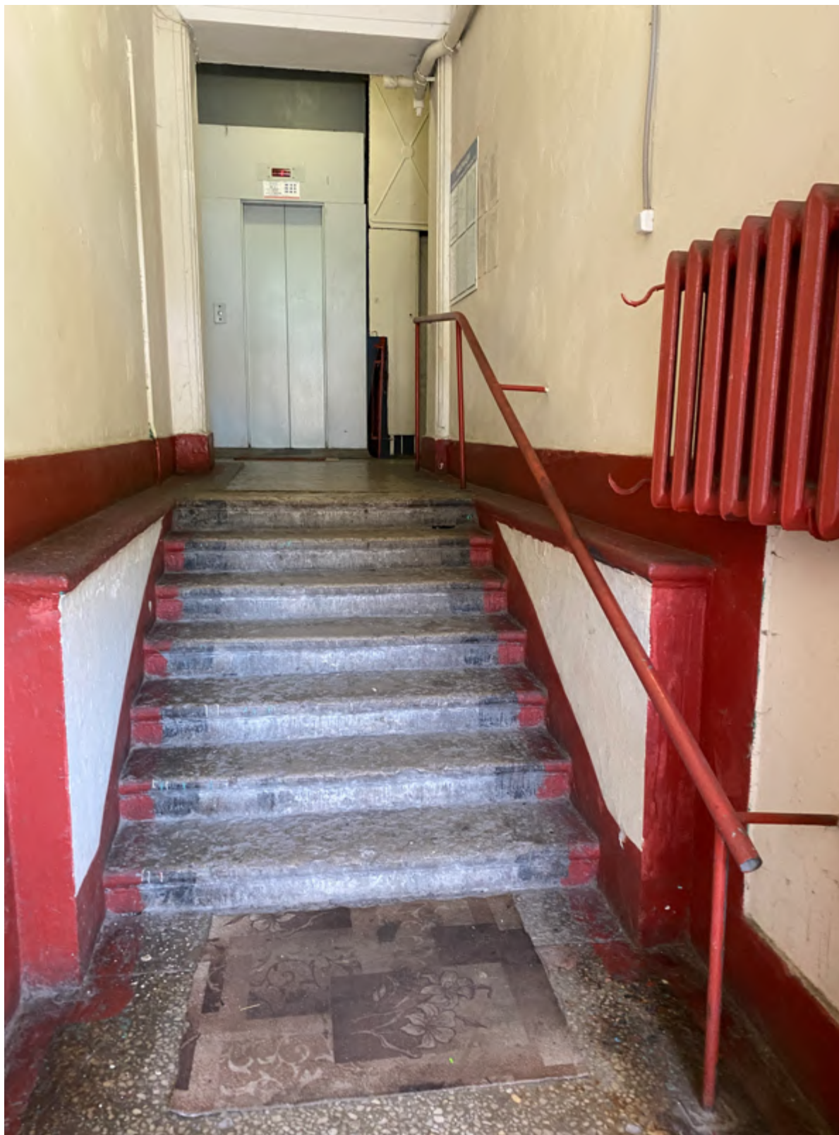
48. Фрагмент интерьера лестницы №4
