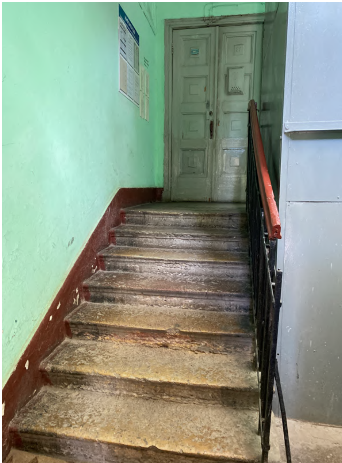
41. Фрагмент интерьера лестницы №3
