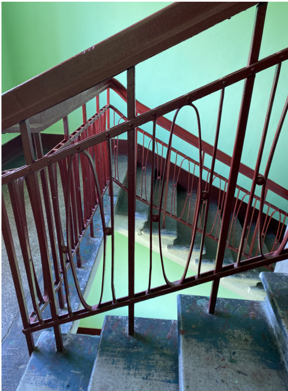
25. Фрагмент интерьера лестницы №1
