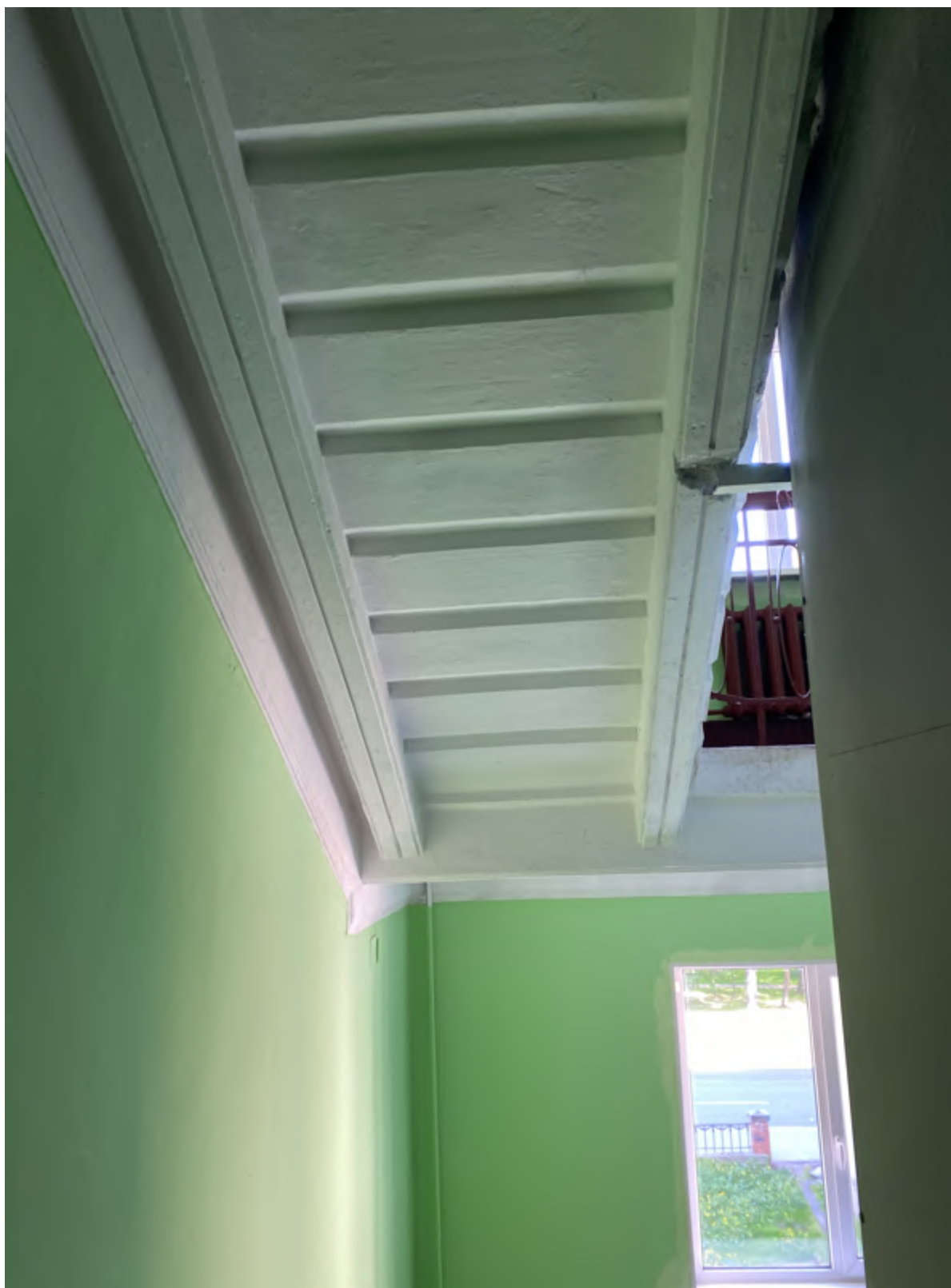
27. Фрагмент интерьера лестницы №1
