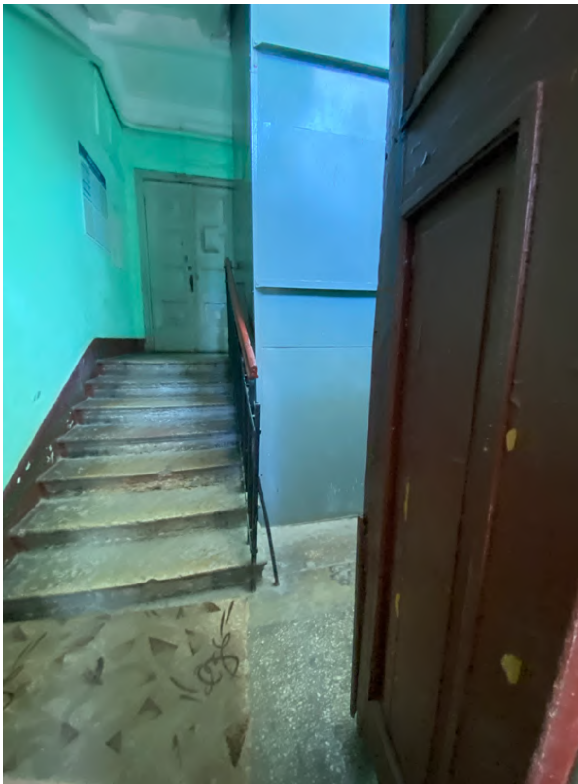
40. Фрагмент интерьера лестницы №3
