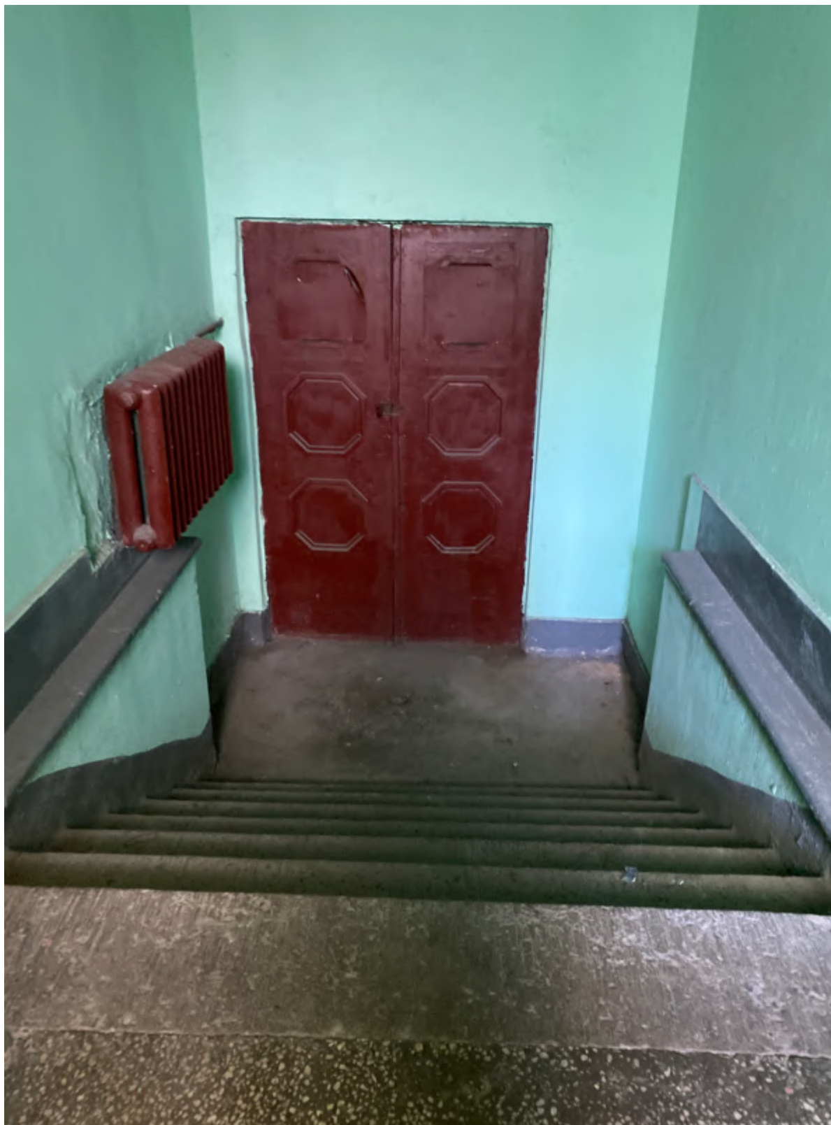
39. Фрагмент интерьера лестницы №2
