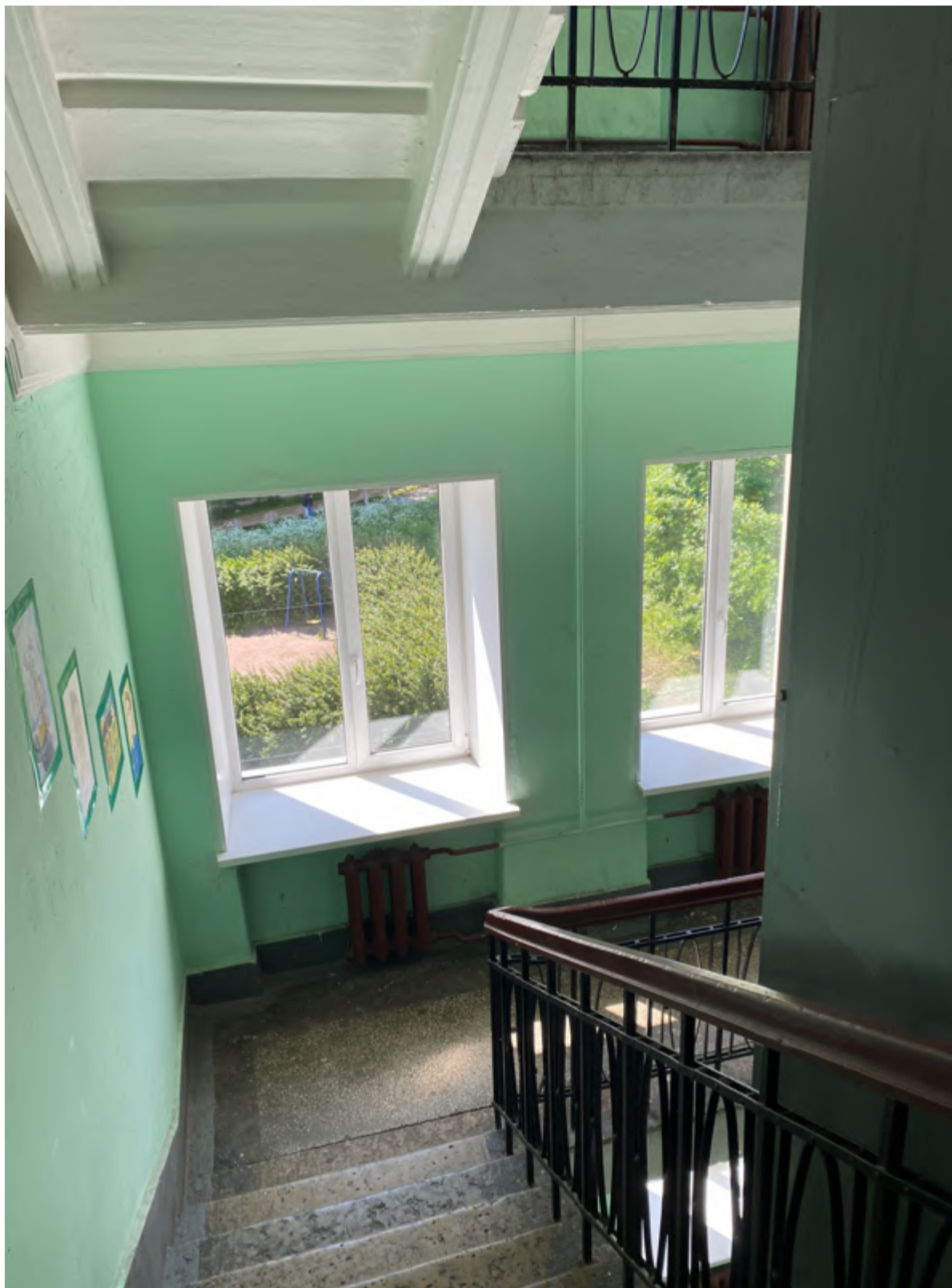
37. Фрагмент интерьера лестницы №2
