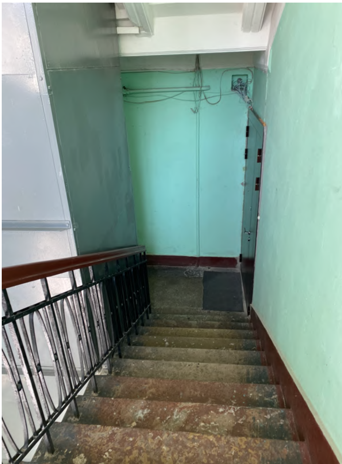
45. Фрагмент интерьера лестницы №3
