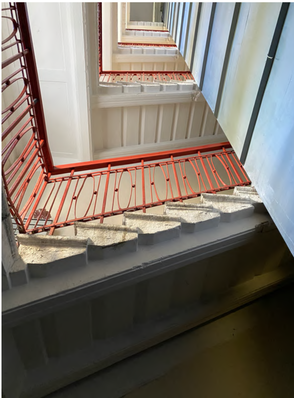
55. Фрагмент интерьера лестницы №4
