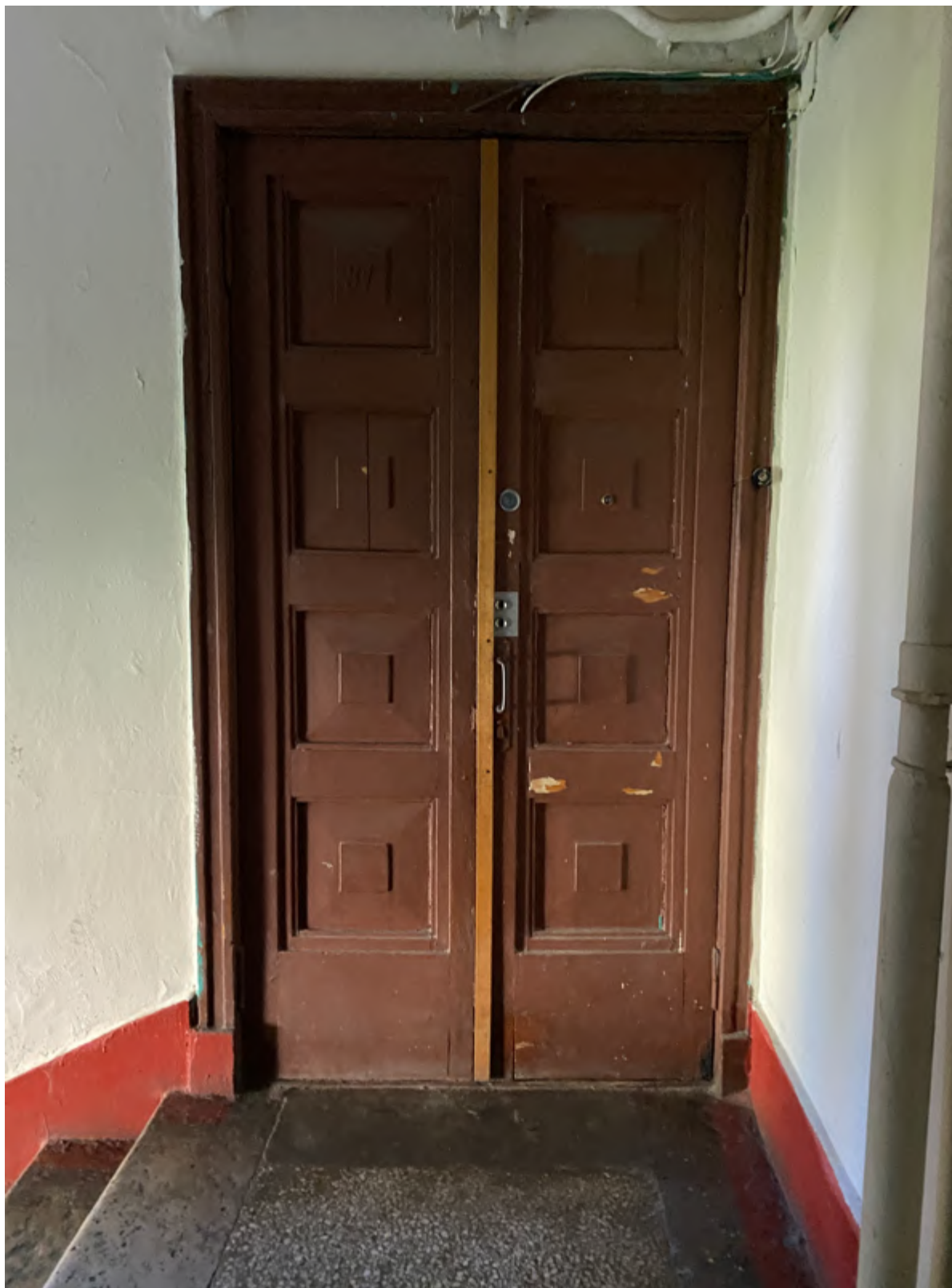
53. Фрагмент интерьера лестницы №4
