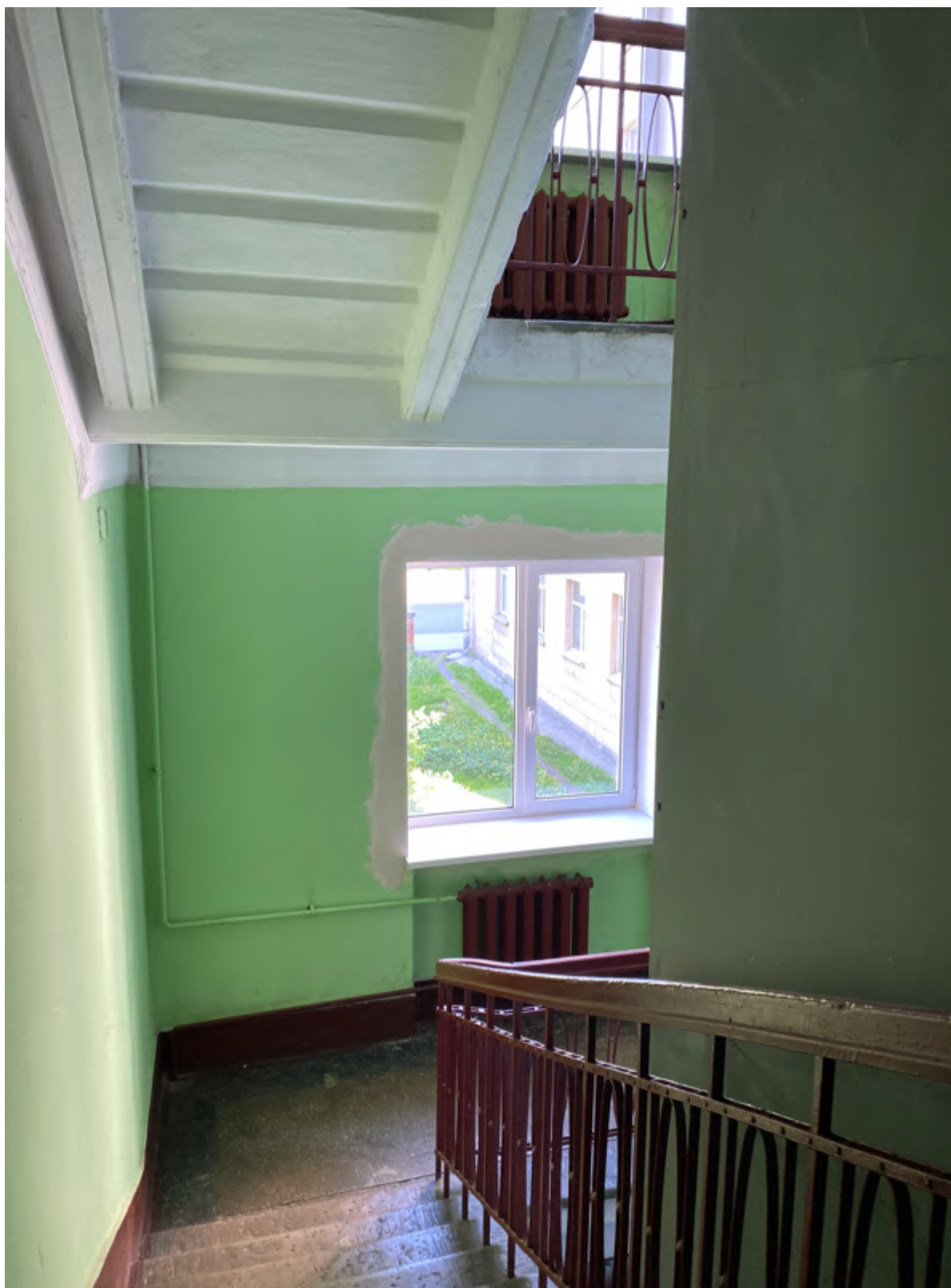
28. Фрагмент интерьера лестницы №1
