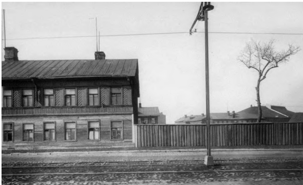
17. Часть фасада дома №33 на Шлиссельбургском проспекте. 1934 г. ЦГАКФФД СПб Гр 67271
