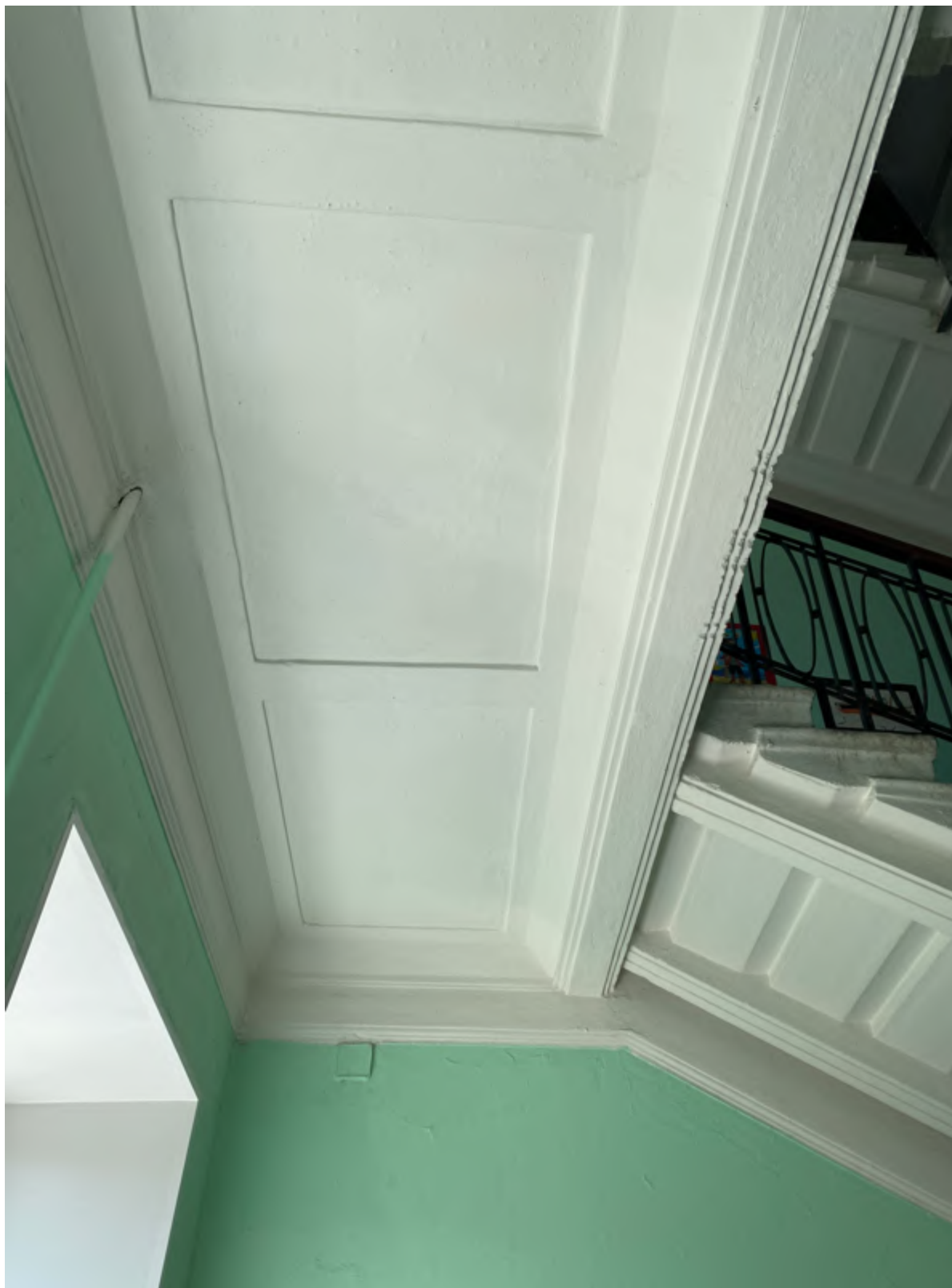
35. Фрагмент интерьера лестницы №2
