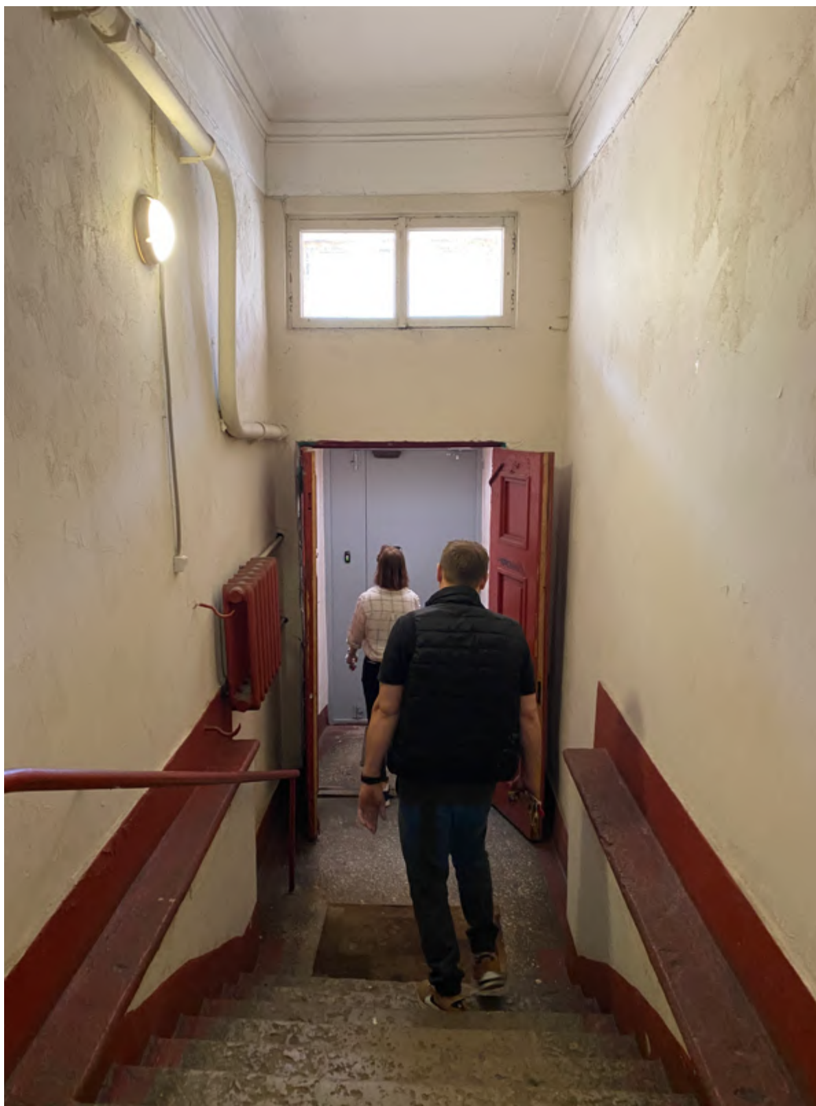
56. Фрагмент интерьера лестницы №4
