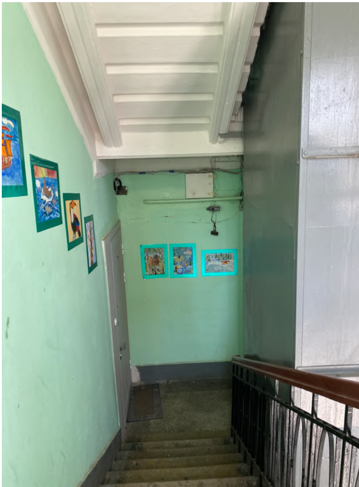
38. Фрагмент интерьера лестницы №2
