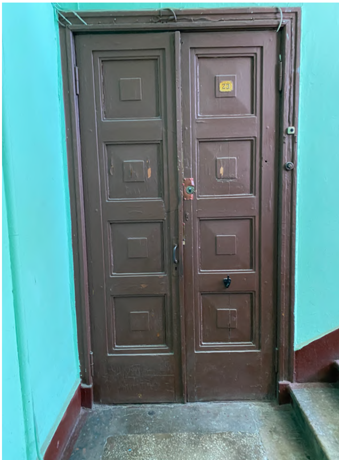
47. Фрагмент интерьера лестницы №3
